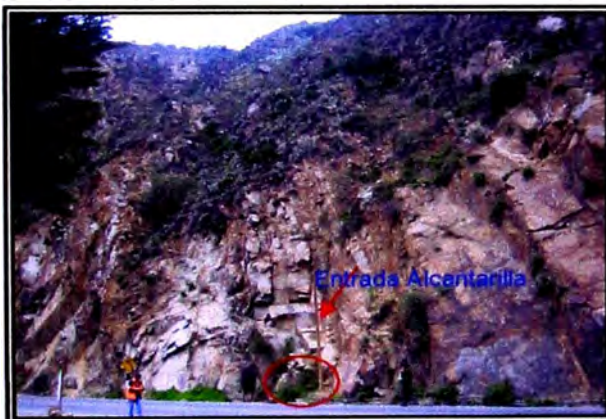
Alcantarilla N° 01 Km. 69+020.00
