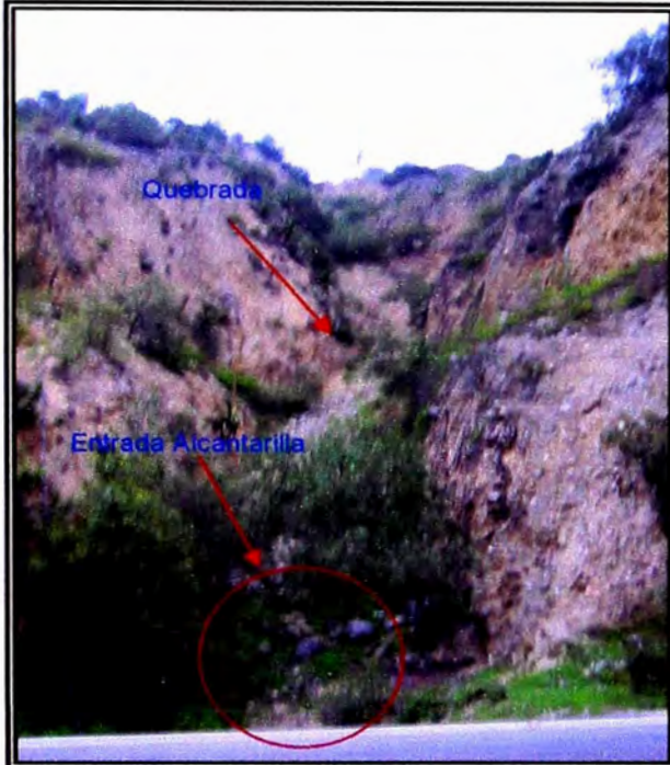
Alcantarilla N° 05 Km. 70+195.00
