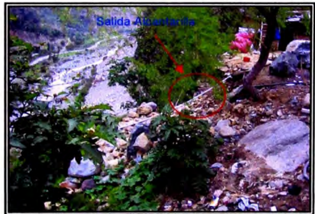
Alcantarilla N° 01 Km. 69+020.00
