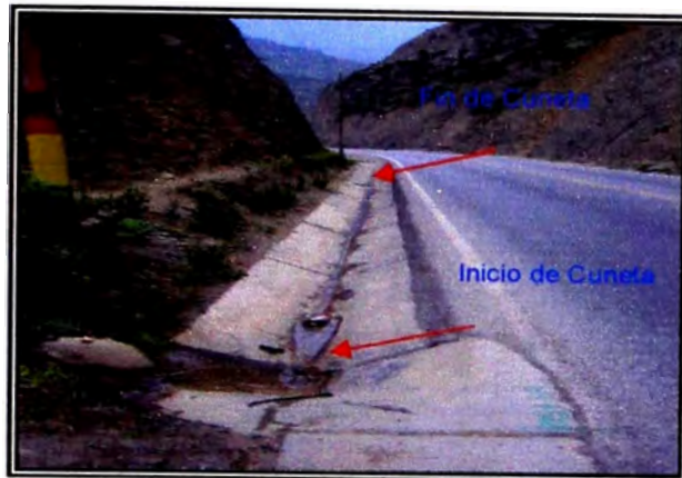
Cuneta Triangular en Sección Cajón
