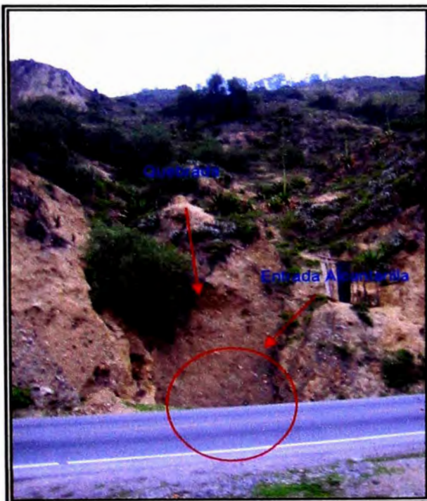
Alcantarilla N° 06 Km. 70+316.40
