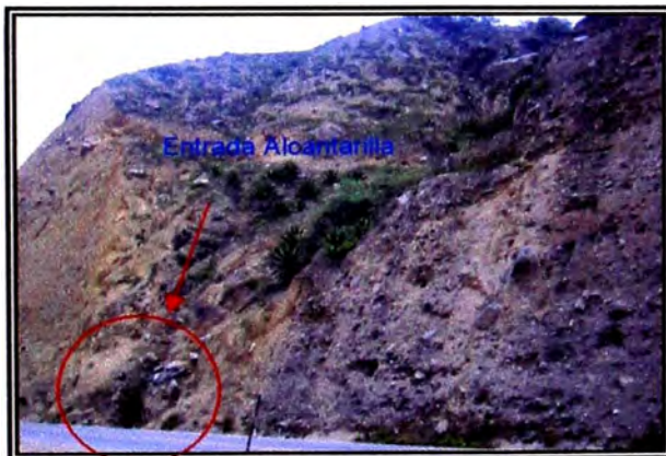
Alcantarilla N° 04 Km. 69+530.50
