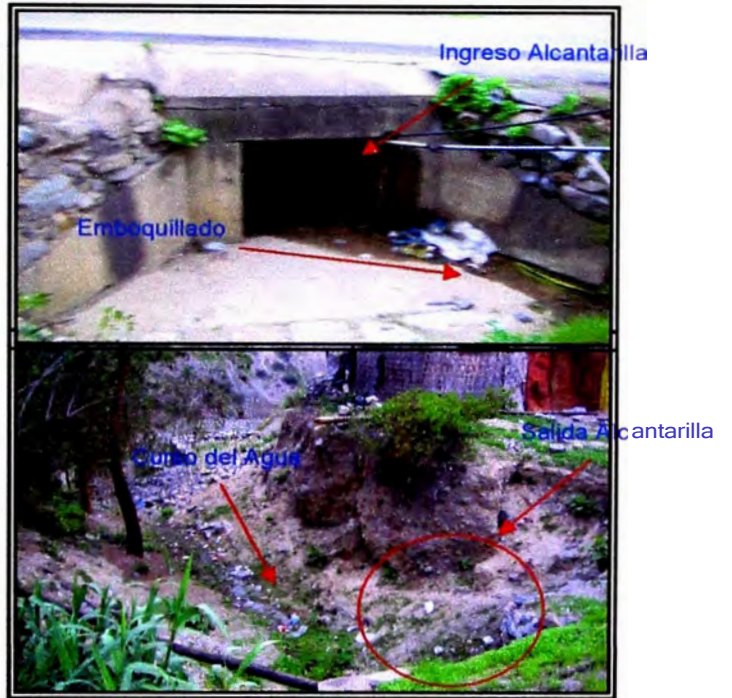
Alcantarilla N° 05 Km. 70+195.00
