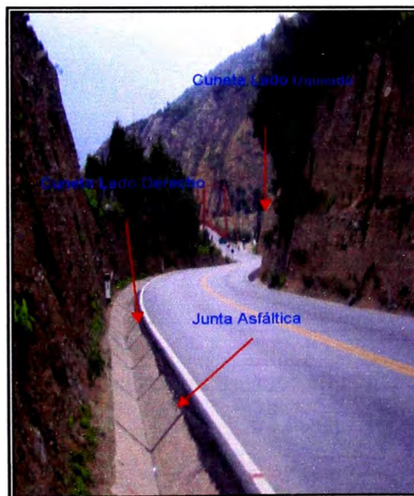
Cuneta Triangular en Sección Cajón
