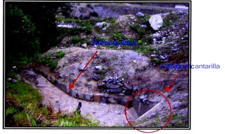
Alcantarilla N° 03 Km. 69+408.80
