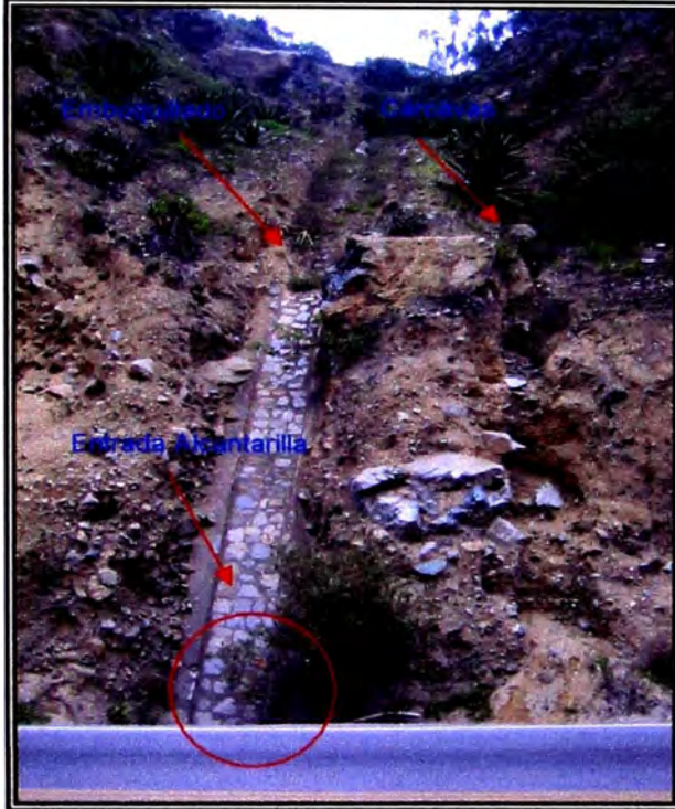
Alcantarilla N° 03 Km. 69+408.80
