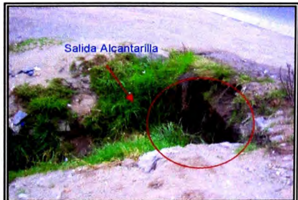
Alcantarilla N° 04 Km. 69+530.50
