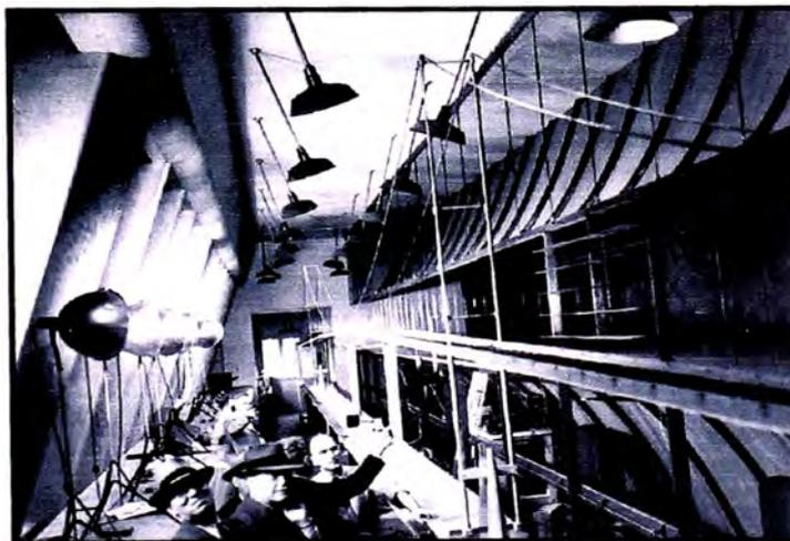
Foto 8: Modelo del puente sobre el estrecho de Tacoma en el túnel de viento de la Universidad de Washington. (años después del desplome)
