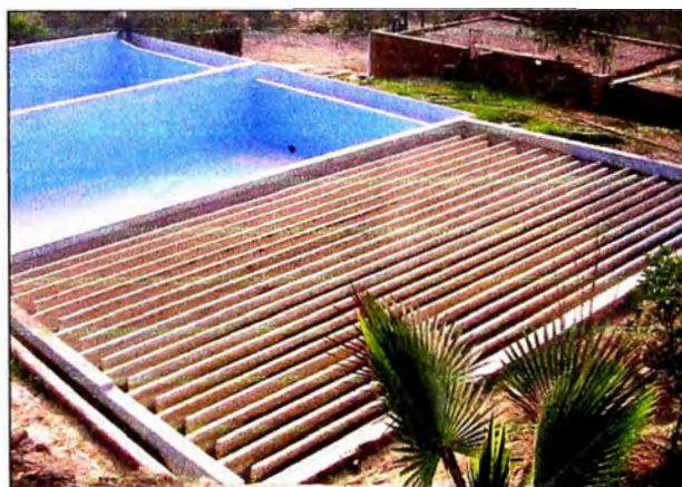
FOTO 1.3: FLOCULADOR DE PANTALLA PLANA VERTICAL
