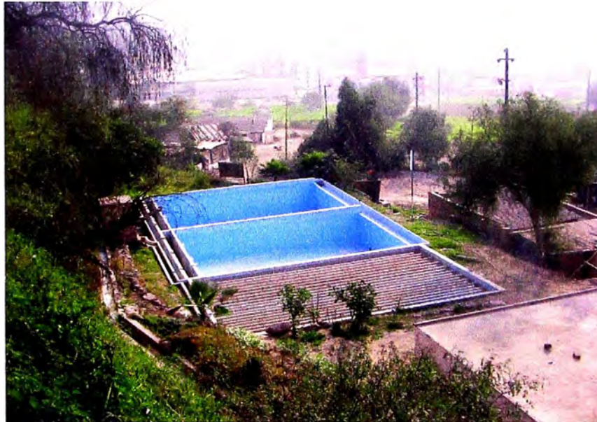
FOTO 07 FLOCULADOR Y SEDIMENTADOR
