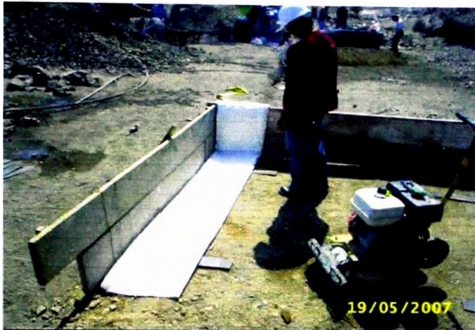
Foto A. 1. (9) Colocación del geotextil tejido de acuerdo a las características del diseño presentado.
