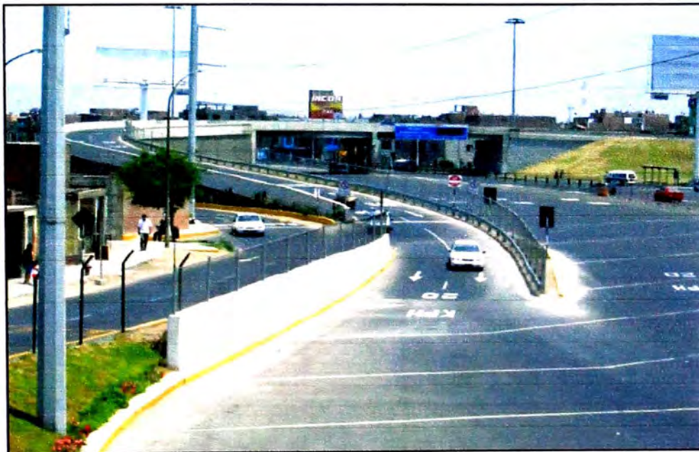
Foto 5_5 Muro de Suelo reforzado con Geomallas - By Pass en la Vía Expresa del Callao - Lima - Perú
