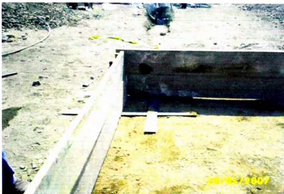
Foto A.1. (8) Detalle del encofrado, solo se realiza por capas de 50 cm. e ira subiendo conforme aumente la altura del muro (encofrado removible).
