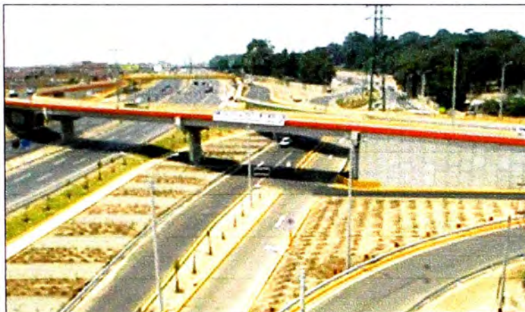
Foto 3.11. Muro de suelo reforzado con fachada de paneles de concreto - Intercambio Vial Sur Villa el Salvador - Lima
