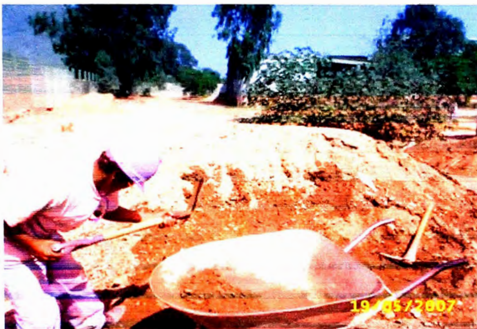
Foto 3.1 O. Vista del material usado como relleno en el muro de suelo.
