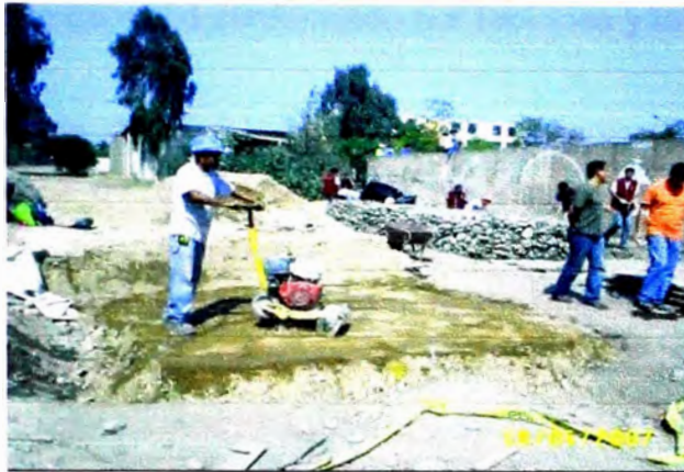
Foto 3.3. Construcción de cama de nivelación ó "colchón" con material de relleno.
