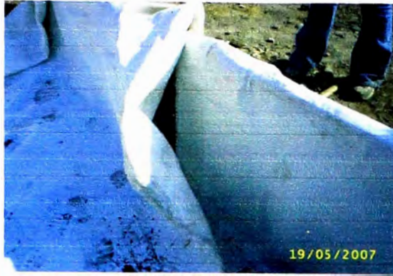
Foto 3.6. Detalle de traslape del geotextil.
