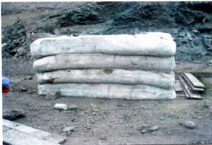
Foto 3.14. Muro reforzado para obras de corta duración (hasta 6 meses) se puede dejar el geosintético expuesto - UNI
