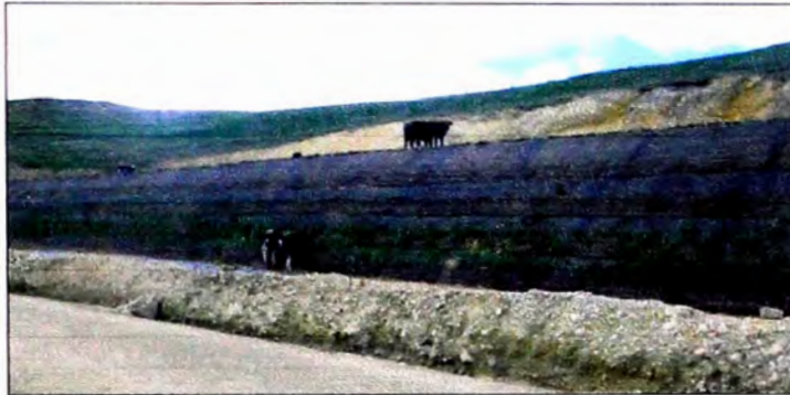
Foto 3.13. Muro reforzado con recubrimiento de geomantas en proceso de revegetación Yanacocha - Cajamarca.
