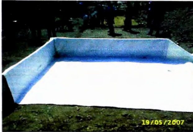
Foto 3.7. El geotextil completamente colocado listo para el relleno de material.
