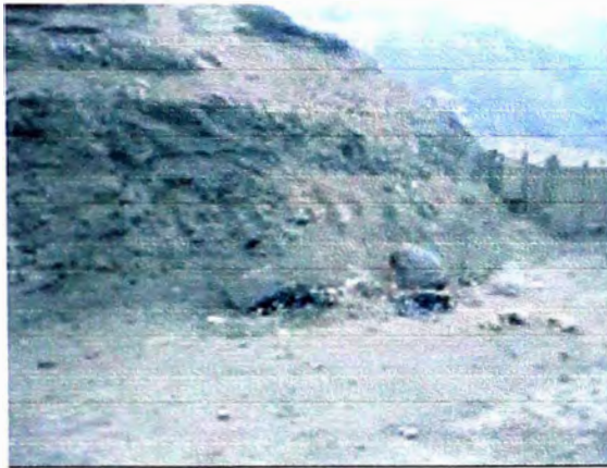
Foto 3.1. Vista del terreno donde se ubicará el muro del proyecto.
