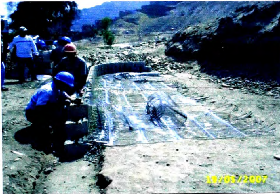
Foto 5.1. Detalle del acomodo de los bloques de concreto.
