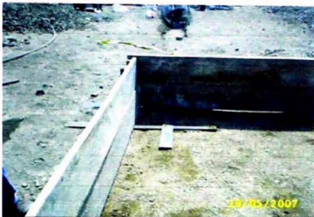
Foto 3.4. Encofrado de muro conformado por tablonces y formaletas removibles.
