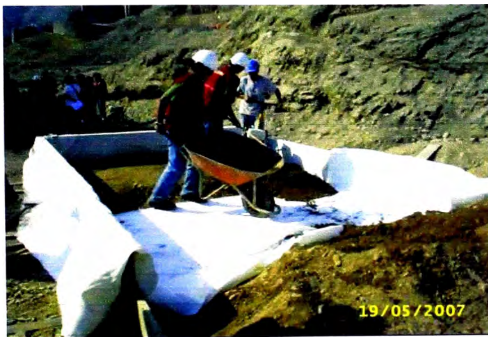
Foto A.1. (12) Acarreo y traslado del material de relleno de manera manual.
