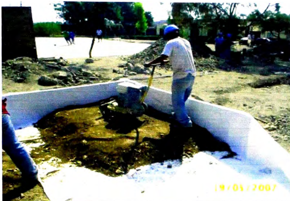
Foto A.1. (11) Relleno, extendido y compactación de 1ra capa de 25 cm. del 1er nivel del muro, se realizara en 2 etapas por el espesor del nivel.
