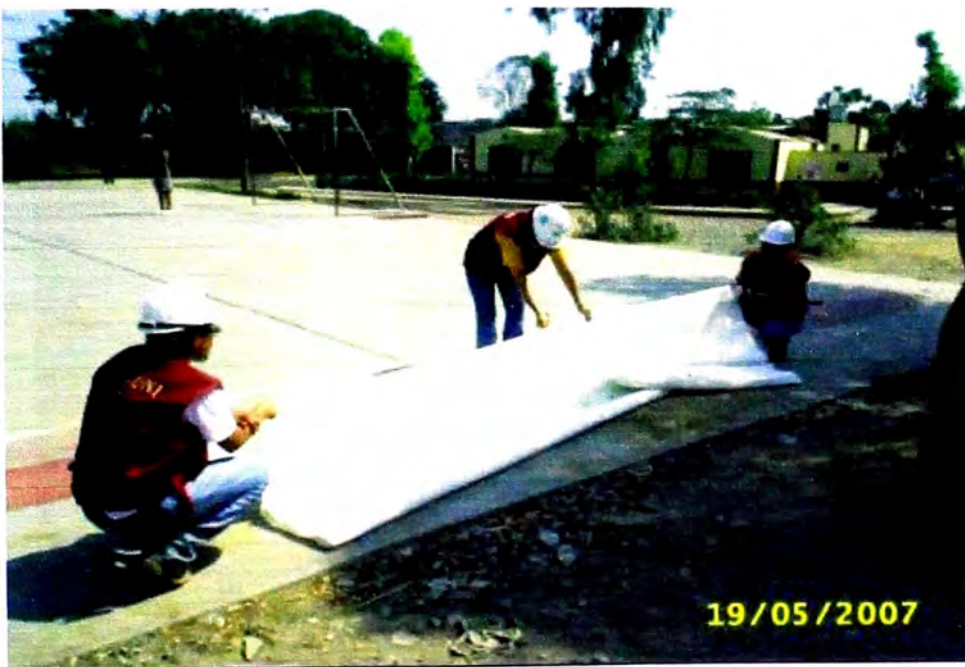
Foto A.1. (6) Habilitación, transporte y corte de geotextil tejido según diseño.
