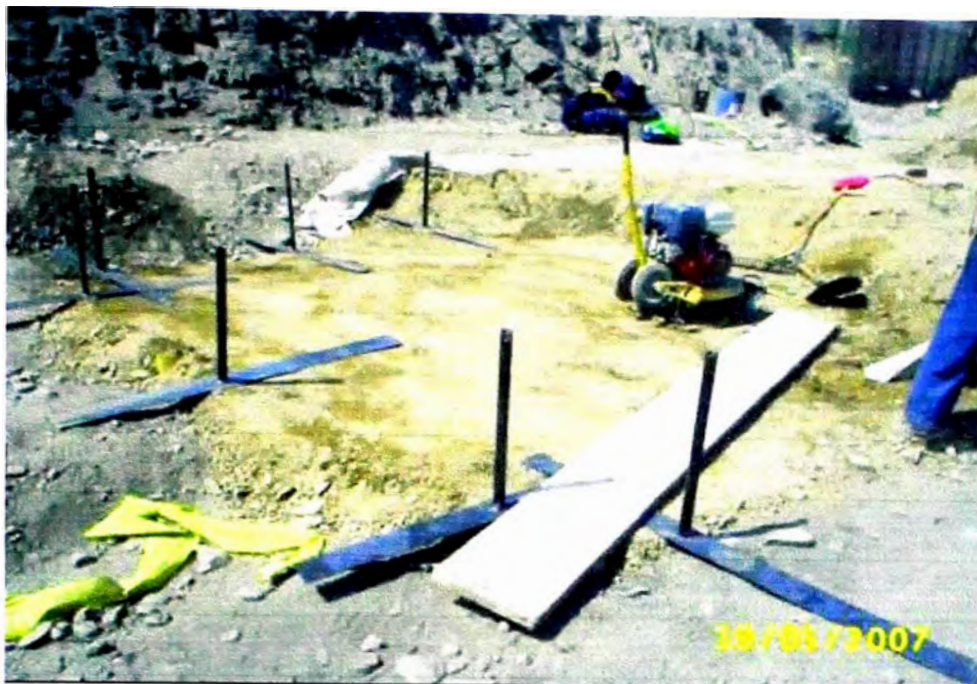
Foto A.1. (7) Formaletas de fierro removibles para realización de encofrado de muro.
