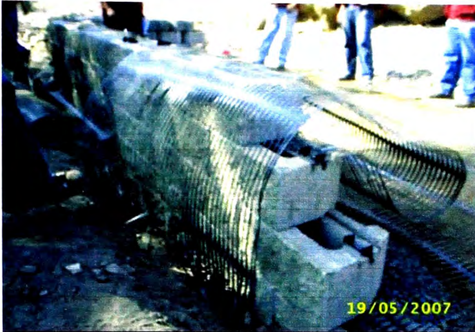
Foto 5.4. Detalle del dobléz de la geomalla, acomodando más de 1 capa.
