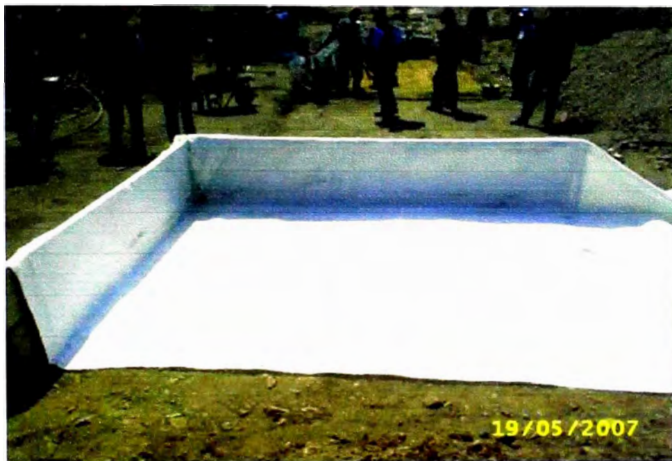
Foto A.1. (10) Primera etapa de colocación del geotextil, se realizara el traslape de 30 cm. en los bordes.
