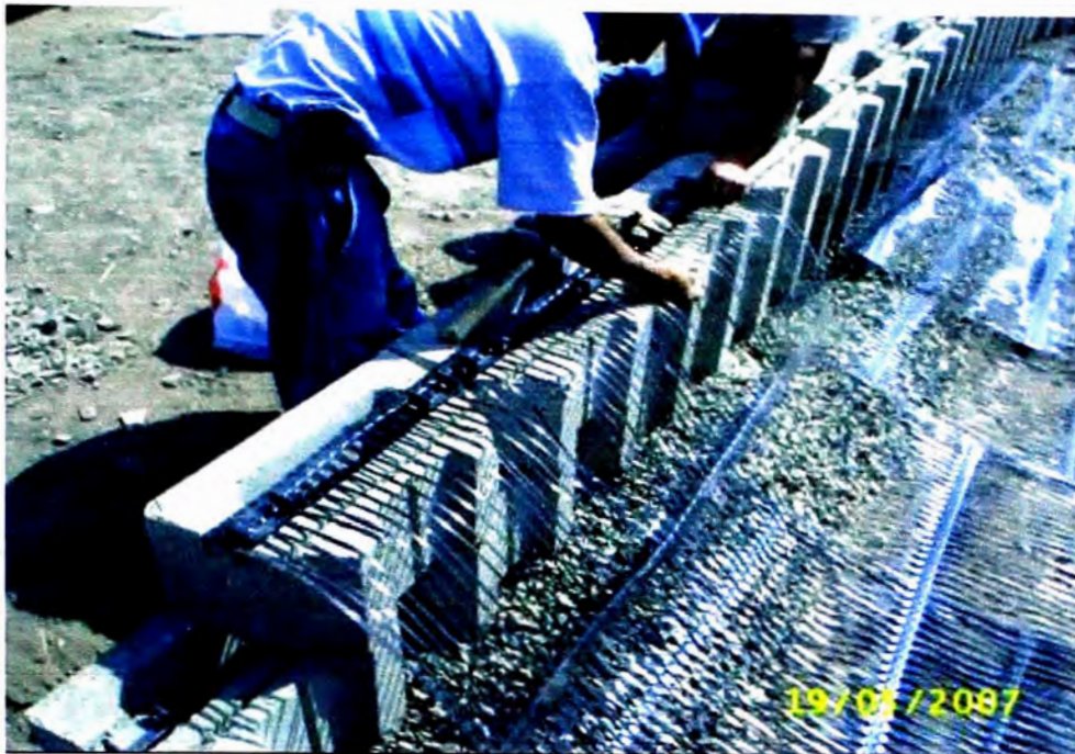
Foto 5.2. Colocación de las geomallas, se observa la capa del dren (piedra chancada)
