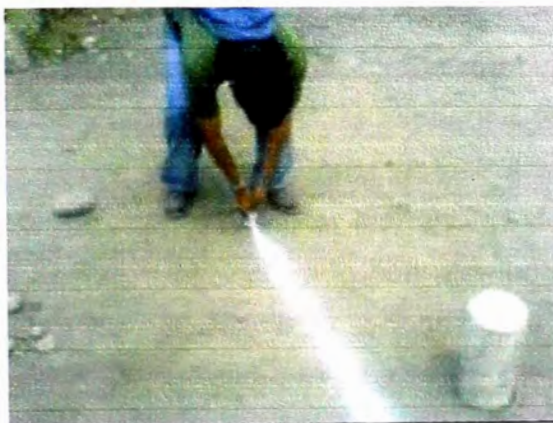
Foto 3.2. Trazado de ejes del muro.
