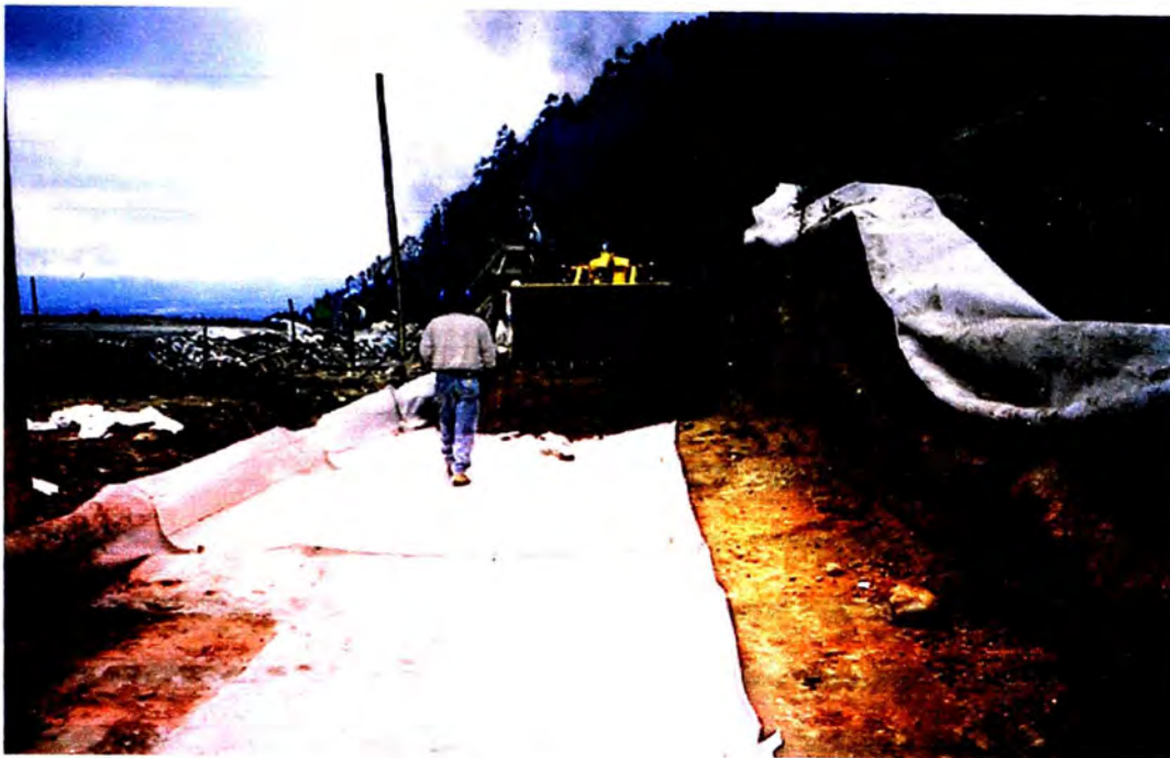
Foto 3.9. Relleno de muro de contención con el apoyo de maquinaria pesada.
