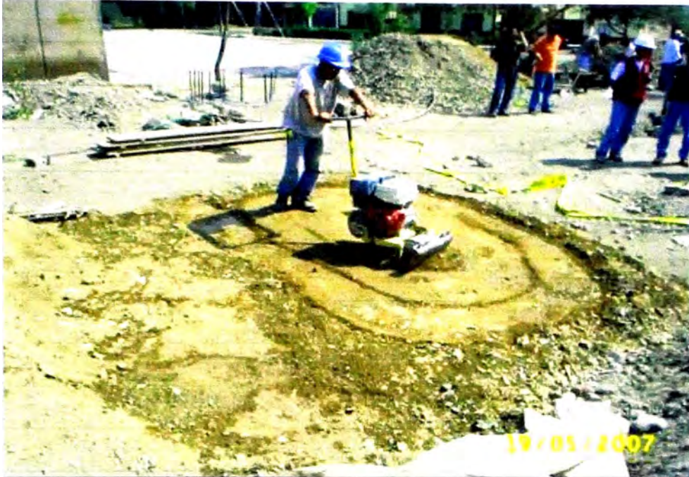
Foto A.1. (5) Relleno y compactación de base de nivelación con material de préstamo para alcanzar el 90% de la MDS.
