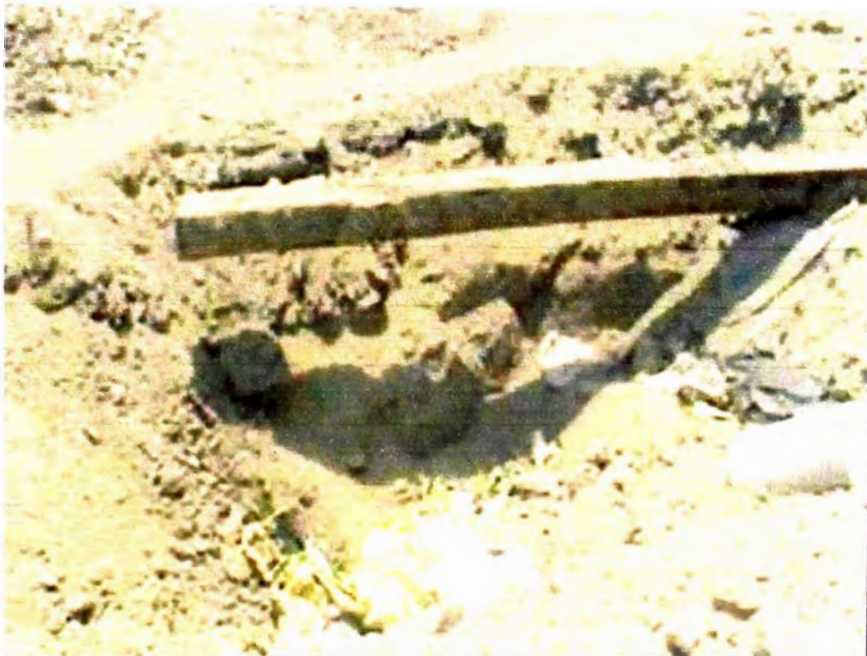
Foto A.1. (2) Excavación cercana al área de trabajo donde se observa la calidad del material de fundación.
