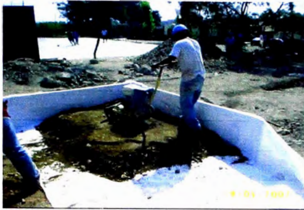
Foto 3.8. Relleno de la primera capa de material de espesor 25 cm.
