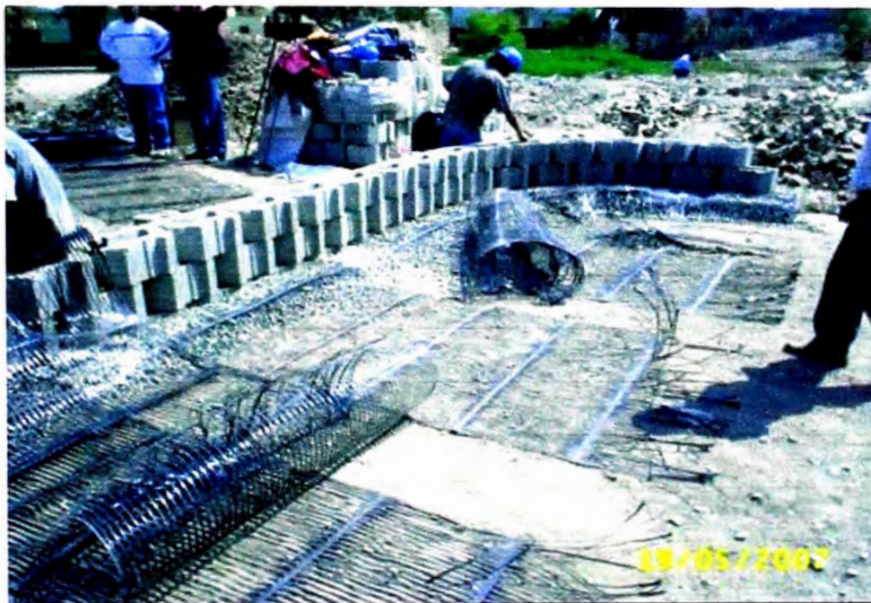
Foto 5.3. Detalle de la forma circular del muro acomodando las bloquetas de concreto.
