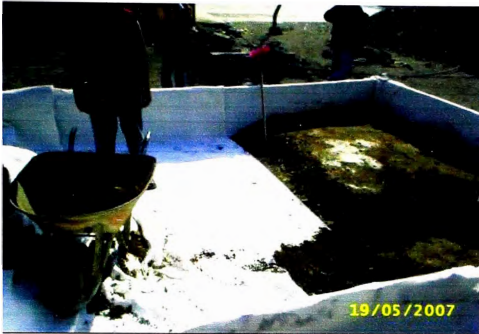
Foto A 1. (13) Detalle de la primera compactada de material, las esquinas y los bordes se compactan de manera manual con ayuda de pisones.
