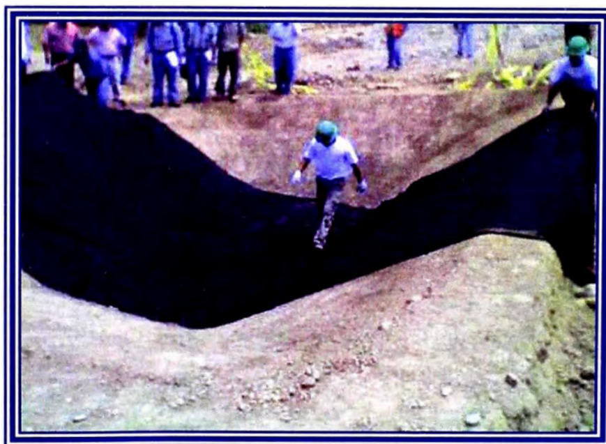
Foto 12: Durante la colocación de los paneles de Geotextil No Tejido, se debe asegurar que cada panel este lo mas extendido posible, sin dobleces, ni abultamientos.
