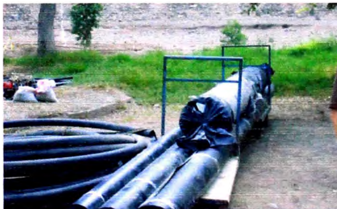
Figura 5.2 Almacenaje en obra de Geotextil No Tejido.
