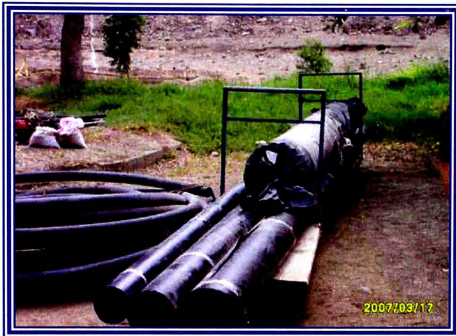
Foto 5: Transporte y almacenamiento del Geotextil No Tejido de amortiguamiento.
