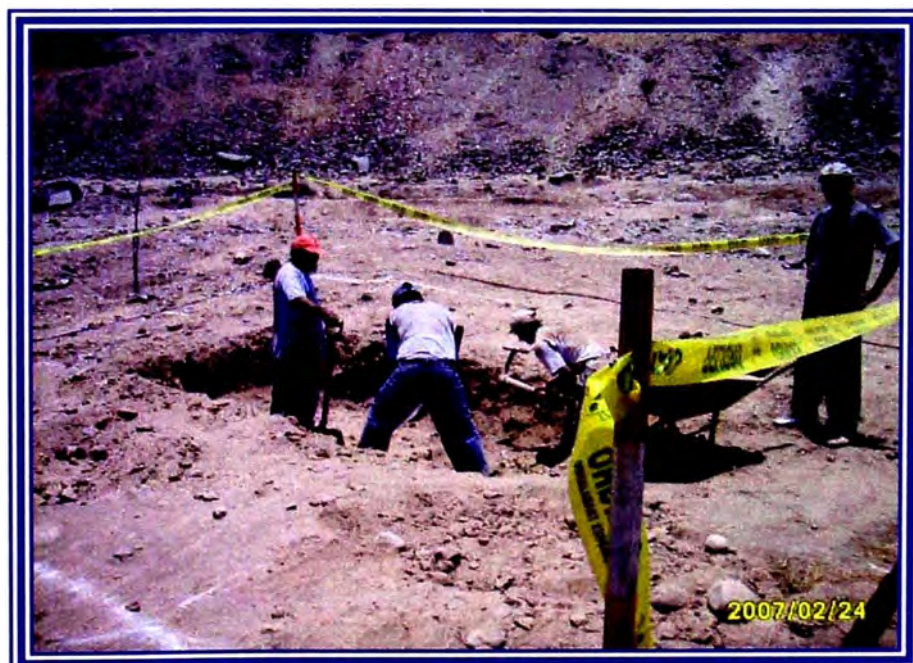
Foto 2: Excavación de Reservorio
