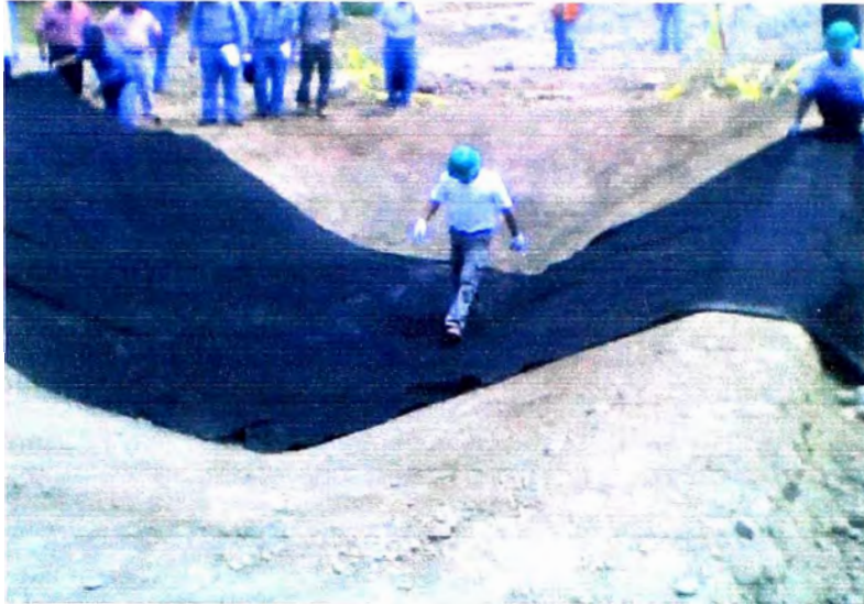
Figura 5.4 Colocación de Geotextil de amortiguamiento
