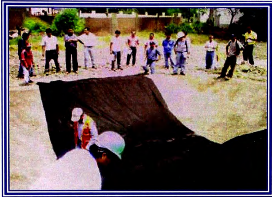
Foto 13: Revisión de primer panel instalado, - En las zonas abultadas ejercer tensión a lo largo del panel.
