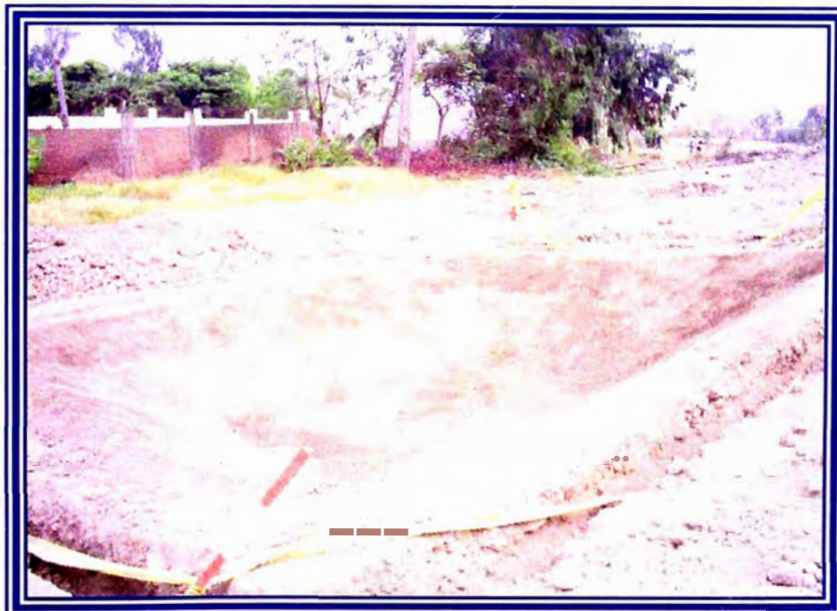
Foto 4: Conformación y Refine de fondo y paredes de reservorio de agua
