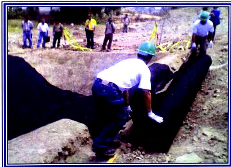
Foto 10: Colocación de primer panel de Geotextil No Tejido.
