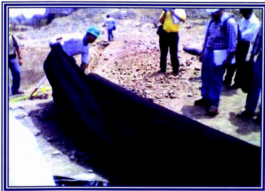
Foto 8 Inspección visual de la calidad del Geotextil No Tejido proveído
