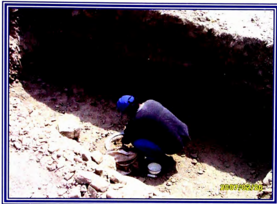
Foto 3: Toma de muestras para Ensayos de Suelos
