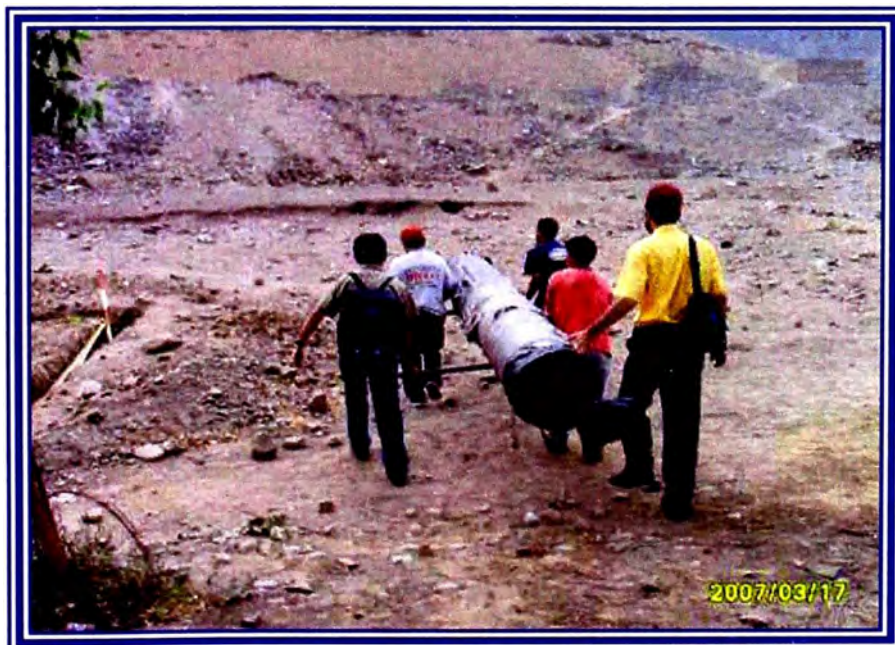
Foto 6: Transporte del Geotextil No Tejido de amortiguamiento a pie de obra.
