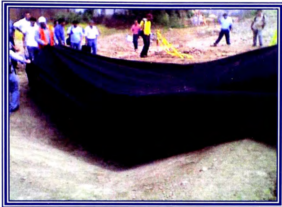
Foto 9: Colocación del Geotextil No Tajido
