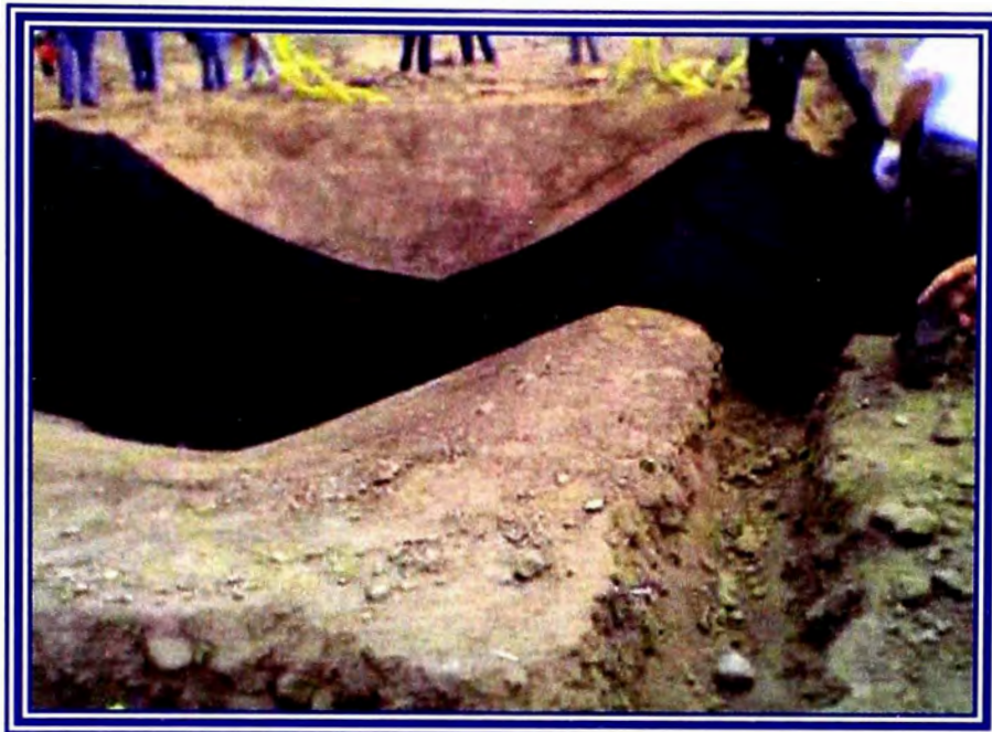
Foto 11: Paneles de Geotextil No Tejido, cubre zanja de anclaje.
