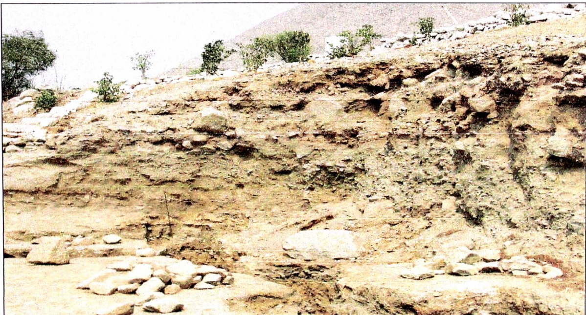
Figura 4.1: Observamos un corte transversal al cono de deyección donde podemos apreciar la matriz del cono, arena limosa, bolonería que varía de 30cm hasta 1 metro de diámetro, que muestran la actividad que tuvo la quebrada; asimismo se puede apreciar que existen diferentes estratos de depósito.
