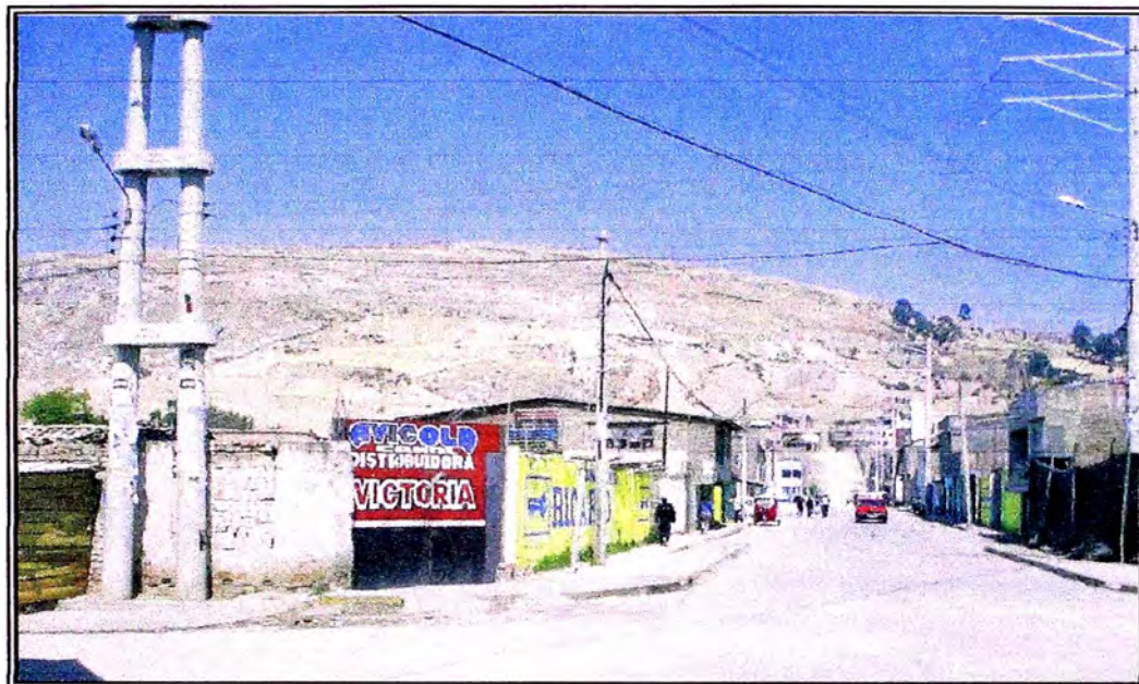
Foto N° 25 Jr. Túpac Amaru, postes y cableado eléctrico ubicados de manera desordenada.
