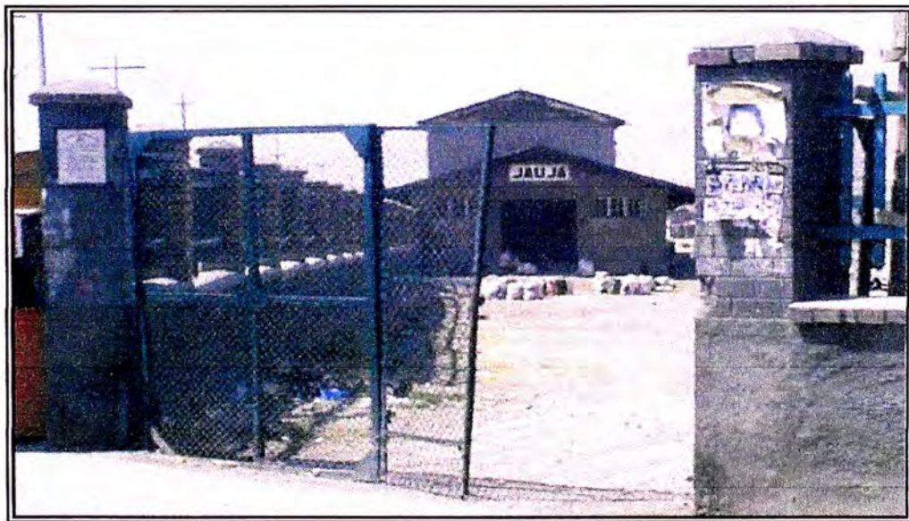
Foto N° 24 Estación Jauja, ubicada al ingreso del distrito de Yauyos
