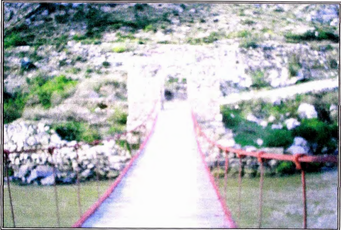
Foto N° 16 Puente Inca, recientemente reparado por el municipio de Yauyos.
