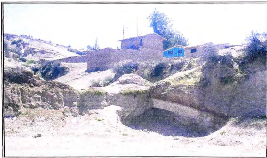
Foto N° 13 Bajo el suelo de Yauyos existen varios minerales. Presencia de roca caliza bajo las casas construidas.
