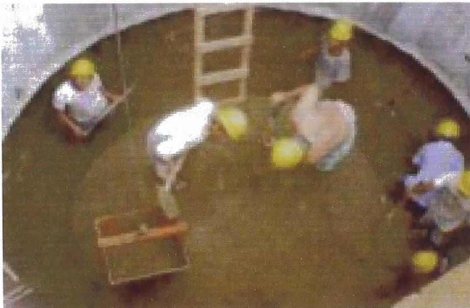
Figura N°6\_ Excavación de uno de los pozos de cimentación para un puente. El tubo de hormigón (concreto) se va hundiendo a medida que se excava. En este caso se llegó a 24 m de profundidad.
