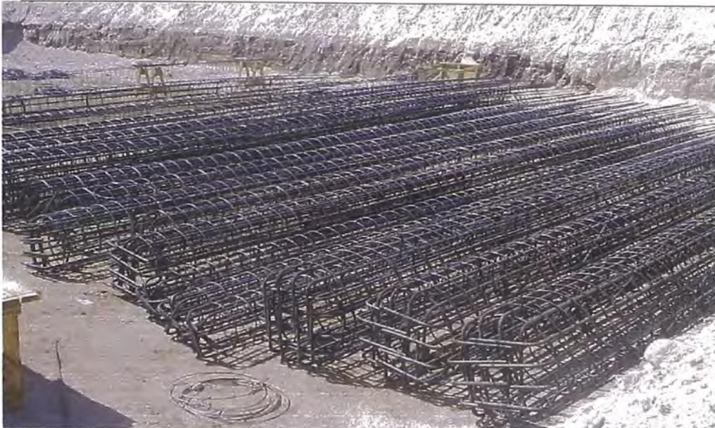
Figura N°22\_ Acero de pilotes.
