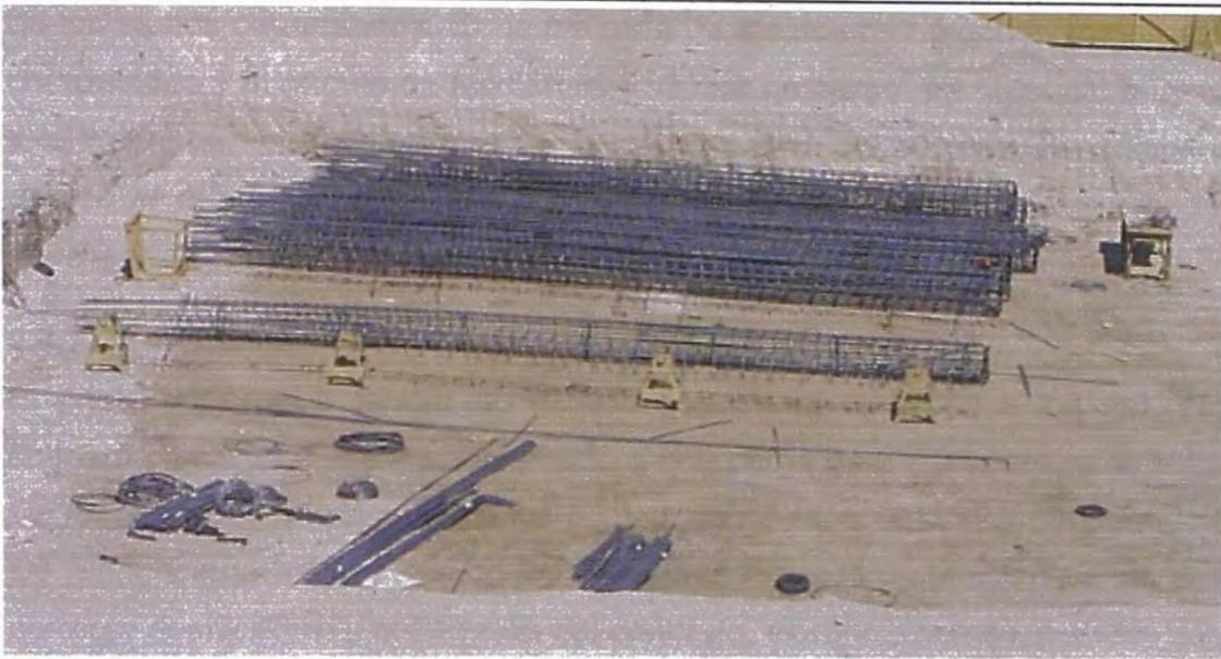
Figura N°17\_ Habilitación del acero en pilotes vaceados in situ
