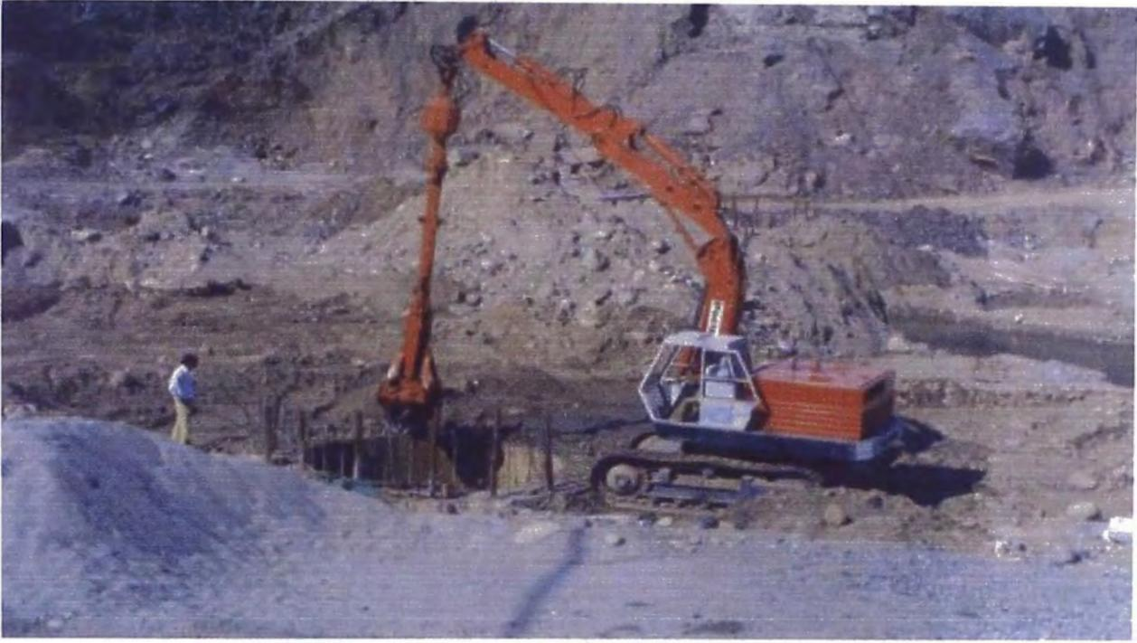
**Figura N°7\_ Cimentación mediante pozos perforados**
