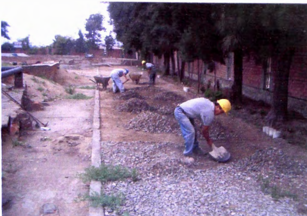
Foto N° 03: Preparación del terreno antes de la excavación. Retiro de la cobertura de piedra chancada de ¾".
