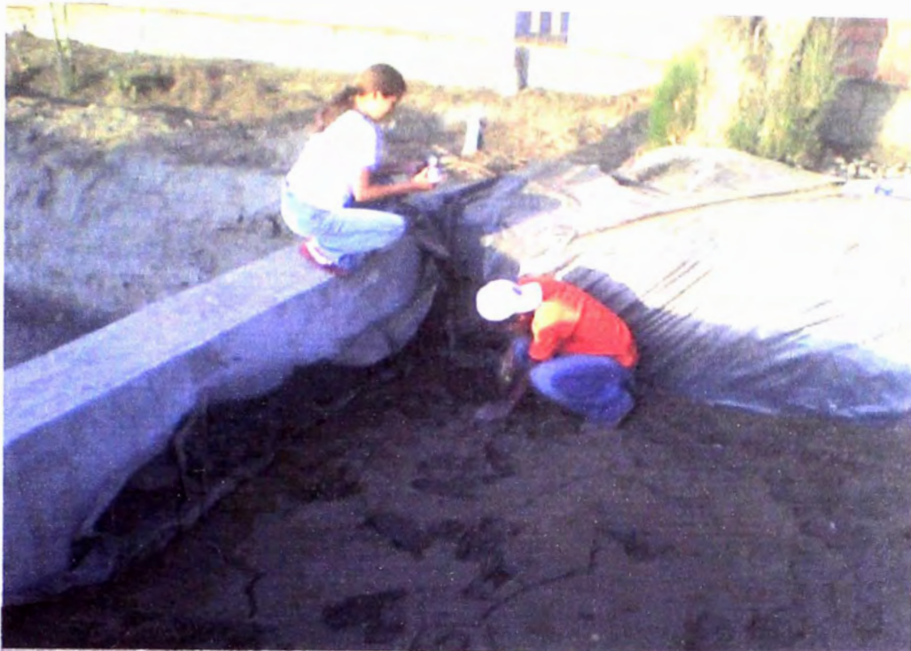
Foto N° 29: Toma de muestras para el control de evaporación en la subrasante generada.
