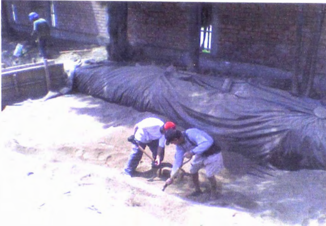
Foto N° 23: Colocación del suelo seleccionado para la generación de la subrasante.
