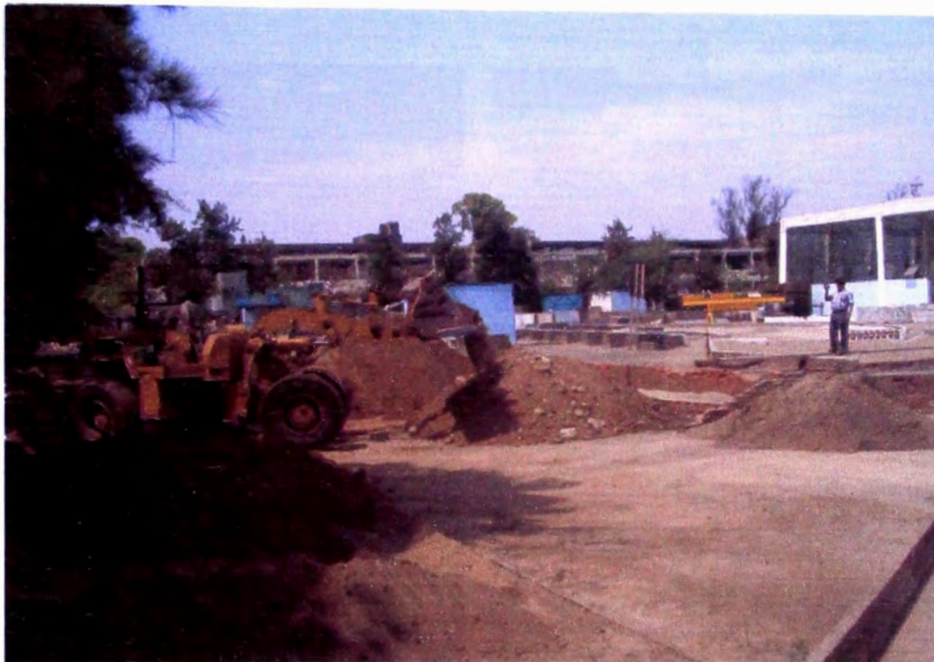
Foto N° 07: Apilado del material de excavación por tipos.
