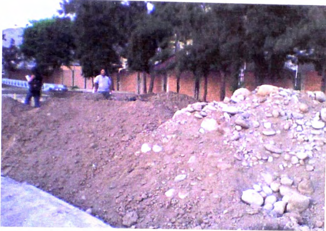
Foto N° 13: Dos montículos de suelos de características diferentes
