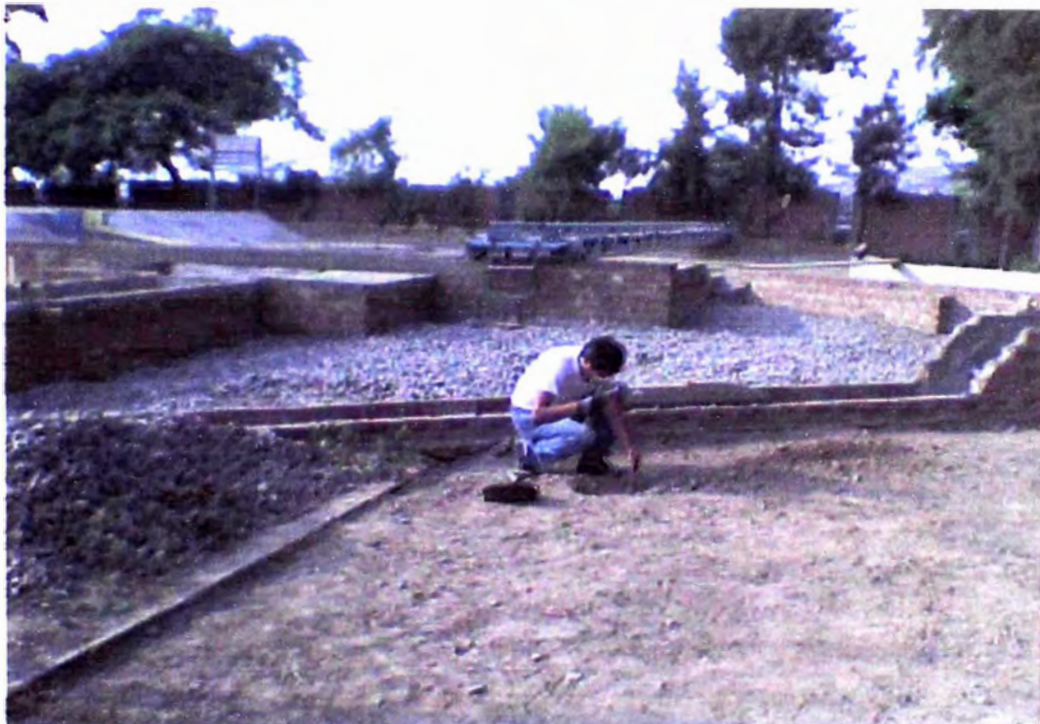
Foto N° 02: Toma de muestra del suelo de cimentación para la determinación del CBR del sitio propuesto.
