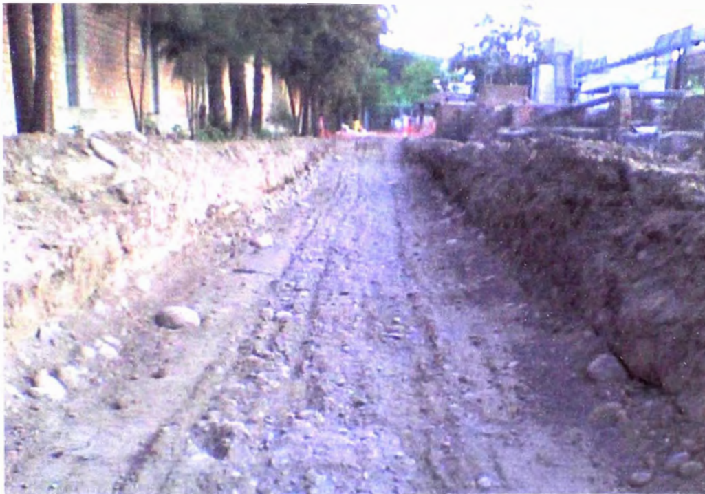
Foto N° 08: Vista del sector excavado.
