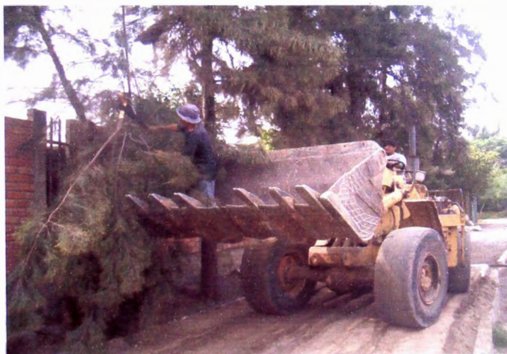
Foto N° 04: Preparación del terreno antes de la excavación. Podado de árboles.
