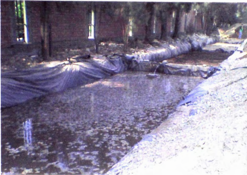
Foto N° 25: Saturación del suelo de subrasante.
