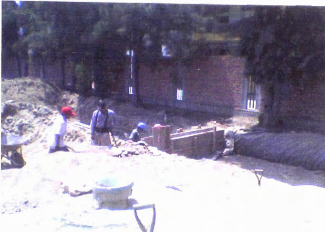
Foto N° 21: Preparación de la poza para la degradación de subrasante.
