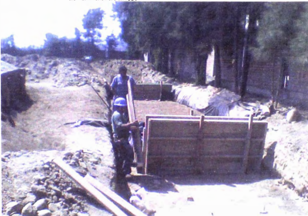
Foto N° 24: Construcción de muros de separación.
