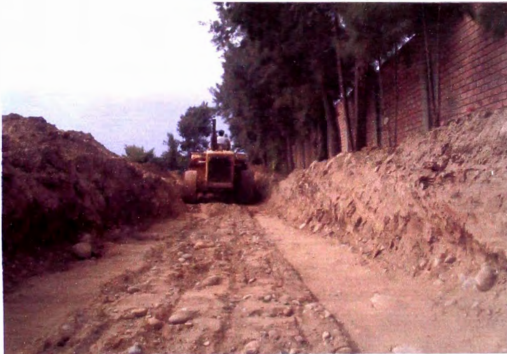
Foto N° 06: Excavación para la poza de degradación de subrasante.
