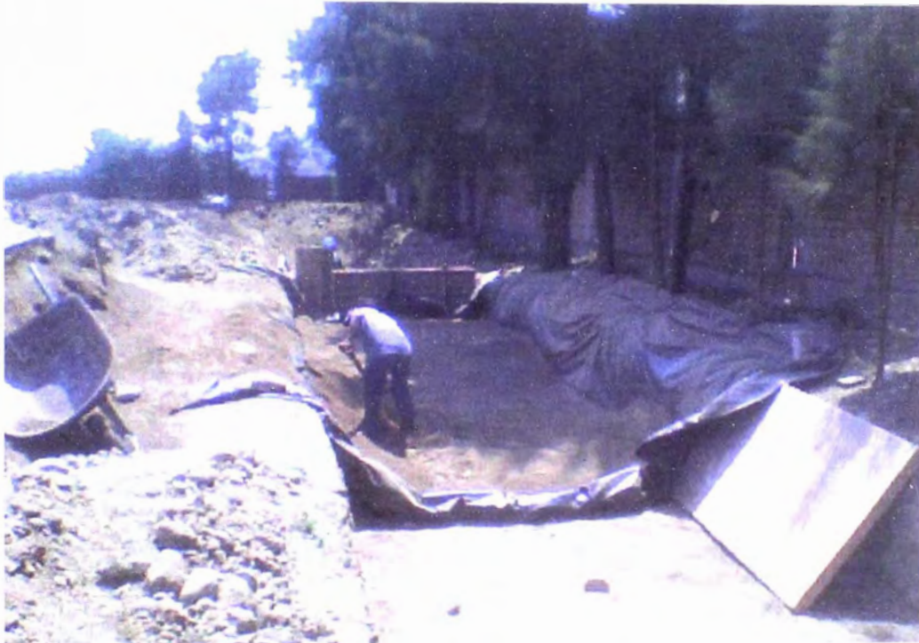
Foto N° 22: Colocación del suelo seleccionado para la generación de la subrasante.
