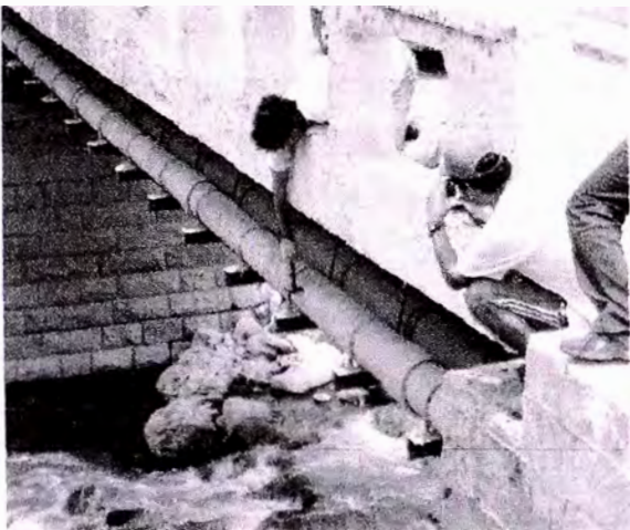
Foto N° 03: Se observa la línea de impulsión existente, el cual se esta verificando su estado.
