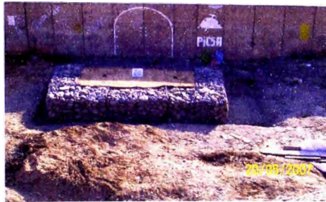
Figura 22. Relleno estructural concluido
