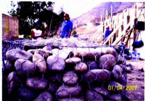
FOTO 9: CIERRE FINAL EN LOS ELEMENTOS TERRAMESH
