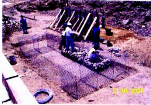
FOTO 7: COLOCACIÓN DE PIEDRAS EN DOS ELEMENTOS SUCESIVOS
