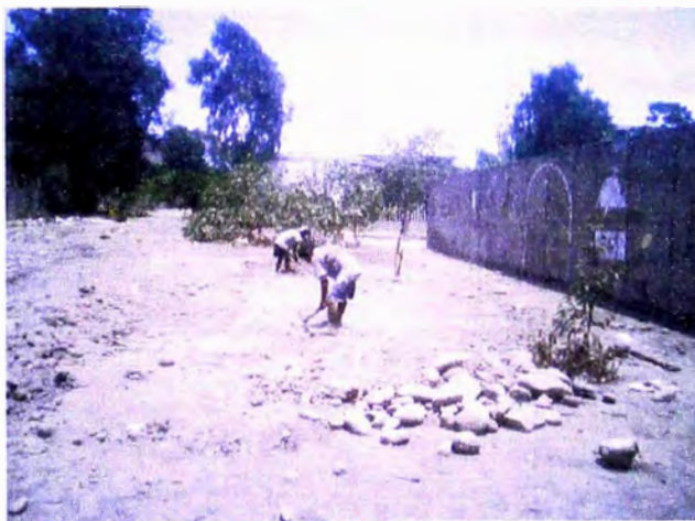
Figura 11. Limpieza y preparación del terreno
