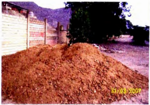
FOTO 12: AGREGADO PARA EL RELLENO ESTRUCTURAL.
