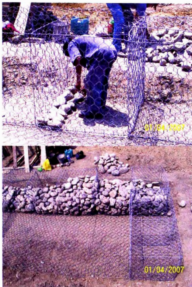
Figura 15. Colocación de piedras en los elementos terramesh
