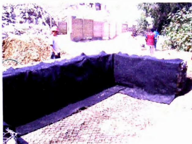
Figura 16. Colocación del geotextil de separación
