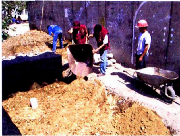
Figura 18. Colocación del relleno estructural.
