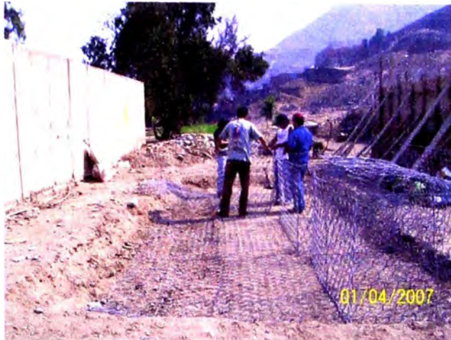
Figura 12. Primera hilera del elemento terramesh
