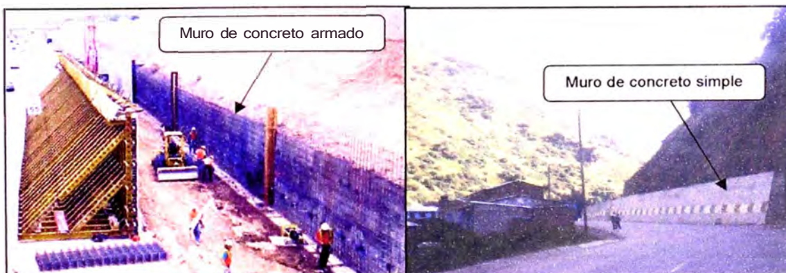
Figura 1. Muros masivos rígidos
