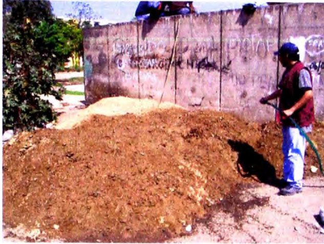
Figura 17. Riego del material de relleno.
