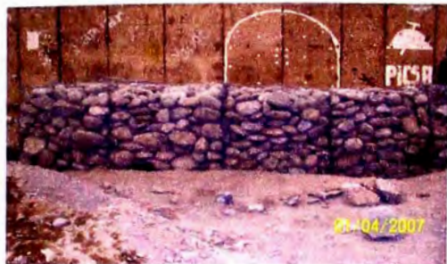
FOTO 10: PRIMERA HILADA DEL ELEMENTO TERRAMESH CON PIEDRAS
