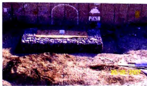
FOTO 18: FINALIZACIÓN DEL PRIMER NIVEL DEL MURO DE CONTENCIÓN
