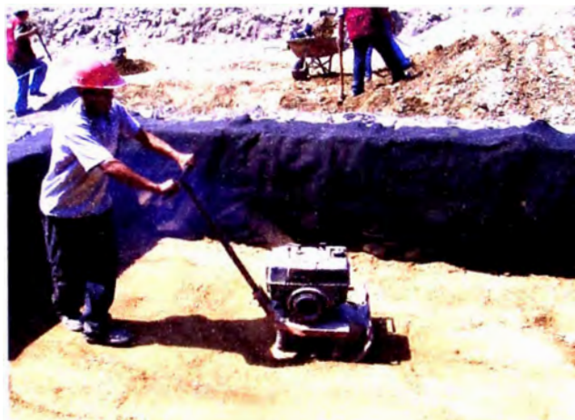
Figura 19. Compactación con plancha vibratoria
