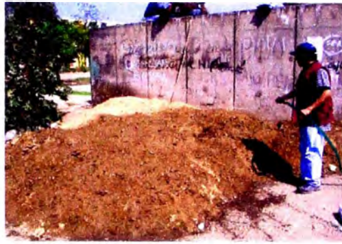
FOTO 14: RIEGO DEL MATERIAL DE RELLENO ESTRUCTURAL.
