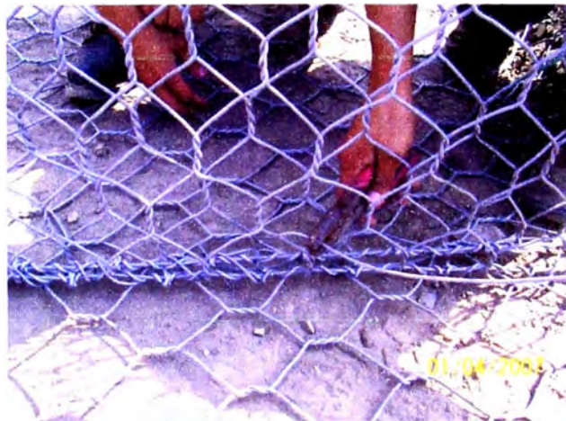
Figura 13. Amarre del elemento terramesh
