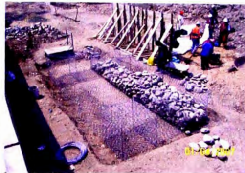
FOTO 8: COLOCACIÓN DE PIEDRAS AL PRIMER TERCIO
