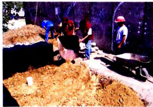
FOTO 15: COLOCACIÓN DEL MATERIAL DE RELLENO.
