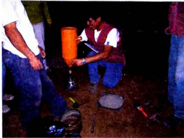
Figura 21. Control de compactación (Cono de Arena)
