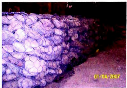
FOTO 11: PRIMERA HILADA DEL ELEMENTO TERRAMESH CON PIEDRAS
