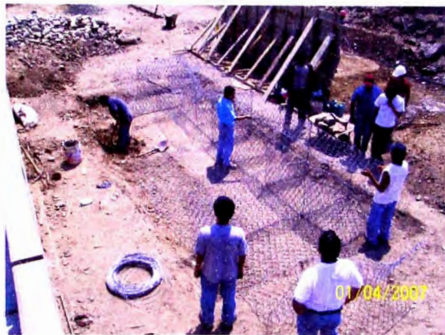
Figura 14. Primera hilada de elementos terramesh terminada
