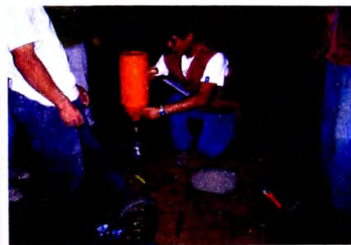
FOTO 17: CONTROL DE COMPACTACIÓN (CONO DE ARENA)
