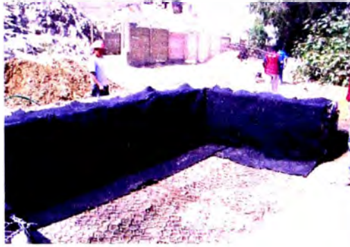
FOTO 13: COLOCACIÓN DEL GEOTEXTIL.
