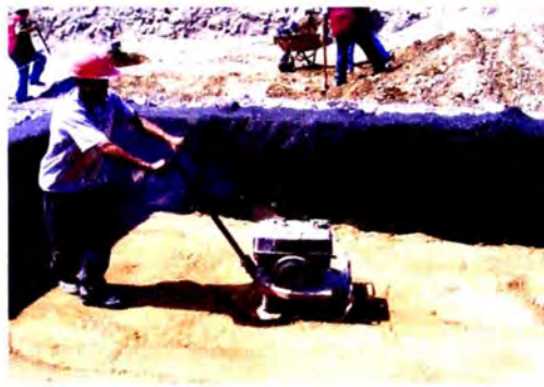
FOTO 16: COMPACTACIÓN DEL RELLENO ESTRUCTURAL.
