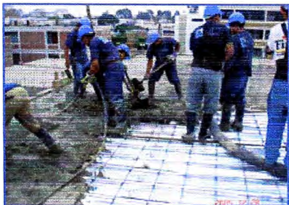
Foto 2.16: Distribución y vibrado de concreto
