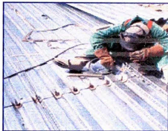
Foto 2.11: Fijación en empalme de placa
