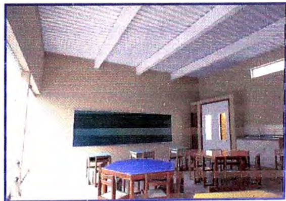
Foto 2.19: Acabado con pintura
