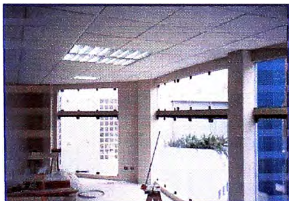
Foto 2.18: Acabado con falso cielo raso
