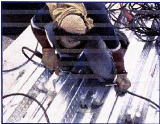
Foto 2.10: Fijación con pernos
