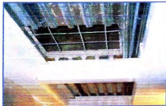
Foto 2.13: Ductos en losa colaborante
