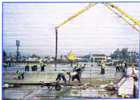
Foto 2.17: Vaciado con bomba
