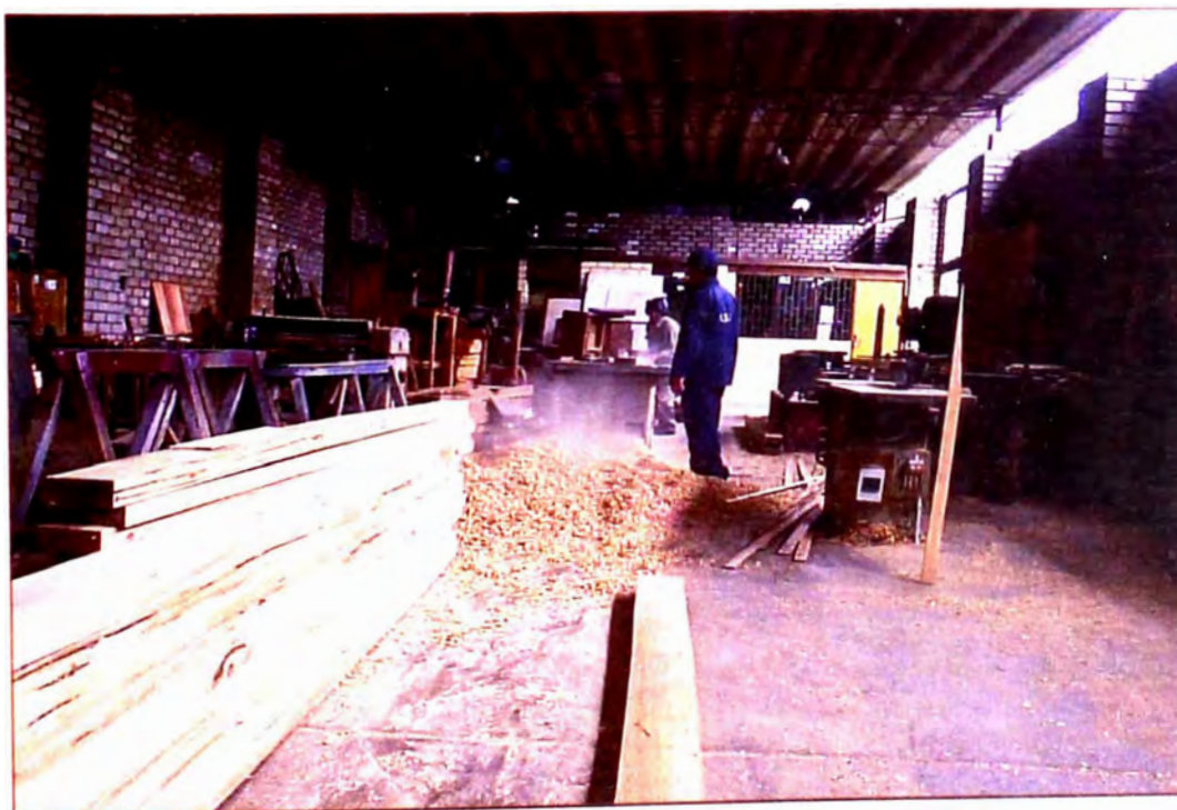
Cepillado de vigas en carpintería UNI
