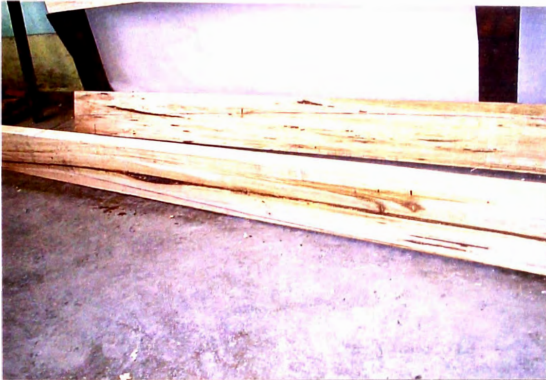
Exceso de extractivos, tipo de defecto encontrado en algunas vigas de E. Saligna.
