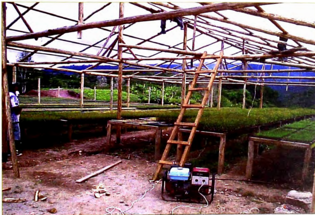
Vivero de plantas y semillas de Eucalipto Saligna -Villa Rica. (Estructura y elementos también de E. Saligna).
