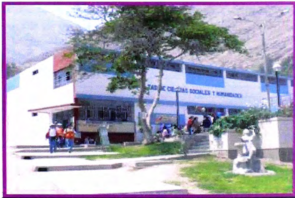
Figura 1.4: El edificio N° 19, denominado pabellón "A" es utilizado en toda su capacidad por la facultad de Ciencias Sociales y Humanidades para el desarrollo de las actividades académicas.
