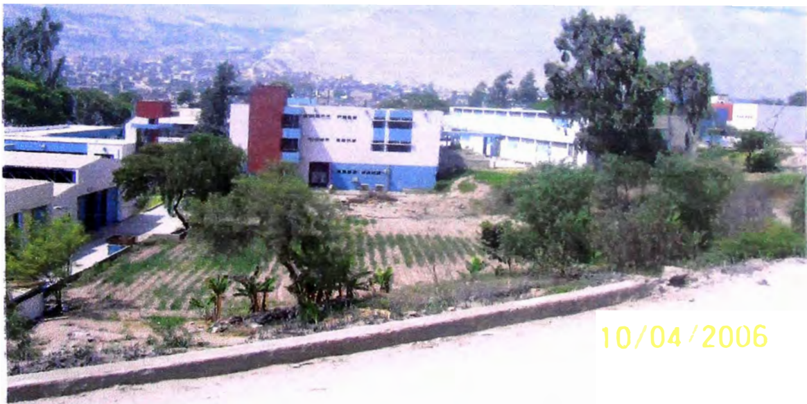
Figura 4.3: Se puede apreciar el relieve del terreno existente, presentando diferencias de cotas, la existencia de vegetación y montículos de tierra, situados en el área de construcción del Departamento de Educación Artística, aledaños a los pabellones existentes.
