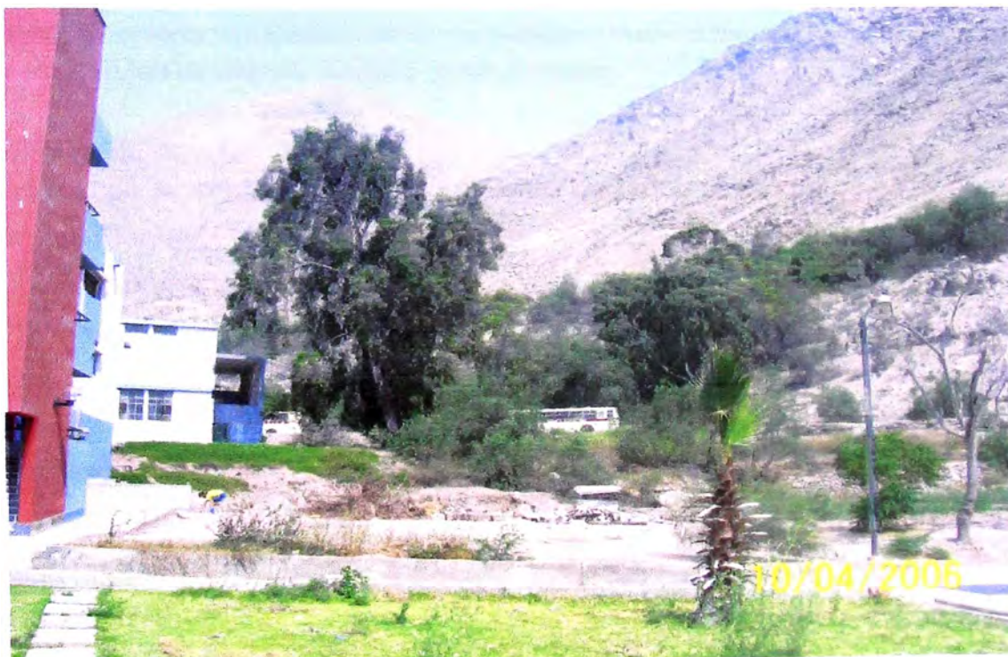
Figura 4.5: Se observa la topografía del área de estudio, que colinda con las construcciones existentes adyacentes.
