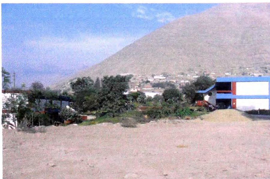
Figura 1.6: Los pabellones "B y C" ubicados en zona de huaycos, Se observa el pontón que permite cruzar el cauce del río.
