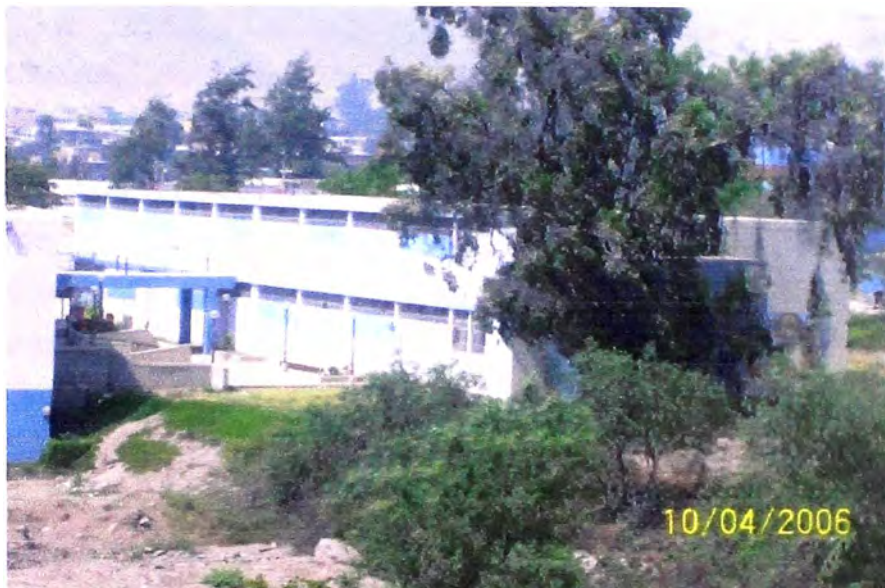
Figura 1.5: El pabellón "A" tiene orientación (norte-sur) desfavorable para implementar aulas de estudio con grandes ventanales.
