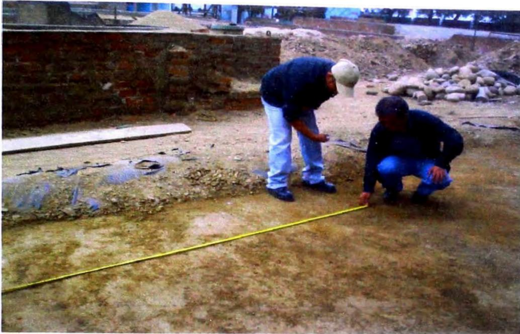
**Foto 3:** Ubicación de puntos de ensayo en el tramo de carretera con geoceldas para la medición de la deflexión
