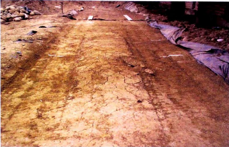
Foto 4.1: Deformación del pavimento ocasionado por el paso del camión
