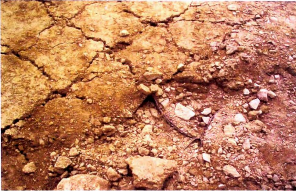
**Foto 4.3:** En esta foto se observa el agrietamiento de la superficie de rodadura, debido a la tracción ocasionada por la carga ejercida sobre el pavimento a través de las llantas del camión.
