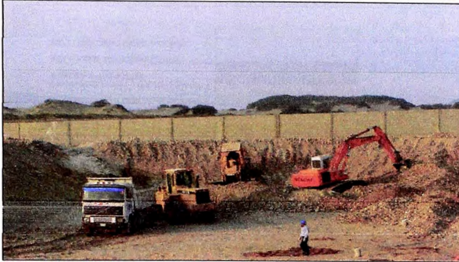
Figura 3.1 Corte de terreno con equipos
