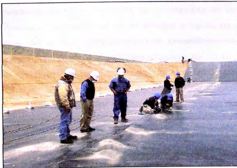
Figura 3.6 Soldadura de geomembrana por termofusión
