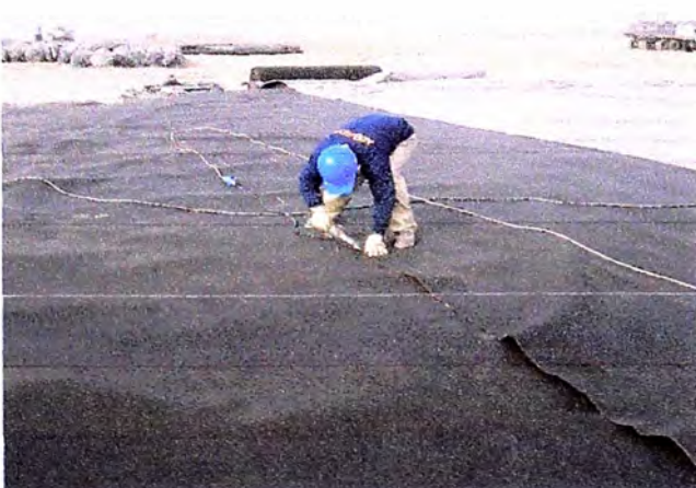
c.- Colocación de geotextil de protección
