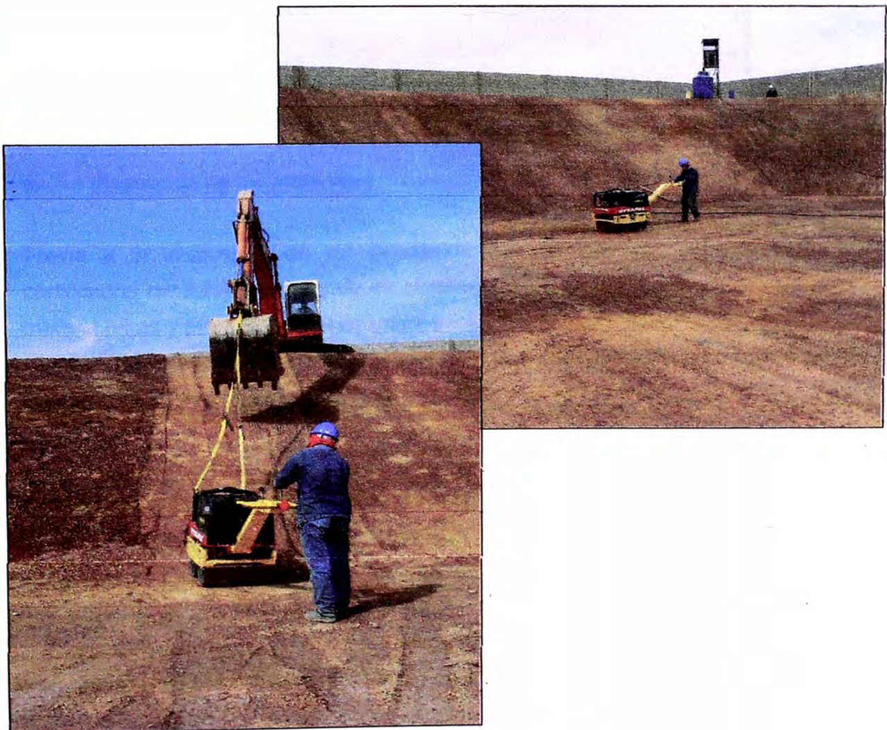
Figura 3.4 Compactación de arcilla colocada en el fondo y talud
