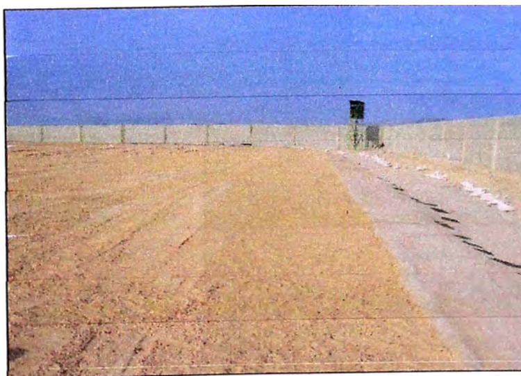
Figura 3.10 Colocación de arcilla – capa superior
