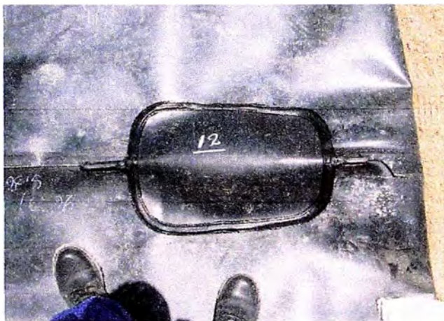
b.- Sellado del depósito con geomembrana (encapsulado)
