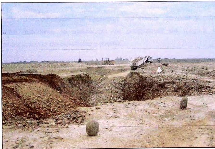
Figura 3.12 Relleno de "Trincheras"
