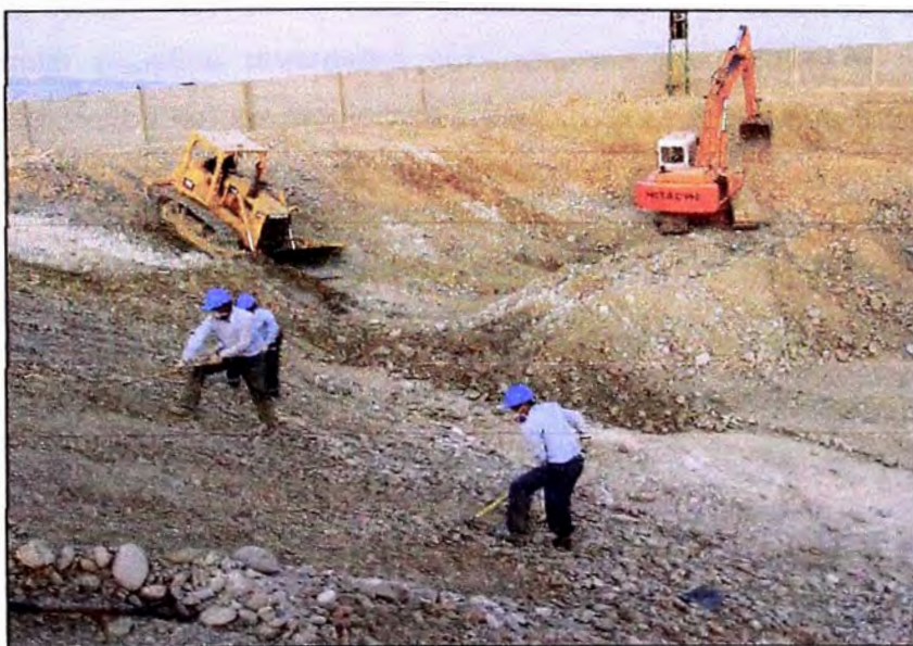
Figura 3.2 Escarificado y perfilado de taludes
