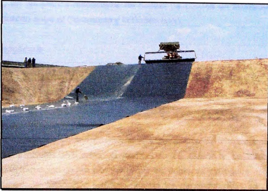
Figura 3.5 Instalación de Geomembrana
