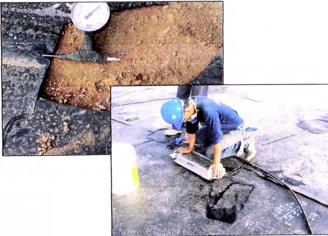
Figura 4.3 Ensayos de presión de aire y de vacío.
