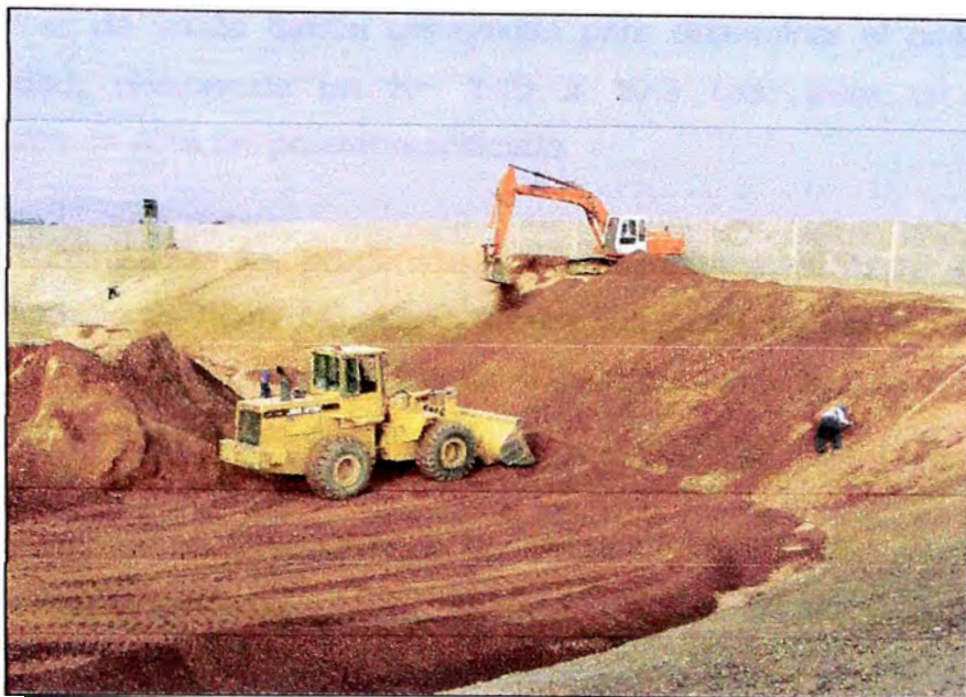
Figura 3.3 Colocación de arcilla
