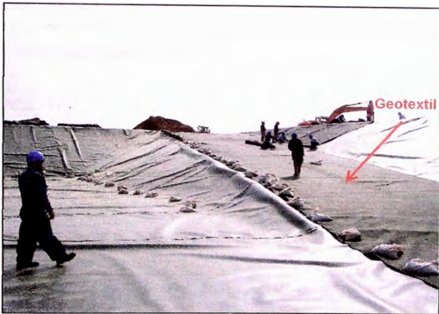
Figura 3.7 Instalación de geotextil
