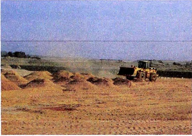
a.- Capa de arcilla en el área superior
