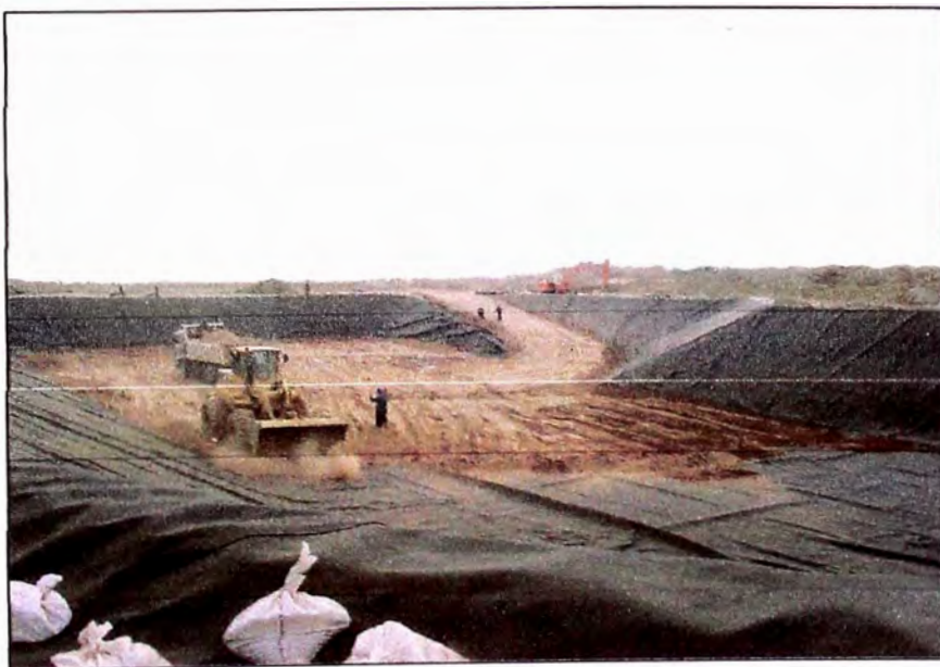
Figura 3.8 Colocación de capa de arcilla en el fondo del depósito
