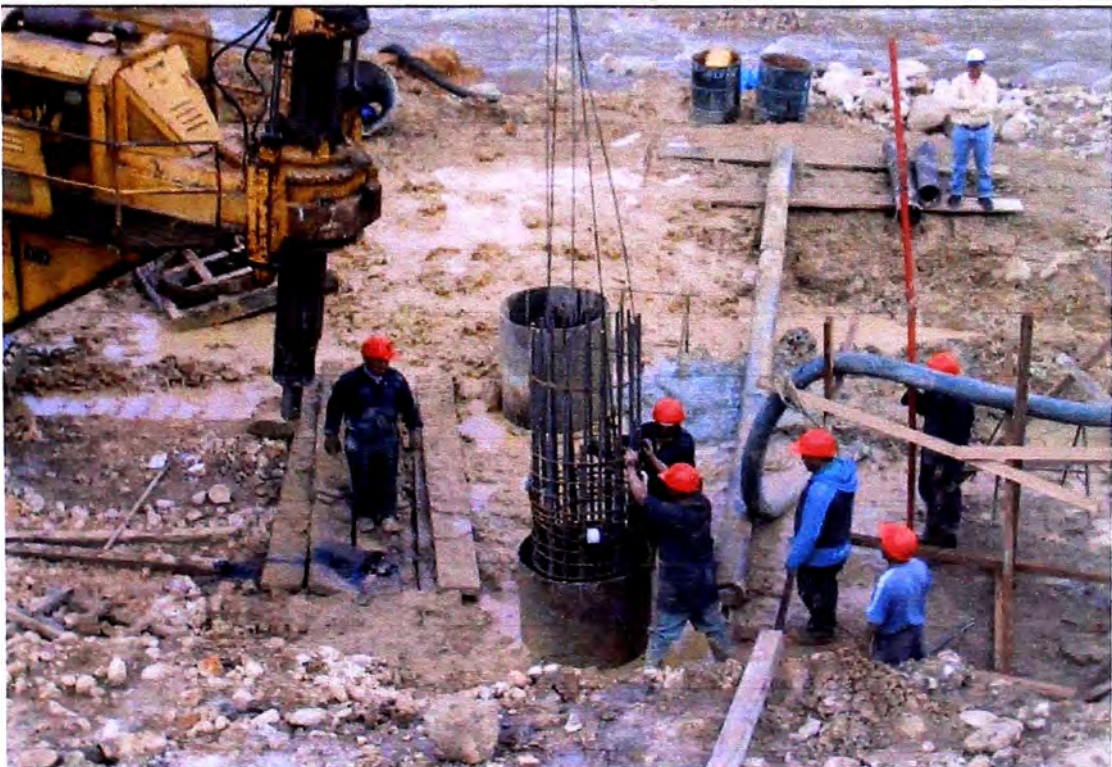
6.- COLOCACIÓN DE LA CANASTA DE ACERO
