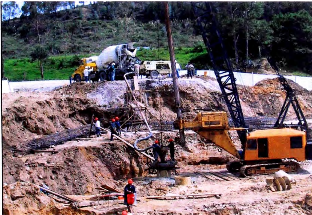
8.- VACIADO DE PILOTES CON CONCRETO PREMEZCLADO
