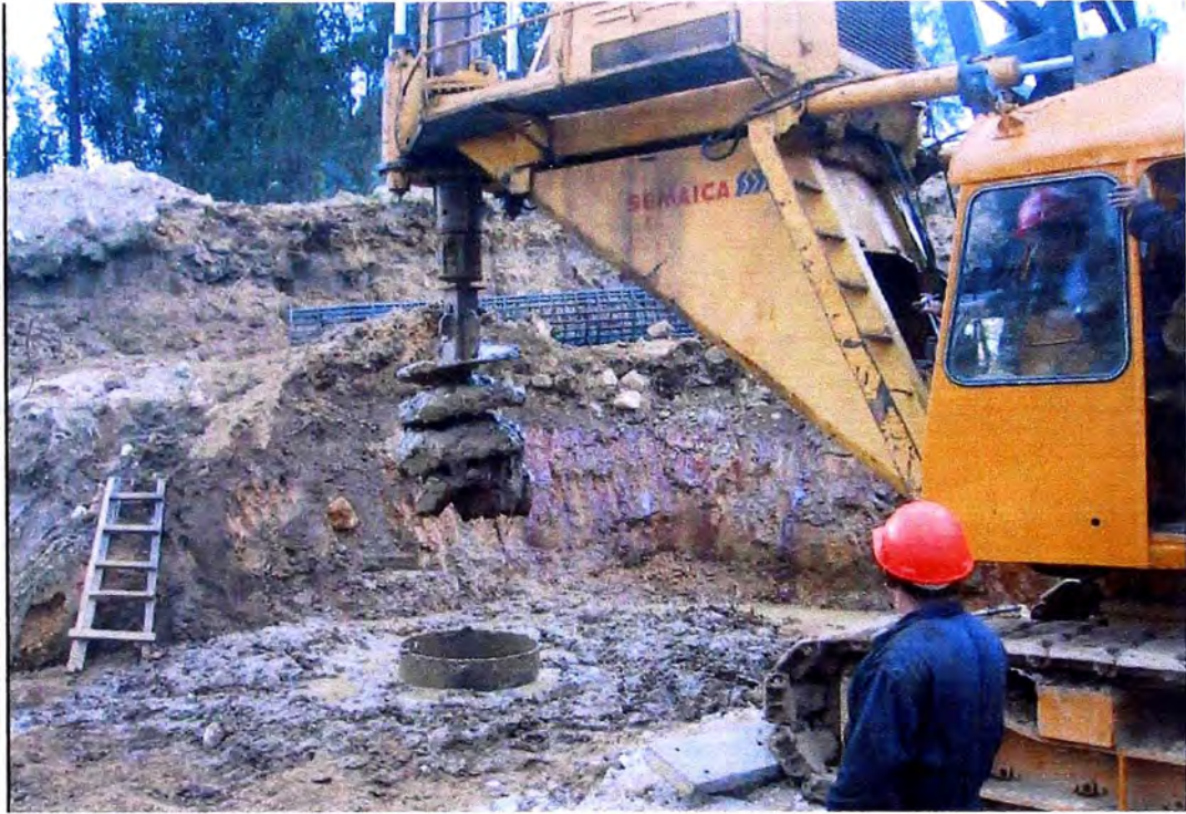
3.- EXCAVACIÓN CON ACCESORIO TORNILLO
