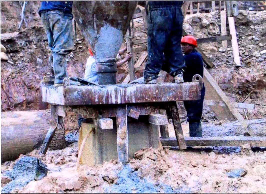
9.- DESPLAZAMIENTO DEL AGUA POR EL CONCRETO
