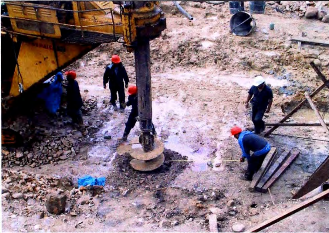
1.- COLOCACIÓN DEL TORNILLO EN EL PUNTO DE EXCAVACIÓN
