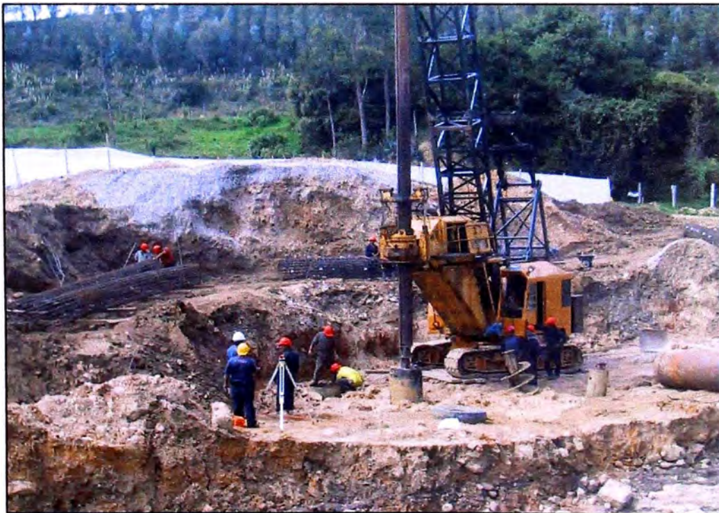
2.- COLOCACIÓN DE FUNDA METÁLICA
