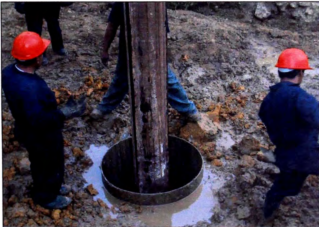
4.- BARRA KELLY CON FUNDA METÁLICA
