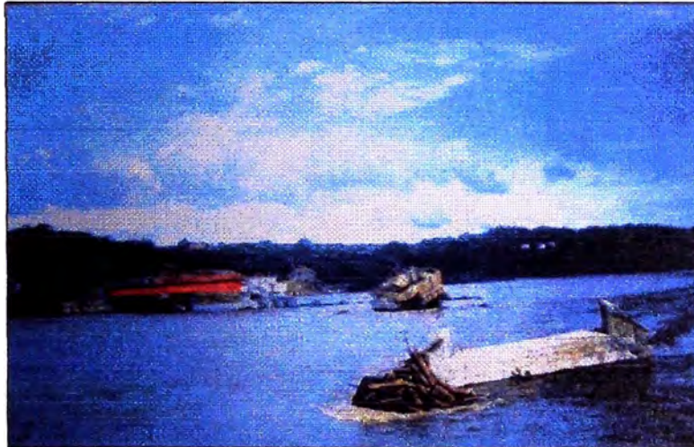
Foto III-01: Puente Franco dañado después de Fenómeno de El Niño.
