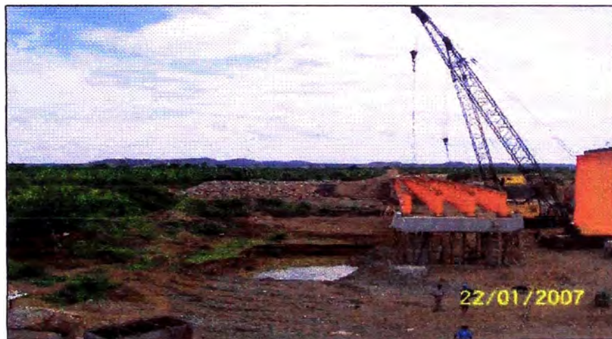
Foto IV-07: Colocación de Vigas Metálicas entre el pilar 3 y 4 .
