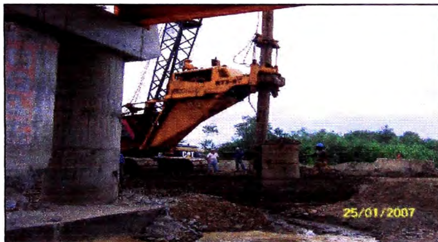
Foto IV-04: Excavación de pilotes de refuerzo en el pilar 2.
