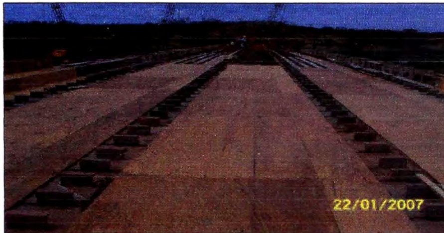
Foto IV-09: Encofrado de Losa del Tablero del Pte Franco.
