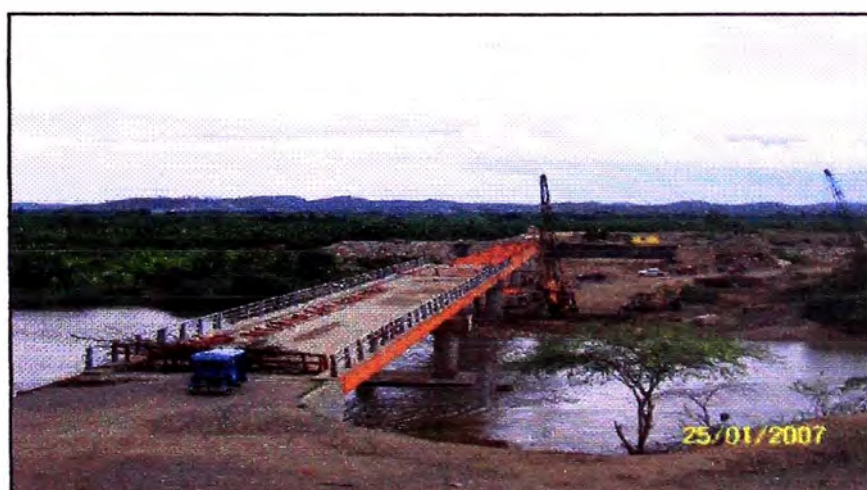
Foto IV-02: Vista General desde accesos de tramos existentes.
