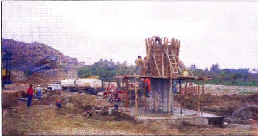
Foto IV-06: Encofrado de Pilares centrales del Puente Franco.
