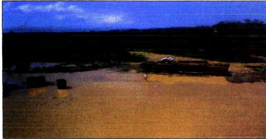
Foto IV-12: Zona de pilotes para prueba de carga inundada con crecida del río.
