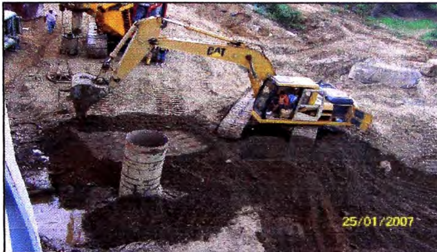
Foto IV-03: Preparación de terraplenes para pilotes excavados para reforzamiento de pilares existentes.
