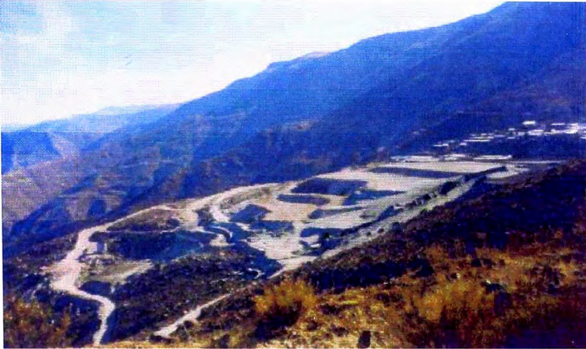
FOTO N° 01: Vista general y panorámica del talud principal de la relavera Yareta
