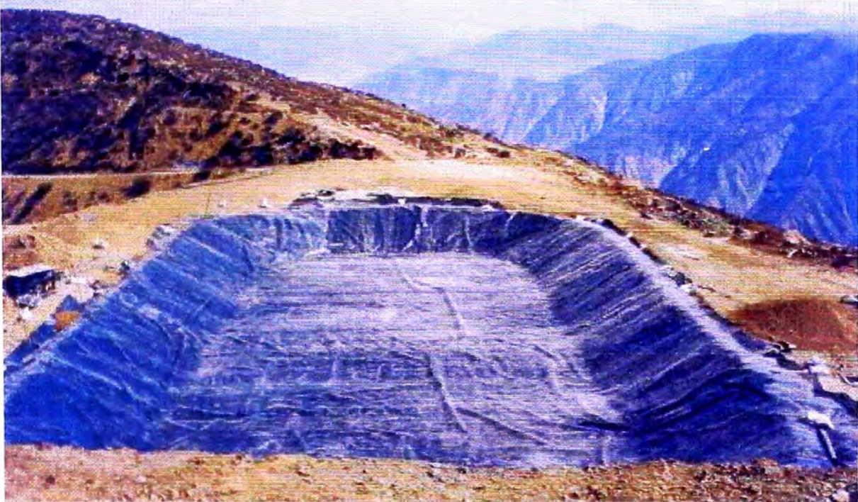
FOTO N° 43: Vista de la colocación completa de la geomembrana, listo para realizar el relleno del canal de anclaje.
