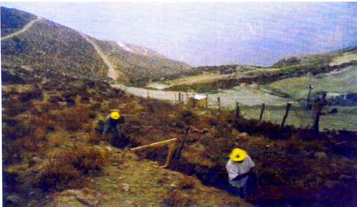
FOTO N° 25: Excavando el canal, haciendo uso de un marco para indicar los límites de perfilado y no sobreexcavar.
