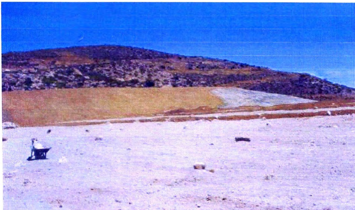
FOTO N° 11: Colocación de la cobertura luego de la nivelación, se realizó solo con tractor.
