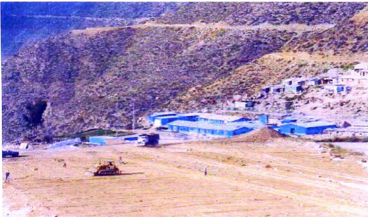
FOTO N° 14: Nivelación y colocación de la cobertura arcillosa del relave de flotación.
