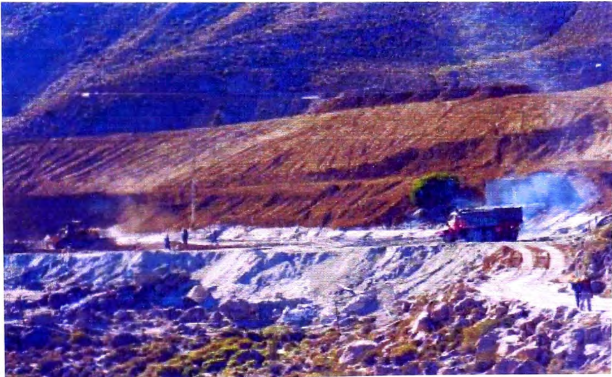
FOTO N° 16: Vista del muro construido en la base del talud del muro de cianuración, previo a la cobertura y perfilado del talud de la antigua planta de relleno hidráulico.
