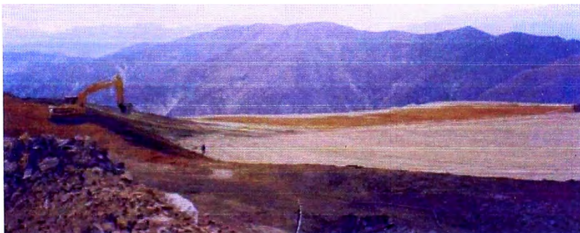
FOTO N° 10: Perfilado del talud de relave de cianuración.
