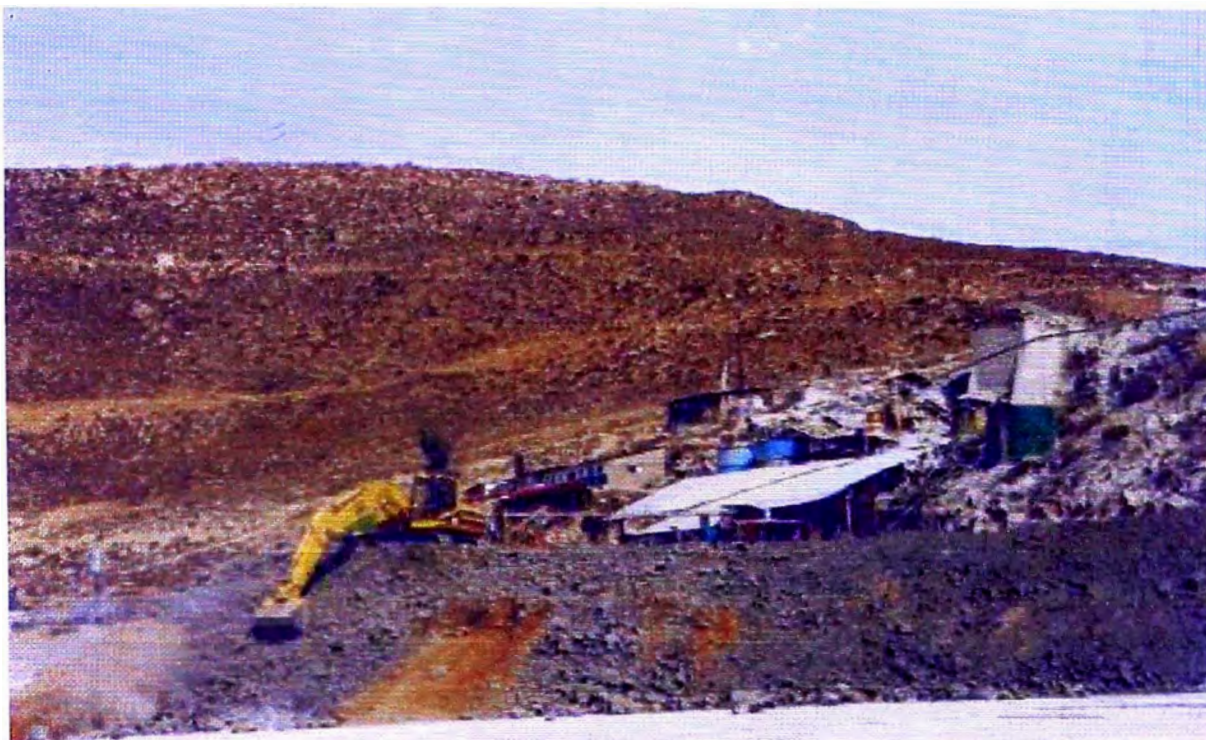
FOTO N° 19: Perfilado del talud del relave de cianuración, sobre la zona que aún se mantiene húmeda.
