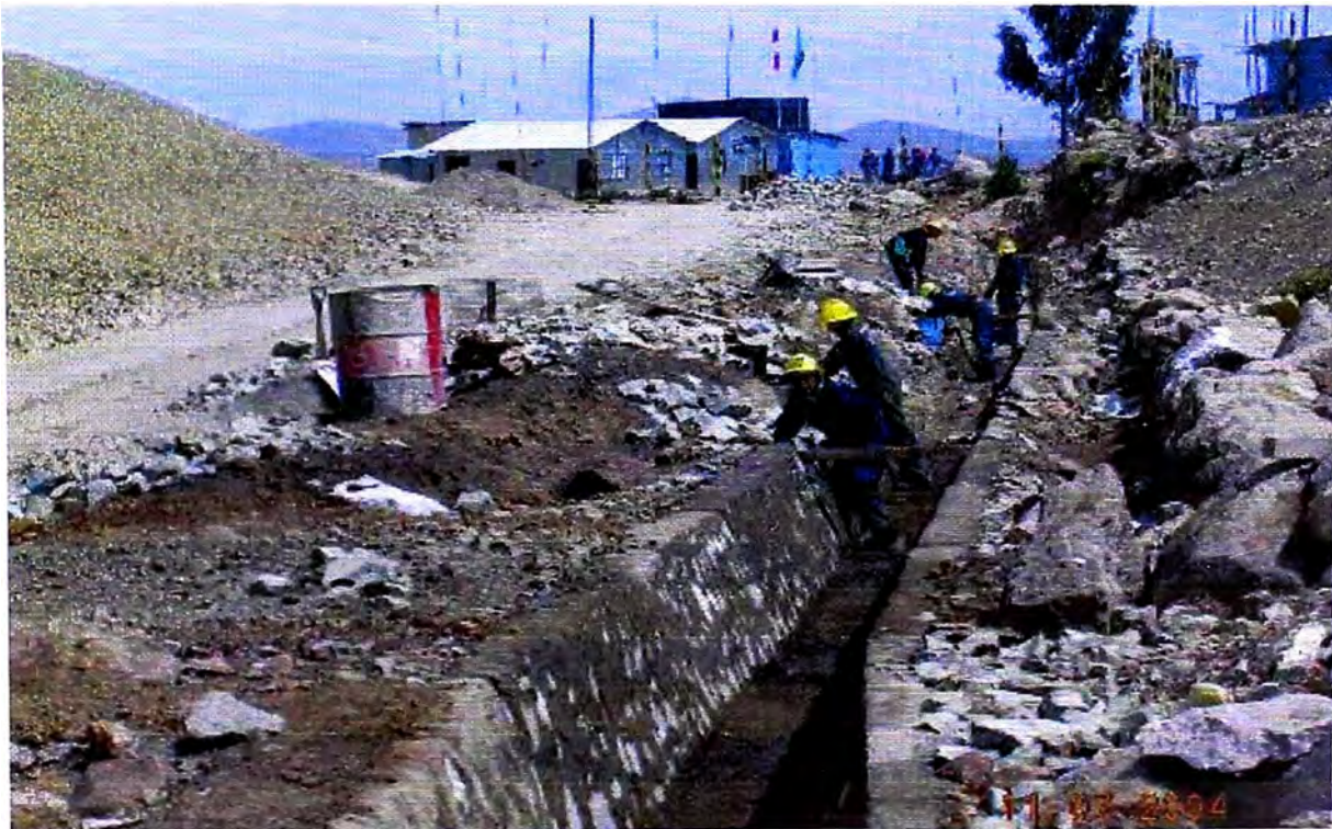
FOTO N° 33: Canal en proceso de revestimiento.
