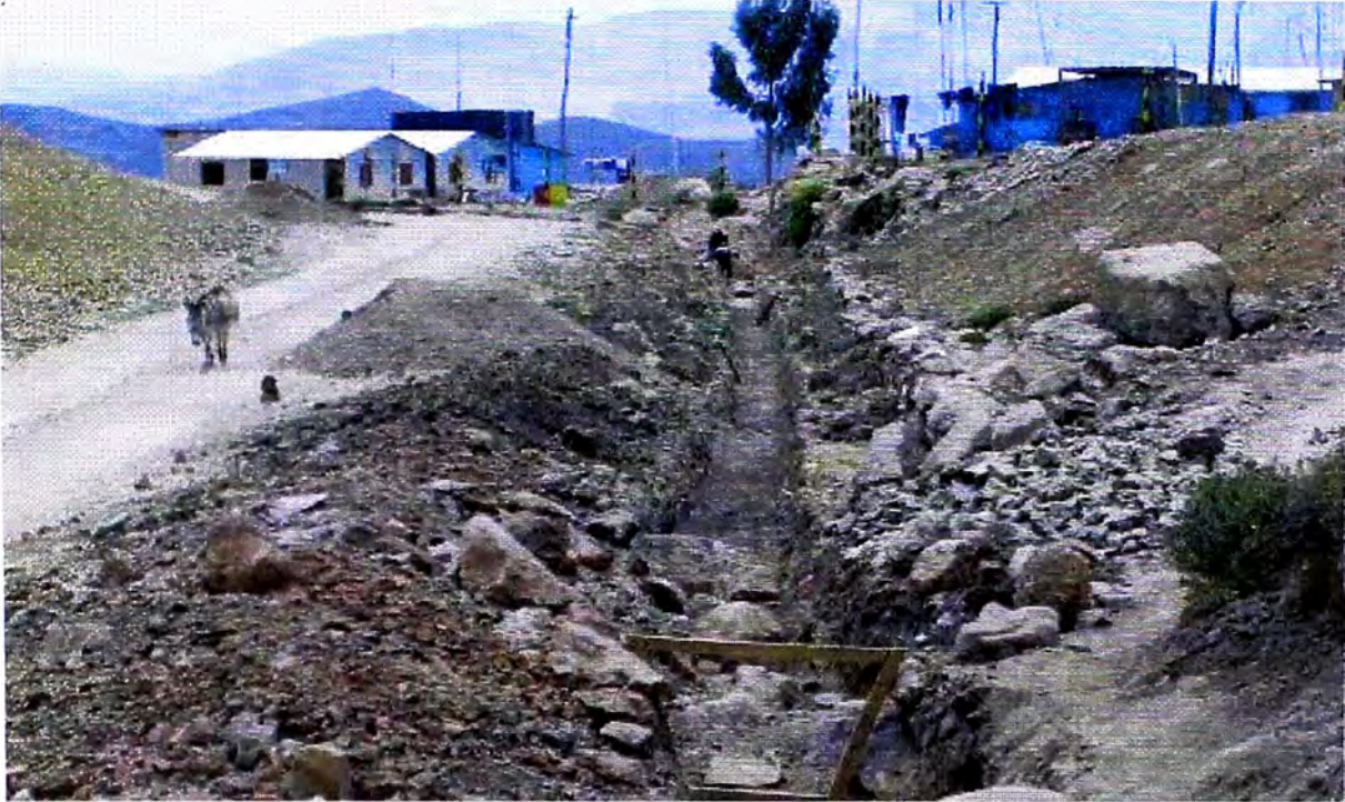
FOTO N° 32: Canal excavado que va dirigiéndose hacia la quebrada.
