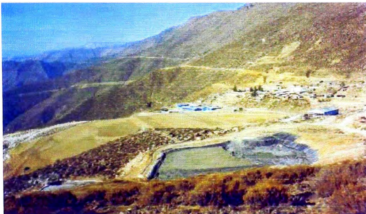
FOTO N° 22: Ejecución completa con cobertura de top soil.
