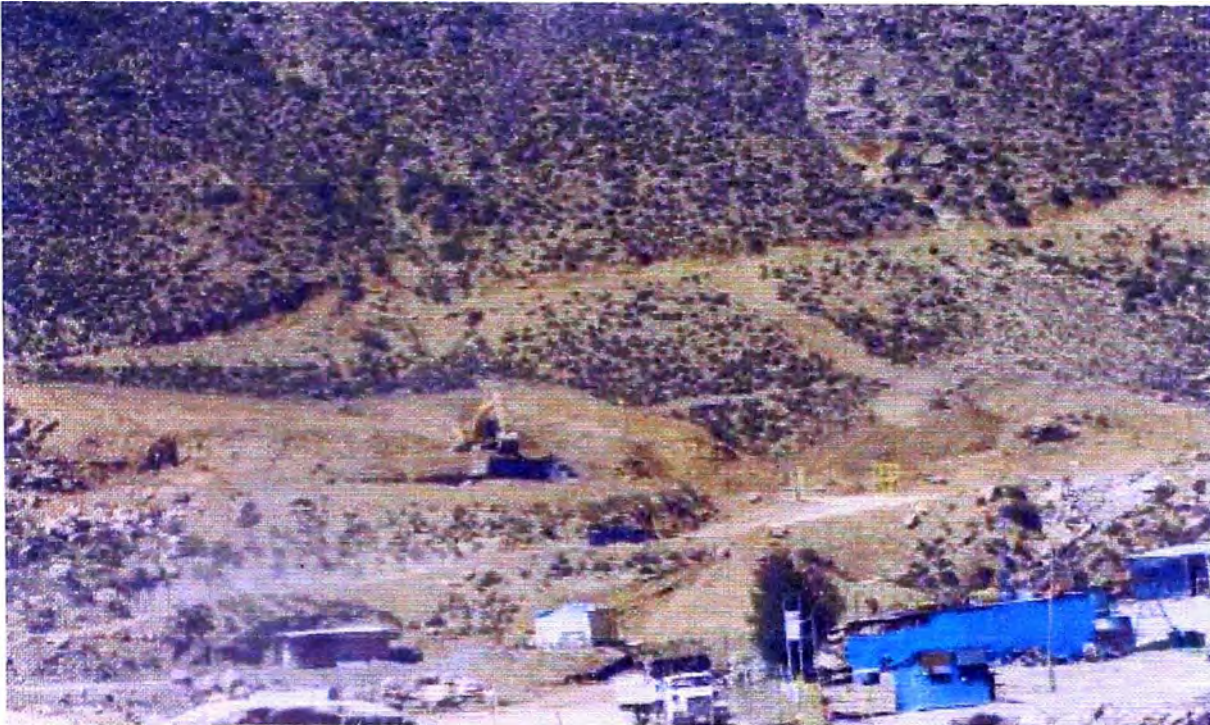
FOTO N° 13: Vista de la cantera que se utilizó para la cobertura en la parte superior de la relavera, el top soil se separó para colocarlo en la etapa
