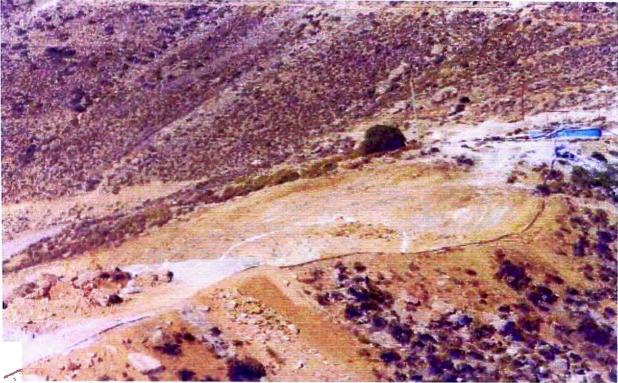
FOTO N° 35: Trazo del borde donde se excavará el reservorio.
