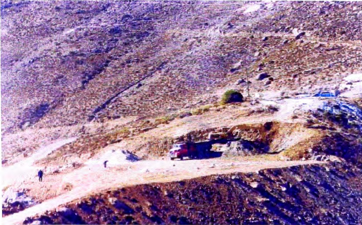
FOTO N° 37: Excavación hasta llegar al nivel superior del reservorio.
