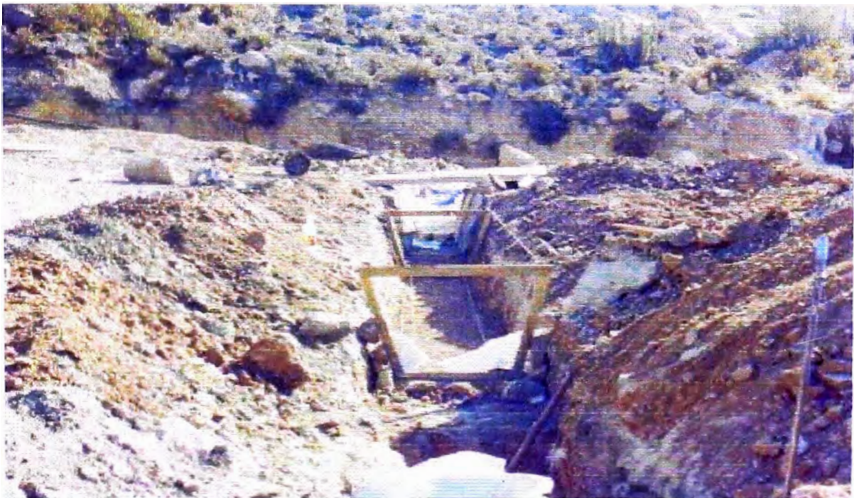
FOTO N° 27: Se muestra el trabajo de revestimiento se hace uso de marcos para obtener las dimensiones de diseño.
