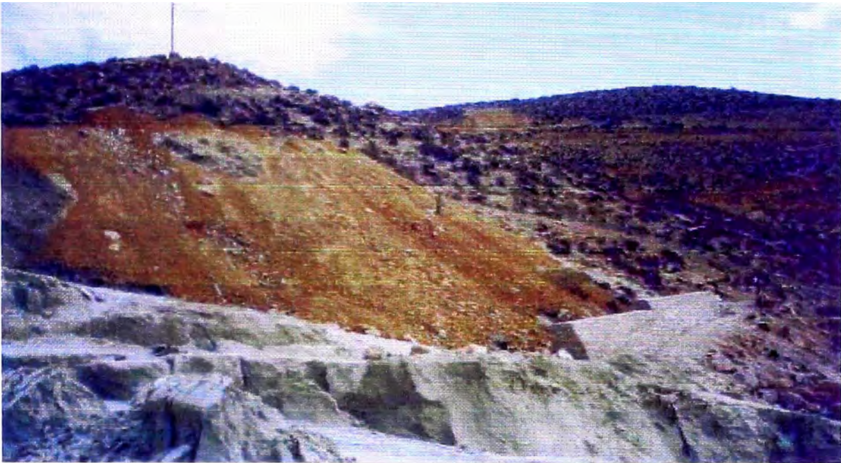
FOTO N° 15: Vista del muro construido en la base del talud del muro de cianuración, previo a la cobertura y perfilado del talud de la antigua planta de relleno hidráulico.
