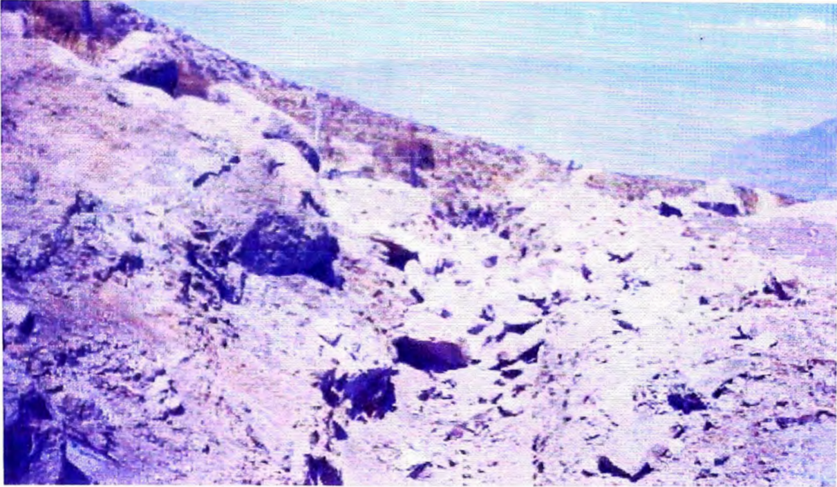
FOTO N° 26: Roca fractura luego del uso de explosivos para permitir el paso del canal.
