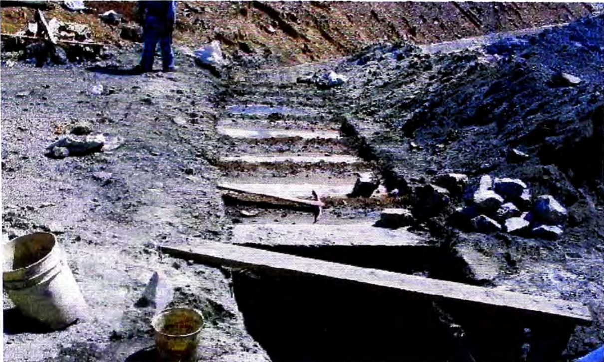
FOTO N° 28: Se ejecutó alcantarillas de concreto para mantener el tránsito en algunos cruces necesarios para continuar con la operación.
