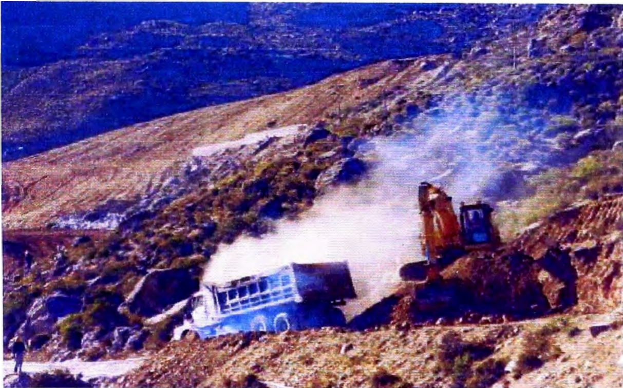
FOTO N° 17: Cantera para ejecutar la cobertura de la parte interior del talud.
