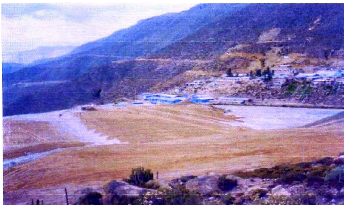
FOTO N° 12: Vista de la primera capa de cobertura colocada, consiste en un material arcilloso, como impermeabilizante.
