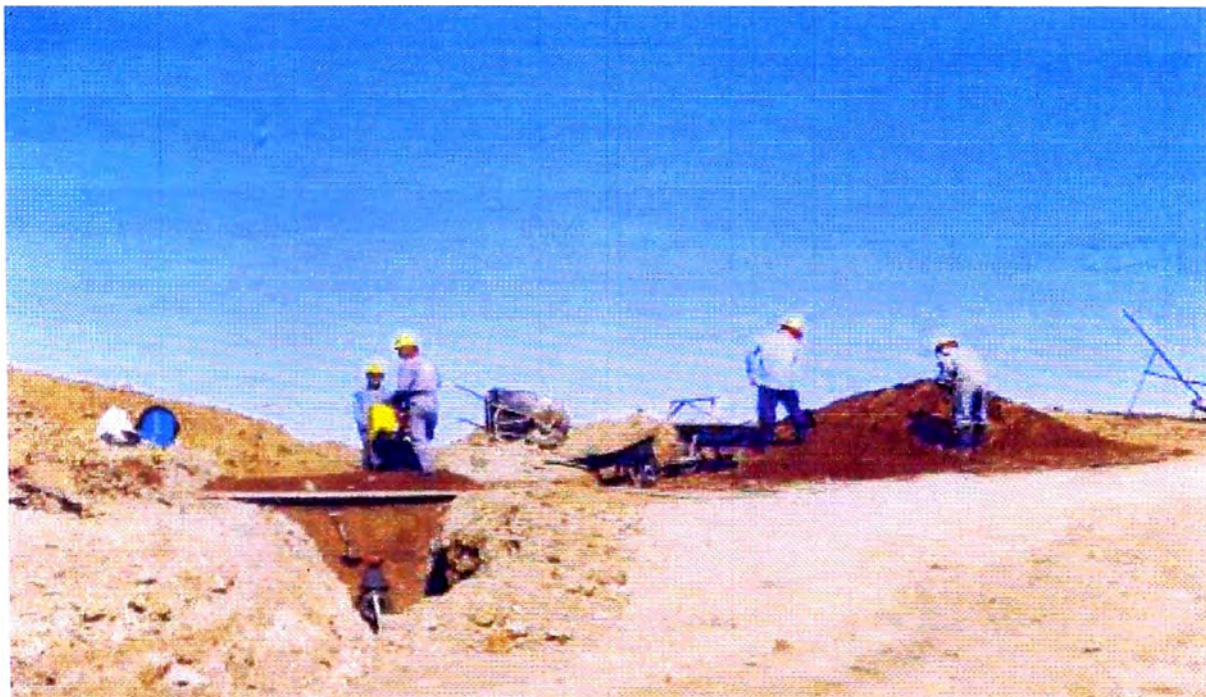
FOTO N° 41: Relleno y compactación donde se instaló la tubería de captación.
