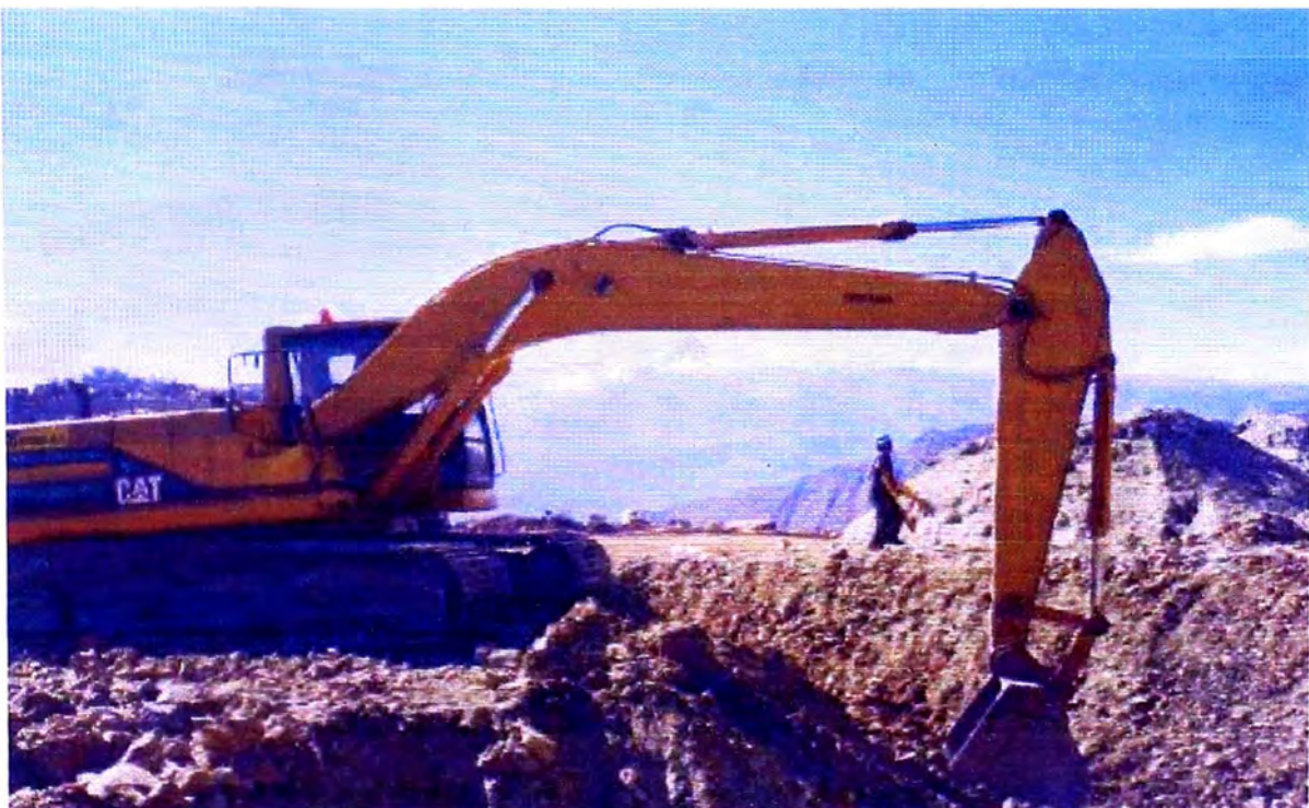
FOTO N° 38: Excavación del reservorio que tiene una profundidad de 2 m se observa al personal que apoya el equipo con una escuadra que verifica el talud.
