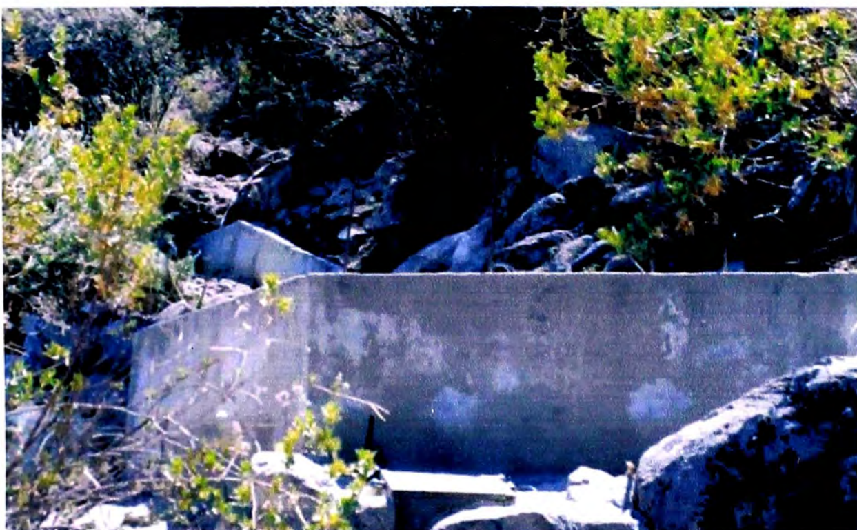
Foto 2.1 Bocatoma que capta las aguas del manantial Chiuro
