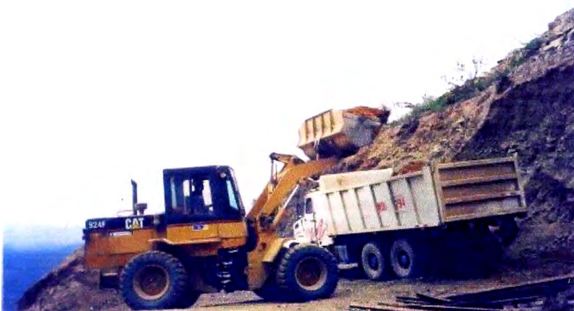
Foto 1.1: Carguío de material en bocamina. La bocamina se encuentra a varios metros a la derecha (no se muestra)
