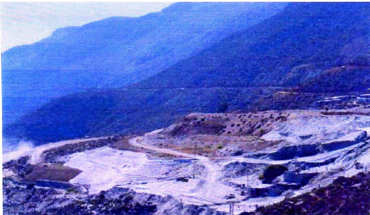
FOTO N° 08: Parte del talud ejecutado manualmente, se muestra un muro de contención y el dique de piedra.
