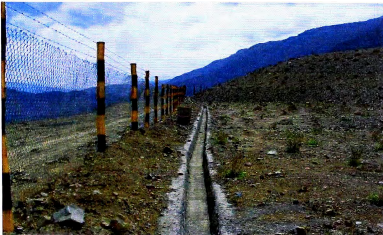
FOTO N° 34: Canales intermedios construidos que cruzan la relavera.
