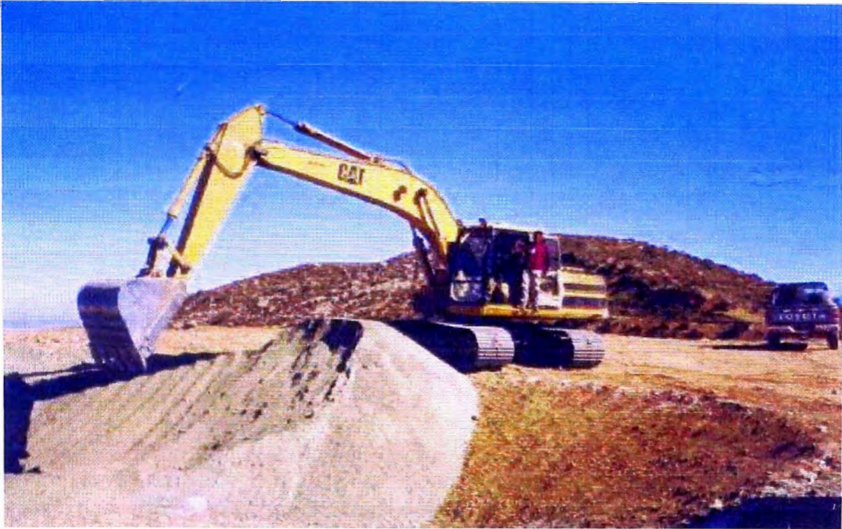
FOTO N° 39: Colocando la cama de arena con el apoyo de la excavadora.
