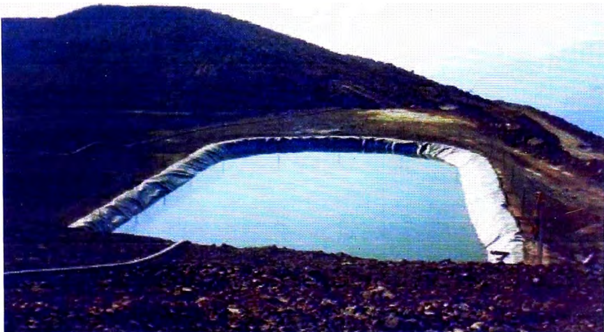
FOTO N° 44: El reservorio en funcionamiento, con una malla lateral de cerco perimétrico.
