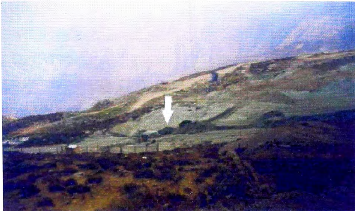
FOTO N° 03: Vista de la planta de relleno hidráulico que funcionaba en la relavera Yareta antes del cierre.
