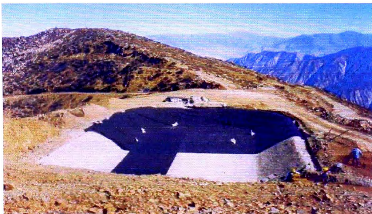
FOTO N° 42: Colocación del geotextil, también se observa el canal de anclaje.
