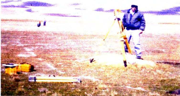
Foto 2-7 Trazo y Replanteo para Laguna de Estabilización en Junín
