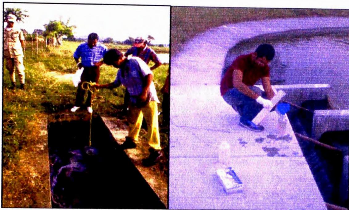
Figura 7-14: Limpieza de los lodos en lagunas facultativas. Se muestra a los operarios realizando la limpieza de los lodos en las lagunas facultativas. A la izquierda se observa a los operarios midiendo la estructura de concreto de la laguna. A la derecha se observa a un operario realizando la limpieza de los lodos en la laguna.
