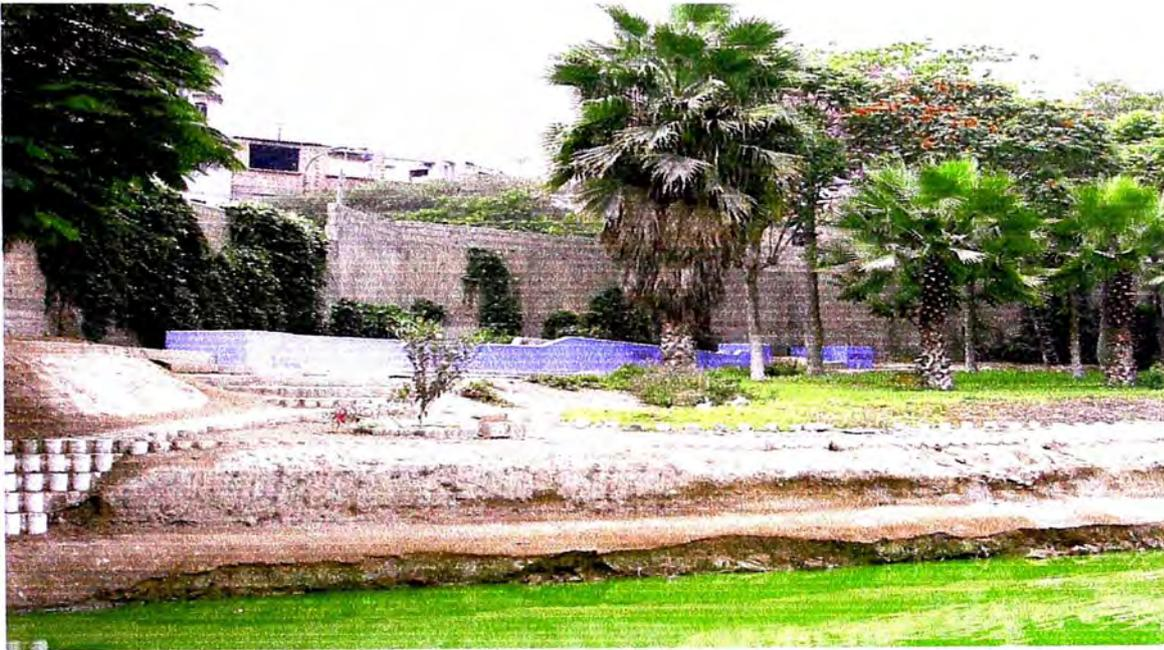
foto 2-3: Podemos observar como el talud ha erosionado, por una mala impermeabilización de este o quizá por falta de mantenimiento.
