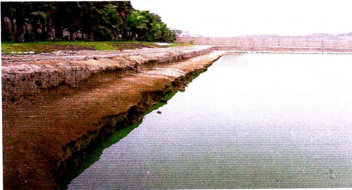
Foto 2-4 Nótese que el talud ya ha sido socavado por el agua, a tal punto que no se distingue el mismo. Fotos UNITAR.
