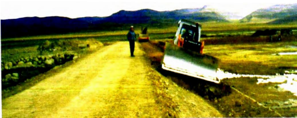
Foto 2-17: Observar como debe quedar un talud terminado. PTAR Junín.
