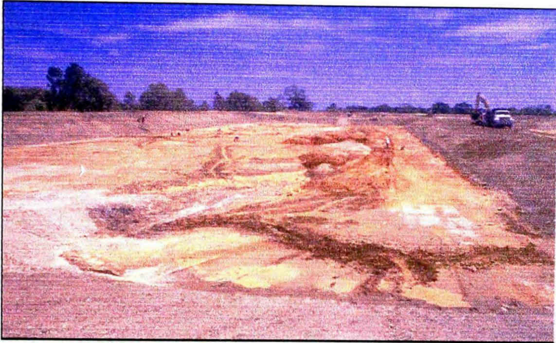
Foto 2-19: Impermeabilización de lagunas con 3rcilla.
