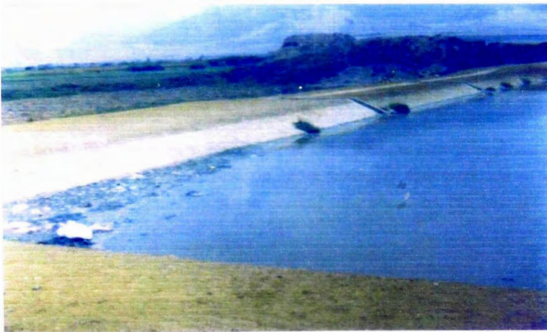
Foto 2-18: Talud interior revestido con mampostería de piedra (pedraplen) .PTAR Moche.
