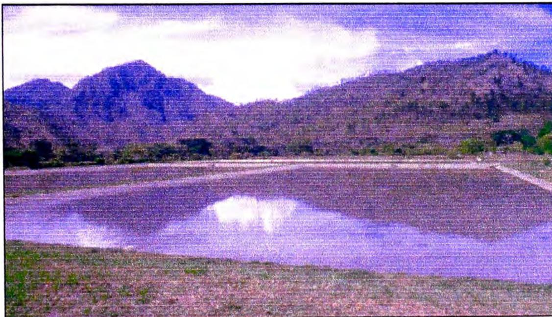
foto 2-1 -Ejemplos de sistemas de lagunas bien diseñadas y mantenidas. Los terraplenes están mantenidos con el corte de hierbas en la orilla. Los taludes interiores tienen un revestimiento de concreto o mortero que sirve para controlar el crecimiento de plantas acuáticas y evitar la erosión por acción de olas. La superficie del agua no tiene materiales flotantes ni natas, y el nivel del agua está mantenido en el centro del revestimiento. (Foto :Villanueva, Honduras.)
