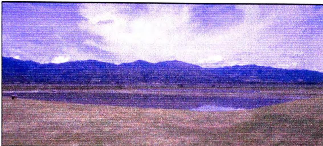
Foto 2-2 La superficie del agua no tiene materiales flotantes ni natas, y el nivel del agua está mantenido en el centro del revestimiento. ( Foto: Danlí, Honduras.)
