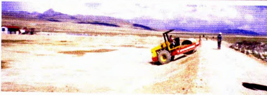
Foto 2-13: Compactación de taludes PTAR Junín, nótese que debe quedar completamente liso y uniforme.
