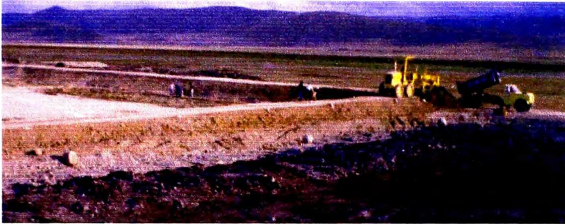
Foto 2-9: Formación de los taludes con material de préstamo. PTAR Junín.
