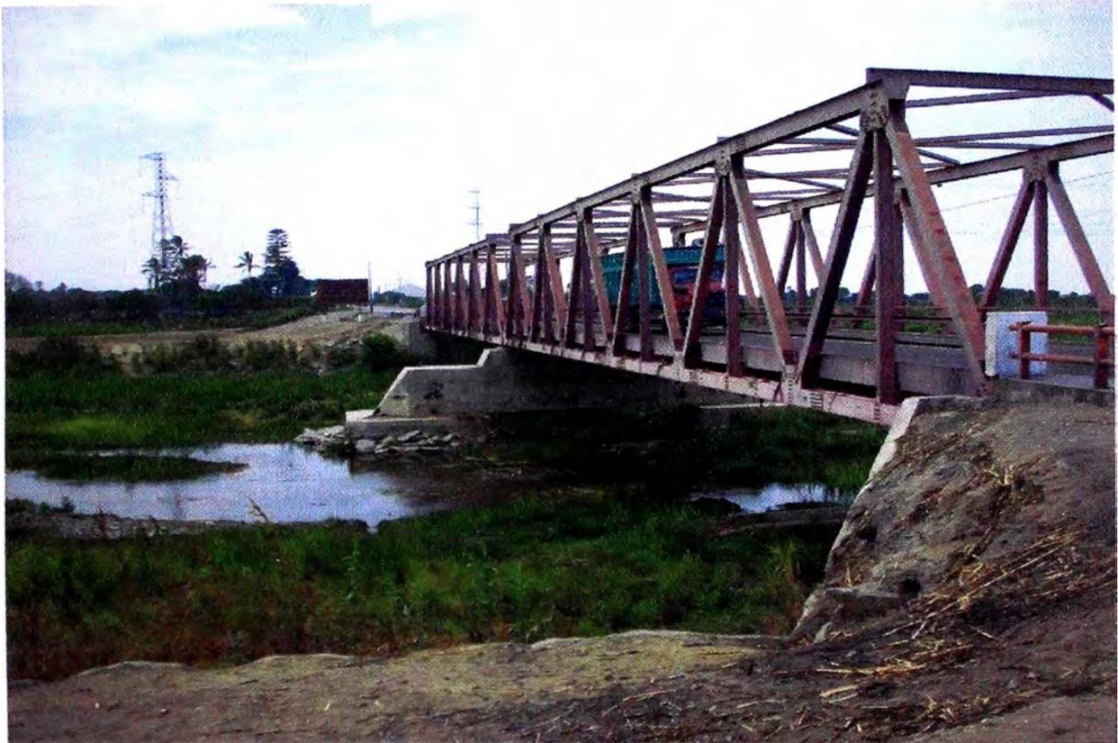
**Fig. 05 Vista de los estribos y apoyos existentes.**
