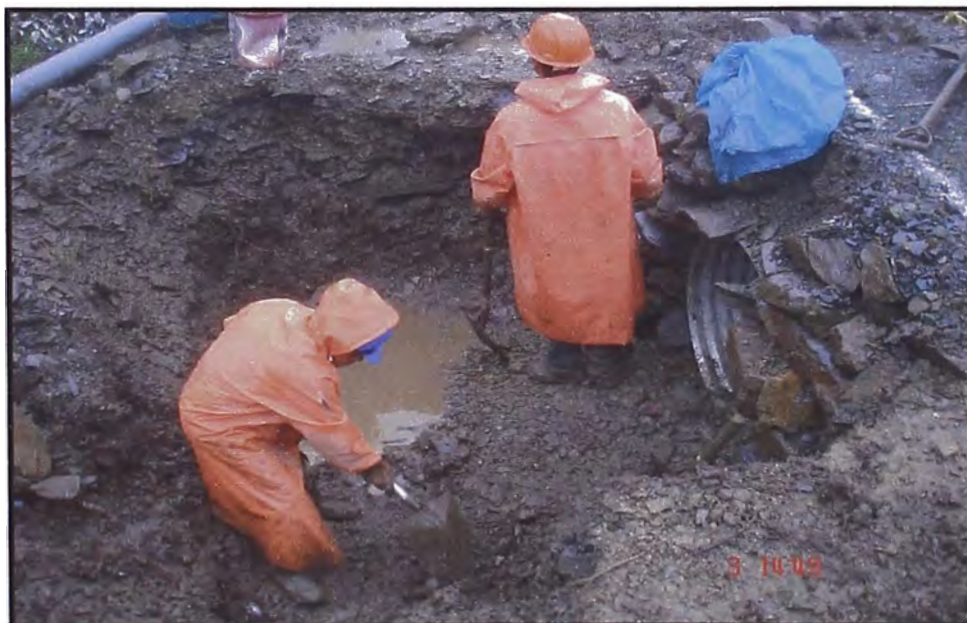
LIMPIZA Y ELIMINACION DE MATERIAL SATURADO
