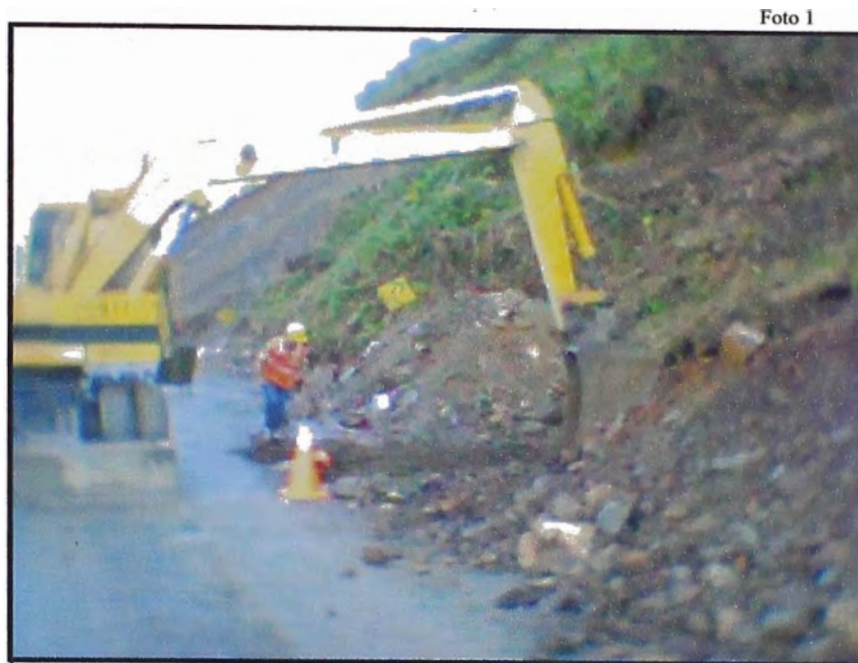
EXCAVACION DE ALCANTARILLA CON EQUIPO MECANICO
