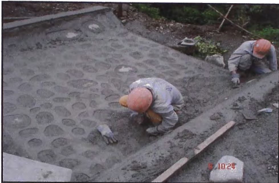
LLENADO DE JUNTAS CON MORTERO
