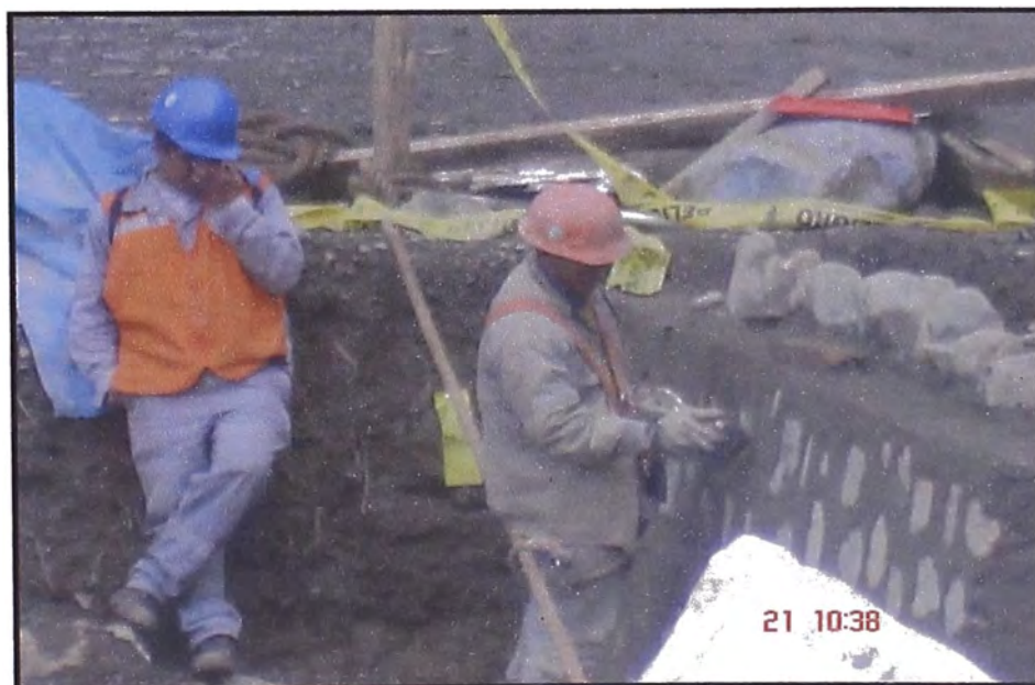
SOLAQUEADO DE MURO DE MAMPOSTERIA
