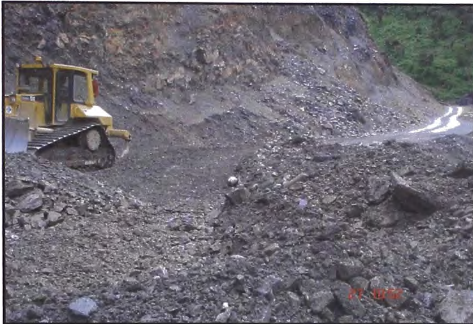
EXCAVACION DE BADEN CON TRACTOR
