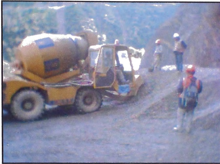
CARGANDO AGREGADO GRUESO
