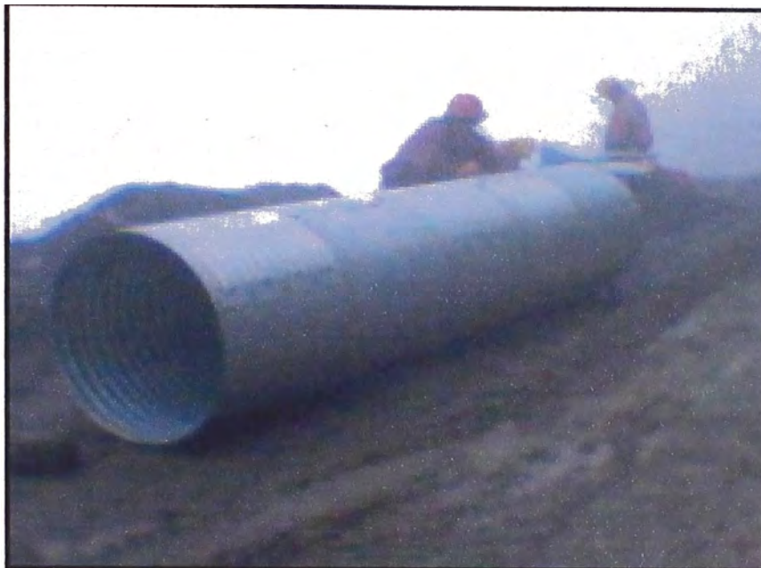
ALCANTARILLA DE TMC ARMADA Y LISTA PARA INSTALARSE
