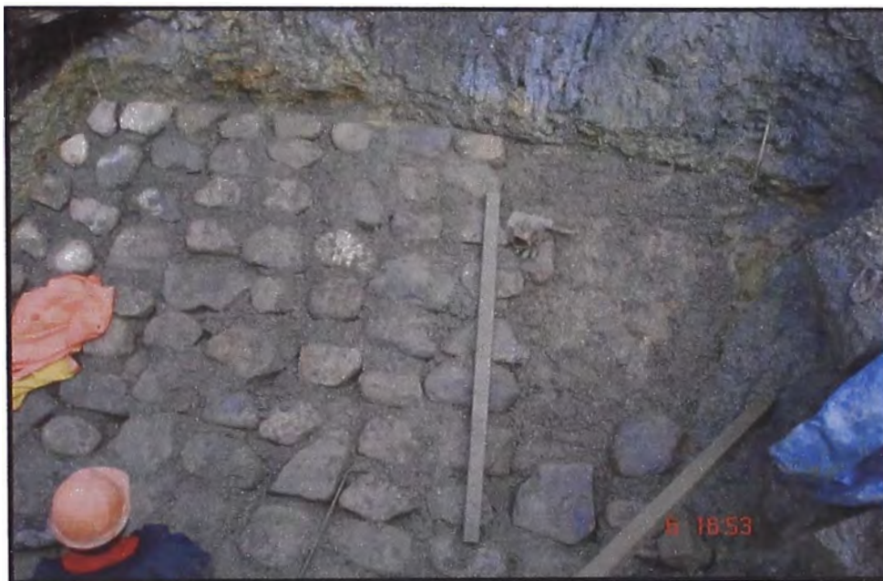
NIVELACION DE LAS PIEDRAS UTILIZANDO REGLA DE MADERA
