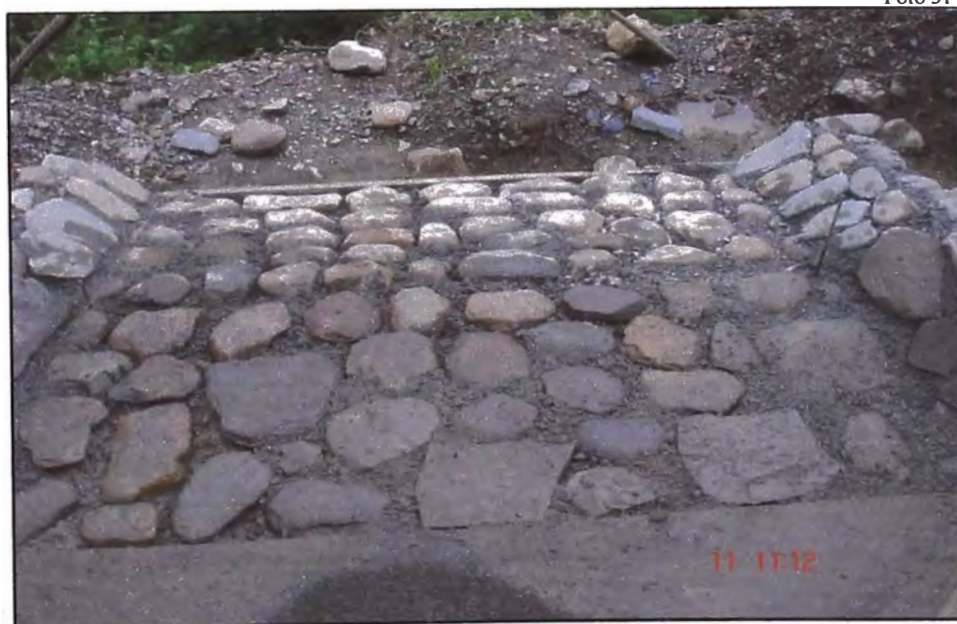
COLOCACION DE PIEDRAS SIGUIENDO LA FORMA DEL EMBOQUILLADO
