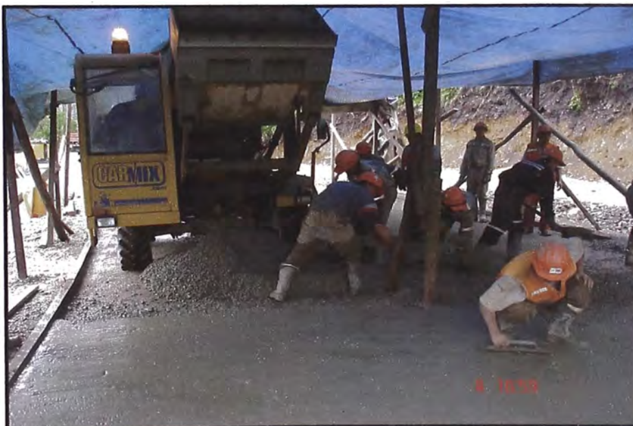
VACIADO DE SOLADO BAJO CARPA PARA PROTEJERSE DE LA LLUVIA
