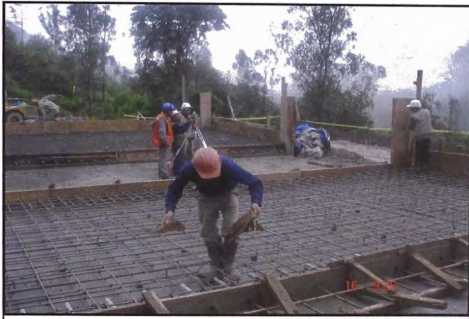
ENCOFRADO Y ACERO LISTOS PARA EL VACIADO DE CONCRETO
