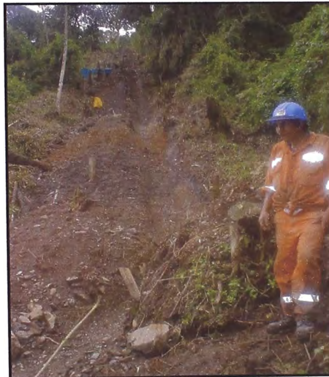
EXCAVACION DE ZANJAS DE ENCAUZAMIENTO
