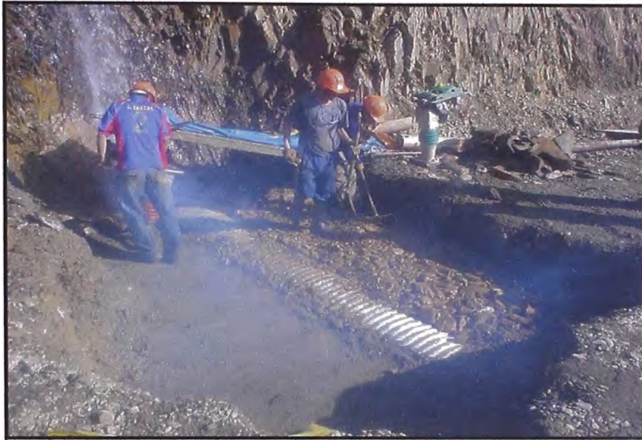
COMPACTACION DE LOS COSTADOS DE LA ALCANTARILLA
