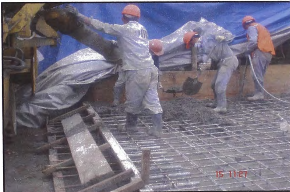
VACIADO DEL BADEN POR MEDIO DEL CHUTE DEL CARMIX
