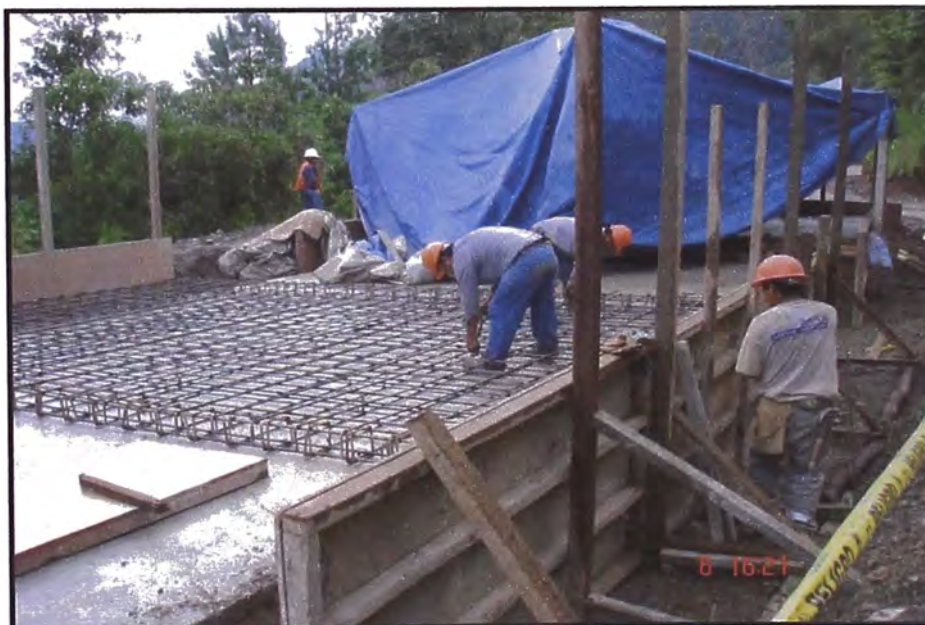
ARMADO DE MALLAS DE ACERO EN EL BADEN
