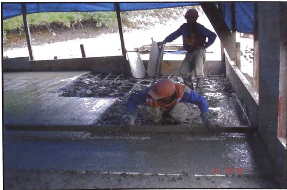
ENRASADO DEL BADEN CON REGLA DE MADERA (REGLEADO)
