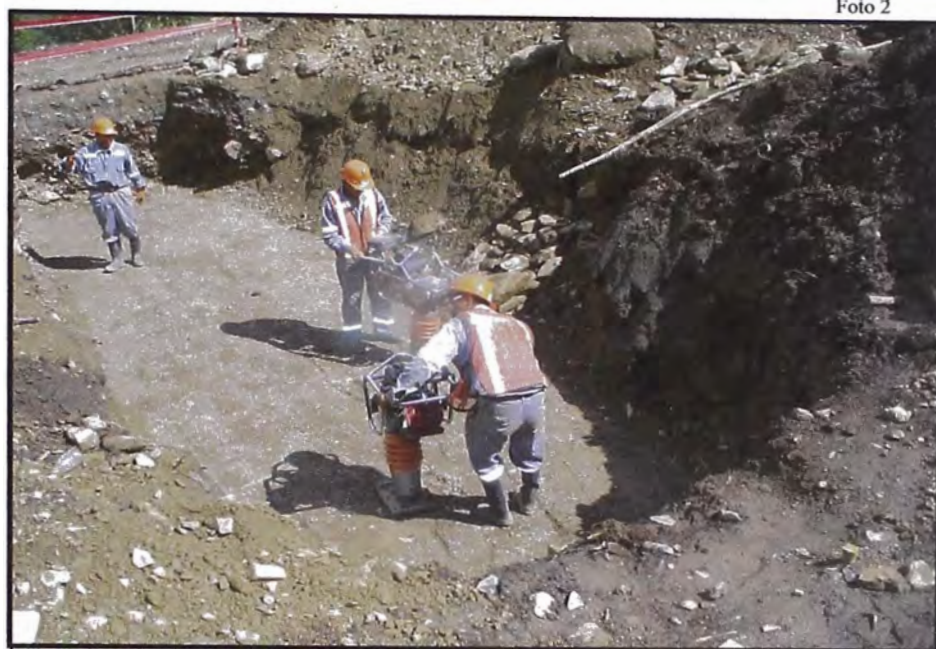
COMPACTACION DE BASE CON VIBROPISONADORES
