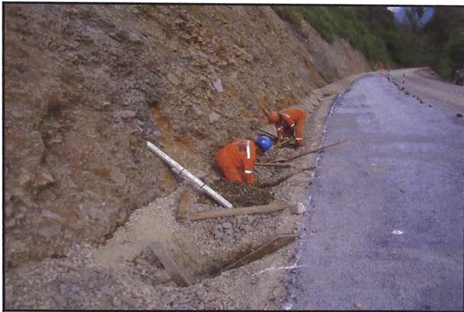
COLOCACION DE CERCHAS DE MADERA UTILIZANDO NIVEL DE MANO
