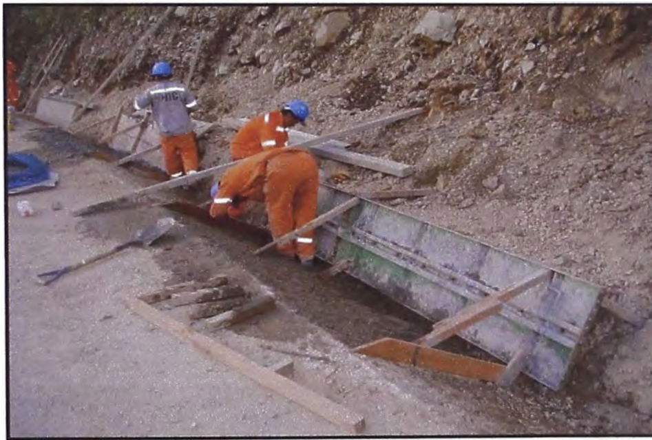
ENCOFRADO USANDO PANEL METALICO
