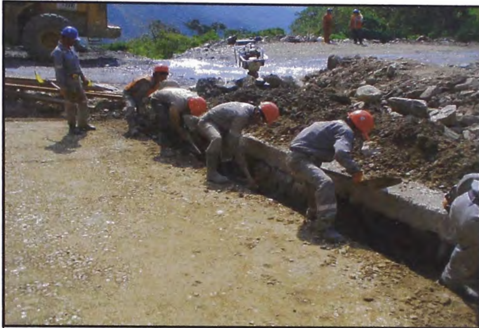
EXCAVACION MANUAL DE LAS UÑAS DEL GAVION
