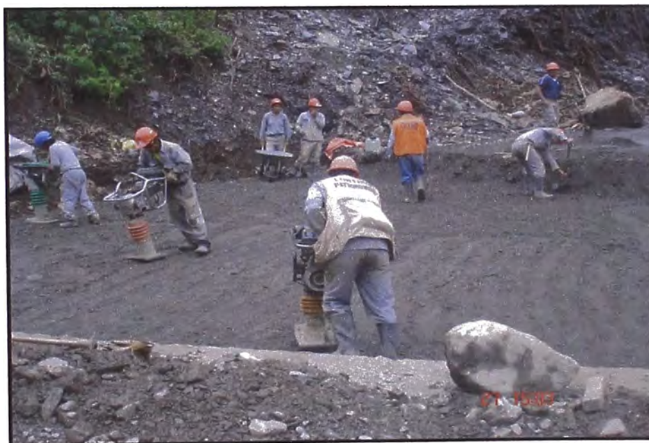
COMPACTACION DE BASE DEL BADEN CON VIBROPISONADORES
