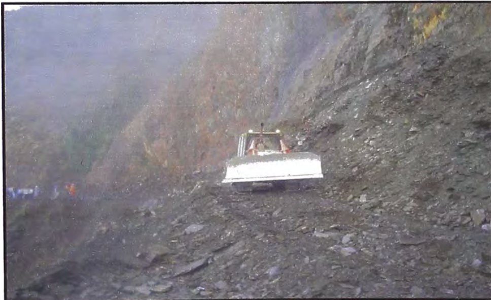
LIMPIEZA DE DERRUMBE CON TRACTOR
