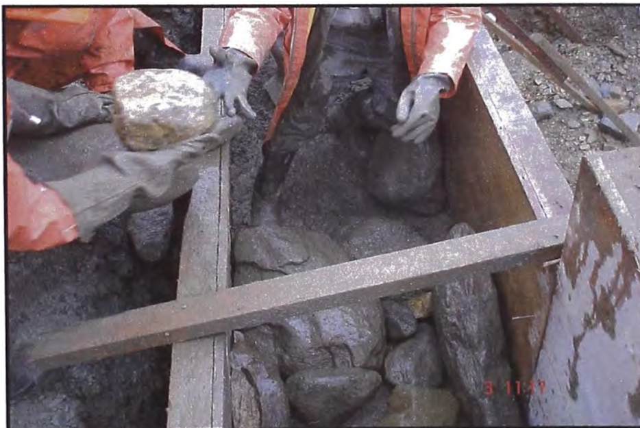
ACOMODO DE LAS PIEDRAS DENTRO DEL ENCOFRADO
