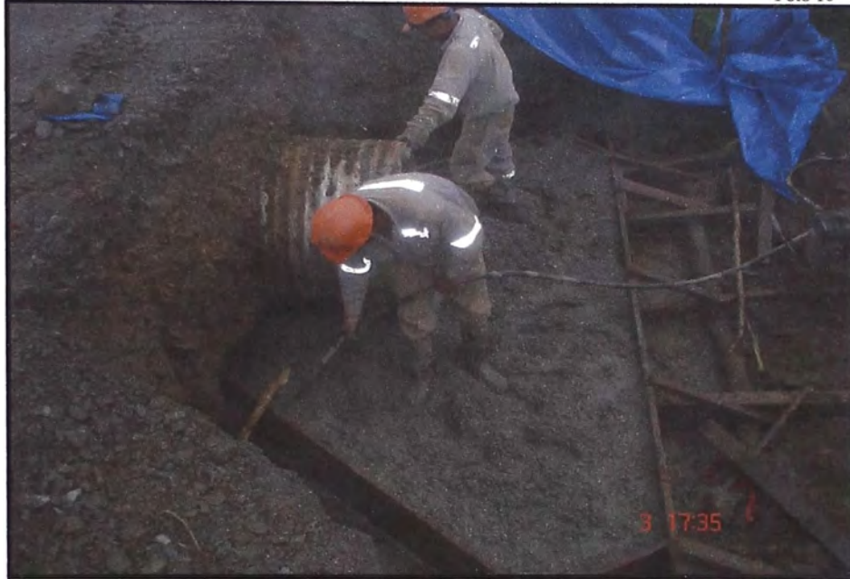
COLOCACION Y VIBRADO DE CONCRETO DE CIMENTACION
