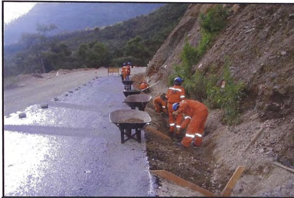
REFINE DE CUNETAS USANDO LAS CERCHAS COMO GUIAS
