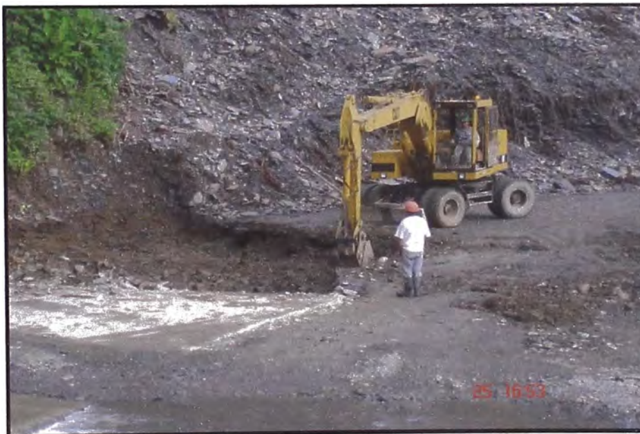
EXCAVACION DE BADEN CON EXCAVADORA
