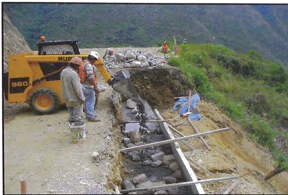
VACIADO DE PRIMER CUERPO DEL MURO POR MEDIO DE UN MINICARGADOR
