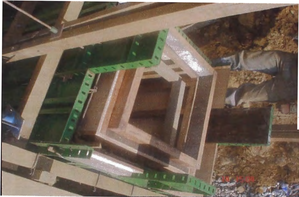
ENCOFRADO DE CAJA DE REGISTRO
