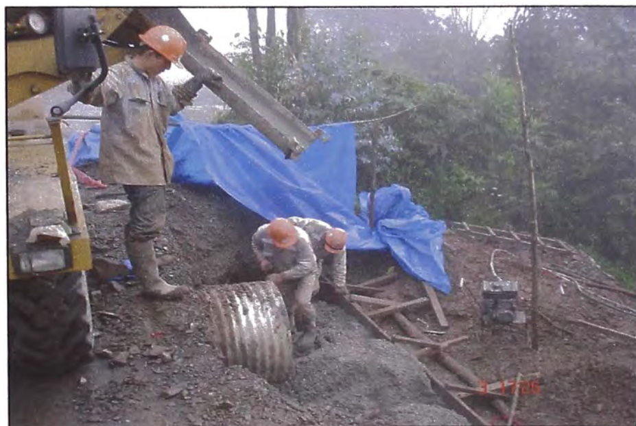
VACIADO DE LA CIMENTACION MEDIANTE EL USO DEL CARMIX
