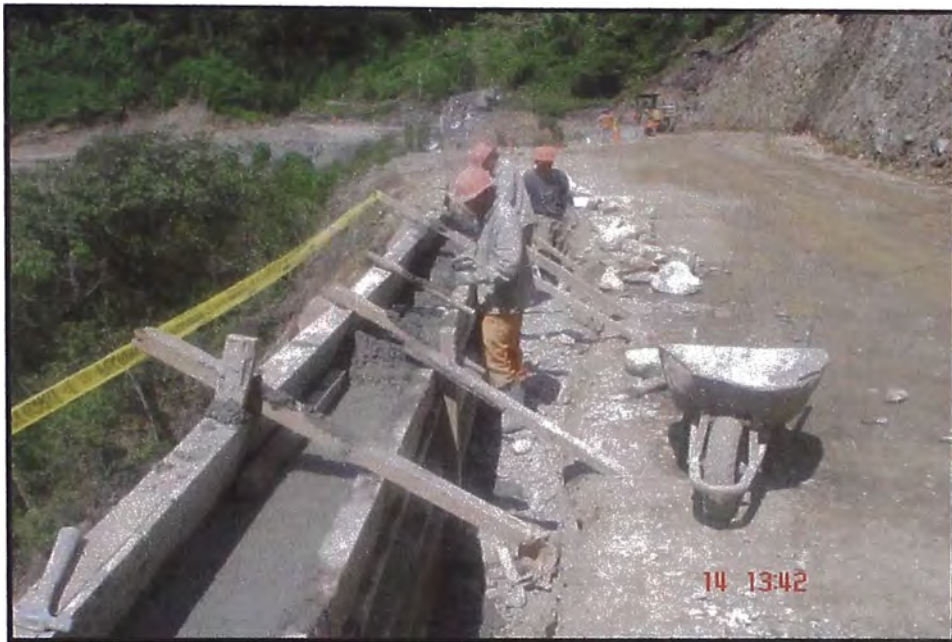
VACIADO DEL ULTIMO CUERPO DEL MURO DE MAMPOSTERIA
