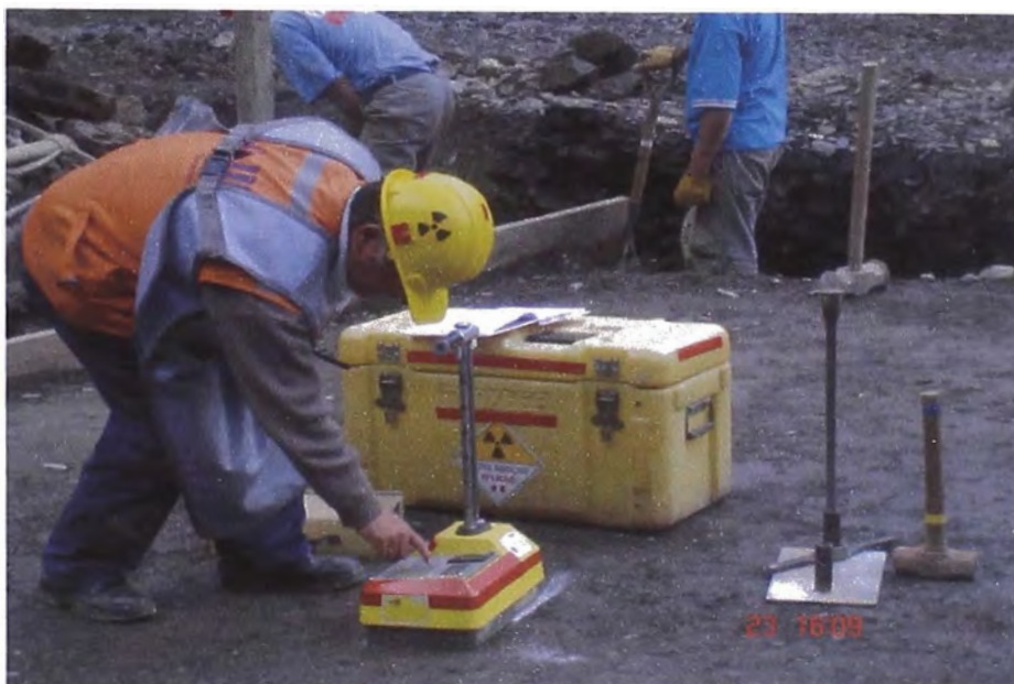
TOMANDO PRUEBAS DE COMPACTACION CON DENSIMETRO NUCLEAR
