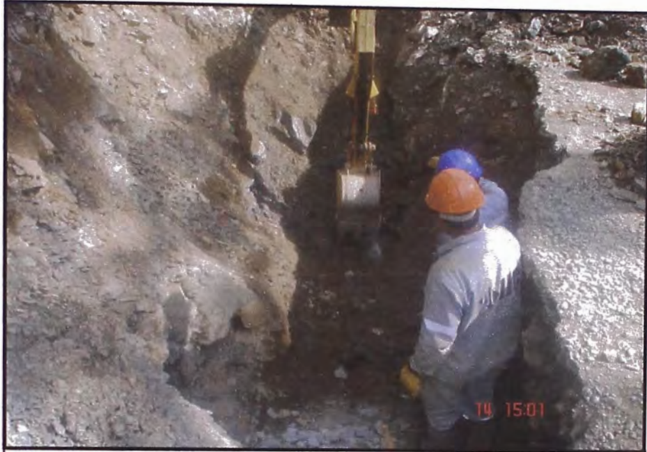
EXCAVACION DE SUB-DREN CON RETROEXCAVADORA
