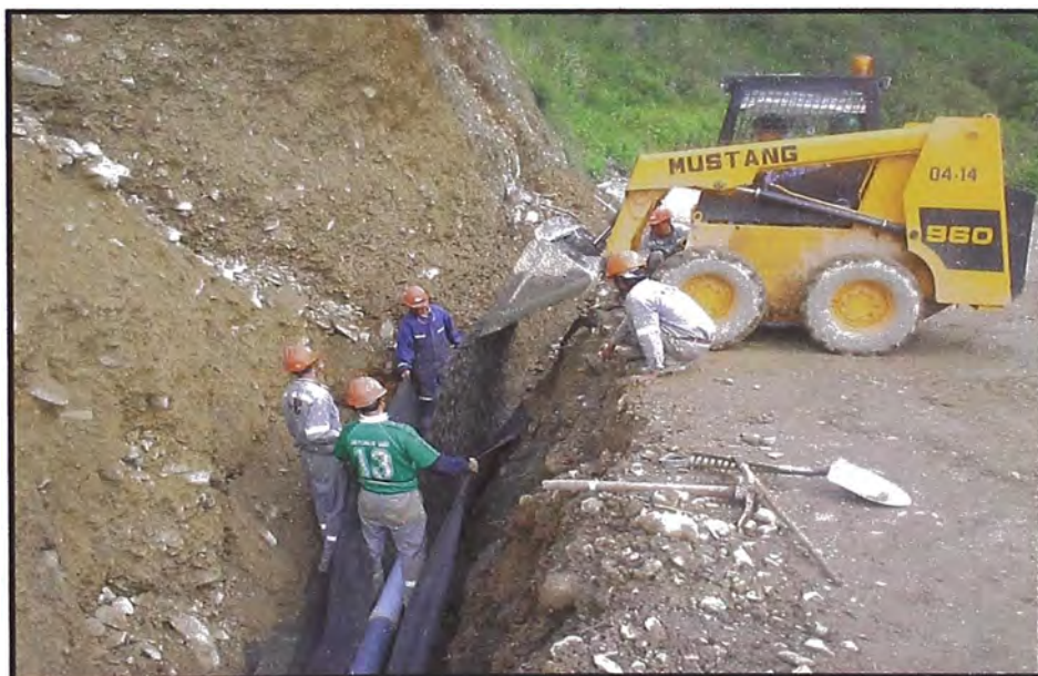
RELLENO DE GRAVA UTILIZANDO MINICARGADOR
