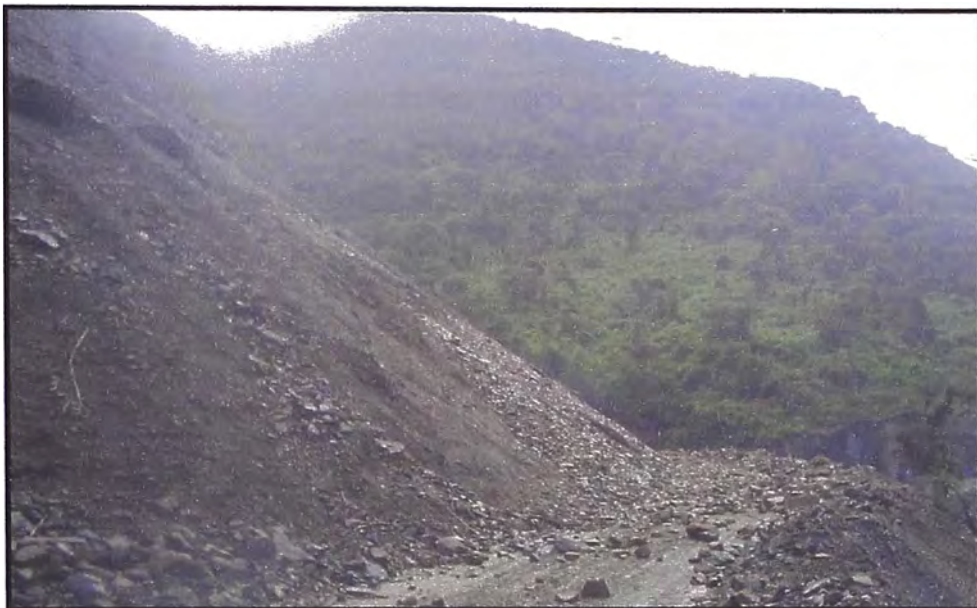
DERRUMBE EN Km. 73 + 450 (obstruye toda la vía)
