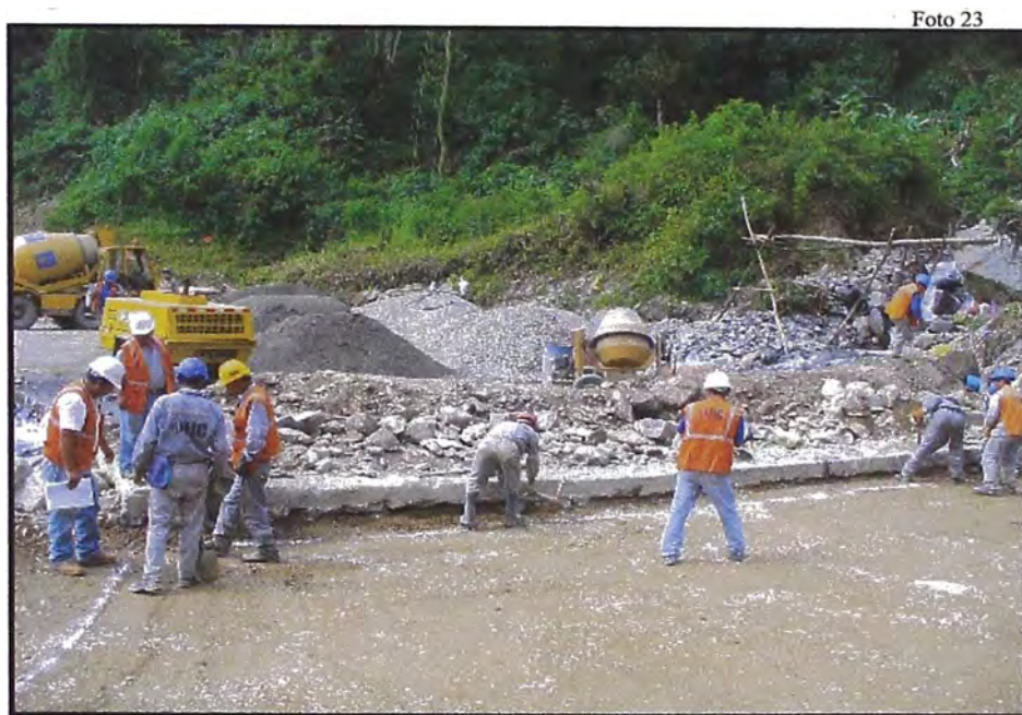
TRAZADO CON YESO DE LAS UÑAS DEL BADEN
