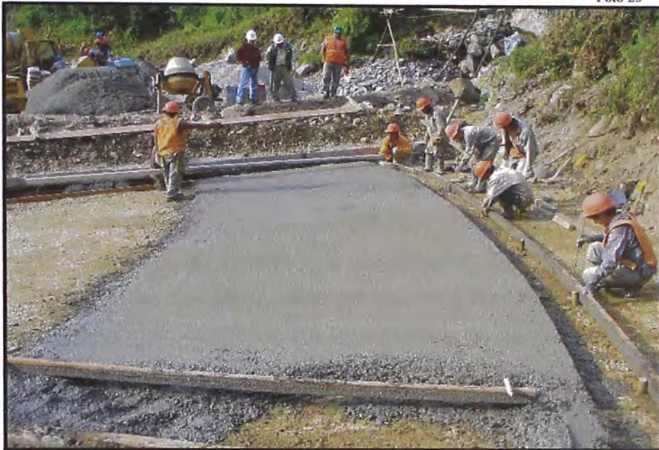
VACIADO DE SOLADO
