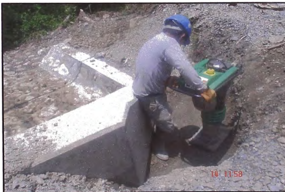
COMPACTACION CON VIBROPISONADOR
