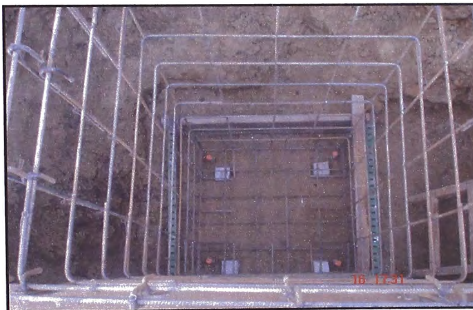
ENMALLADO DE CAJA DE REGISTRO
