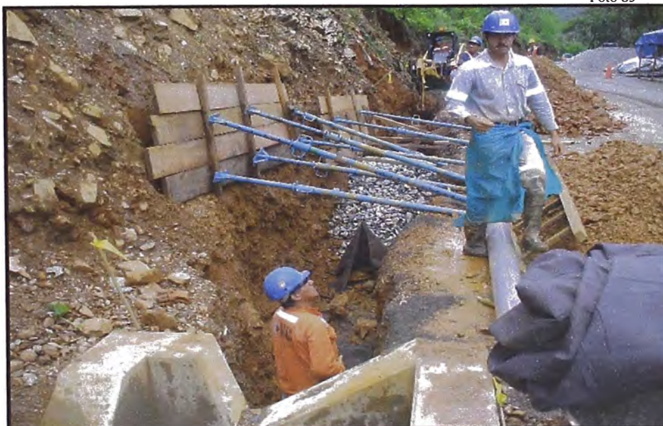
ENTIBADO EN OBRAS DE SUBDRENAJE
