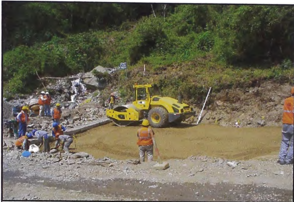
COMPACTACION DE BASE DEL BADEN CON RODILLO
