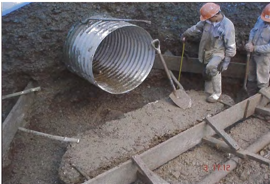
ENCOFRADO DE CIMENTACION DE CABEZAL TIPO ALA
