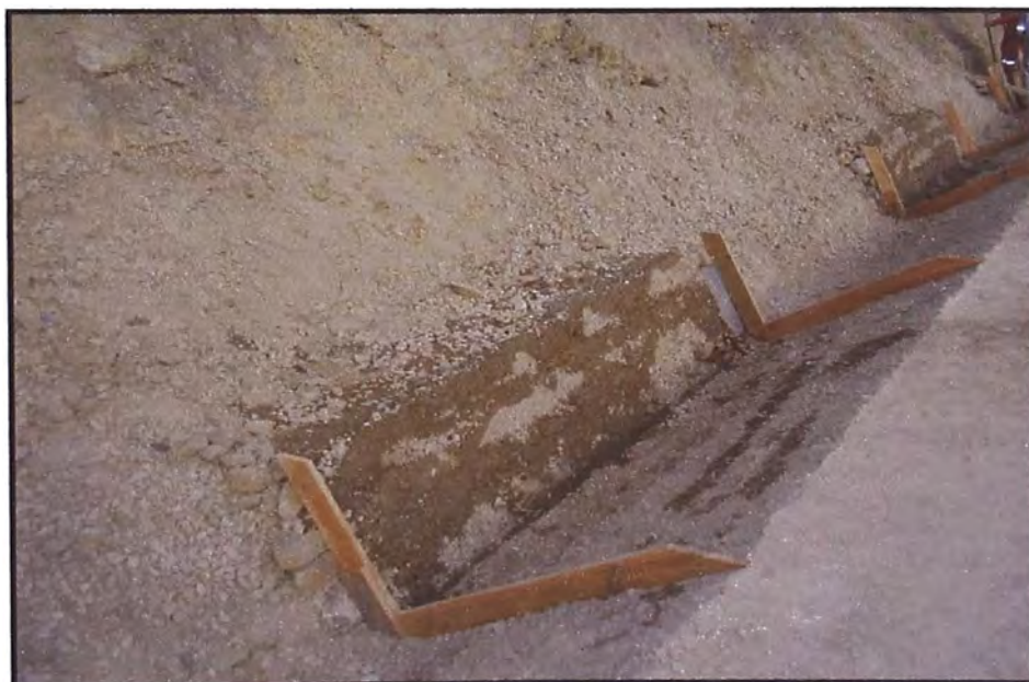
PAÑO REFINADO Y COMPACTADO
