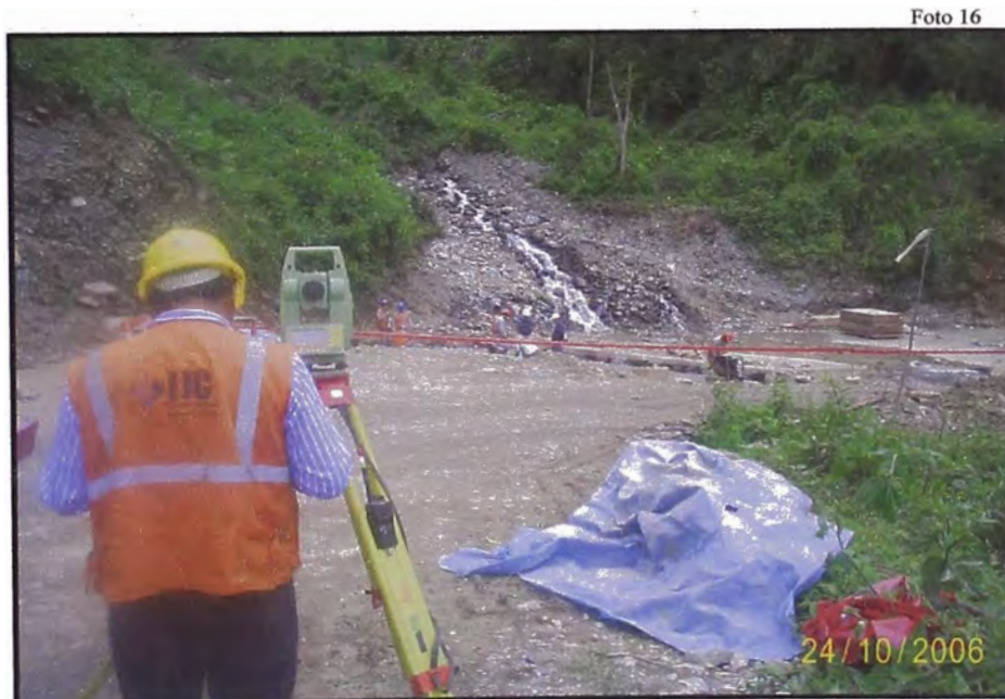
COLOCACION DE PUNTOS REFERENCIALES CON ESTACION TOTAL
