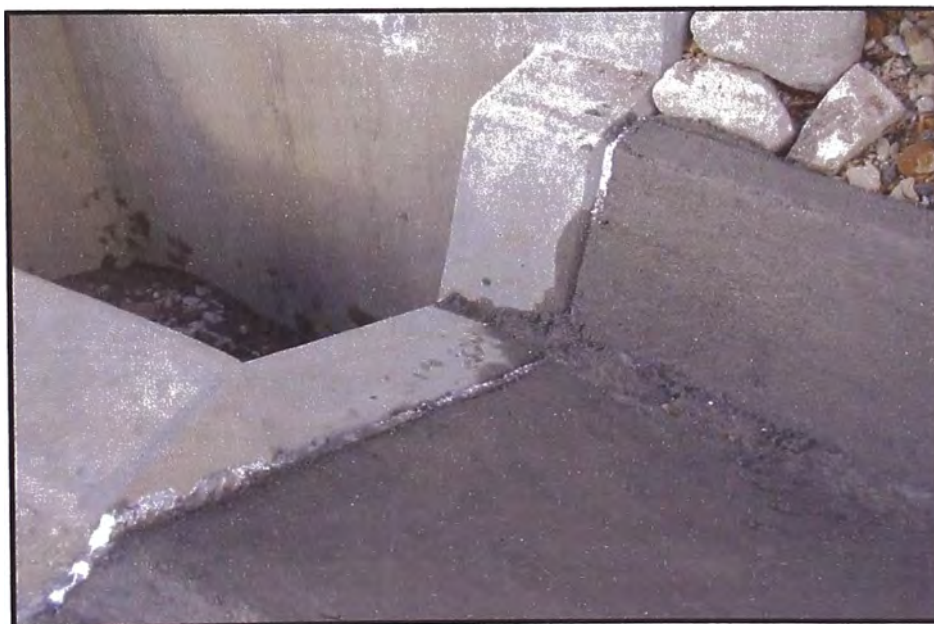
TECKNOPORT ENTRE CUNETAS Y CABEZAL TIPO CAJA
