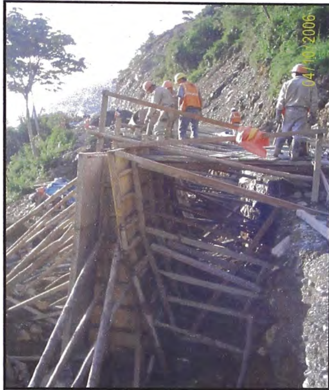
ENCOFRADO Y APUNTALADO DE MURO DE CONCRETO CICLOPEO
