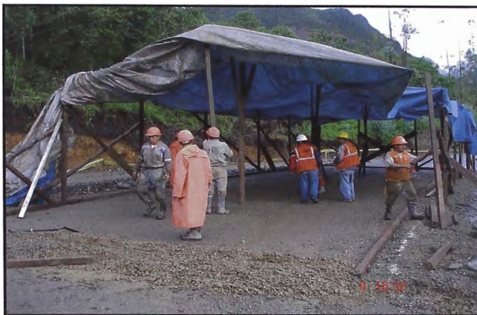
ARMADO DE CARPA PARA PROTEGER EL RELLENO
