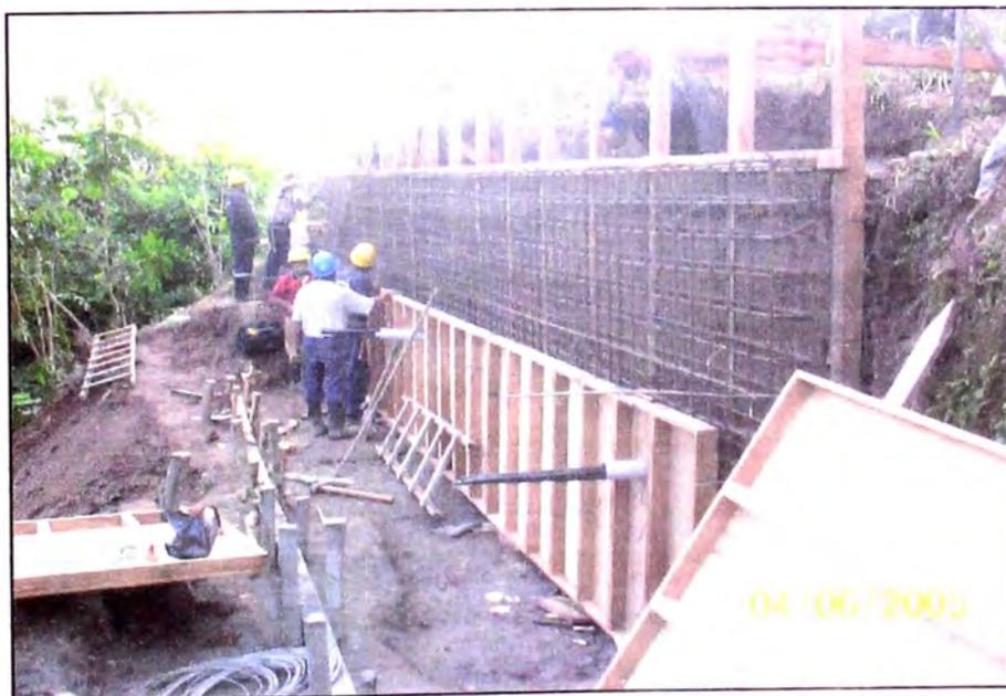
**Fotografía N° 54.-** Tramo de muro superior habilitado con acero en proceso de encofrado, observese las aberturas de encofrado para anclajes .
