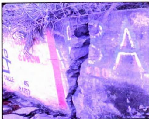
Fotografía Nº 7. - Estado Límite de un Muro de Contención
