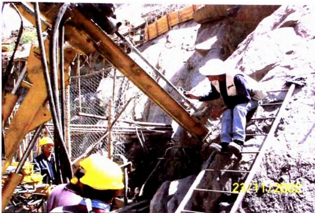
**Fotografía N° 10.-** Alineamiento y Verificación de la inclinación del ángulo vertical de perforación.
