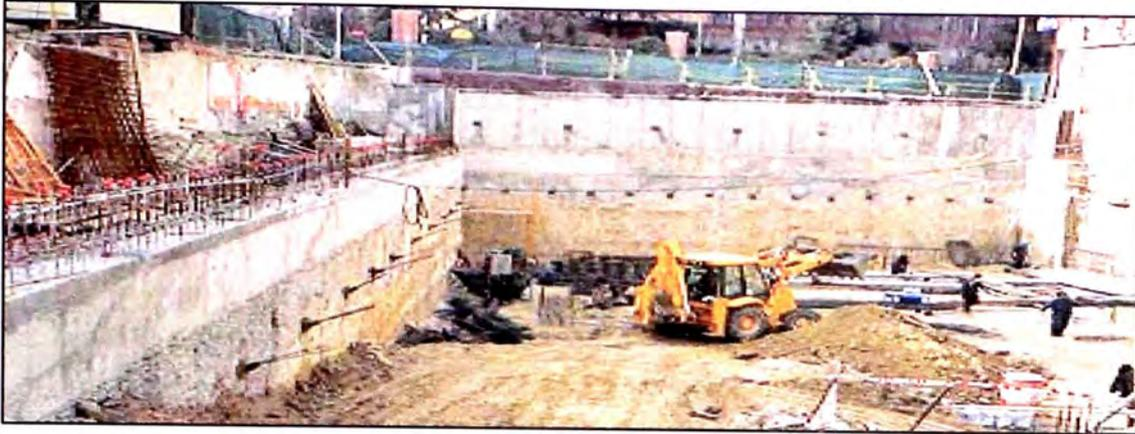
**Fotografía N° 5** .- Procedimientos de Construcción de Pantallas Ancladas en Sótanos de Edificio (Fuente: Anclajes Titan)
