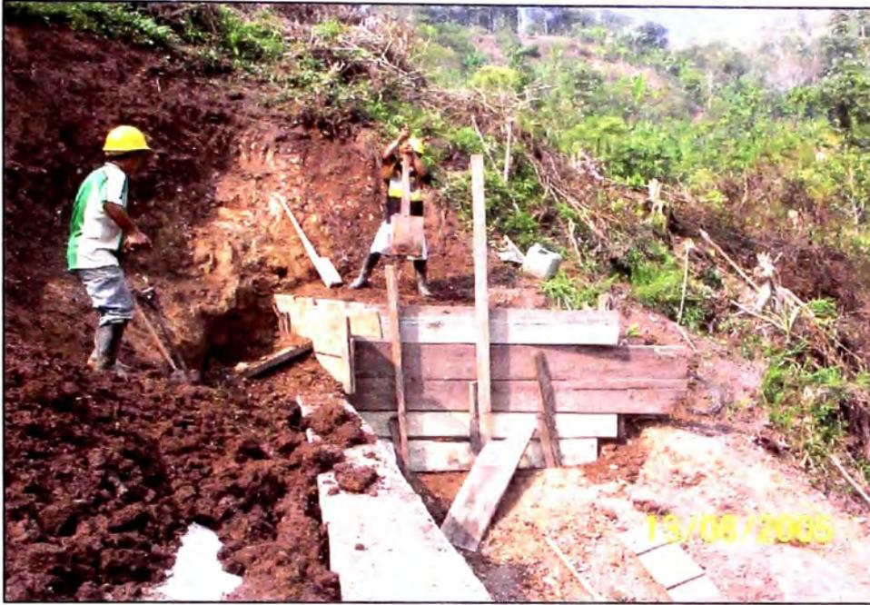
**Fotografía N° 58.-** Trabajos de reconfonnación de áreas eliminadas en parte lateral del muro, nótese la compactación del suelo apoyado por un entablado para luego iniciar la revegetacion.
