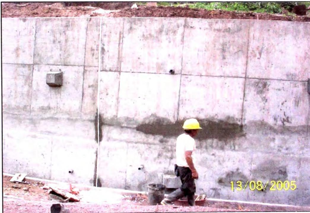
**Fotografía N° 49.-** Juntas de construcción entre tramo de muros.
