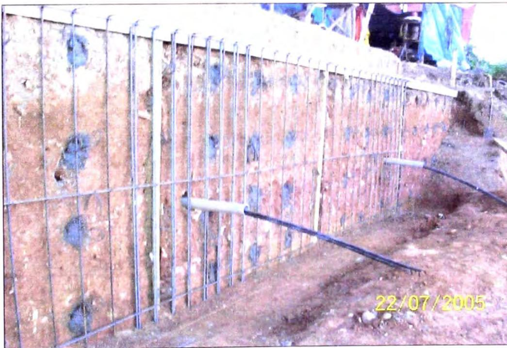
**Fotografía N° 32.-** Colocación de acero de refuerzo vertical en tramo de muro proyectado.
