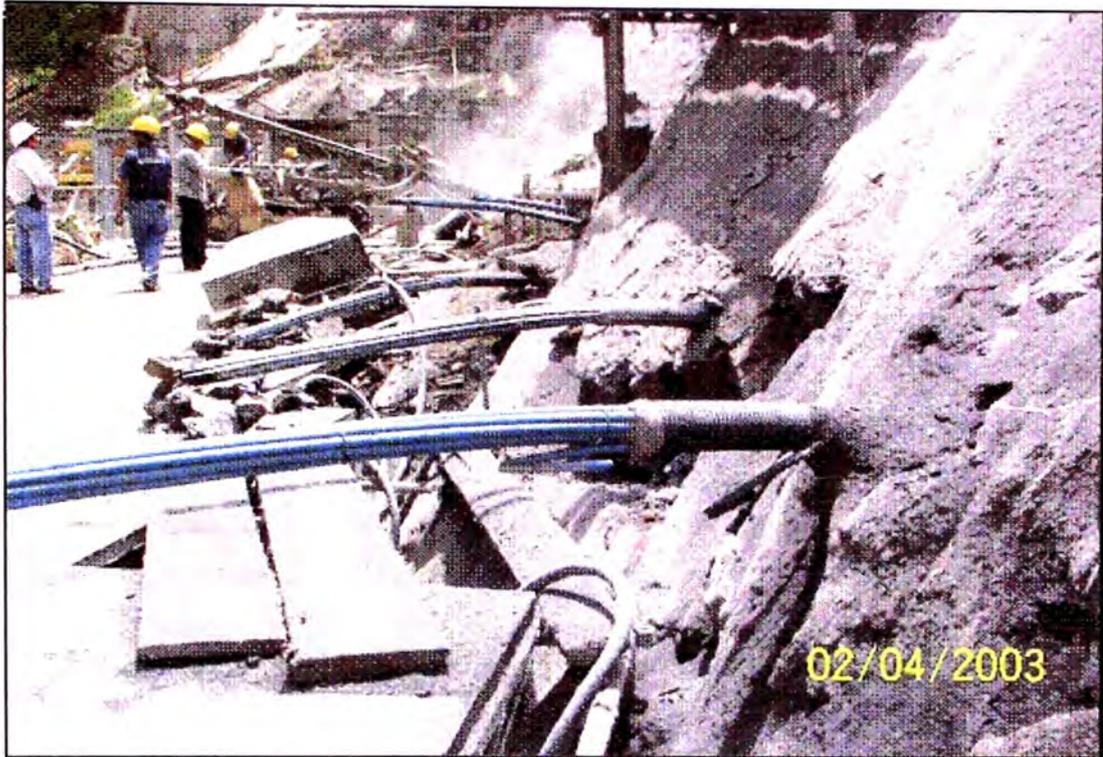
Fotografía N° 28.- Anclajes instalados e inyectados.
