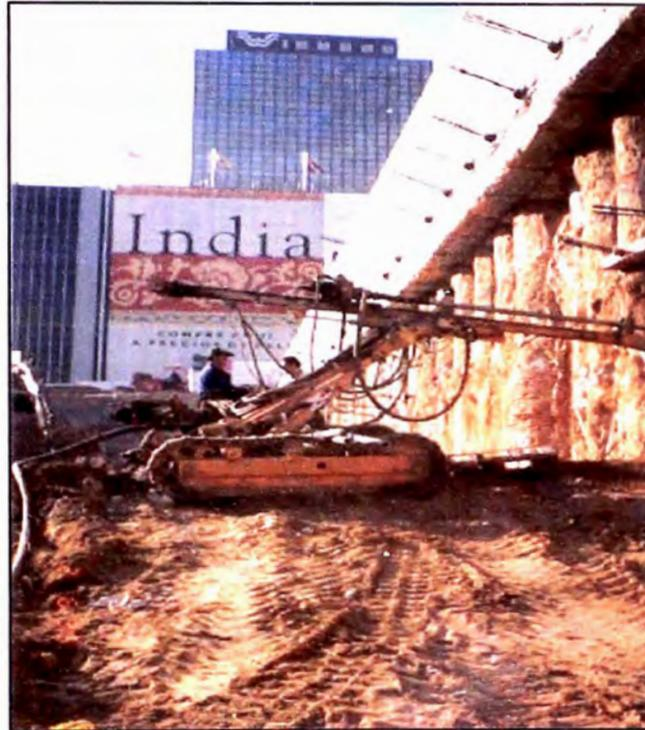
**Fotografía Nº 3** .- Procedimientos de Construcción de Pantallas Ancladas en Sótanos de Edificio (fuente: Anclajes Titan)
