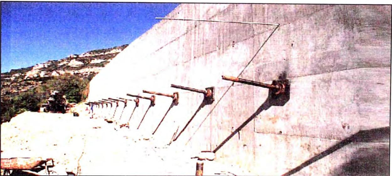
**Fotografía N° 6** - Anclajes en Muros de Carretera en Lleida - España
