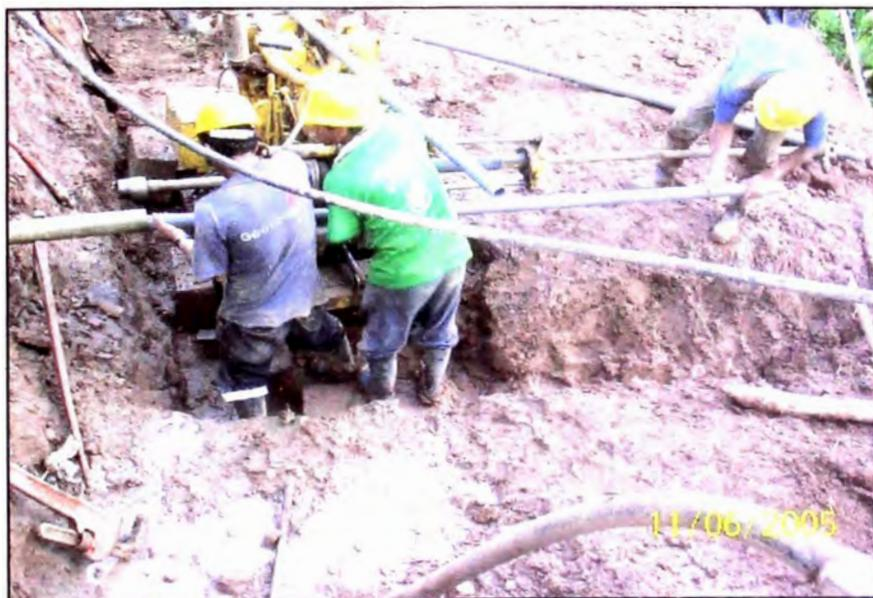
**Fotografía N° 55.-** Perforación con recubrimiento metálico e instalación de tuberías de drenaje de material de PVC.
