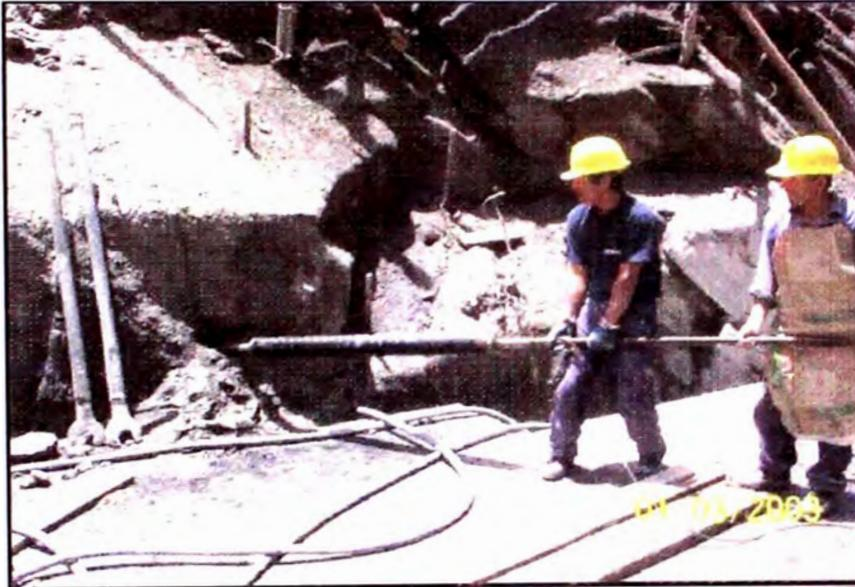
**Fotografía N° 19.-** Primero se introduce dentro del taladro el obturador para ensayar el tramo del bulbo; luego se toman lecturas del caudal perdido en el bulbo.
