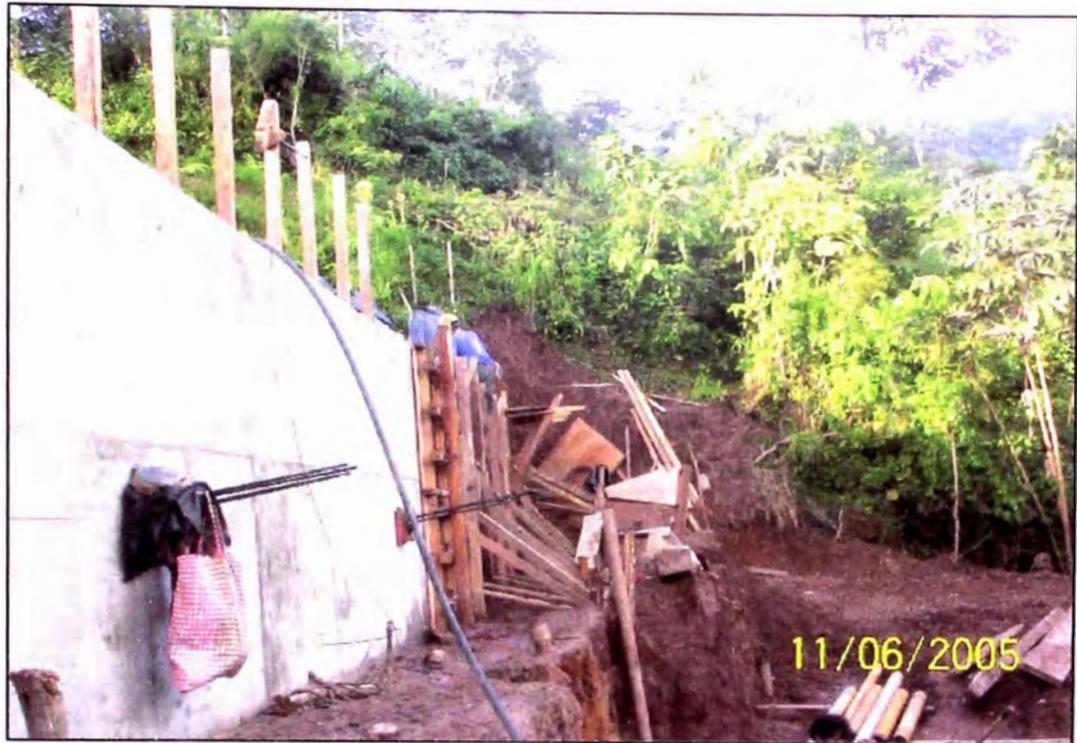
**Fotografía N° 33.-** Encofrado de muro apoyado en banquetas dispuesto desde excavación inicial.
