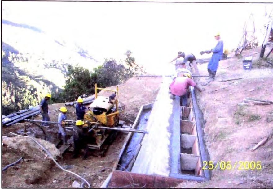
**Fotografía N° 56.-** Construcción de cuneta de coronación.
