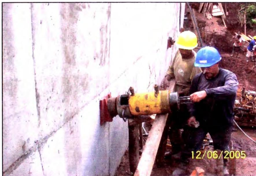
Fotografía N° 35.- Posicionamiento de la gata Hidráulica en anclaje con cabezal y placa de apoyo instalado para los ensayos de tensión, nótese la fijación de los clavetes parafinados en el cabezal para cada uno de los cables, asegurando de esta manera la prueba de tensión.
