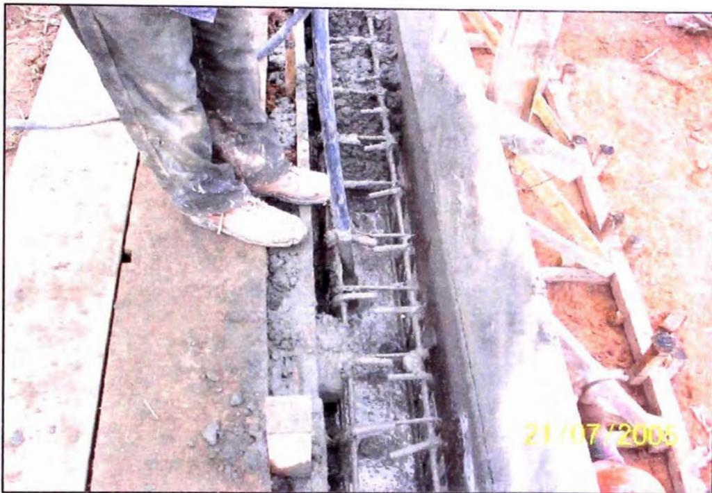
**Fotografía N° 48.-** Manguera de vibración
