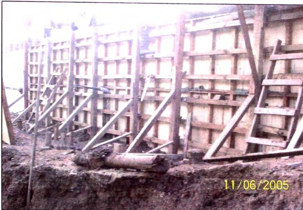
**Fotografía N° 51.-** Encofrado en servicio durante los trabajos de vaciado
