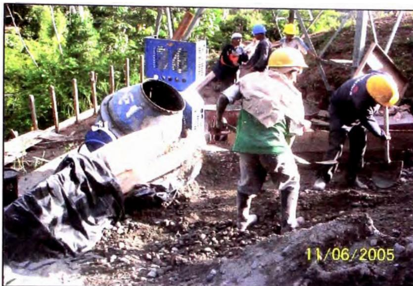
**Fotografía N° 45.-** Preparación de tanda en mezcladora con agregados.
