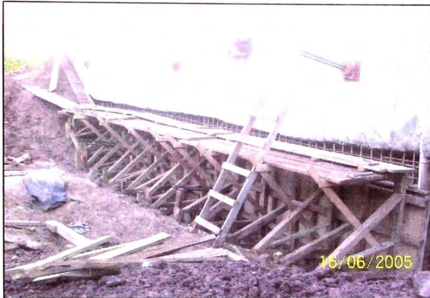
**Fotografía N° 46.-** Nótese la plataforma de recorrido de los boogies para vaciar tramo de muro inferior, tramo superior anclado ya vaciado.
