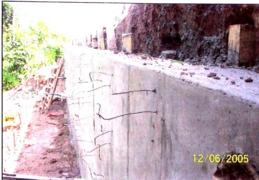
Fotografía N° 34.- Tramo de Muro desencofrado, nótese las mechas de alambres que quedaron del amarre con los paneles de encofrado en este lado de la pantalla ya anclada aun quedando pendiente los ensayos de tensión en este muro.
