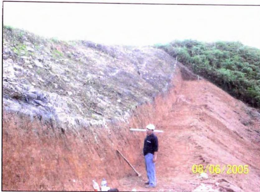
**Fotografía N° 40.-** Verificación de la ubicación de las perforaciones protegidas con tubos de pvc, nótese las referencias de cotas superiores del muro.
