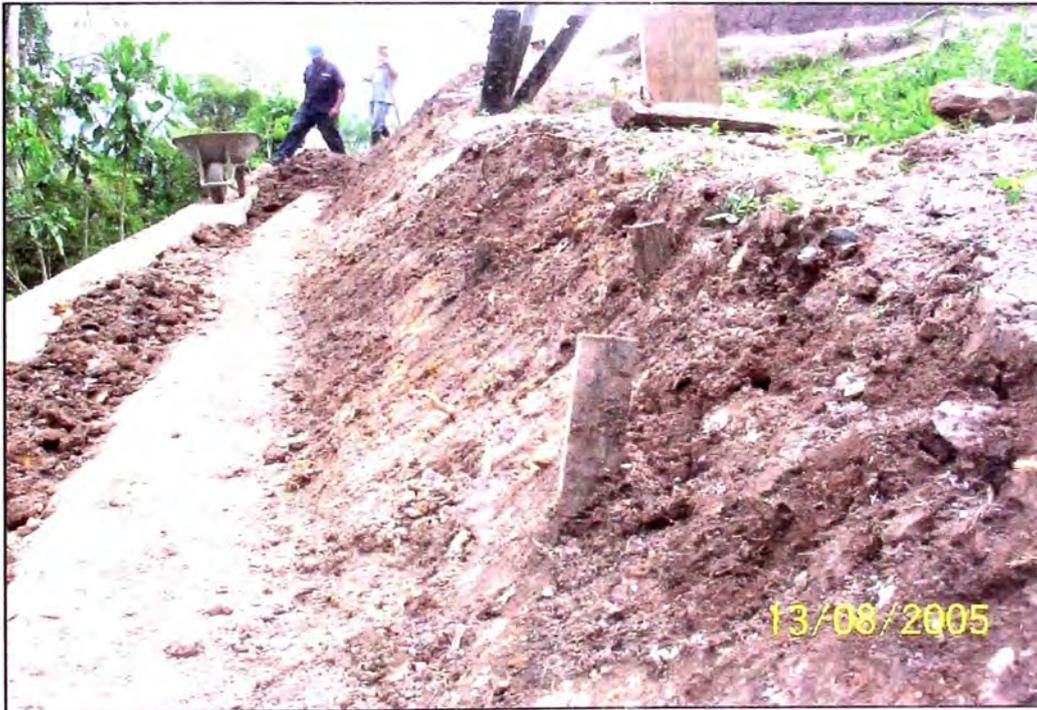
**Fotografía N° 59.-** Trabajos de reconfonnación a pie de torre, parte superior del muro ( zona cuneta de coronación ).
