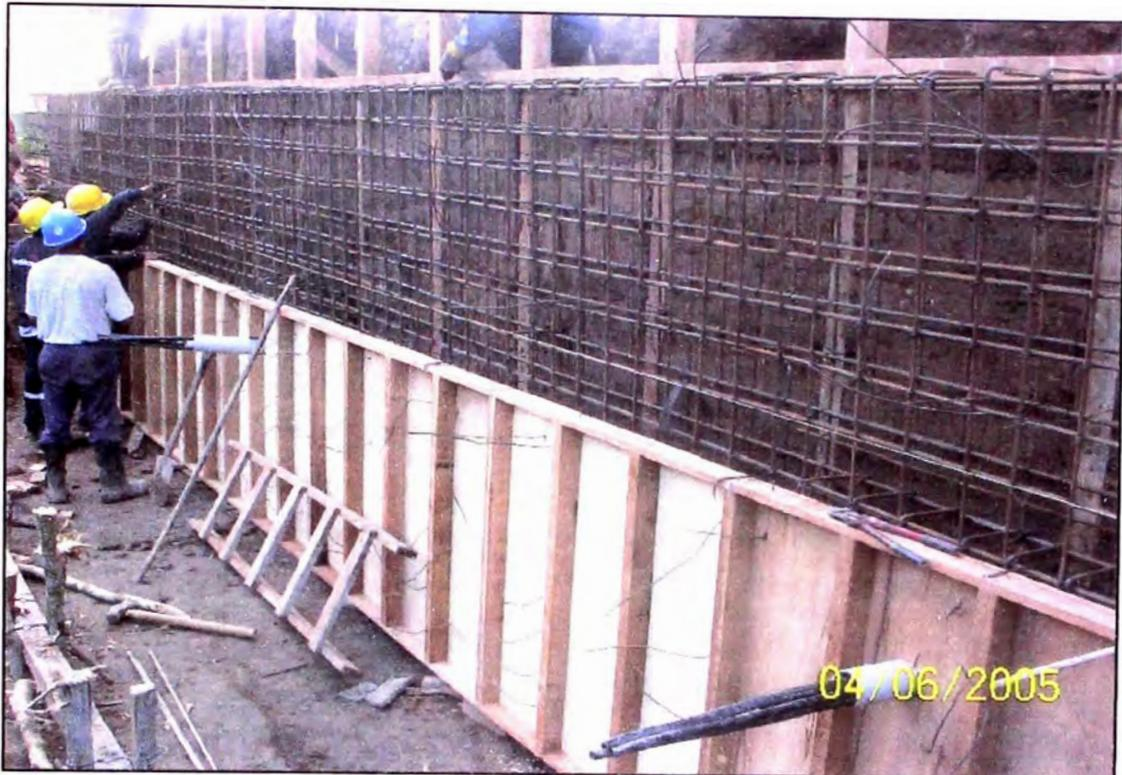
**Fotografía N° 52.-** Habilitacion de acero de refuerzo para tramo de muro.
