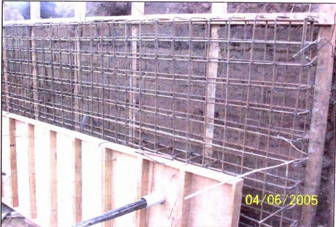
**Fotografía N° 53.-** Observar los estribos con acero de  $\frac{1}{2}$ " dejados alrededor del anclaje (parte superior de encofrado).
