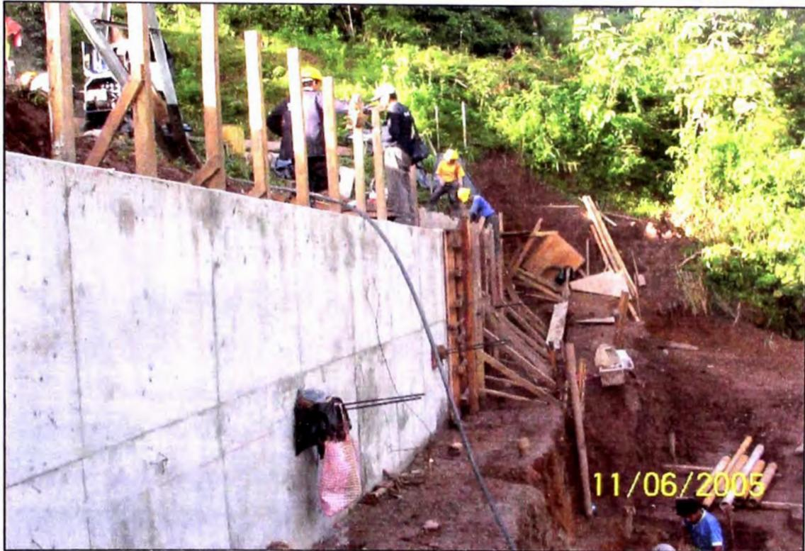
Fotografía N° 50.- Apuntalamiento apoyado en banquetas dejadas para trabajo de tramo de muro encofrado.
