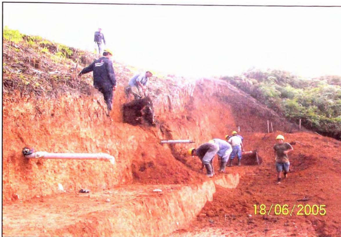
**Fotografía N° 31.-** Excavación y Perfilado en tramo de muro proyectado desde cota superior, nótense las banquetas dejadas de suelo a lo largo del tramo para plataforma de trabajo de perforadoras y encofrados.
