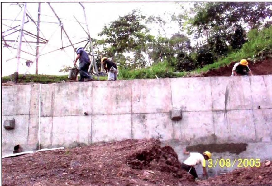
**Fotografía N° 57.-** Construcción de caja de pase en parte inferior de muro, obsérvese línea excavada saliente de pantalla.
