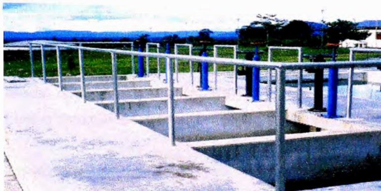
FIG. 2.7 BATERIA DE FILTROS DE TASA DECLINANTE
