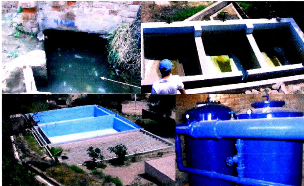
FIG. 1.1.- SITUACION ACTUAL DE PLANTA DE TRATAMIENTO: CAPTACION DESARENADORES, FLOCULADORES, DECANTADORES, FILTROS.
