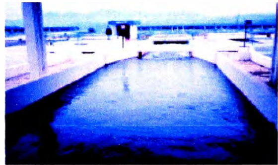
FIG. 2.2.- UND HIDRÁULICA TIPO CANALETA PARSHALL
