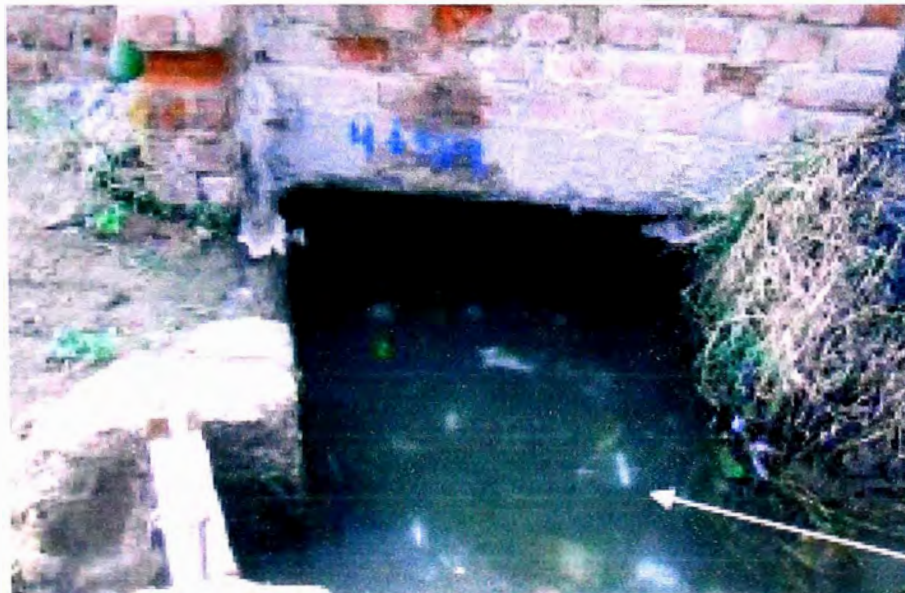
Foto N°2.- Canal de Irrigación – Captación de Aguas
