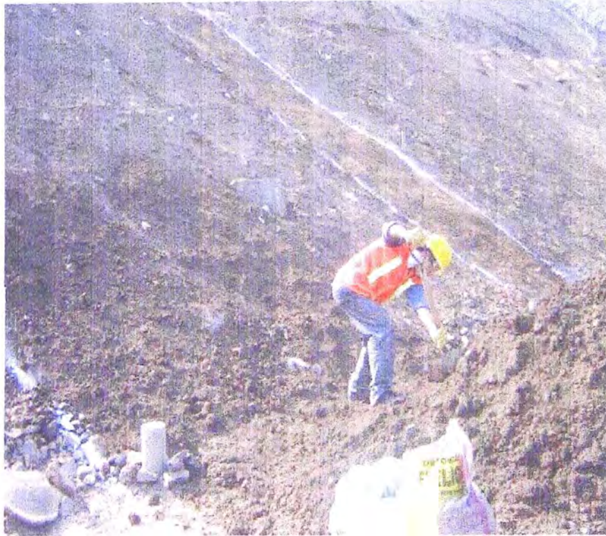
Foto 3: Colocación de tierra de chacra sobre el talud.
