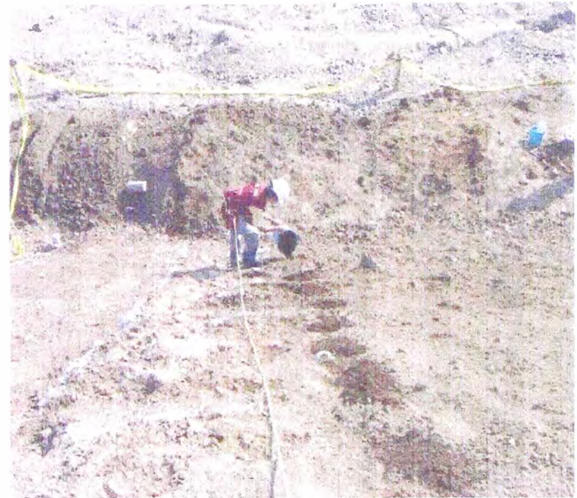
Foto 4: Colocación de Compost y semilla sobre la capa de tierra de chacra. Nótese las marcas de la cuadrícula de 1.0m x 1.0m a la izquierda, así como la línea de vida sujeta al trabajador.
