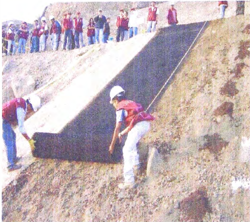
Foto 7: Colocación de Geomanta sobre talud desenrollándola hacia abajo. Nótese las líneas de vida empleadas.
