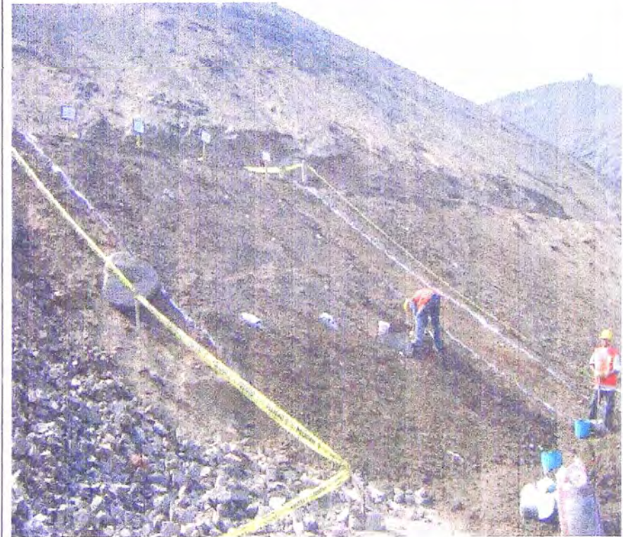
Foto 2: Vista general de parcelas donde se instalarán las mantas geosintéticas.
