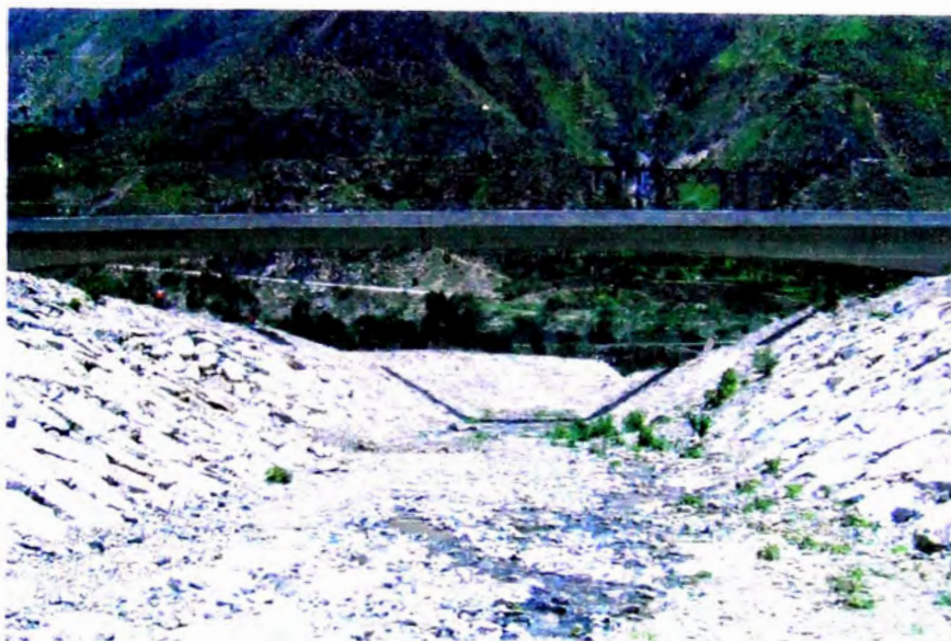
FOTO N° 4.-VISTA DESDE AGUAS ARRIBA HACIA AGUAS ABAJO DE LA SUBCUENCA COLLANA , ADEMAS SE APRECIA EL PUENTE CURVO COLLANA Y LAS ESTRUCTURAS DE DEFENSA RIBEREÑA
