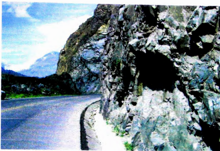
FOTO N° 1.-SE APRECIA EL PAVIMENTO FLEXIBLE Y LAS CUNETAS DE TIPO TRIANGULAR
