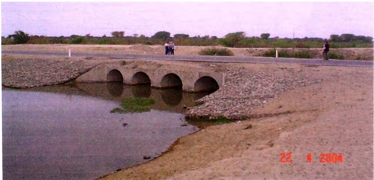
Quebrada Ignacio Escudero (Talud de Rocas)
