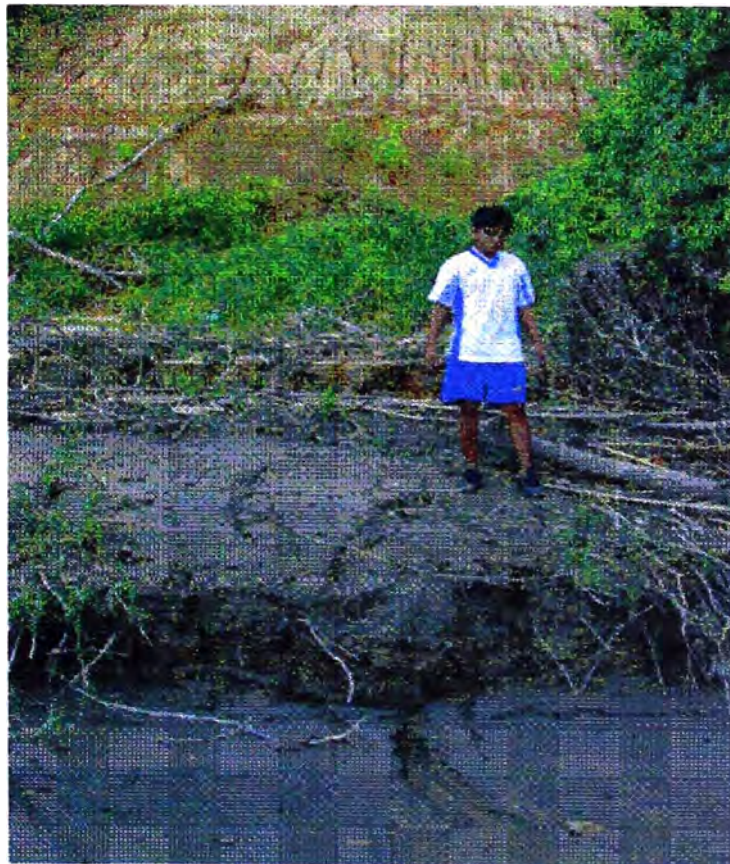
Figura 1-2: Detalle del contraste entre el material del escarpe de la terraza alta de la margen derecha (tonalidad rojiza) y los sedimentos aluviales recientes en la parte inferior (color gris), fotografía tomada en la orilla derecha y ligeramente aguas abajo del eje del puente.
