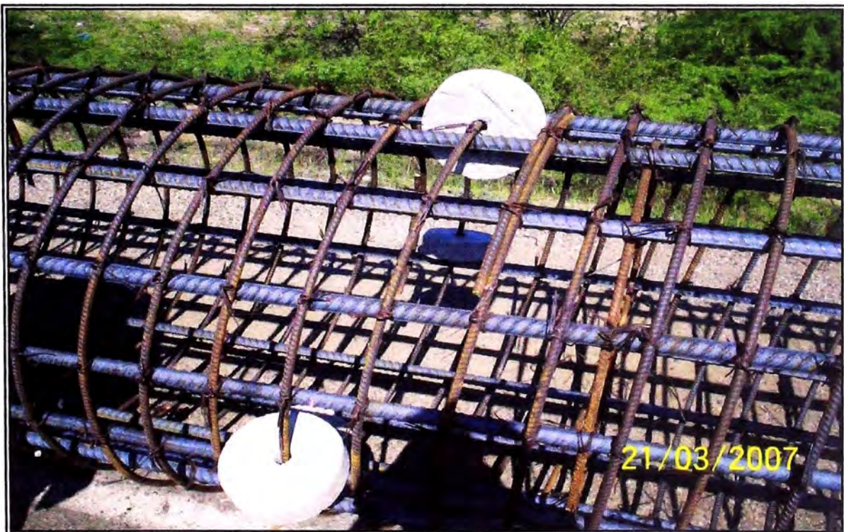
Fig. IV-14: Dados Separadores colocados en la Armadura.
