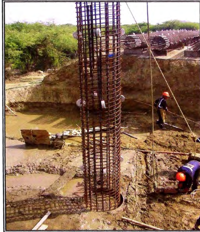
Fig. IV-11: Colocación de la Armadura.
