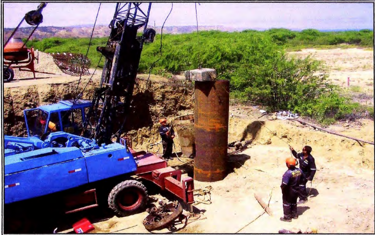
Fig. IV-5: Colocación de la Funda.
