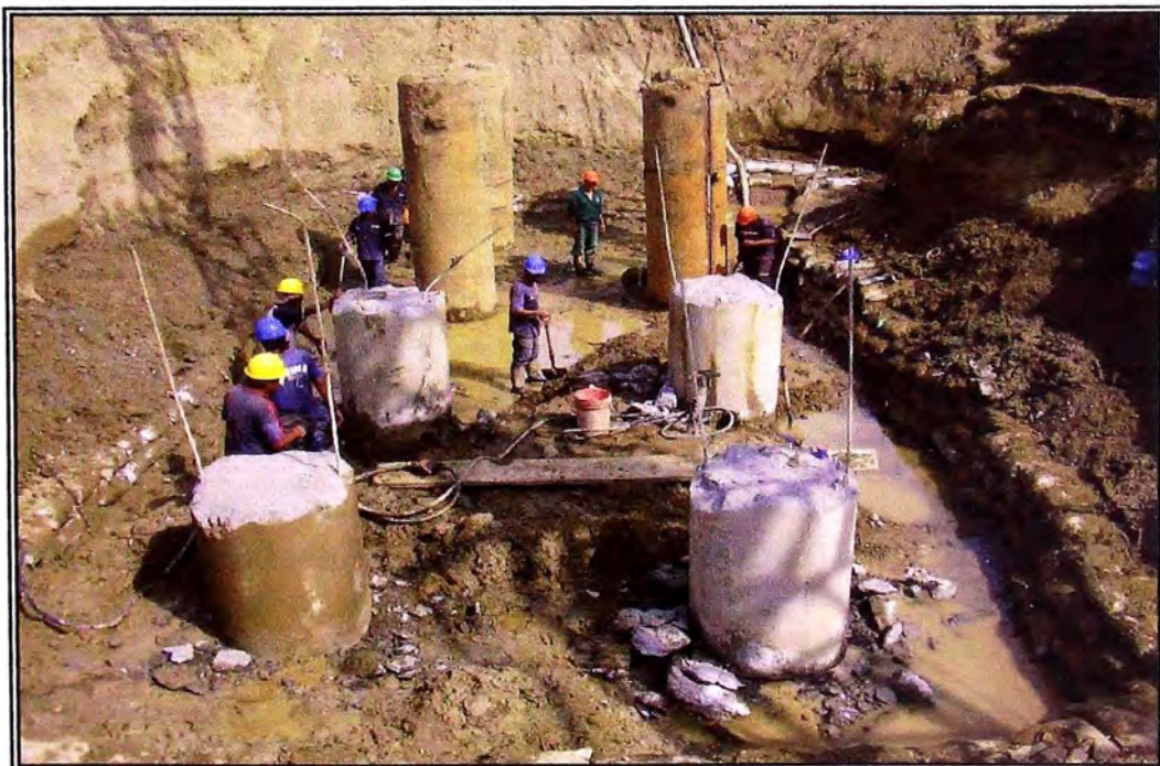
Fig. IV-18: Descabezado de Pilotes.
