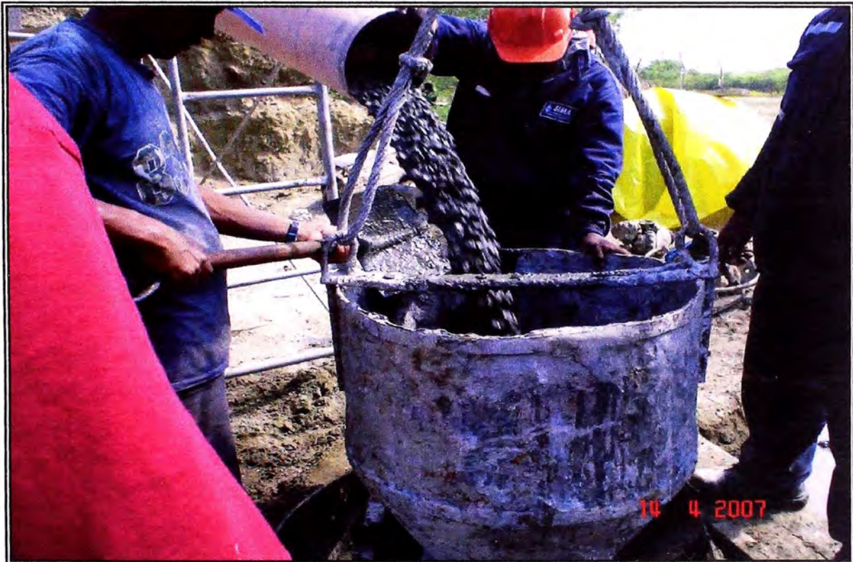
Fig. IV-16: Colocación del Concreto.
