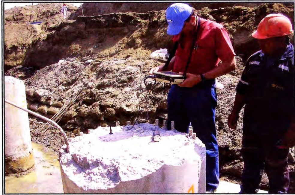
Fig. IV-17: Prueba de Integridad de los Pilotes.
