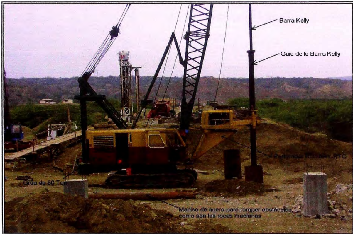
Fig. IV-4: Equipo de perforación de los Pilotes.
