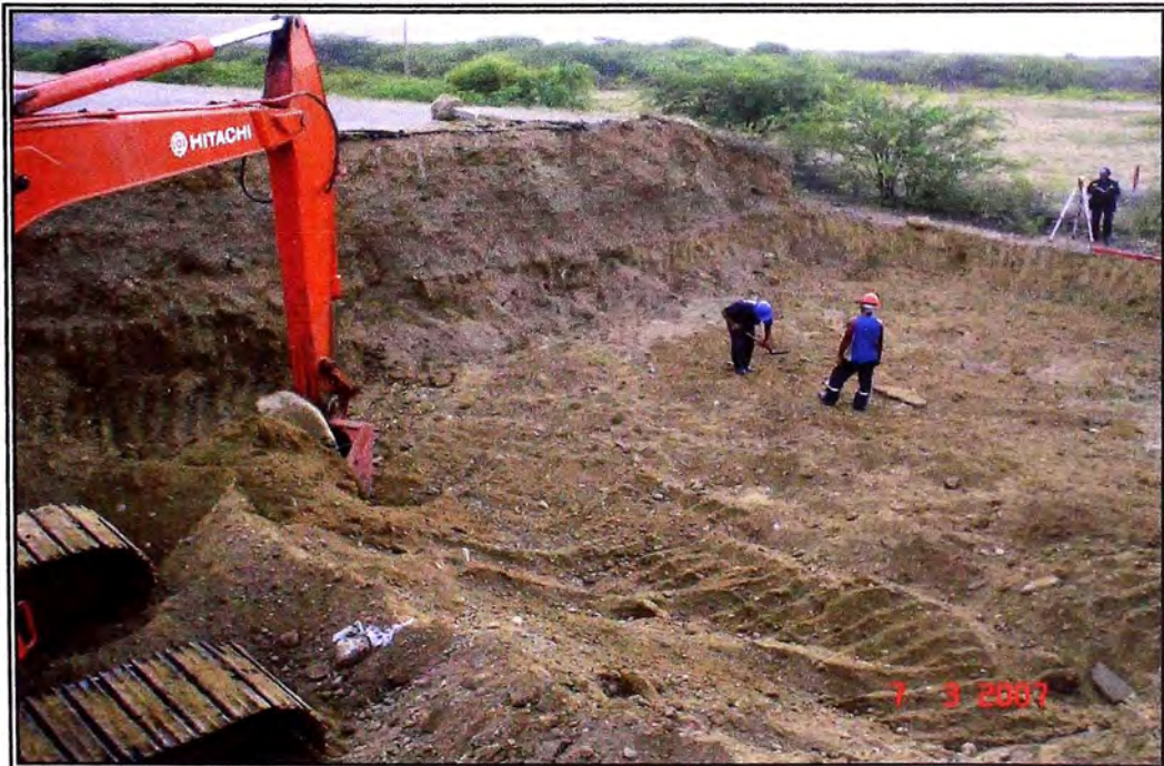
Fig. IV-2: Preparación de la plataforma de trabajo.
