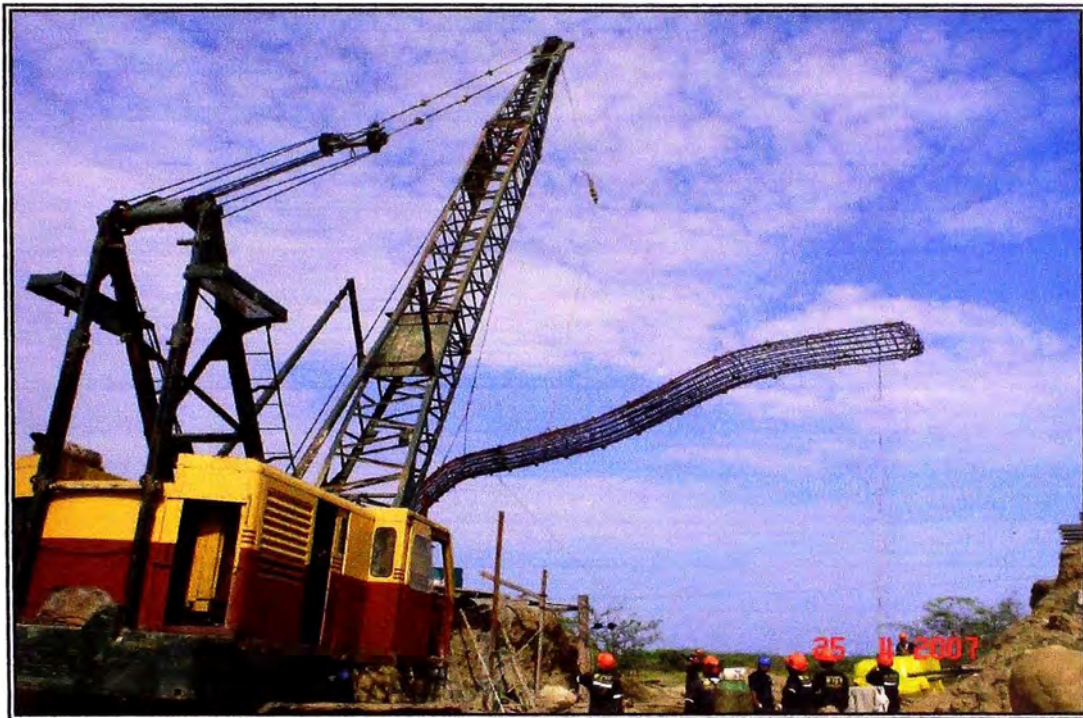
Fig. IV-10: Traslado e Izaje de la Armadura.
