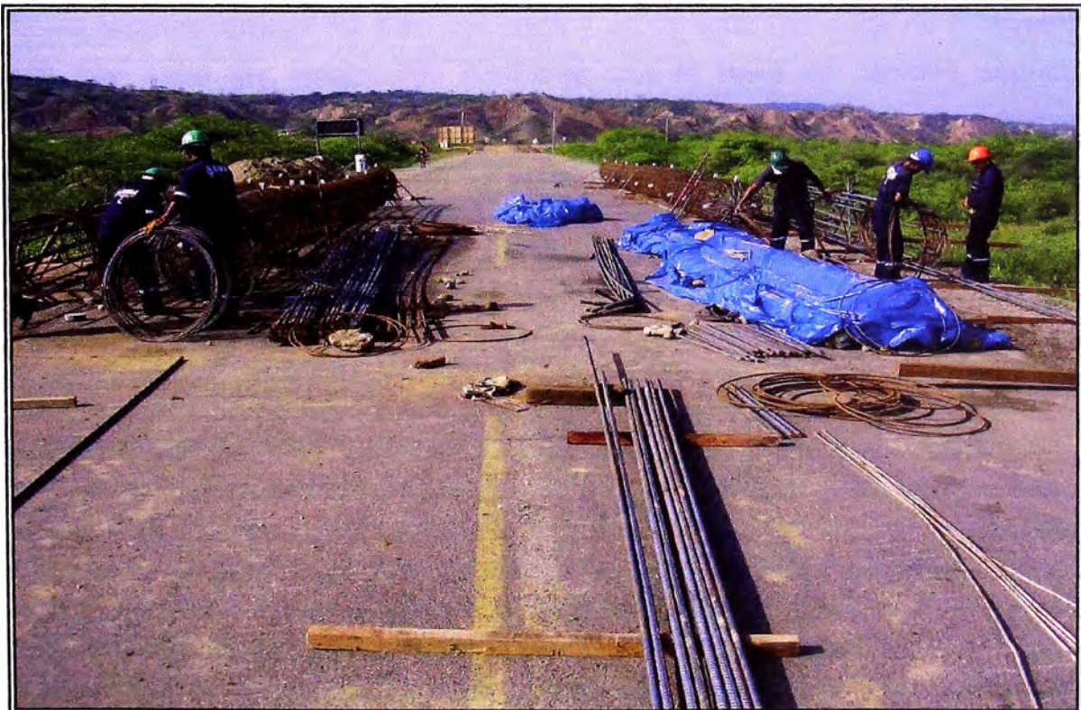
Fig. IV-9: Habilitación de la Armadura.
