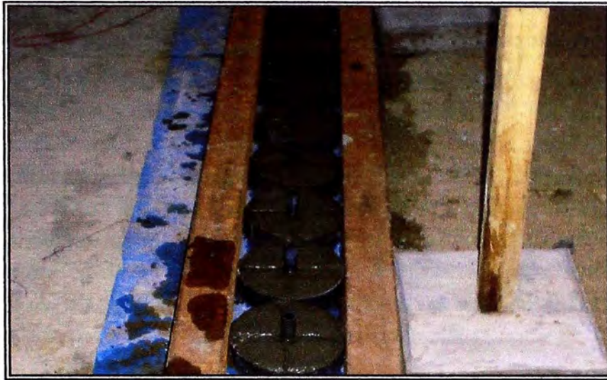
Fig. IV-13: Dados Separadores hechos en Obra.
