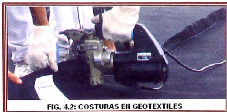
patrón de costura se determina con ensayos en campo y debe cumplir el 75% de la resistencia evaluada por el método de la tira ancha. El ensayo para costuras es ASTM D-4884.
