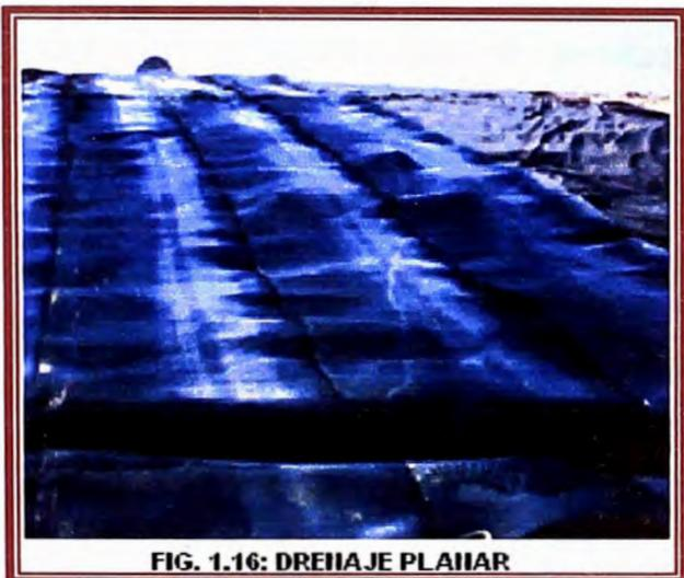
Los geotextiles que tienen un espesor considerable (mayor que 1.5 mm) como es el caso de los no tejidos unidos mecánicamente o punzonados por agujas, tienen la propiedad de conducir el agua en su plano, proporcionando un drenaje planar. Esta propiedad de los geotextiles se conoce con el nombre de transmisividad.
