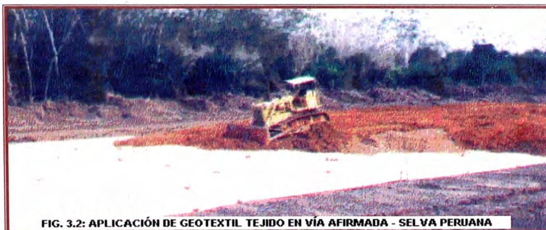
En la Sierra Peruana, existen vías de suelos arcillosos las cuales cumplen una muy buena función a la aplicación de cargas vehiculares, cuando estos materiales se encuentran secos o con bajo contenido de humedad, pero una vez que se saturan por efecto de las lluvias, se vuelven superficies de baja capacidad de soporte; también aquí es recomendable el empleo de geotextiles.
