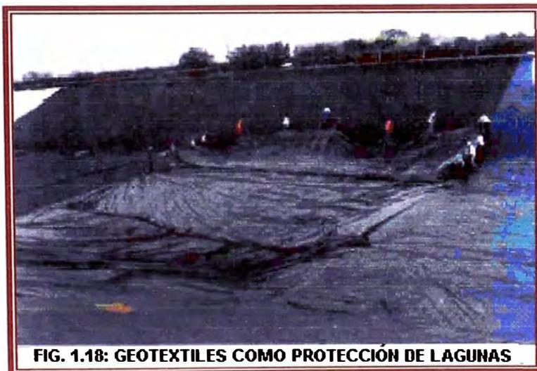
**FIG. 1.18: GEOTEXTILES COMO PROTECCIÓN DE LAGUNAS**
