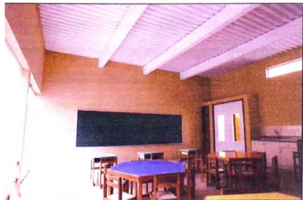
FOTO 3.20 y 3.21: Acabado de la losa colaborante con falso cielo raso y con pintura.
