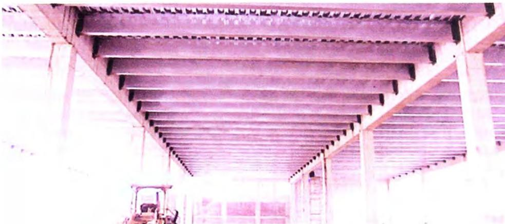
FOTO 3.1: Sistema no convencional, detalle de la losa colaborante por la parte inferior.
