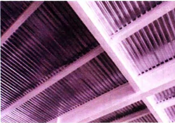
FOTO 3.6: Acabado con pintura Anticorrosiva
