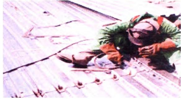
FOTO 3.10 y 3.11: Procedimiento para la colocacion de los conectores de corte
