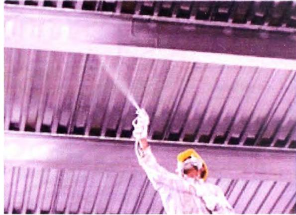
FOTO 3.7: Forma de aplicar la pintura anticorrosiva.
