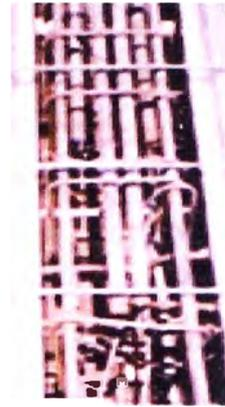
FOTO 3.16 y 3.17: Vistas de la colocación de la malla de temperatura sobre la losa colaborante.
