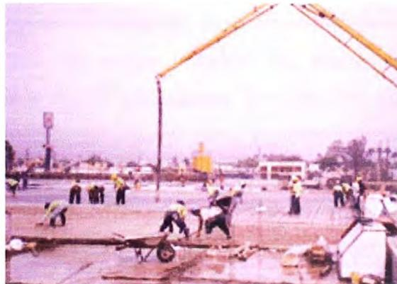
FOTO 3.18 y 3.19: Procedimiento del vaciado de concreto sobre losa colaborante.
