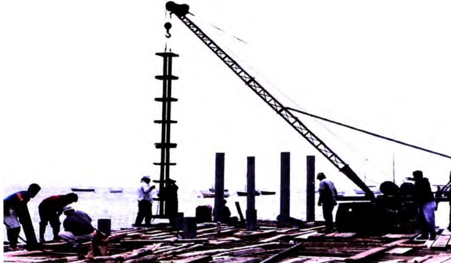
FOTO N° 07: Vista del traslado de la guía hinca pilotes a través del falso puente.
