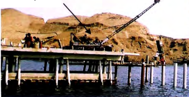
FOTO N° 03: Vista de un hincapilotes.
