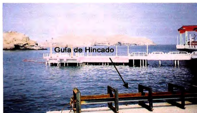
FOTO N° 05: Vista de una guía de hincado.
