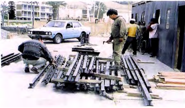
FOTO N° 01: Vista de pilotes de riel.
