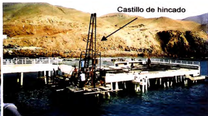
FOTO N° 04: Vista de un castillo de hincado.
