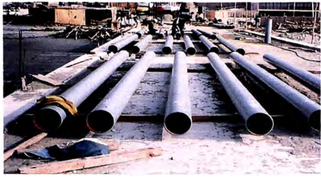
FOTO N° 02: Vista de pilotes de acero.
