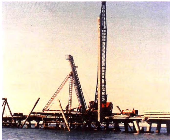
FOTO N° 10: Vista de una Grúa y guía de hincado.
