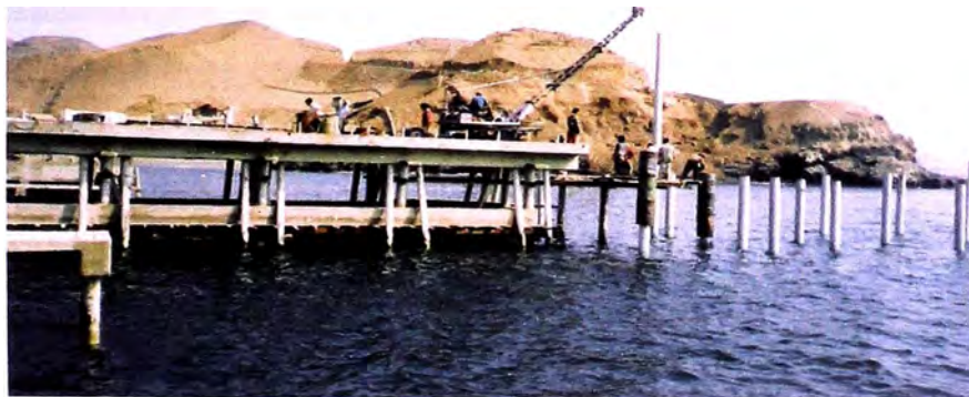
FOTO N° 08: Izado de las fundas de tubo PVC.
