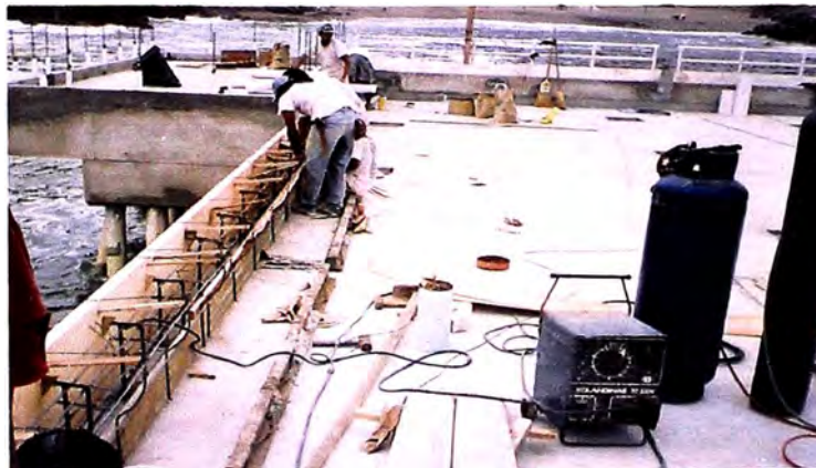
FOTO N° 06: Vista de un equipo de soldadura.
