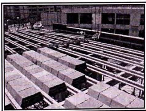
**Figura N°3.2** Detalle isométrico del apoyo de las viguetas sobre los muros armados (bloques King Block).
