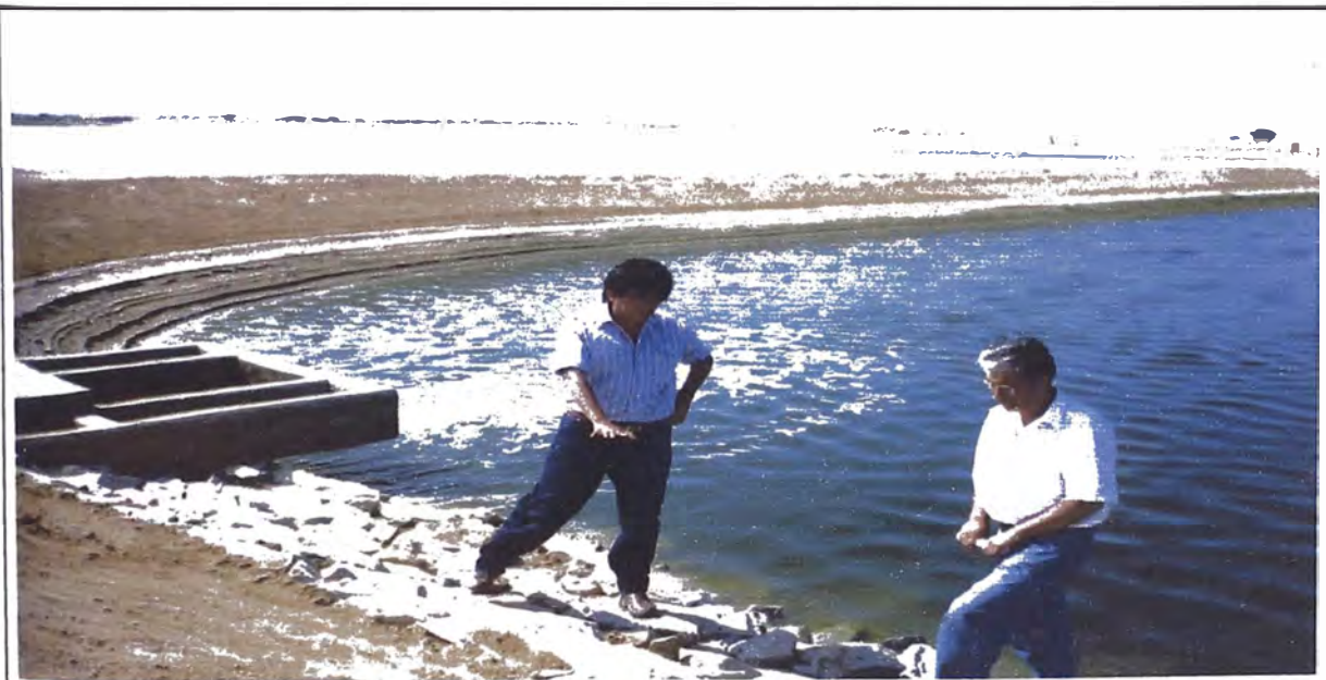
FOTO N° 8 Vista de la laguna Pampa de perros. Se aprecia la erosión y el Enrocado
