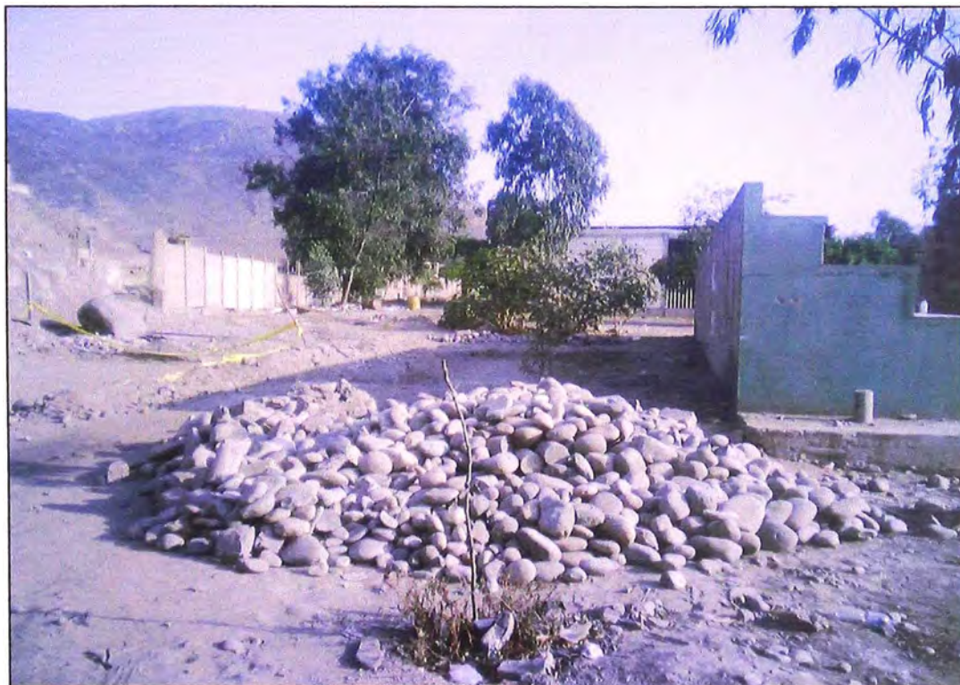
Foto 6 – Piedras para el relleno de las cajas de gavión.
