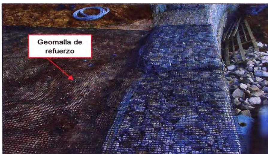
Figura 3.13 - Colocación de geomalla como refuerzo adicional
