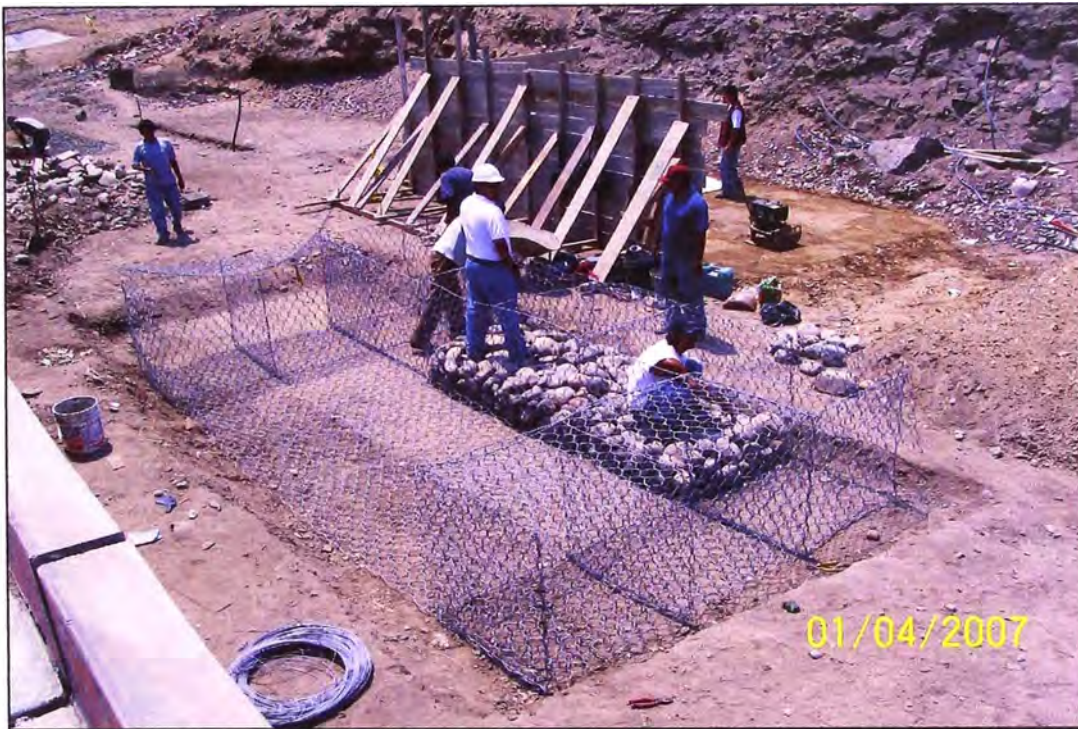
Foto 15 –Colocación de piedras en las cajas de gavión
