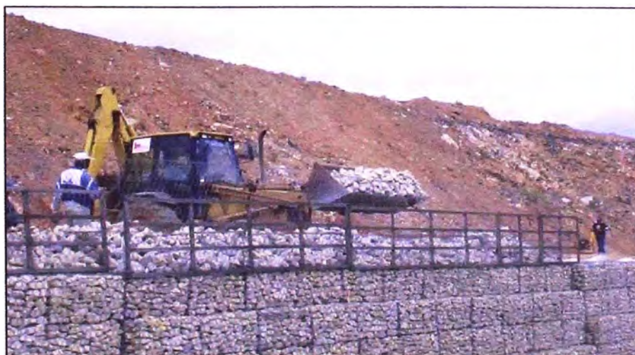
Figura 3.11 - Encofrado de apoyo y maquinaria
