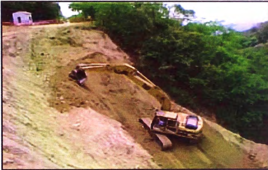
Figura 3.4 – Corte de talud - Condominio Alphaville Burle Marx – Brasil
