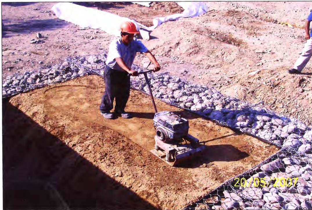
Foto 25 – Ultimo nivel de compactación.
