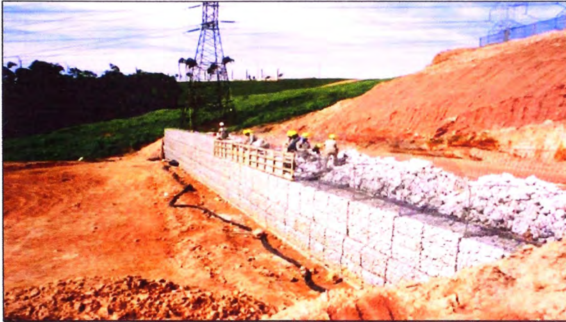
Figura 3.18 - Conformación del muro Condominio Alphaville Burle Marx – Brasil Fuente: Ref. Bibl. N° 12
