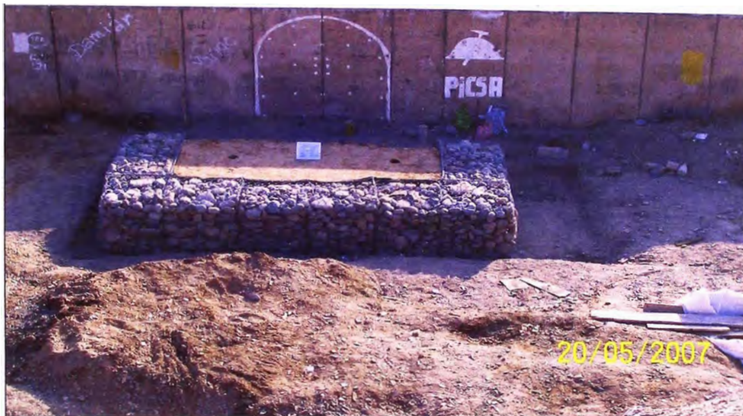
Foto 29 – Modelo experimental de muro terramesh finalizado.
