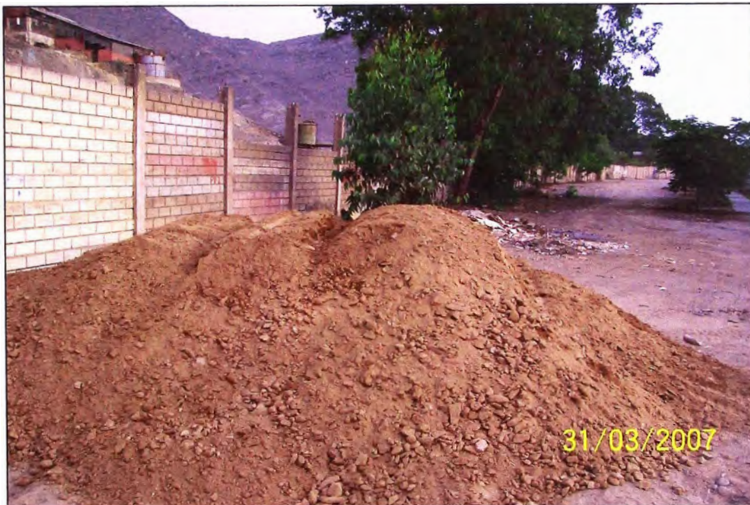
Foto 9 – Material de afirmado para el relleno estructural
