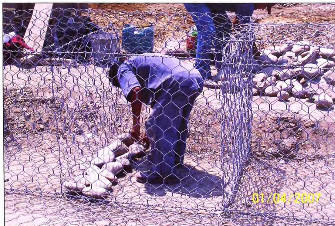
Foto 14 –Colocación de piedras en las cajas de gavión
