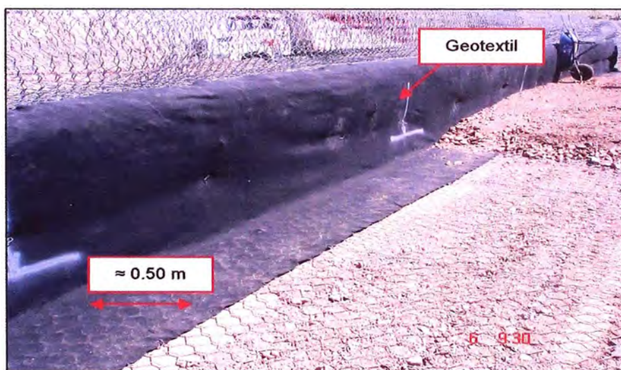
Figura 3.12 - Colocación del geotextil de separación
