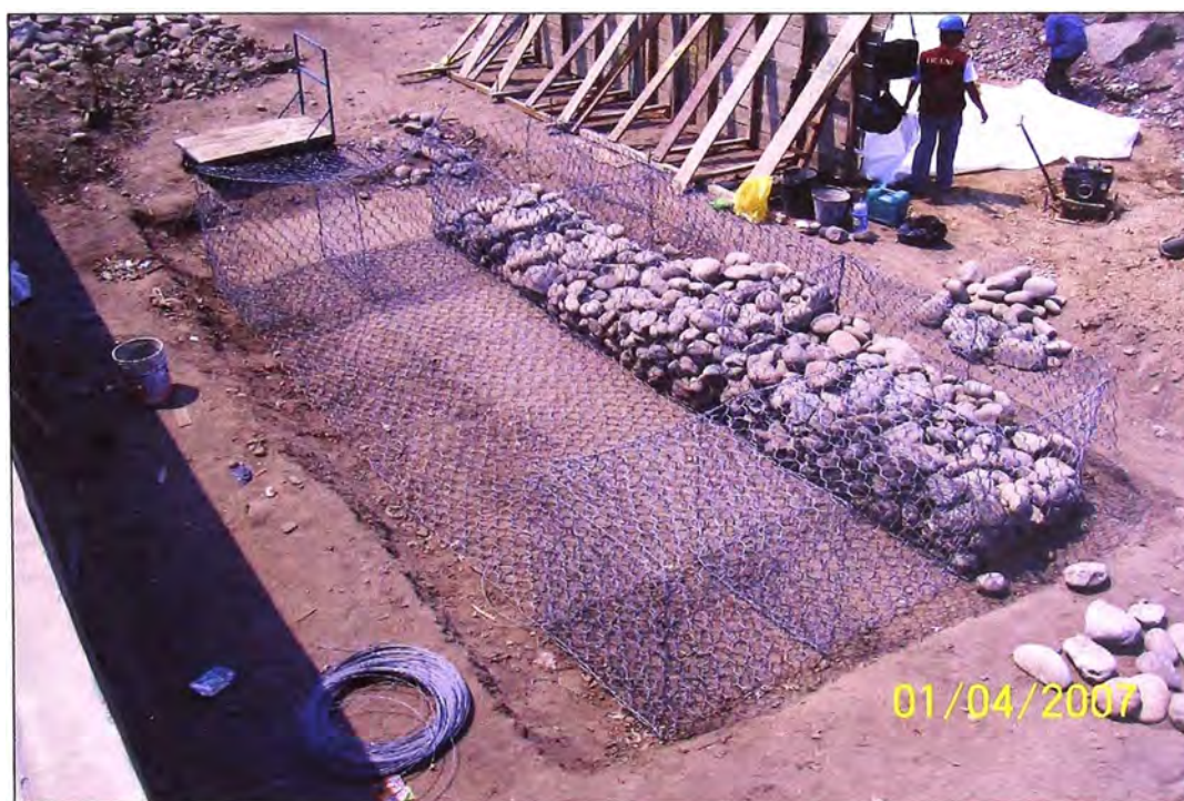
Foto 18 –Llenado de cajas de gavión.
