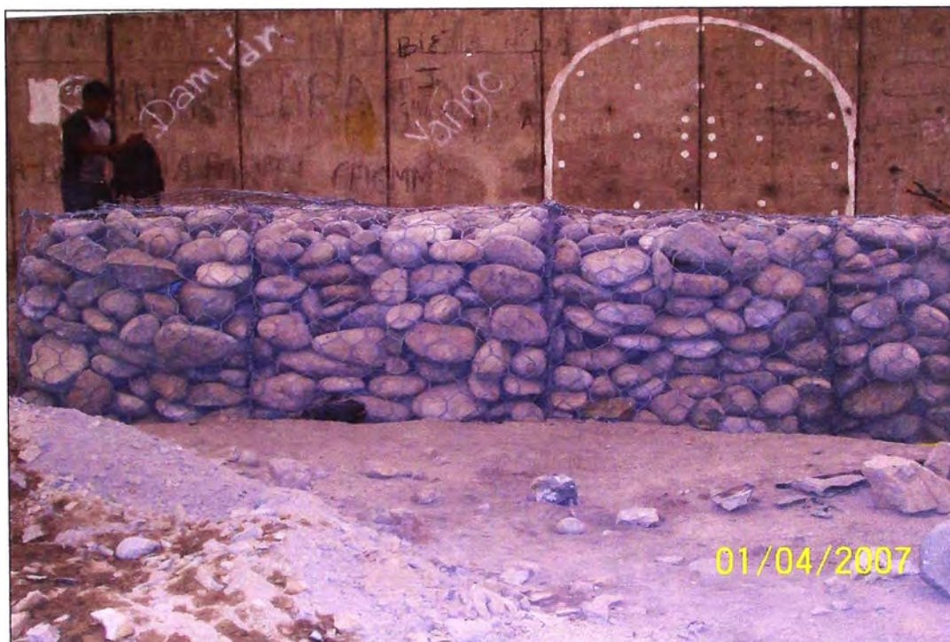
Foto 19 –Cajas de gavión llenas.
