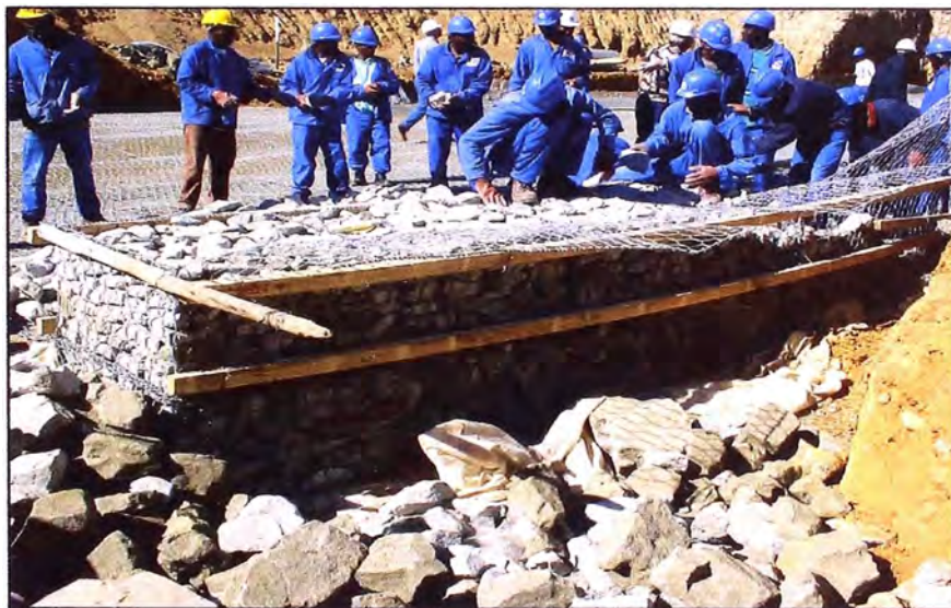
Figura 3.10 - Encofrado de apoyo
