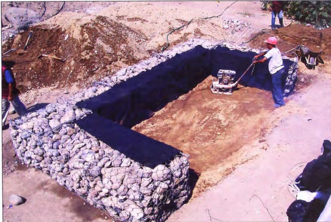
Foto 21 – Compactación del relleno estructural.
