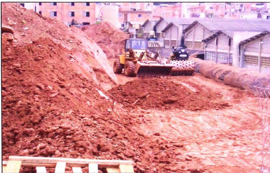
Figura 3.14 - Colocación de relleno estructural
