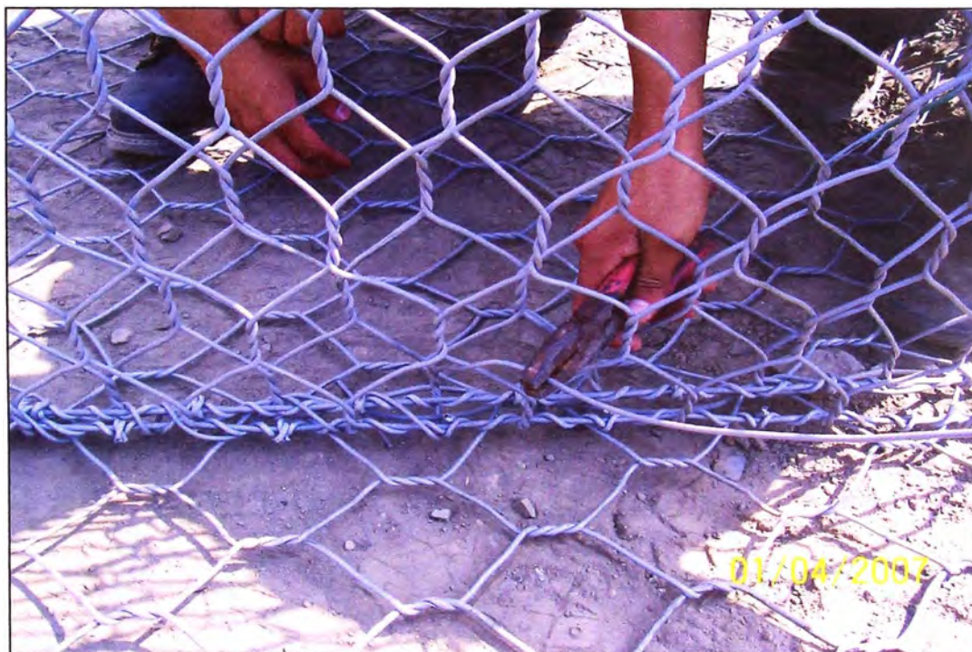
Foto 12 – Montaje de los elementos terramesh
