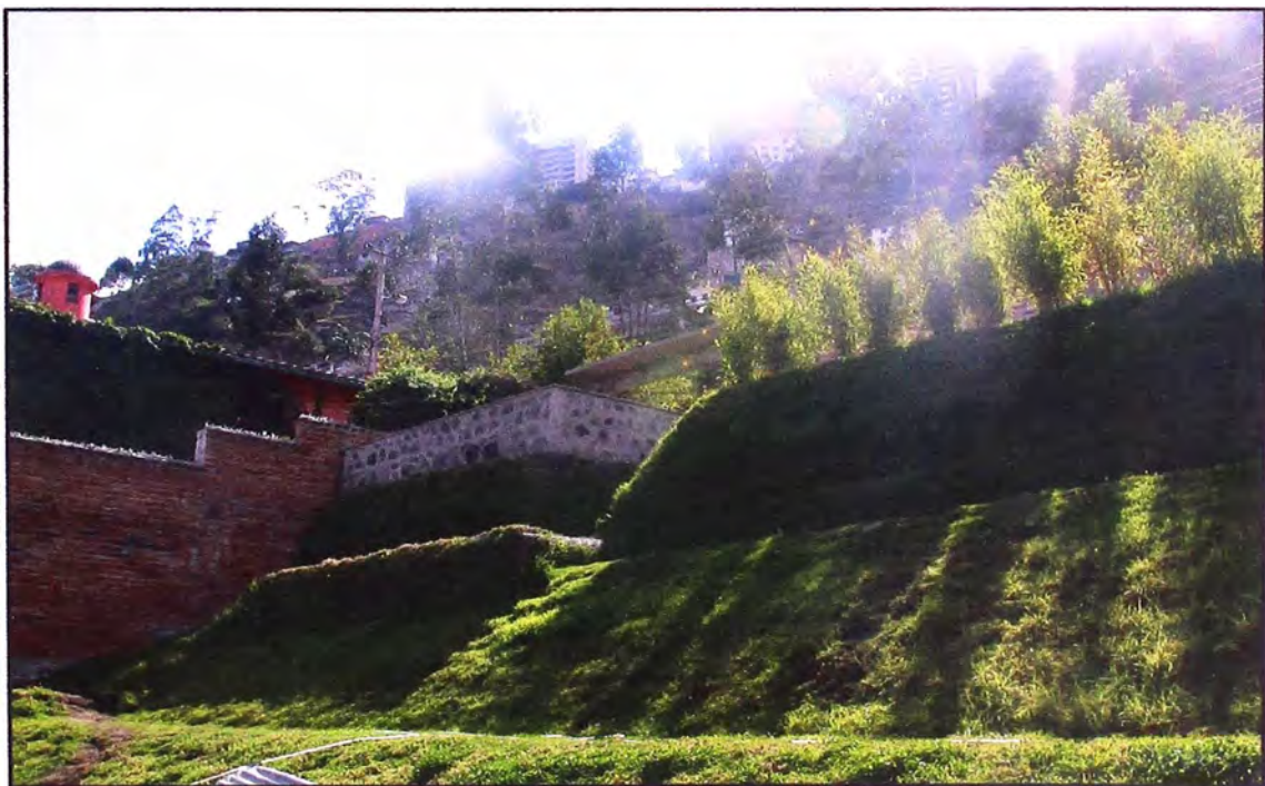
Figura 2.9 – Muro con Terramesh Verde (Quito)
