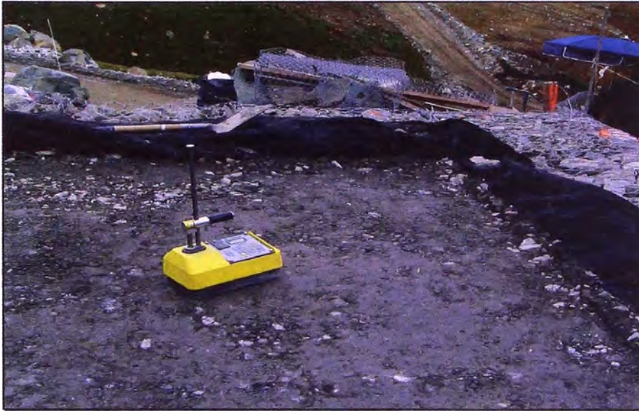
Figura 3.17 - Control de compactación
