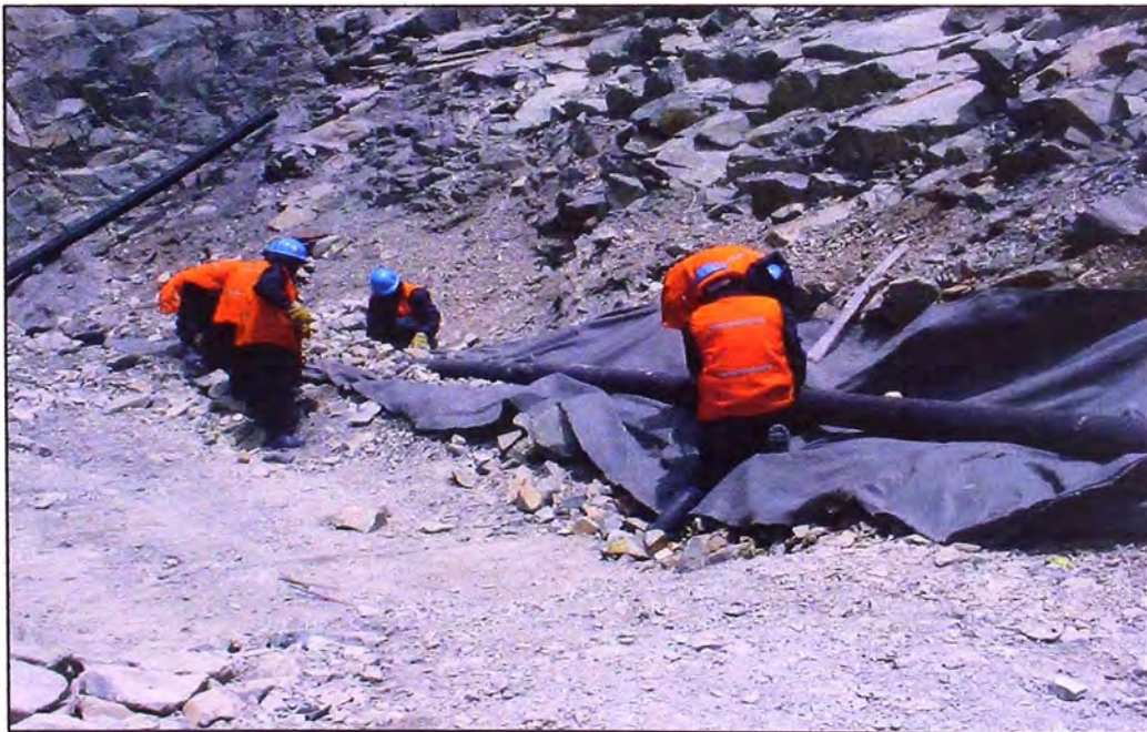
Figura 3.21 - Instalación de geodrenes.
