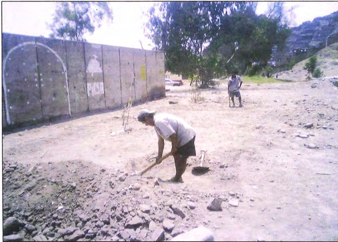
Foto 5 – Limpieza y nivelación del área de trabajo.
