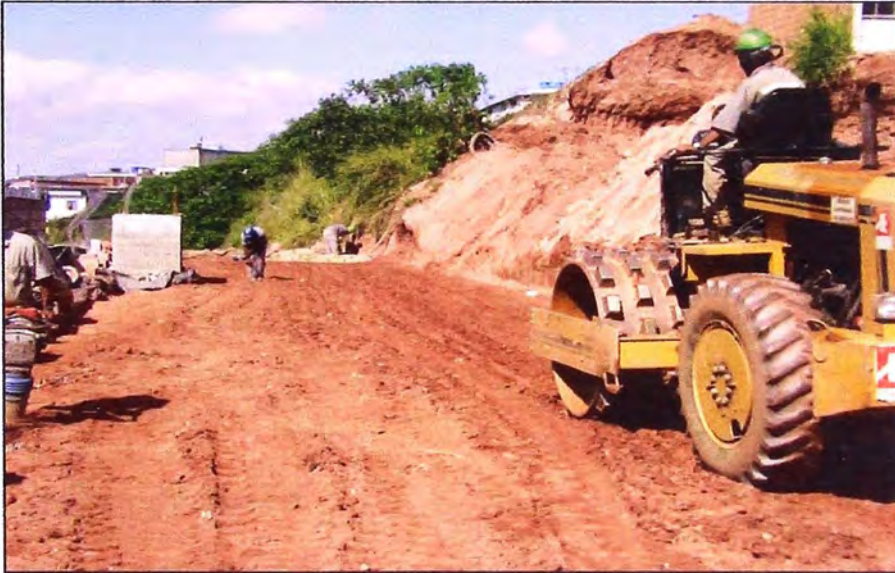
Figura 3.15 - Compactación con equipo pesado
