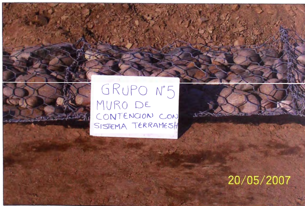
Foto 30 – Modelo experimental de muro terramesh finalizado.
