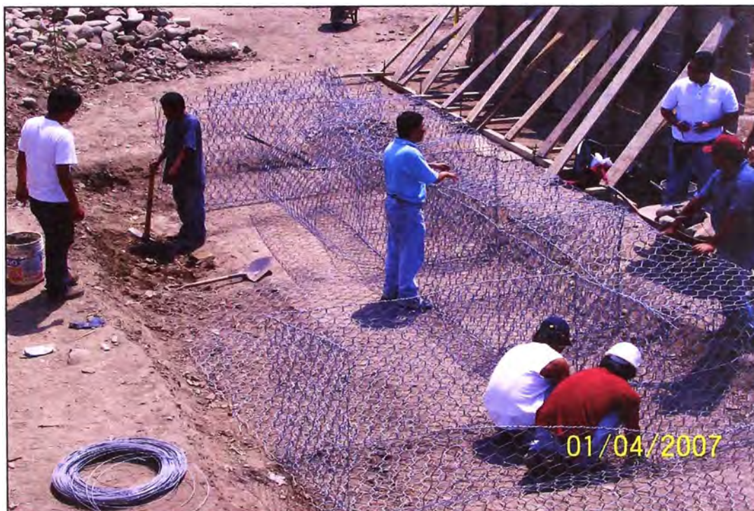
Foto 13 –Conformación de primera hilada de los elementos terramesh
