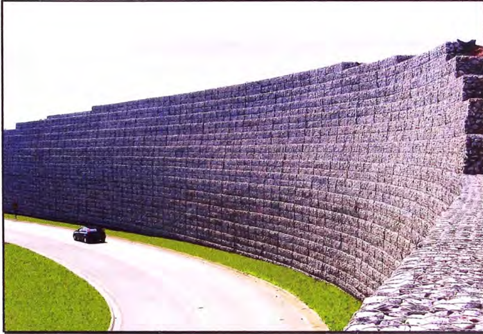
Figura 2.7 – Muro de Contención en Sorocoba (Brasil)
