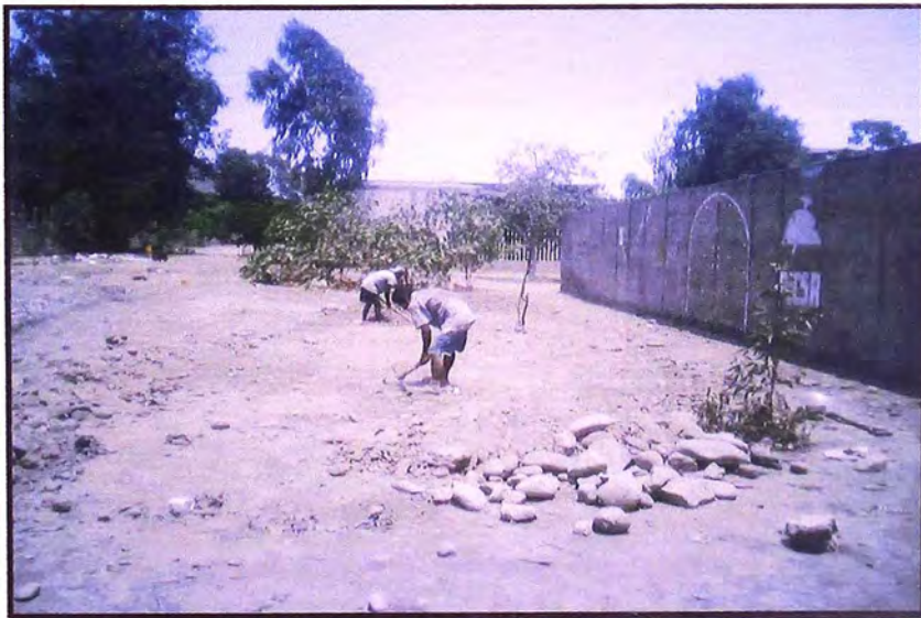
Figura 3.3 - Limpieza y preparación del terreno.
