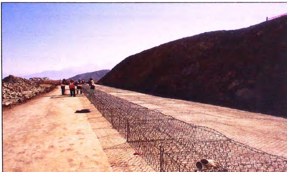
Figura 3.5 - Instalación de primera hilada de elementos terramesh sobre superficie nivelada
