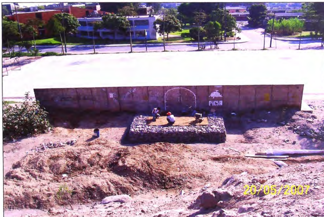
Foto 26 – Fin de la compactación.
