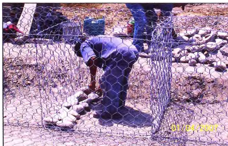
Figura 3.8 - Colocación de piedras en los elementos terramesh
