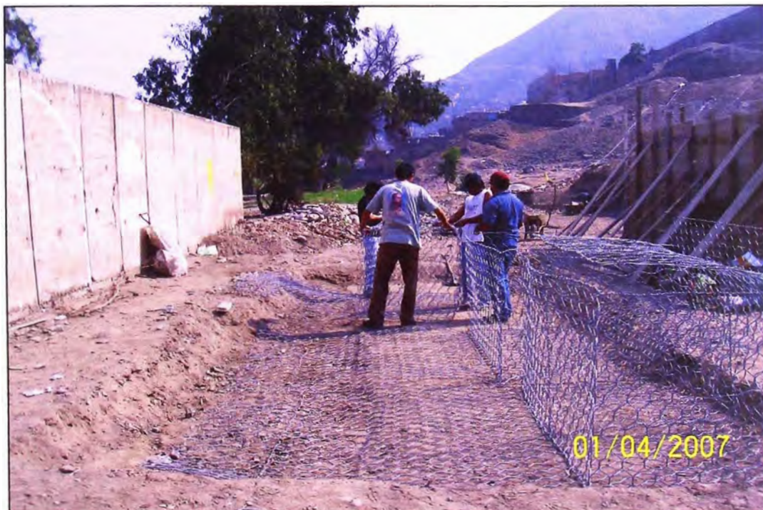
Foto 10 – Montaje de los elementos terramesh
