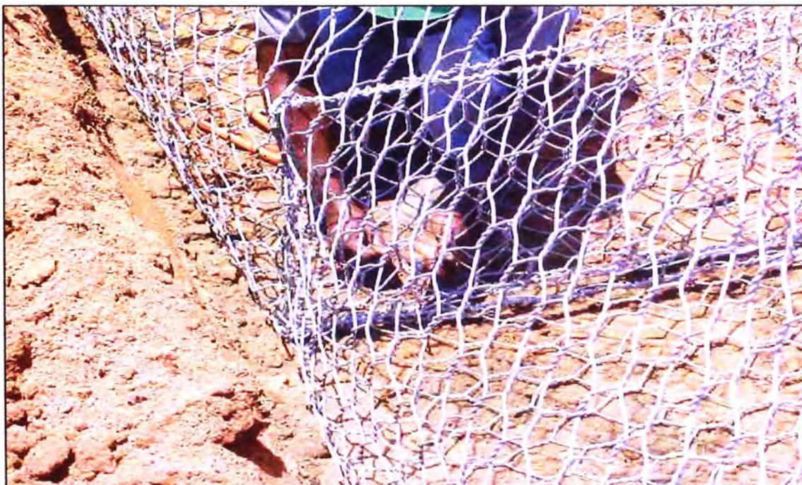
Figura 3.6 - Amarre de elementos terramesh continuos
