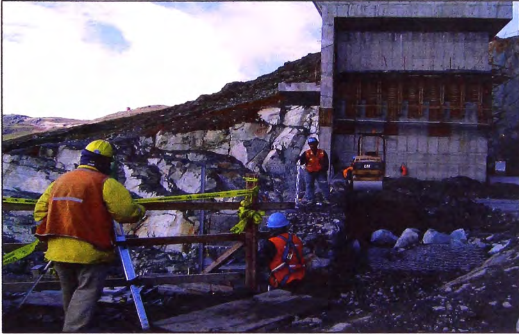
Figura 3.20 - Control de verticalidad del muro.
