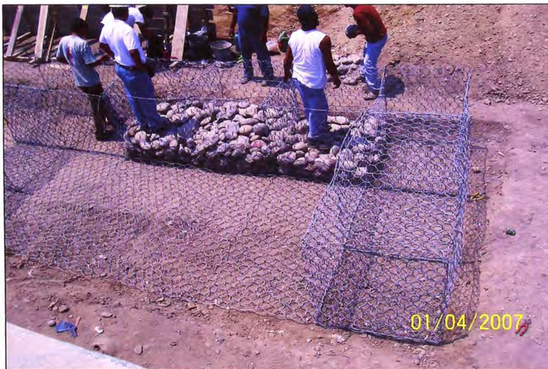
Foto 16 –Colocación de piedras en las cajas de gavión
