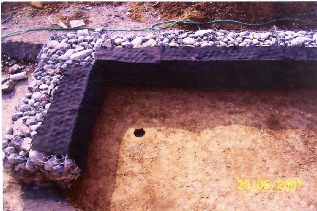
Foto 22 – Ensayo de densidad de campo.
