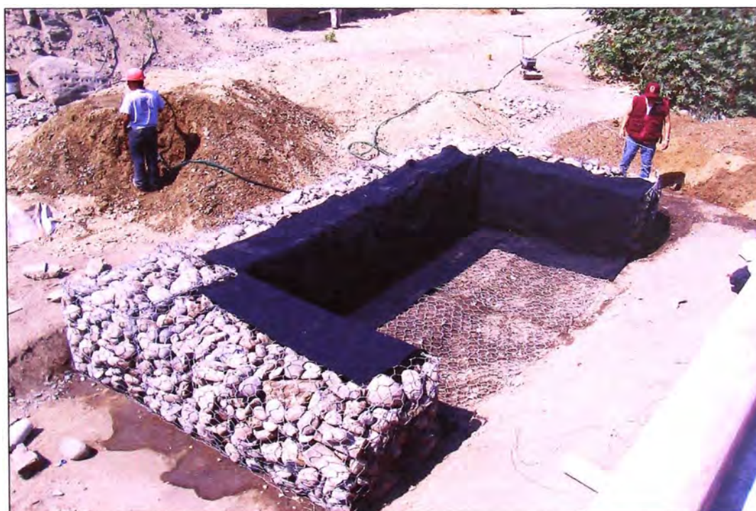
Foto 20 – Colocación de geotextil no tejido.
