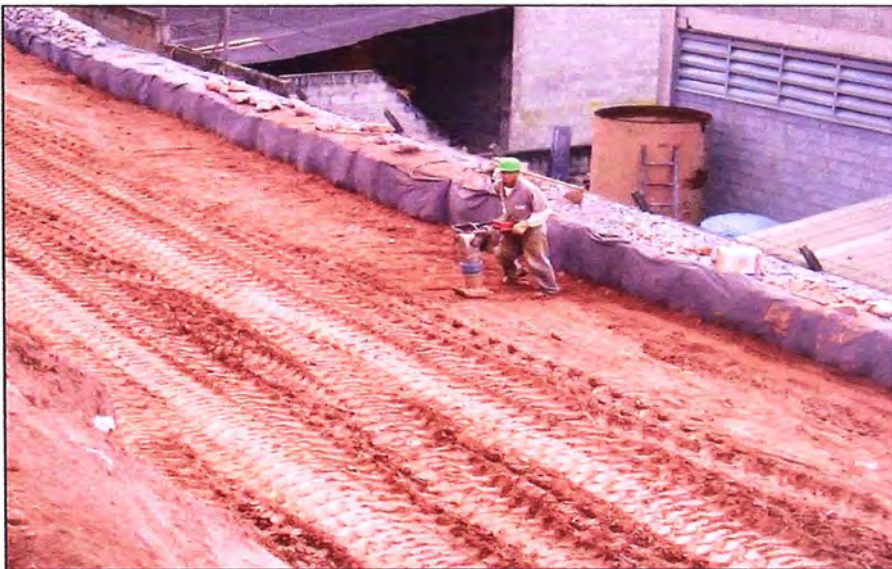
Figura 3.16 - Compactación con equipo liviano
