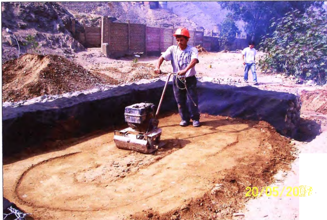
Foto 23 – Compactación del relleno estructural.
