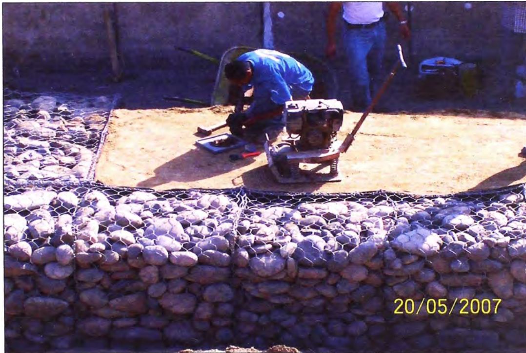
Foto 27 – Ensayo de densidad de campo.
