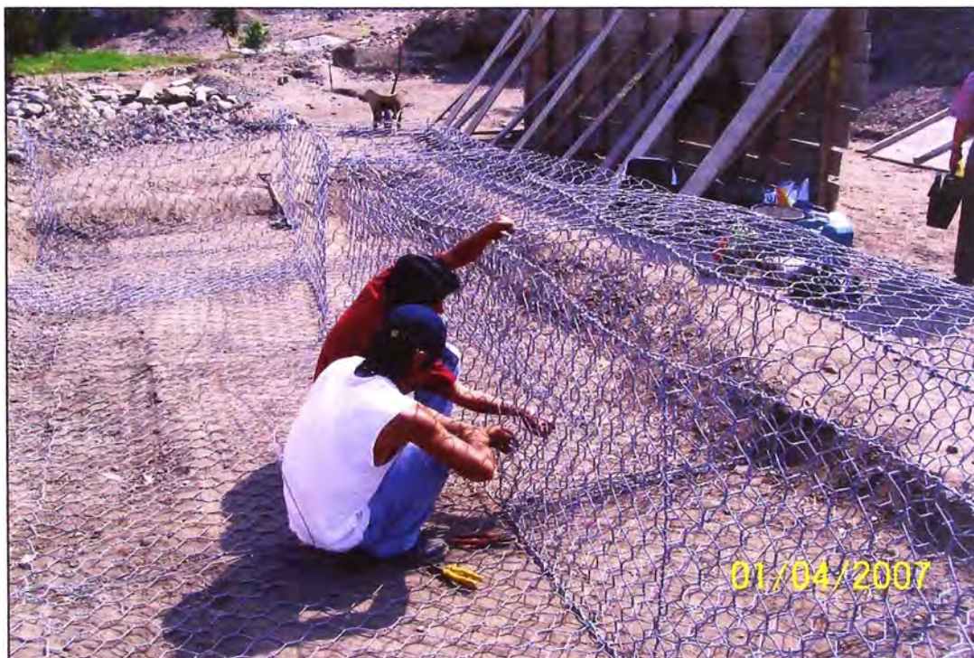
Foto 11 – Montaje de los elementos terramesh
