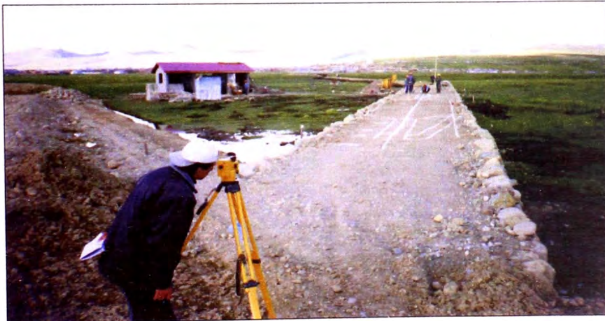
Foto 9: Terraplén artificial, sobre el cuál descansarán las estructuras de concreto de pretratamiento como cámara de rejas, desarenador, canaleta Parshall. Este terraplén se encuentra a una cota igual de la corona del dique de la laguna, a 4,093.15 m.s.n.m.
