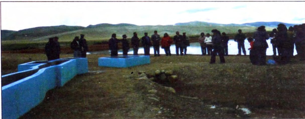
Foto 34: Autoridades, representantes de la Municipalidad Provincial, y personas invitadas, en el día de la Inauguración de la Primera Etapa de la Planta de Tratamiento de Aguas Residuales Lado Sur de Junín.
