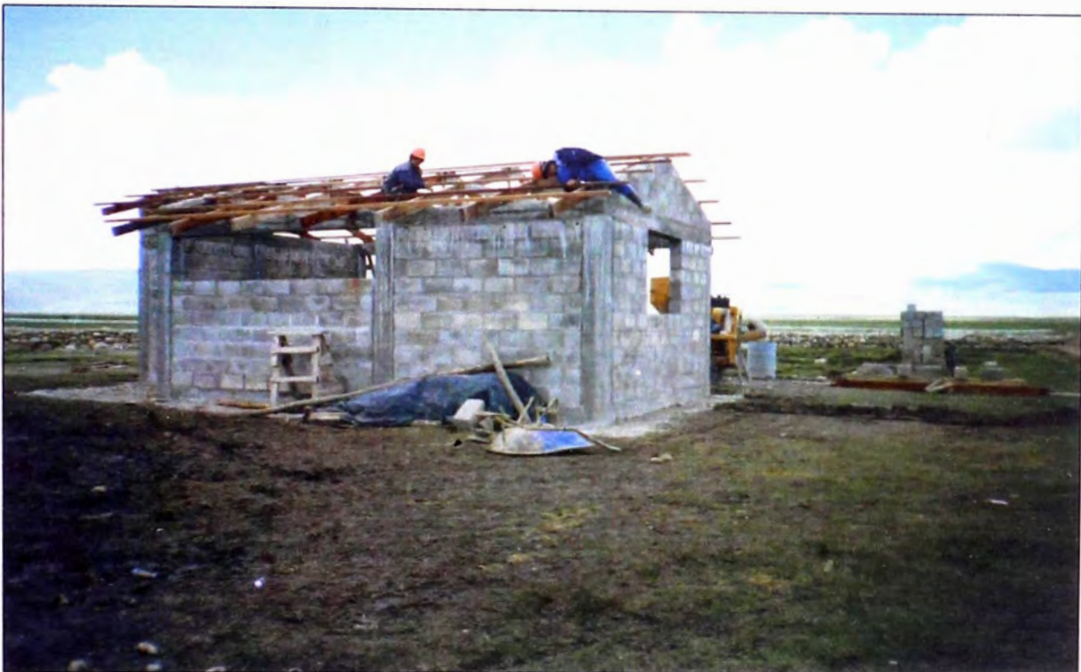
Foto 25: Vista posterior de la Caseta de Guardianía con muros de bloquetas de concreto de 0.20x0.20x0.40 cm conocidos en la zona como ladrillos Kinkon. Toda la cobertura fue sobre viguería de madera en los tijerales y correas.
