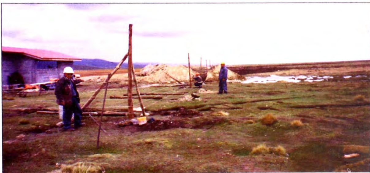
Foto 27: Cerco perimétrico de postes de eucalipto de 4" de diámetro y alambre de púas a cada 20 cm. en 5 hileras, para impedir el paso de animales y personas no autorizadas.
