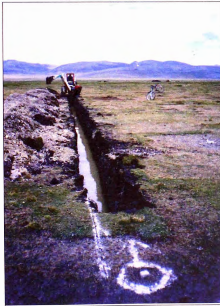
Foto 3: Excavación de zanjas del canal Emisor mediante un equipo multipropósito - retroexcavadora. Se puede apreciar las afloraciones del agua subterránea debido al alto nivel freático de la zona, promedio -1.10m.
