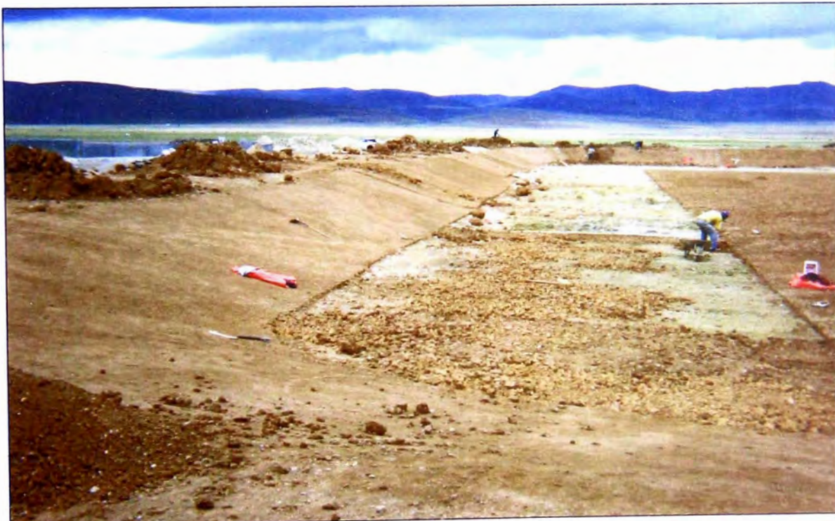
Foto 21 Impermeabilización del interior de la laguna primaria mediante una capa de arcilla seleccionada de 5 cm de espesor, trabajada manualmente por parcelas.
