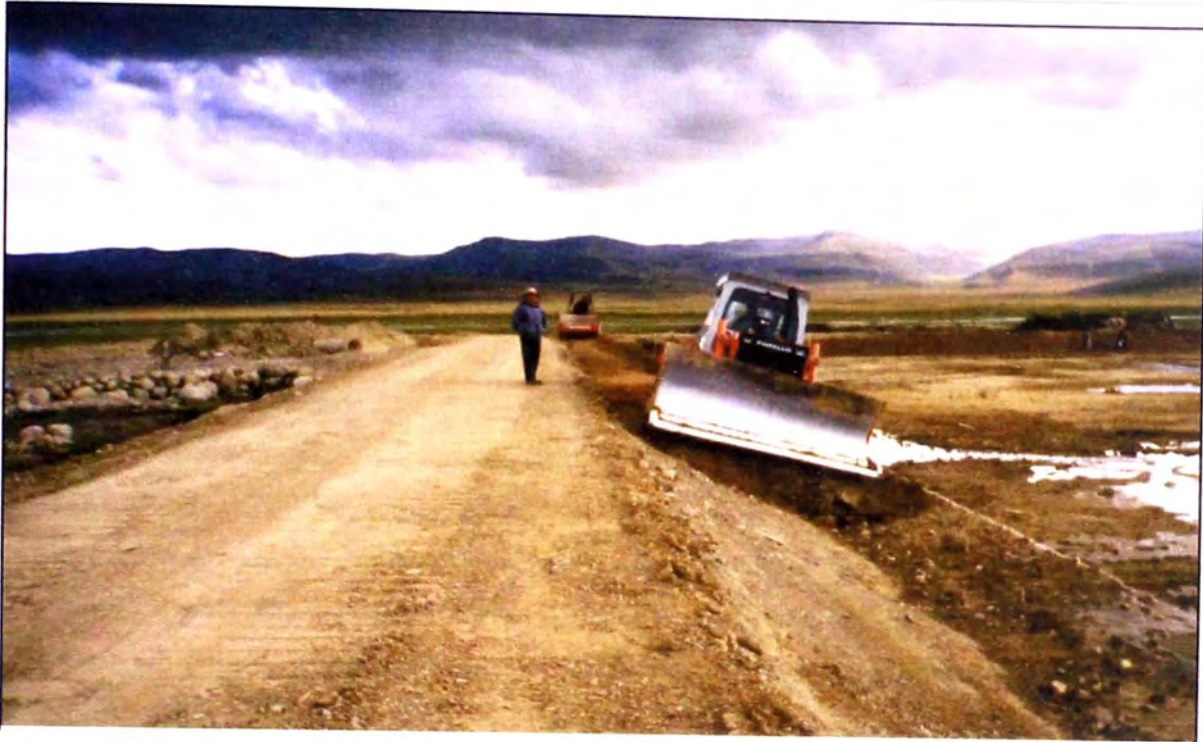
Foto 19: Uno de los problemas de la formación de taludes fue darle la inclinación pedida, lo que se solucionó con ayuda del Tractor oruga, y compactación del rodillo vibratorio.
