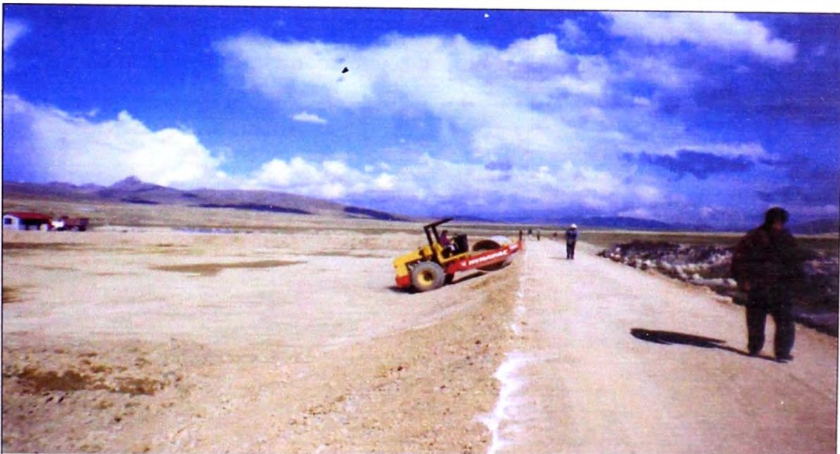
Foto 20: Conformación de los taludes inclinados 1/2.5 mediante la compactación del rodillo vibratorio sobre el material de Afirmado previo humedecimiento.
