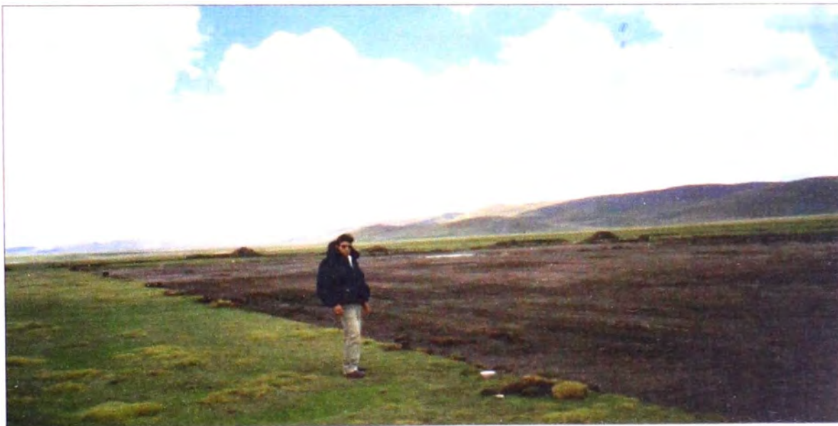
Foto 2: A inicios de obra se deja monumentazo con hitos de concreto a cada 30 m en el perímetro de la obra. Se observa labores de limpieza y deforestación, eliminación de la cap.; orgánica del interior de la futura laguna primaria.
