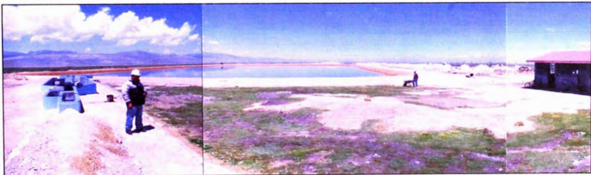
Foto 32: Vista panorámica de la Primera Etapa de la Planta de Tratamiento de Aguas Residuales de Junín, en funcionamiento con el llenado de la laguna primaria.
