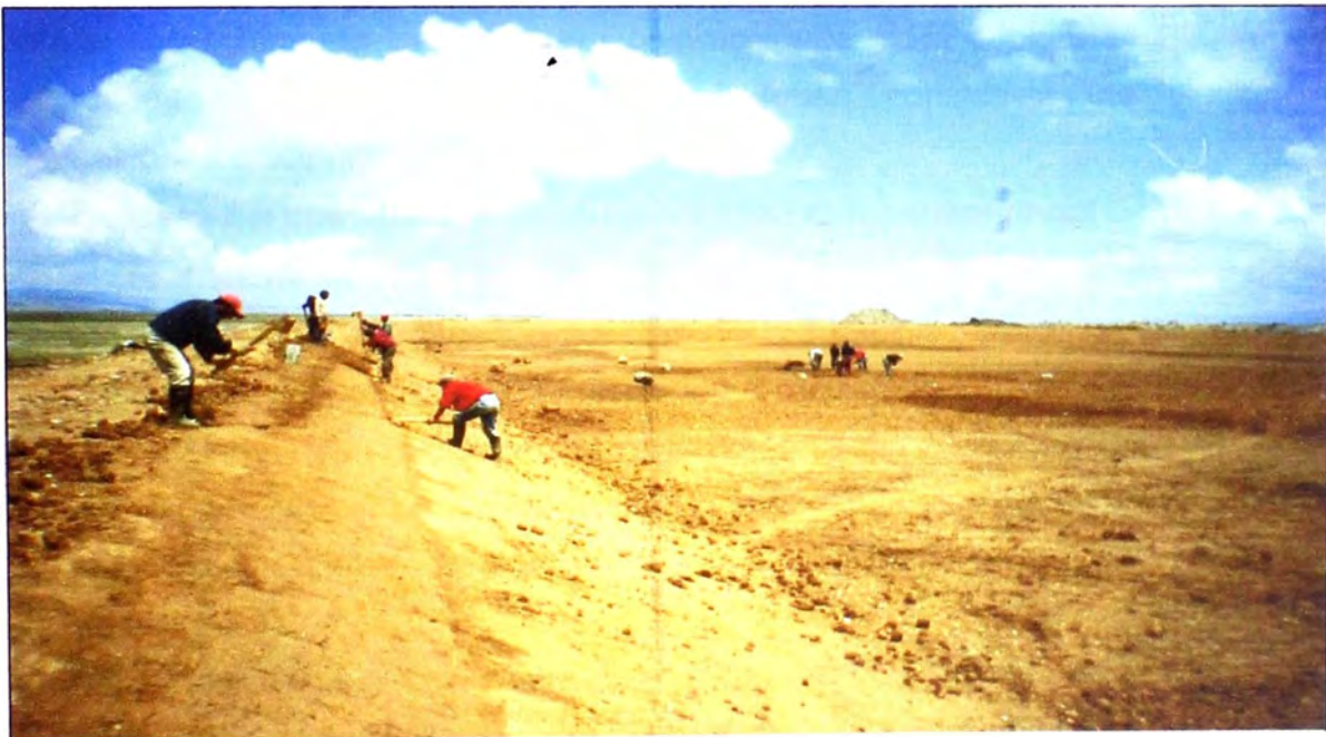
Foto 22: Impermeabilización de fondo e interior de taludes de la laguna primaria con arcilla. Obsérvese la utilización de los mazos para la compactación manual. Sobre el borde superior de la laguna se puso una capa de 10cm de espesor en un ancho de 1 metro para evitar la erosión por acción de las olas (Como medida preventiva dentro de la Primera Etapa). Se recomienda que sea de concreto a fin de evitar el crecimiento de plantas acuáticas
