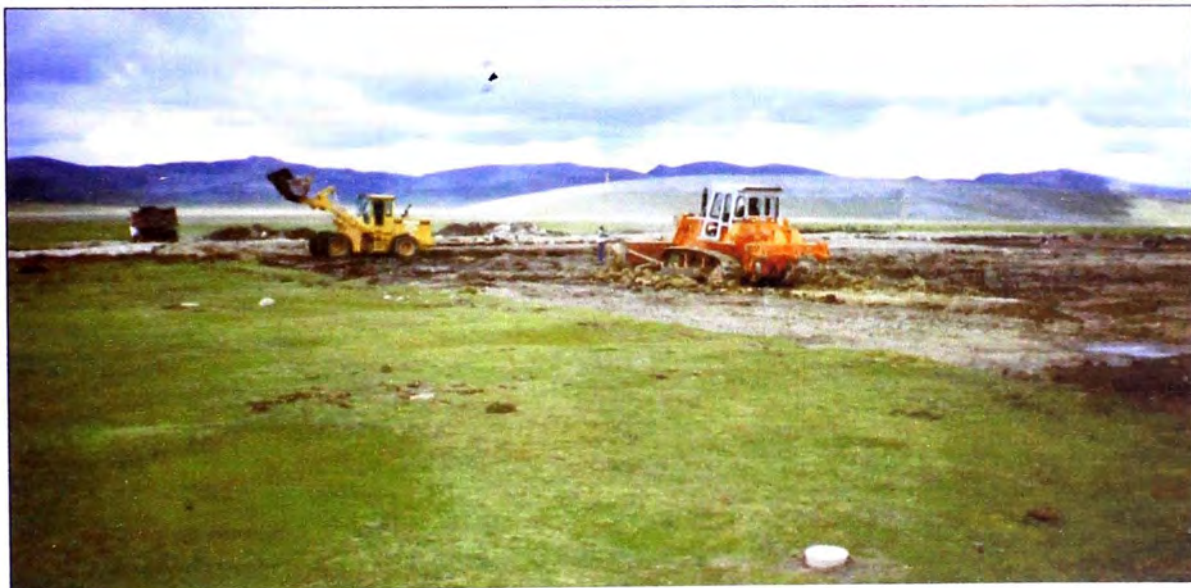
Foto 15: Corte de terreno en la Laguna Primaria mediante maquinarias pesadas: Tractor oruga, Cargador Frontal, y Volquetes de 6 m 3 . Se observa los hitos de concreto de referencia.
