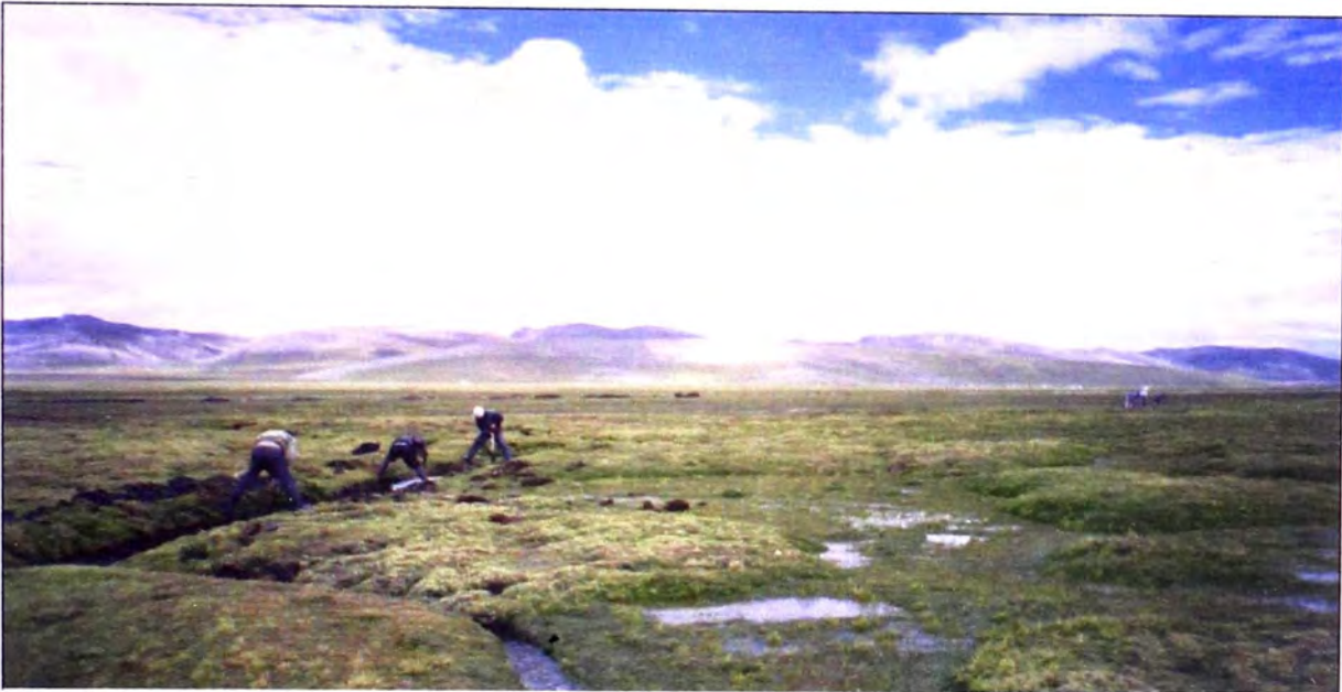
Foto 28: Limpieza y mantenimiento de los canales artesanales, denominados de drenaje menor a fin eliminar las aguas de las escorrentías superficiales y llevarlas fuera del área de la laguna.
