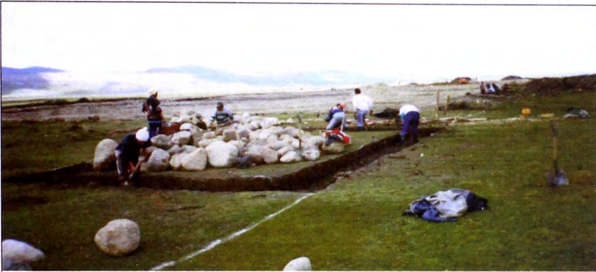
Foto 23: Plantillado y eliminación de la capa orgánica de la base de la futura Caseta de Guardianía con tres ambientes (Laboratorio, Guardianía y Depósito) de material noble.
