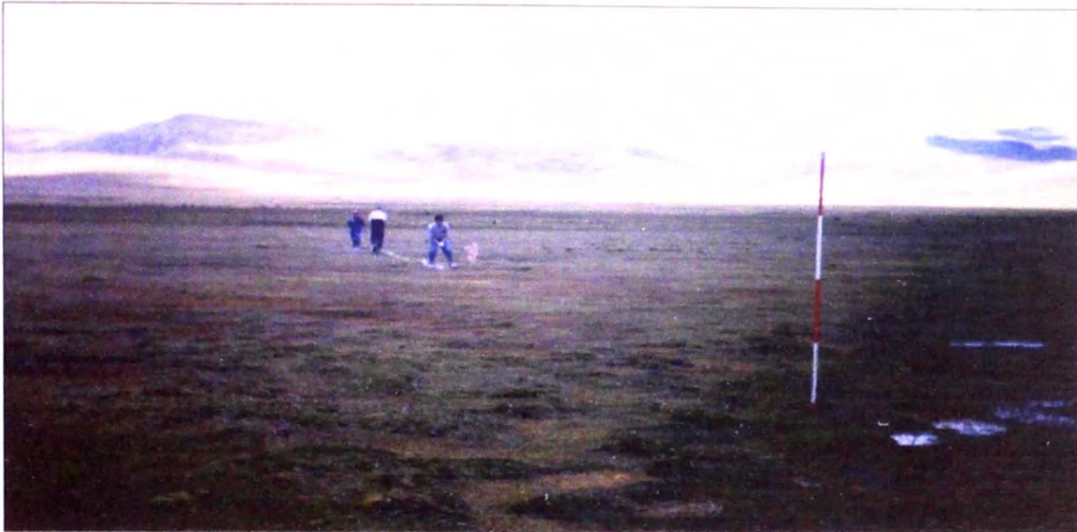
Foto 1: Vista del terreno donde se encuentra ubicada la PTAR lado Sur de Junín. La planicie del terreno presenta una pendiente uniforme de 1%. La obra se inicia con el replanteo y trazado de ejes de la laguna primaria.
