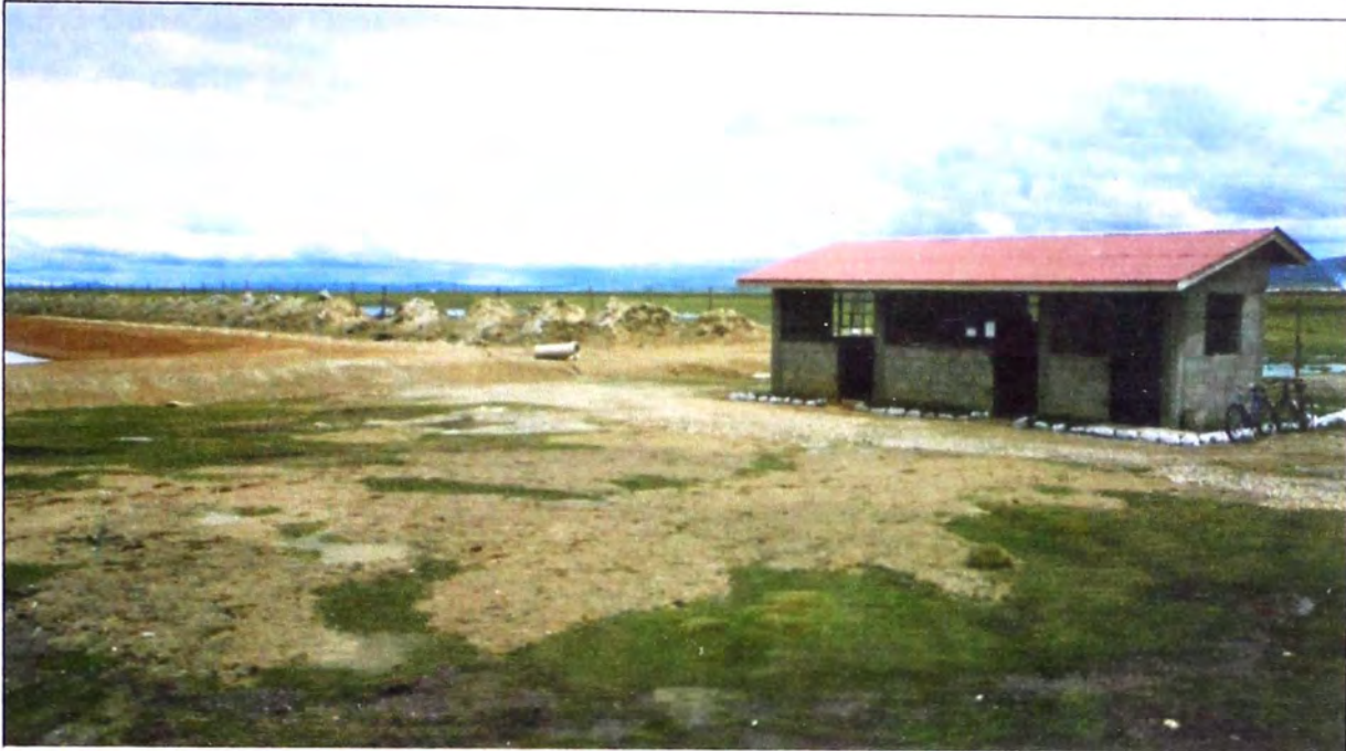
Foto 26: Caseta de Guardianía con tres ambientes, culminada hasta su primera etapa. Las demás partidas de acabados se continuarán en las demás etapas del proyecto integral.
