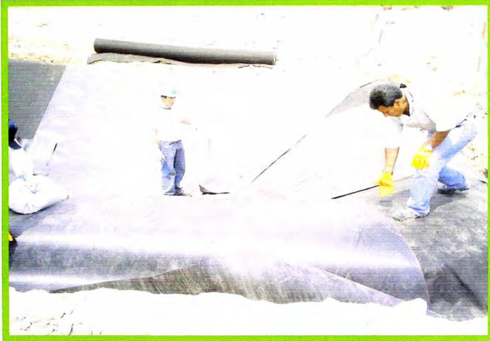
**Foto N° 17: Colocación de paneles de geomembrana HDPE 1.0 mm de espesor**
