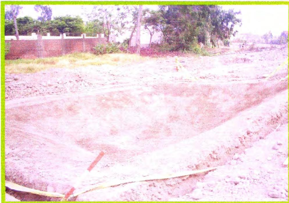
**Foto N° 7: Conformación y Refine de fondo y paredes de reservorio de agua**
