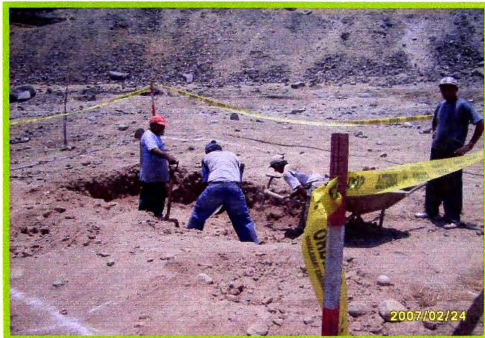
Foto N° 3: Excavación de Reservorio
