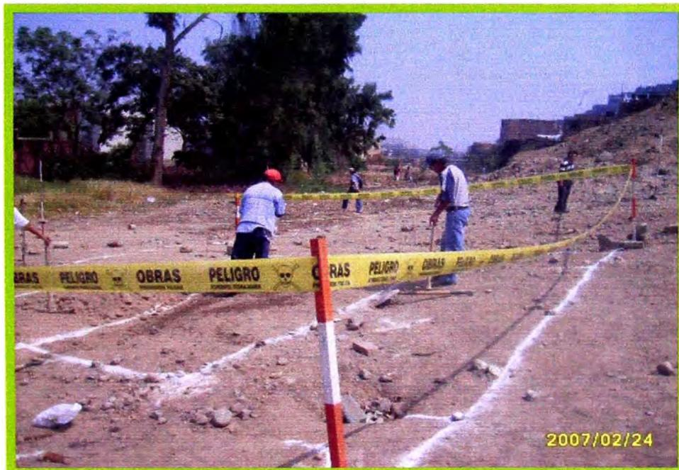
Foto N° 2: Cercado de perímetro con cinta de seguridad y trazo de reservorio
