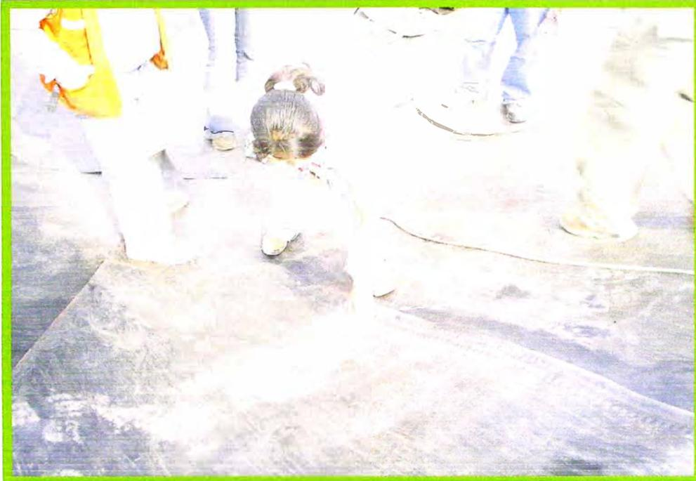
**Foto N° 19: Control de Calidad durante la ejecución del proyecto, verificando la soldadura y marcando zonas de reparaciones**
