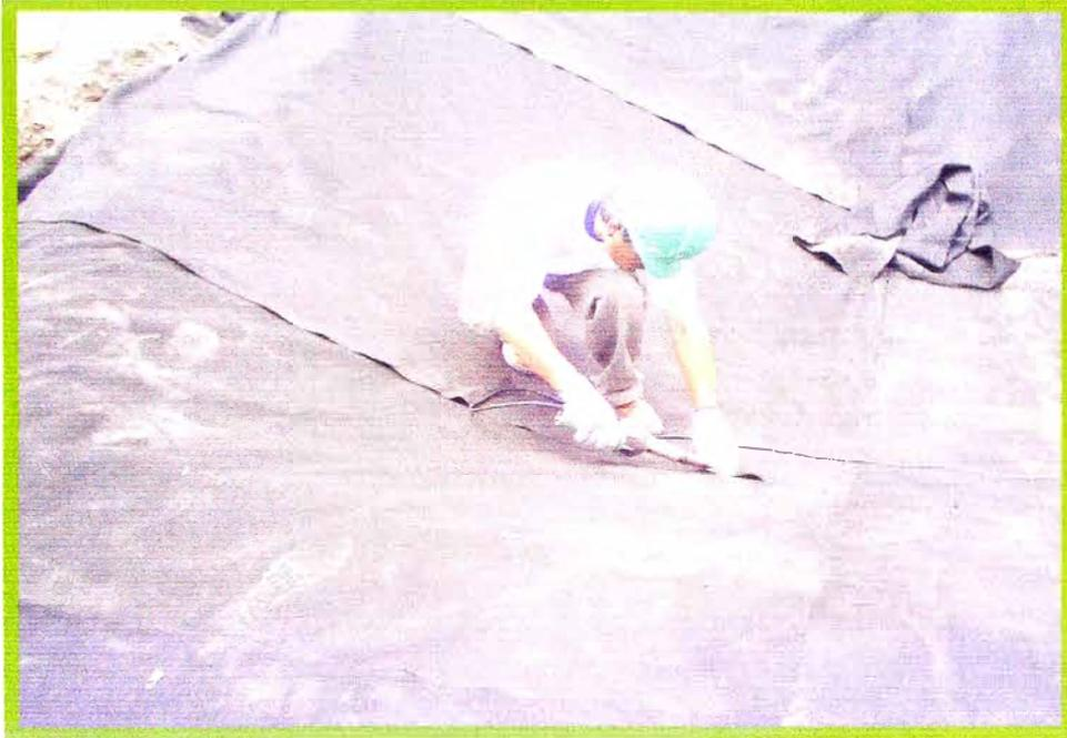
**Foto N° 11: Sellado por calor de uniones entre paños de geotextil**
