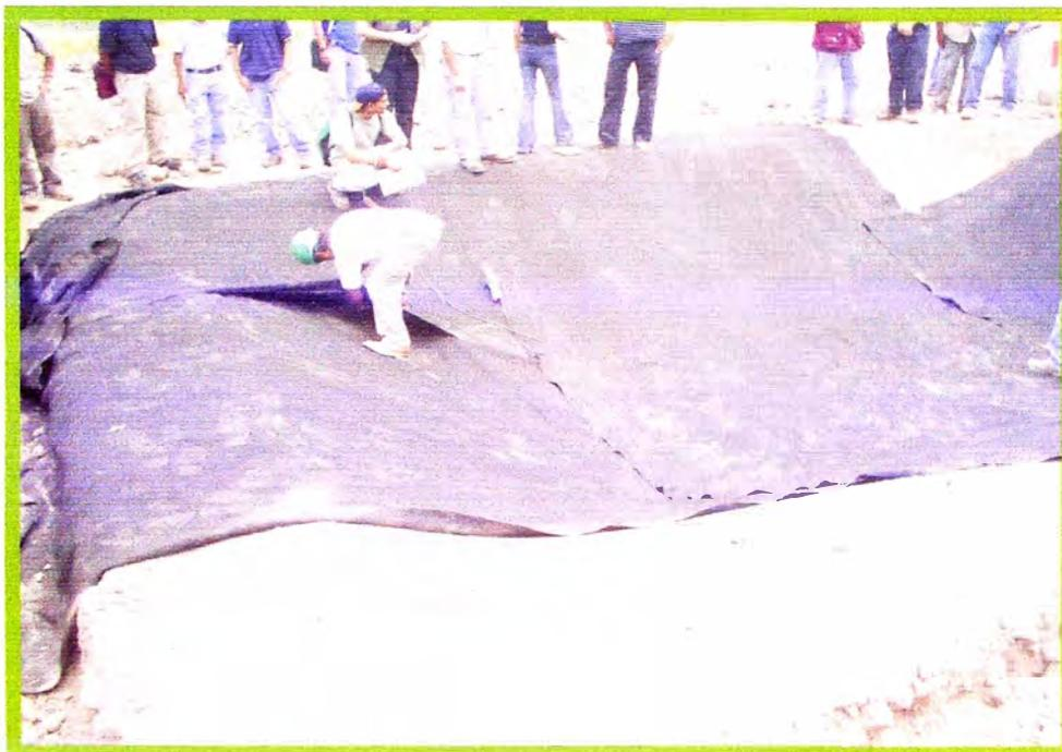
**Foto N° 13: Control de Traslapes en paneles de Geotextil**
