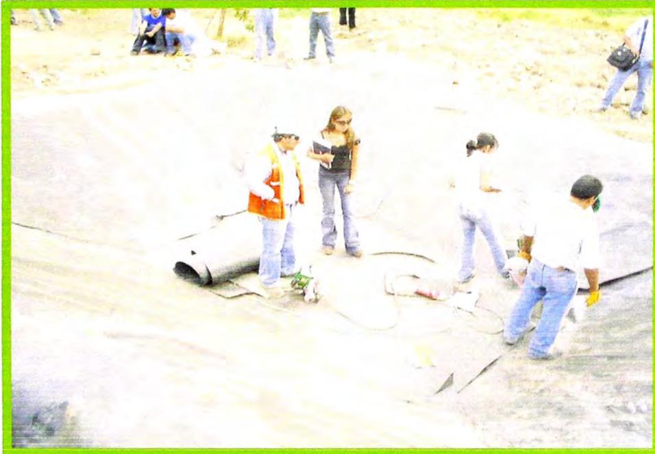
**Foto N° 21: Vista general de Reservorio impermeabilizado con geomembrana**
