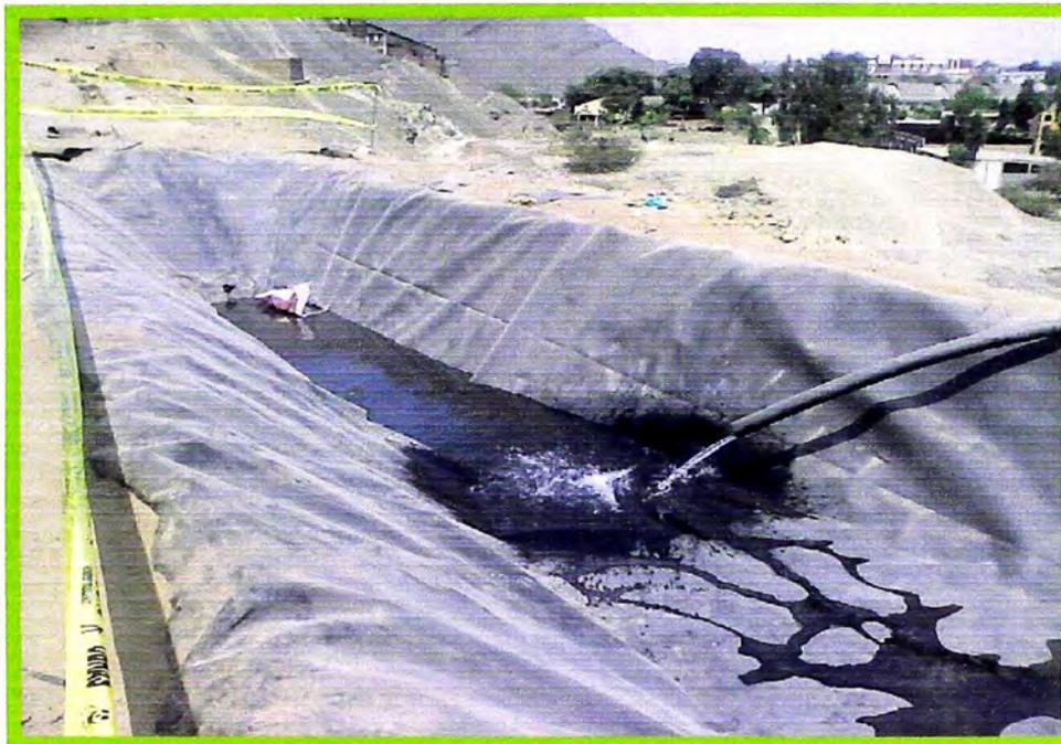
**Foto N° 27: Reservorio N°2 en la parte superior, punto de llegada de la línea de impulsión, inicio de llenado de reservorio**
