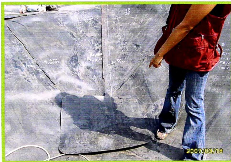
Foto N° 25: Control de parches, soldadura por extrusión
