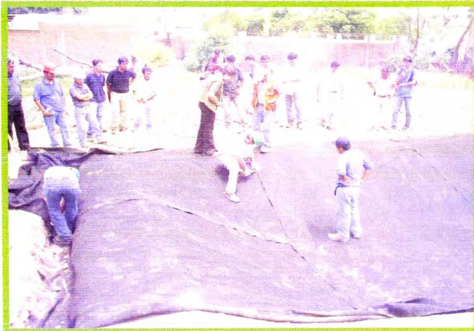
**Foto N° 12: Vista general de tendido de geotextil en Reservorio de Agua**
