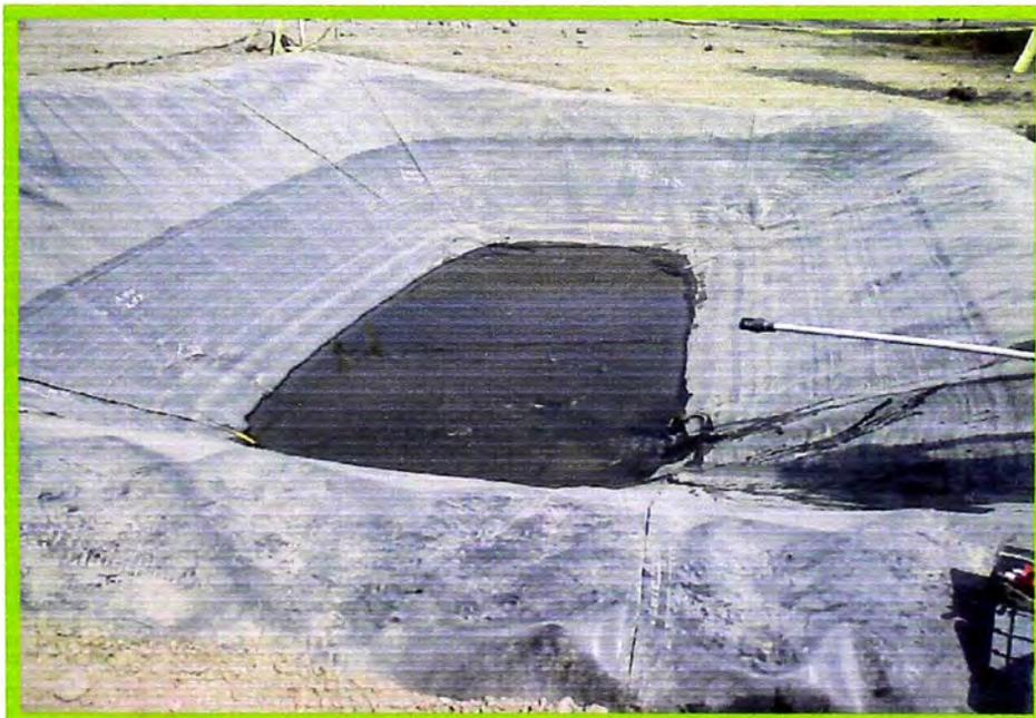
**Foto N° 30: Nivel final de Reservorio N° 1, en la parte inferior, se observa la línea de succión con válvula de pie y canastilla para evitar ingreso de material sólido al sistema.**
