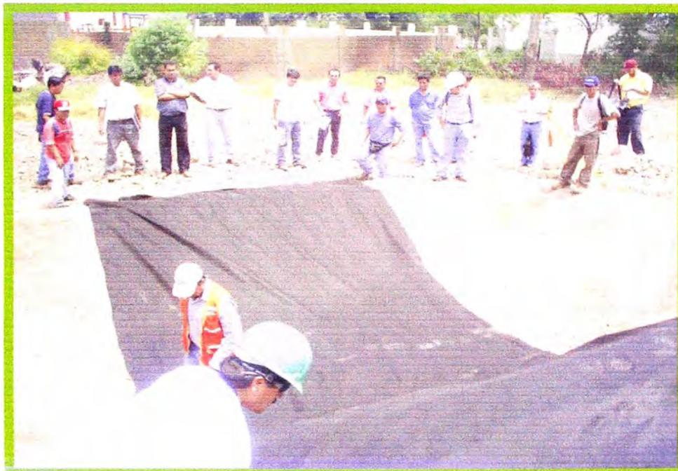
**Foto N° 9: Instalación de Geotextil**
