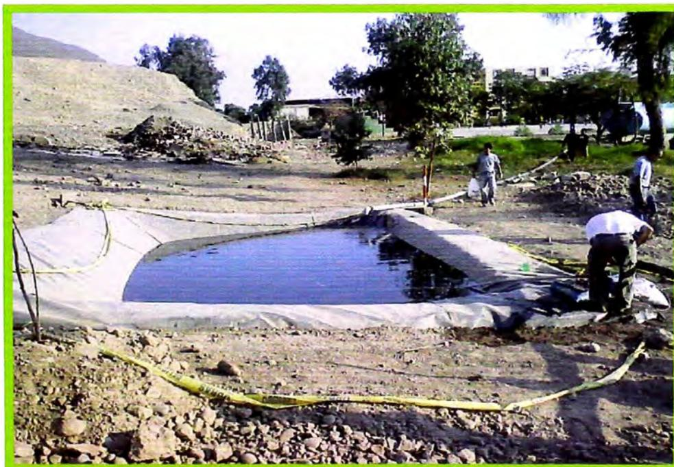
Foto N° 26: Llenado de Reservorio para prueba de impulsión hacia el Reservorio N°2
