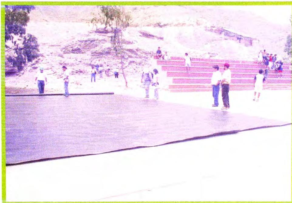
**Foto N° 14: Corte de paneles de geomembrana en zona adyacente para facilitar su instalación**
