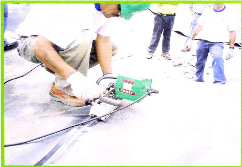
**Foto N° 18: Soldadura por termofusión entre paneles de geomembrana para asegurar la impermeabilidad del reservorio**
