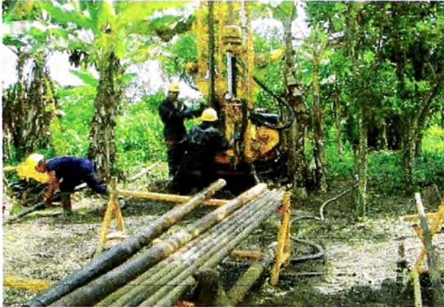
Figura 3-1. Vista general de taladro ejecutando el sondeo SD-EI-05 margen izquierda
