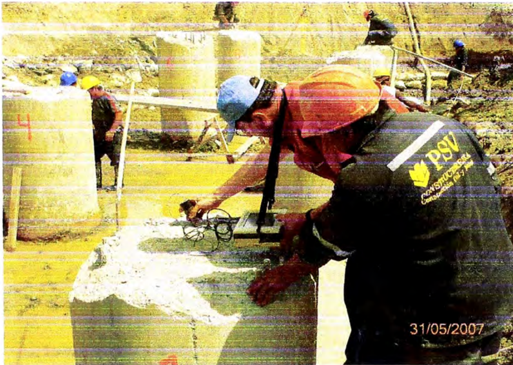
Figura 6-3 En la imagen se aprecia la realización de la prueba de integridad de pilotes – Puente Rubio – Fuente: PSV
