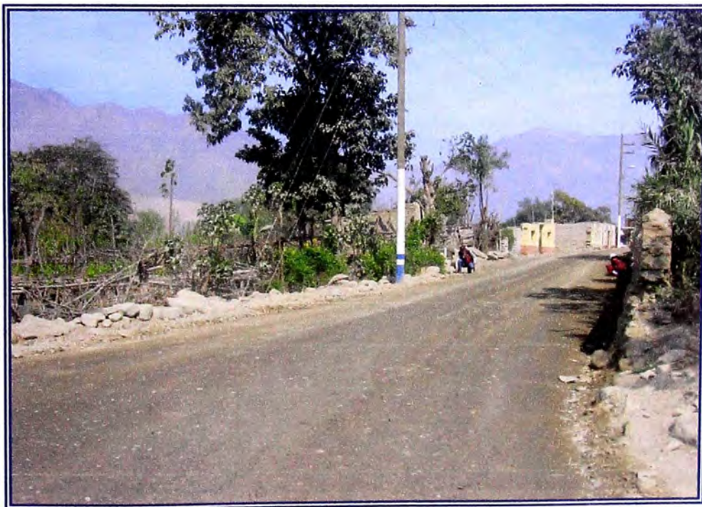
FOTO N° 2.- El levantamiento topográfico se hace cada 20 m, también se realiza un Inventario Vial.
