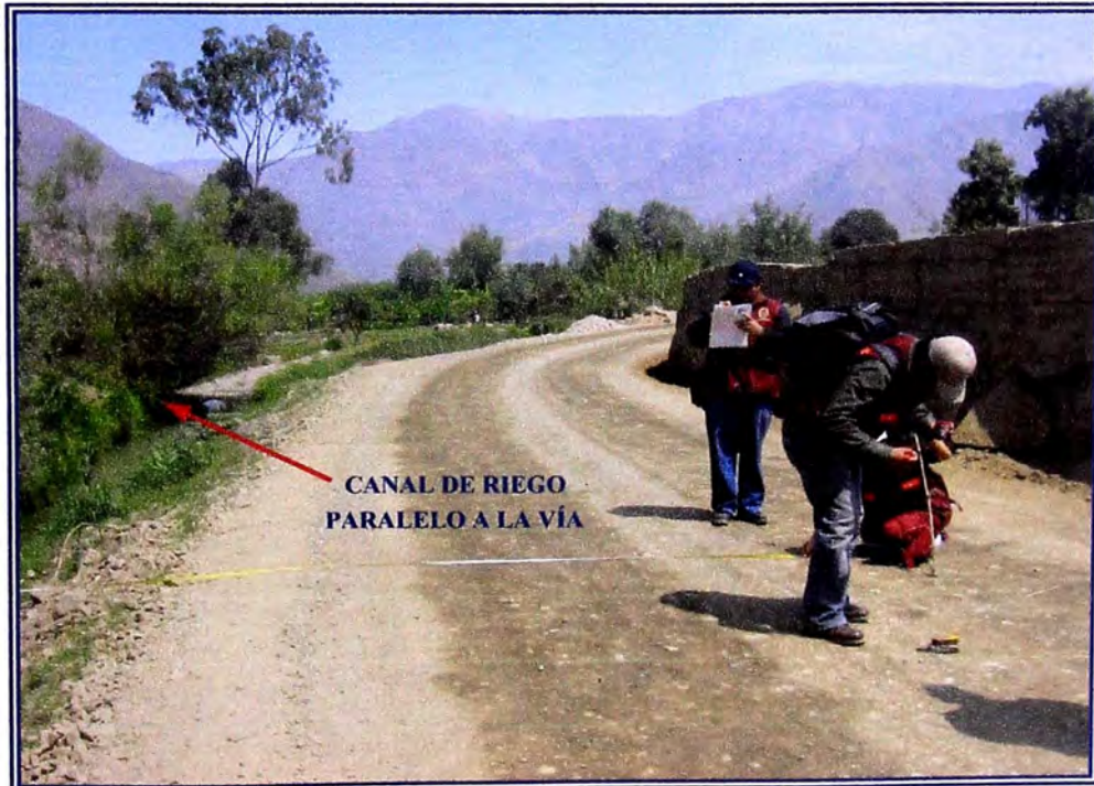
FOTO N° 4.- Se toman las medidas de ancho de calzada, la cota con el GPS y la existencia de estructuras Hidráulicas y drenaje.
