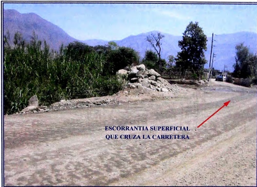
FOTO N° 5.- Se observa impactos ambientales como desmonte de material ubicado al lado de la vía, maleza que impide la visibilidad del conductor.
