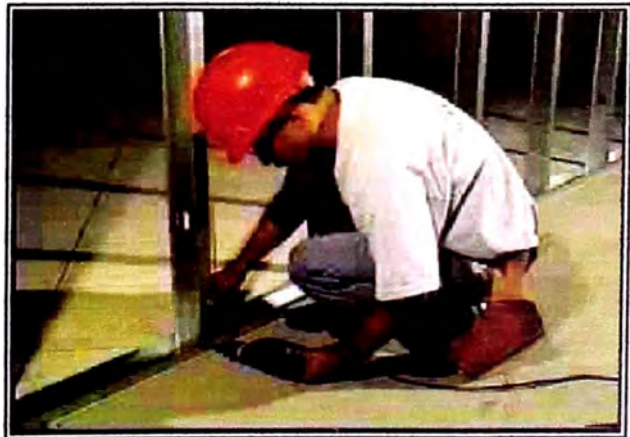
Los postes de acero se colocan en los rieles del piso
