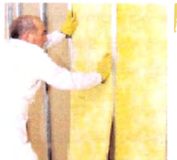
Instalación de la fibra
