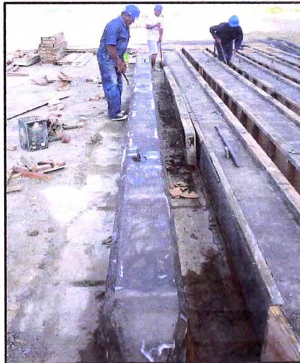
FOTO N° 06 : DESENCOFRADO DE LOS PILOTES
