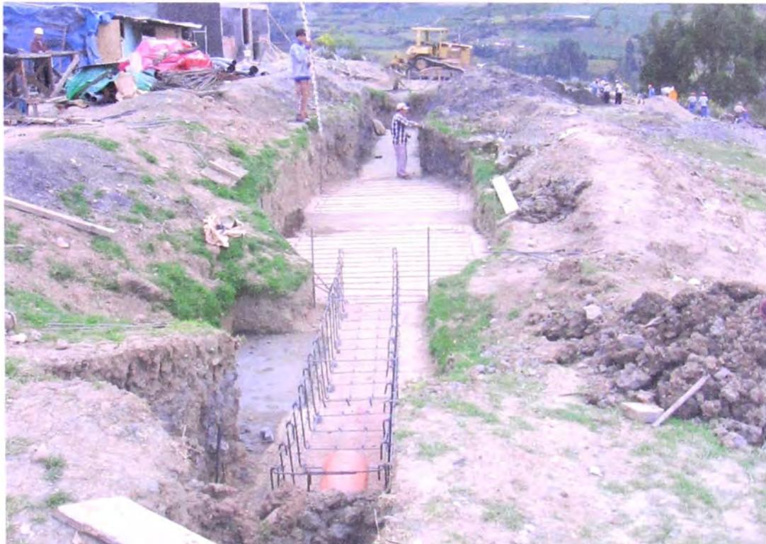
**FOTO N° 4 CONSTRUCCION DE DESARENADOR Y MEDIDORES**
