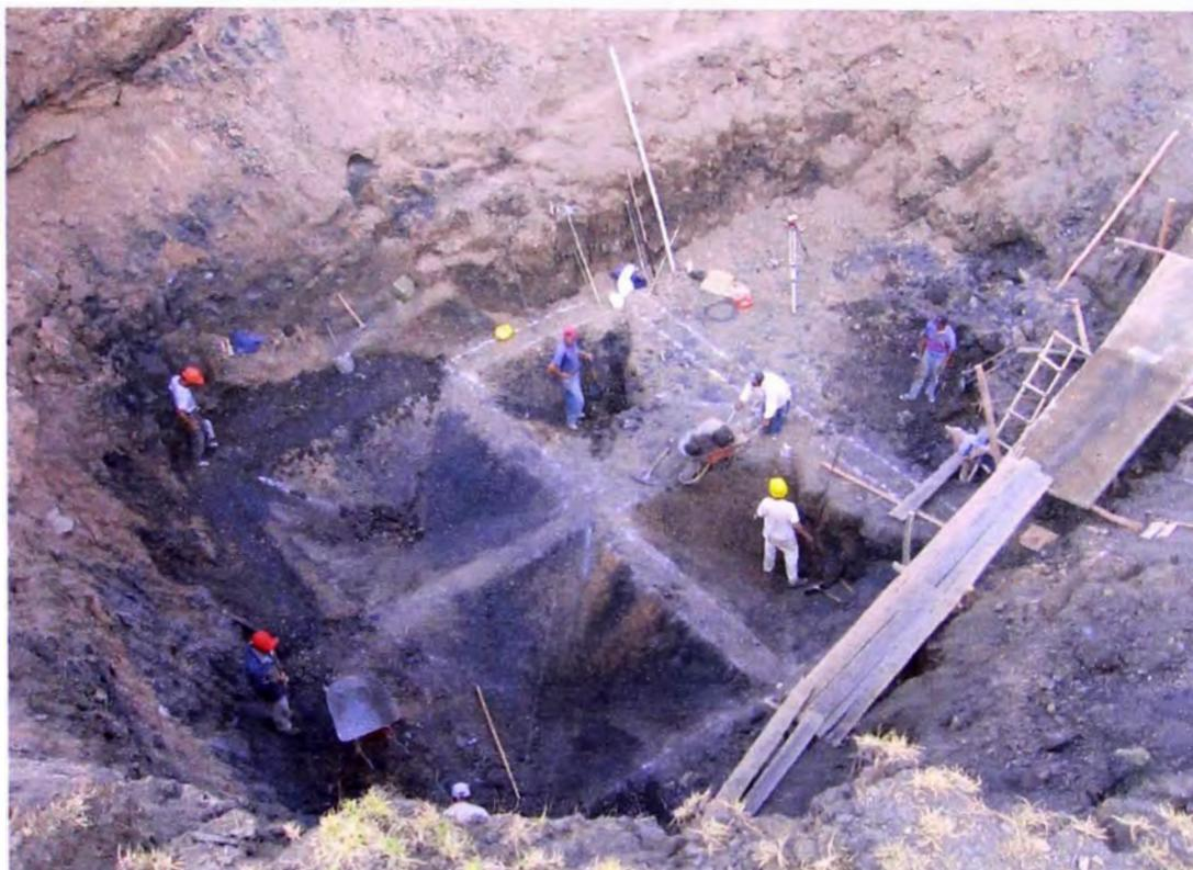
**FOTO N° 5 TRABAJOS INICIALES EN LA CONSTRUCCION DEL TANQUE IMHOFF**
