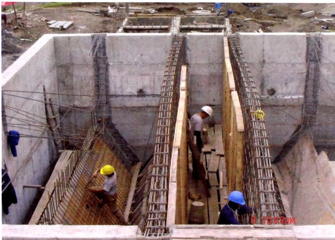
**FOTO N° 8 TANQUE IMHOFF EN CONSTRUCCION**
