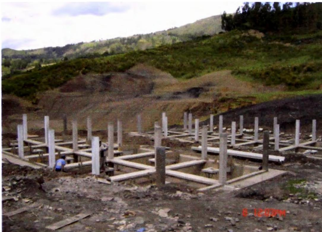
**FOTO N° 11 CONSTRUCCIÓN DE LECHO DE SECADOS**
