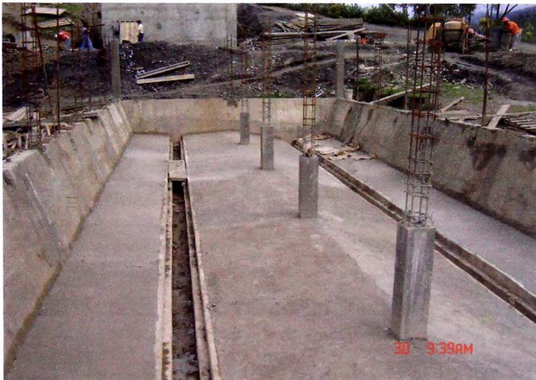
**FOTO N° 10 CONSTRUCCIÓN DE LECHO DE SECADOS**
