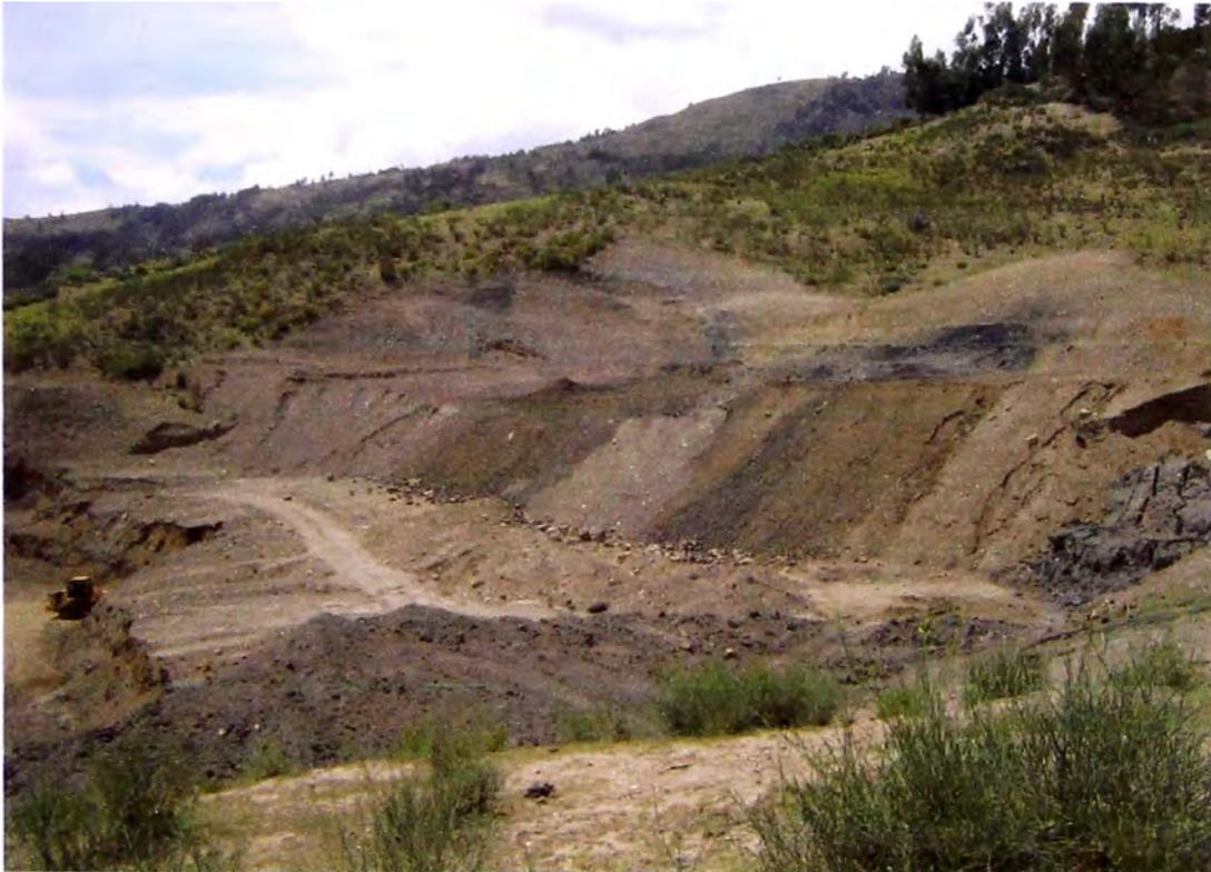
**FOTO N° 15 BANQUETAS DE SEGURIDAD EN CONST. PARA MANTENER EL TALUD**
