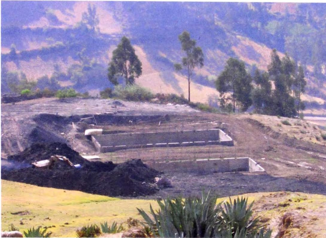
**FOTO N° 9 CONSTRUCCIÓN DE LECHO DE SECADOS**
