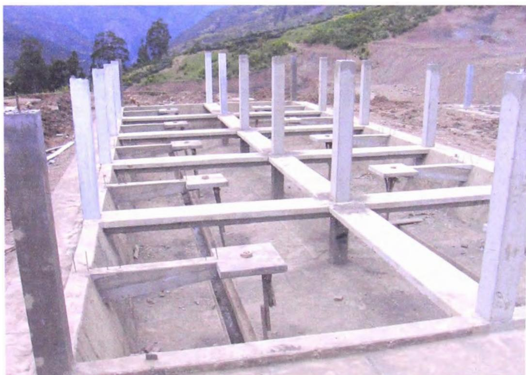
**FOTO N° 12 CONSTRUCCIÓN DE LECHO DE SECADOS**
