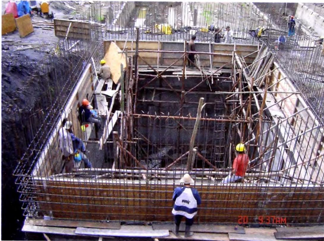
**FOTO N° 7 TANQUE IMHOFF EN CONSTRUCCION**
