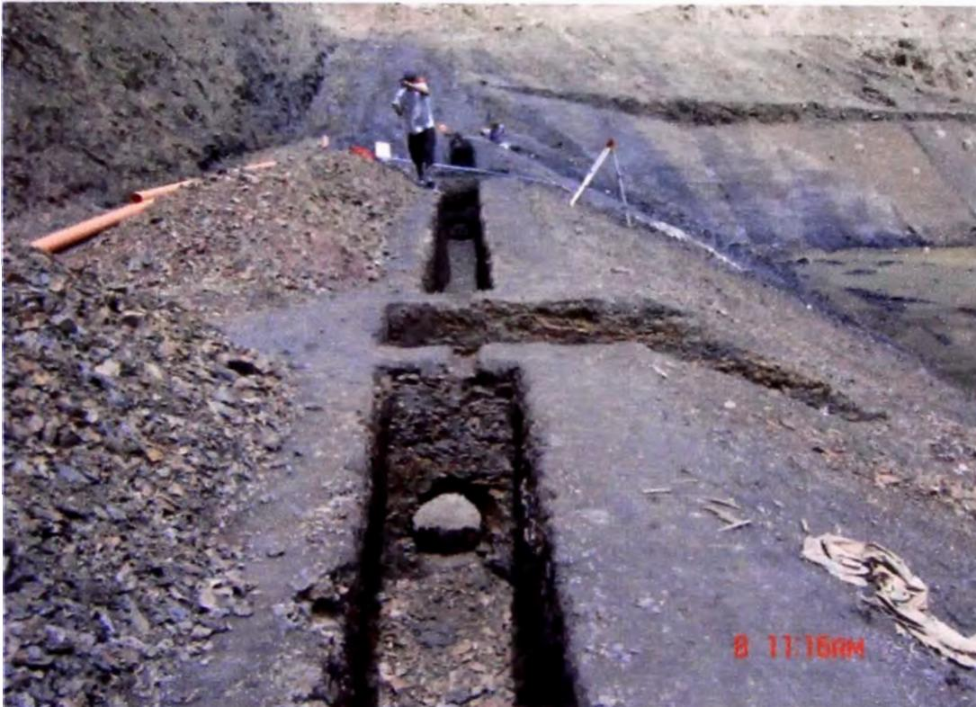
**FOTO N° 17 EXCAV. PARA ESTRUCTURAS DE SALIDA DE LAGUNA FACULTATIVAS**
