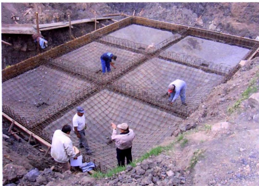
**FOTO N° 6 TANQUE IMHOFF EN CONSTRUCCION**
