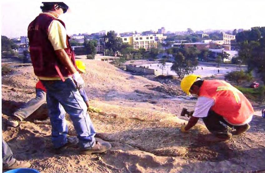
Foto 4.6: Doblez de Biomanta sobre zanja de anclaje y estacado del mismo.
