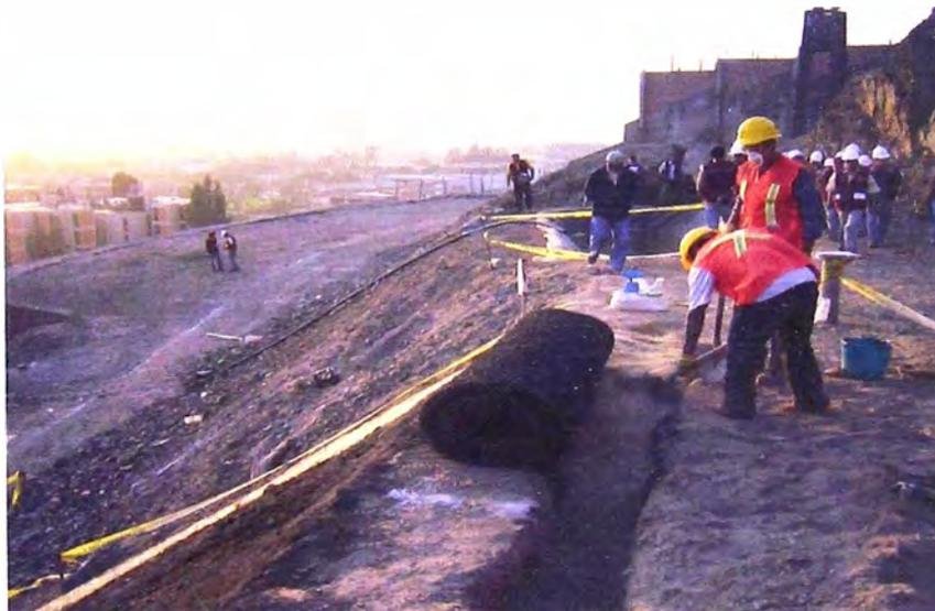
Foto 3.8: Relleno de zanja de anclaje superior con material excavado previamente de la misma zanja.
