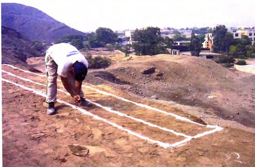
Foto 1.4: Proceso de replanteo de zanjas de anclaje.
