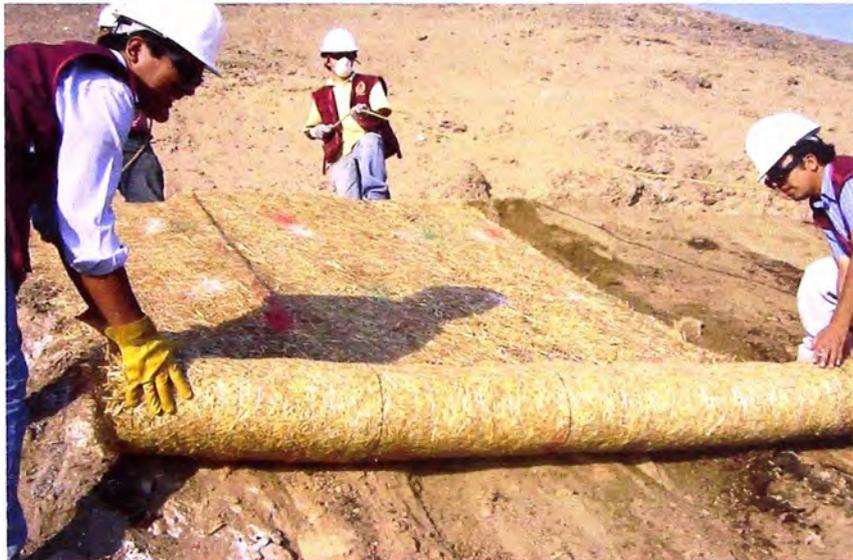
Foto 4.7: Colocación de Biomanta sobre talud desenrollándola hacia abajo.
