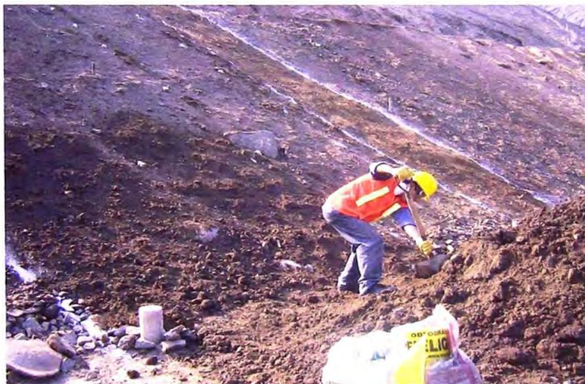
Foto 3.2: Colocación de tierra de chacra sobre el talud.
