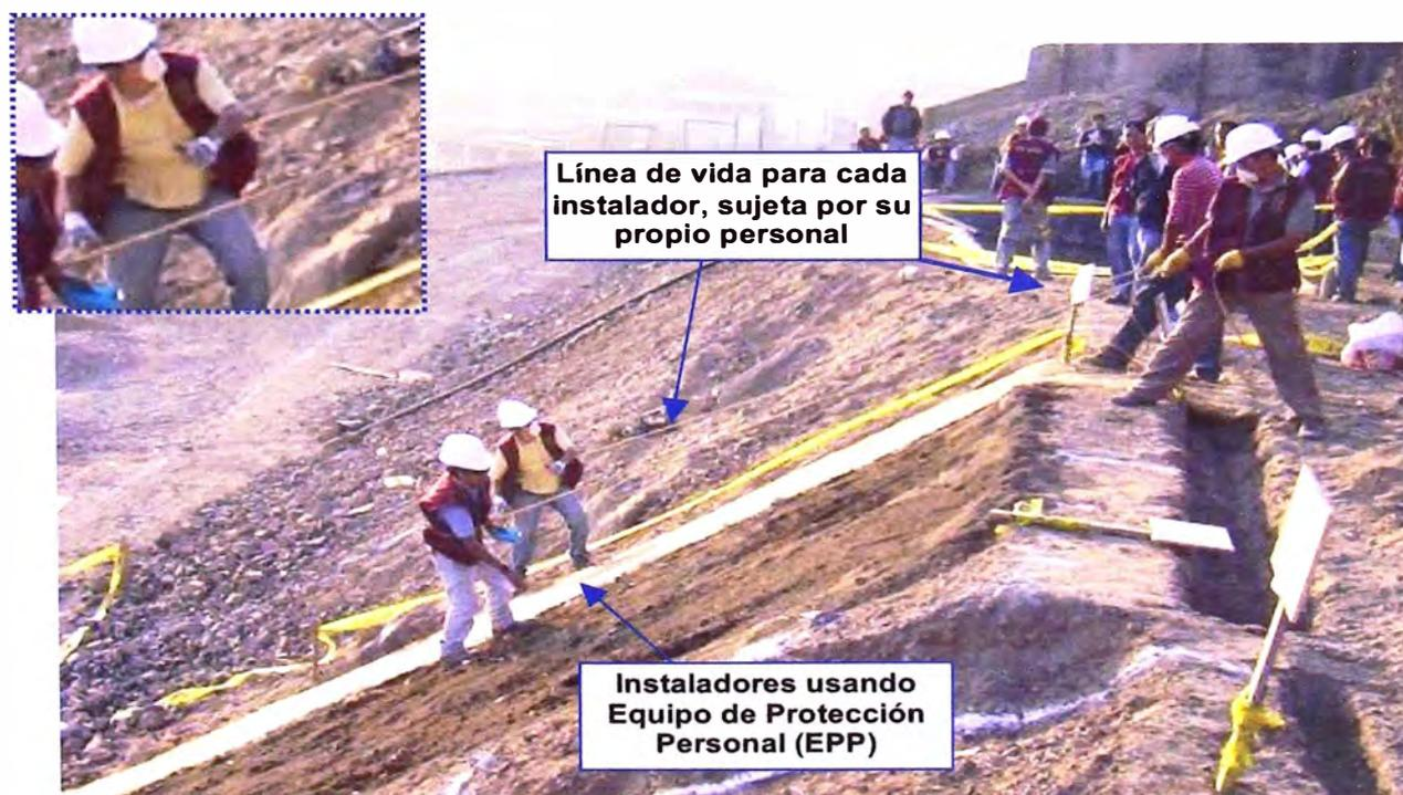
Foto 7.1: Trabajo realizado en talud utilizando implementos de seguridad.
