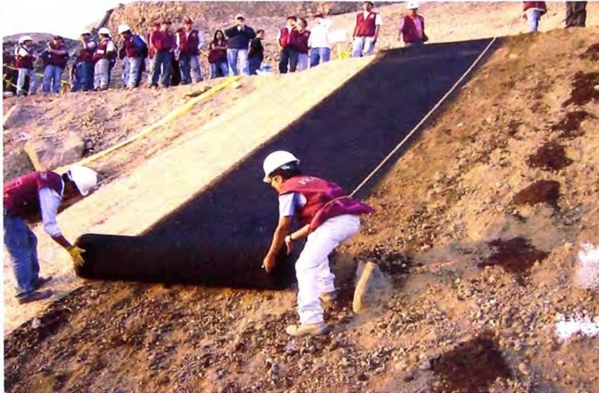
Foto 3.9: Colocación de Geomanta sobre talud desenrollándola hacia abajo.
