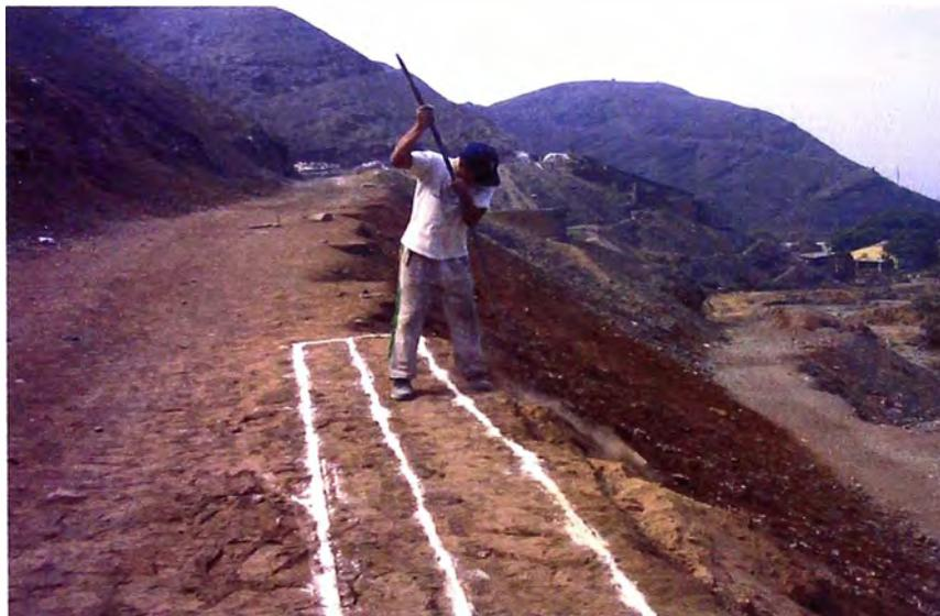
Foto 2.1: Perfilado y limpieza de corona del talud, zona entre el borde del talud y la zanja.
