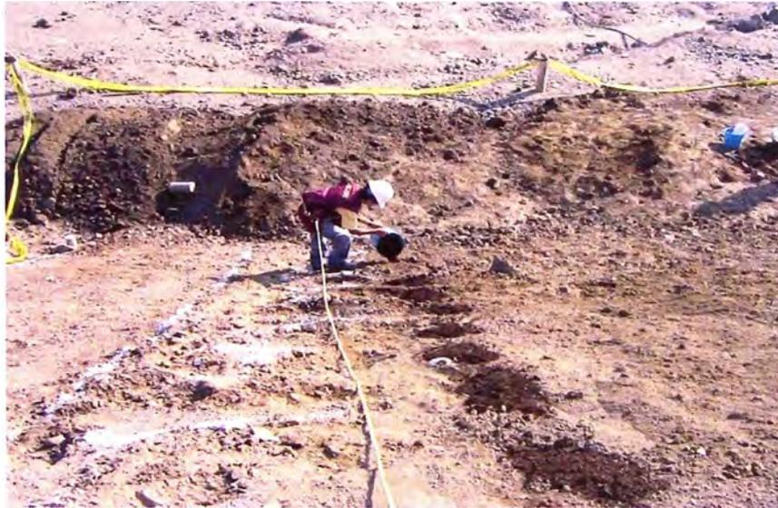
Foto 3.3: Colocación de Compost sobre la capa de tierra de chacra. Nótese las marcas de la cuadrícula de 1.0m x 1.0m a la izquierda, así como la línea de vida sujeta al trabajador.
