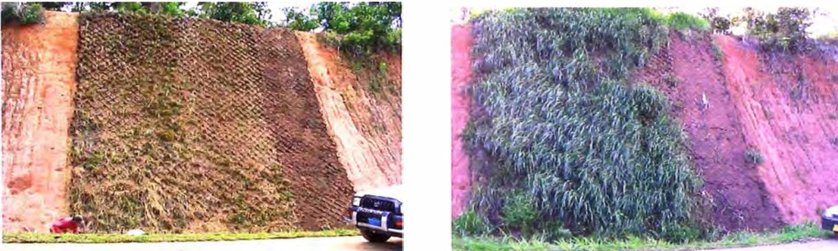
Figura 1.5.3: Control de Erosión a través de la revegetación.
