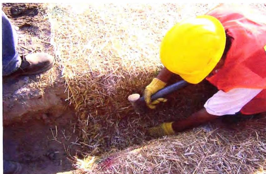
Foto 4.4: Colocación de estacas de fijación en zanja de anclaje superior.
