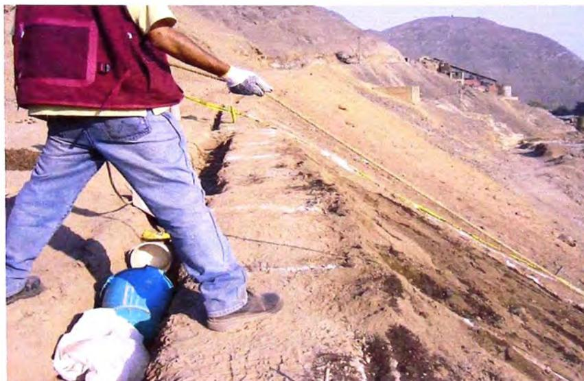
Foto 3.4: Línea de vida siendo tensada por un trabajador. Nótese el uso de guantes para evitar daños en las manos.
