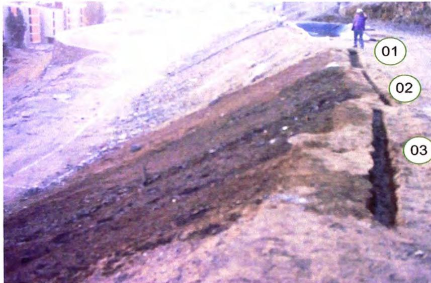
Foto 2.5: Zanjas de anclaje de Parcelas N° 01, 02 y 03, excavadas y alineadas con la sección de talud correspondiente.
