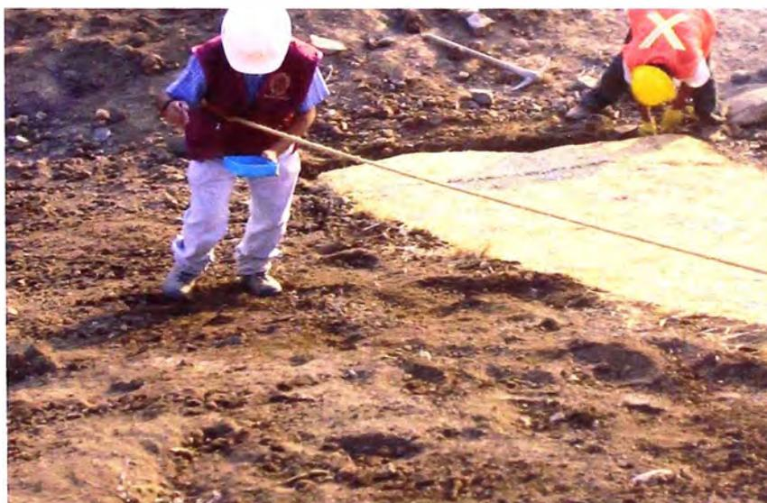
Foto 3.6: Colocación de semillas de pasto tipo Brachiaria sobre el talud.
