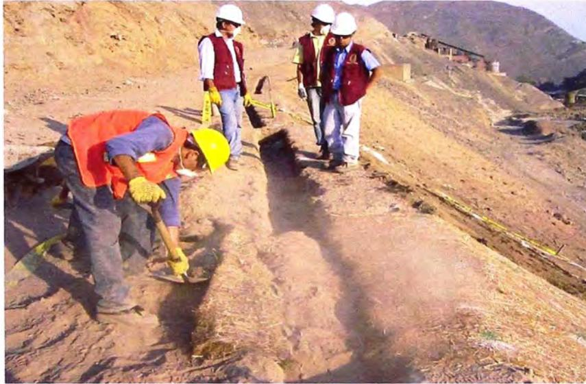
Foto 4.5: Relleno de zanja de anclaje superior con material excavado previamente de la misma zanja.
