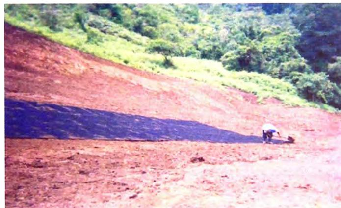
Figura 2. Colocación de primer rollo
