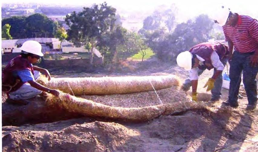
Foto 4.3: Colocación de Biomanta NAG SC-150 dentro de zanja de anclaje superior.
