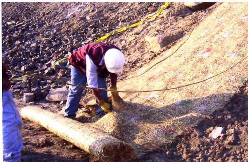
Foto 4.8: Corte de Biomanta sobrante al pie del talud.
