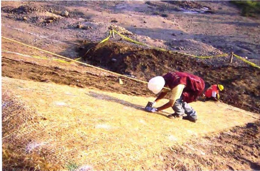
Foto 4.9: Colocación de estacas de fijación en la Biomanta. Nótese nuevamente la línea de vida empleada.
