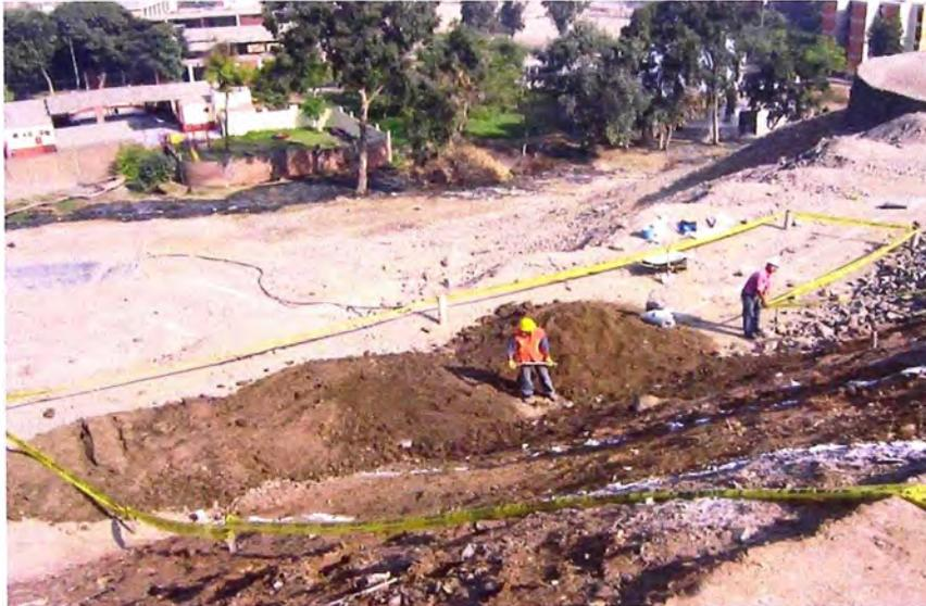
Foto 4.1: Vista de tierra de chacra acumulada a punto de ser colocada sobre el talud.
