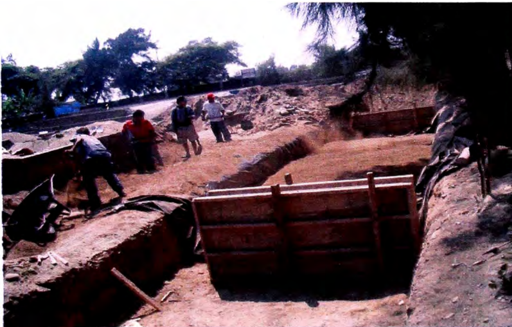
Foto 14. Colocación de material de relleno
