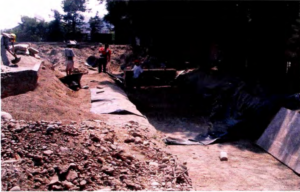
Foto 13. Nótese nuestra zona de trabajo impermeabilizado y con una primera capa de relleno
