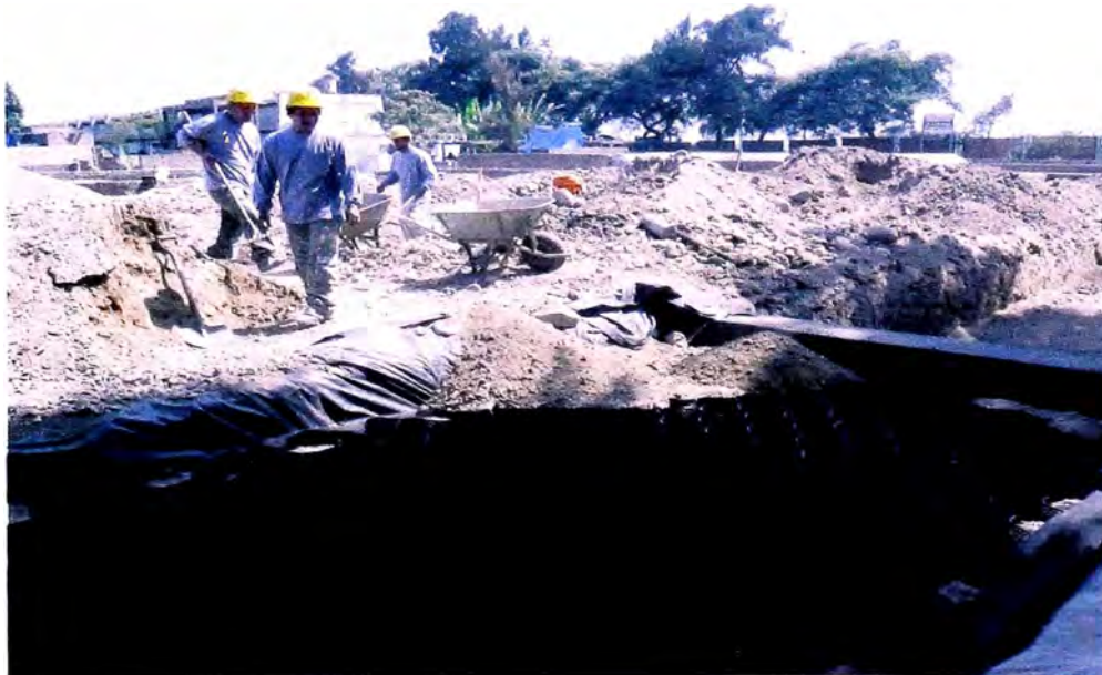
Foto 20. Llenado de las geoceldas con material de afirmado. Por la envergadura de la obra solo se usó mano de obra con sus respectivos equipos
