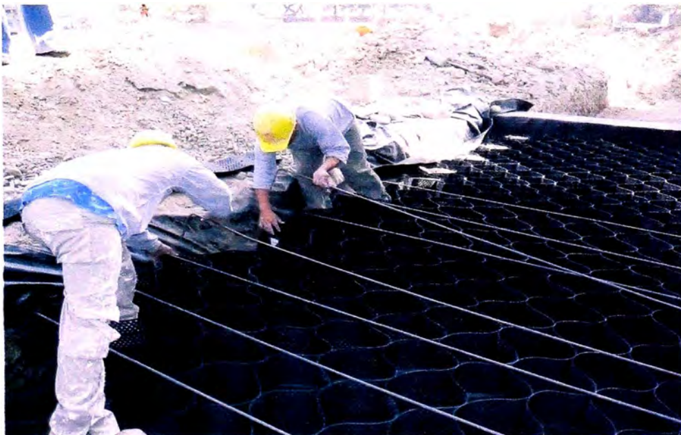
Foto 18. Colocación de la geocelda sobre el geotextil. Nótese la inclusión de estacas de hierro corrugado a fin de extender la sección de geocelda
