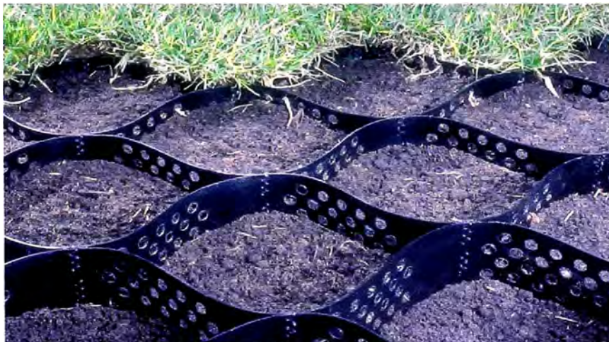
Figura 2.8 Relleno de geoweb con tierra vegetal
