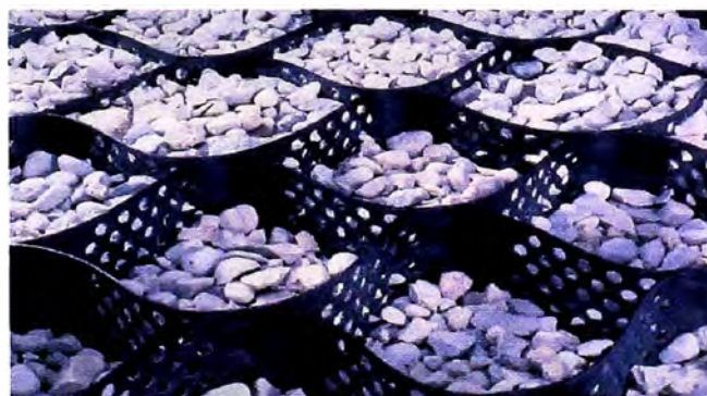
Figura 2.4 Relleno de geoweb con material local
