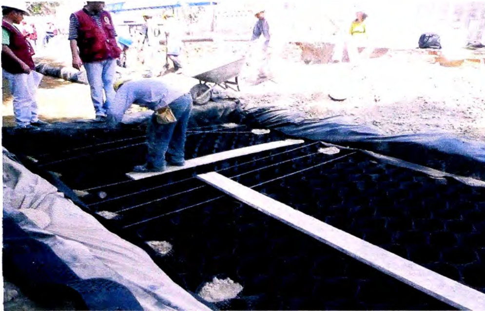
Foto 21. El empleo de tablas de madera que sirvan de superficie para trabajar es muy importante, ya que se evita dañar las secciones de geoweb
