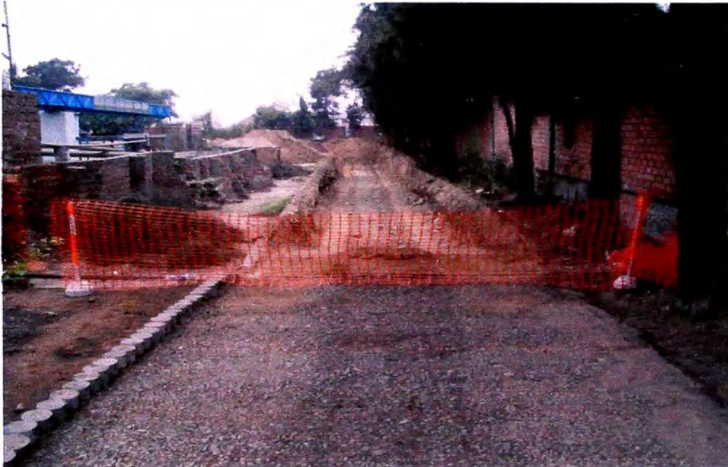
Foto 5. Zona excavada y señalizada
