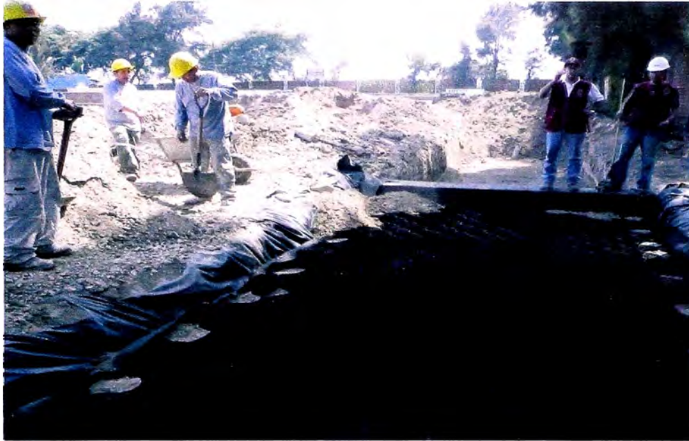
Foto 19. Las estacas se van retirando a medida que se rellenan con material las celdas de los extremos
