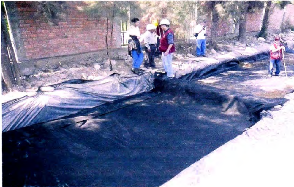
Foto 16. Colocación del geotextil de separación sobre el material de relleno
