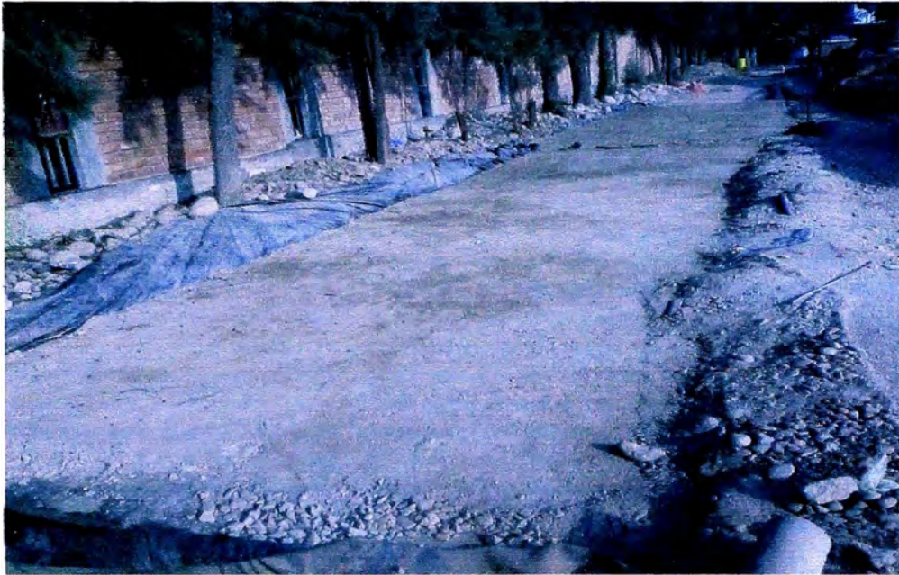
Foto 23. Vía afirmada culminada con la aplicación del sistema geoweb
