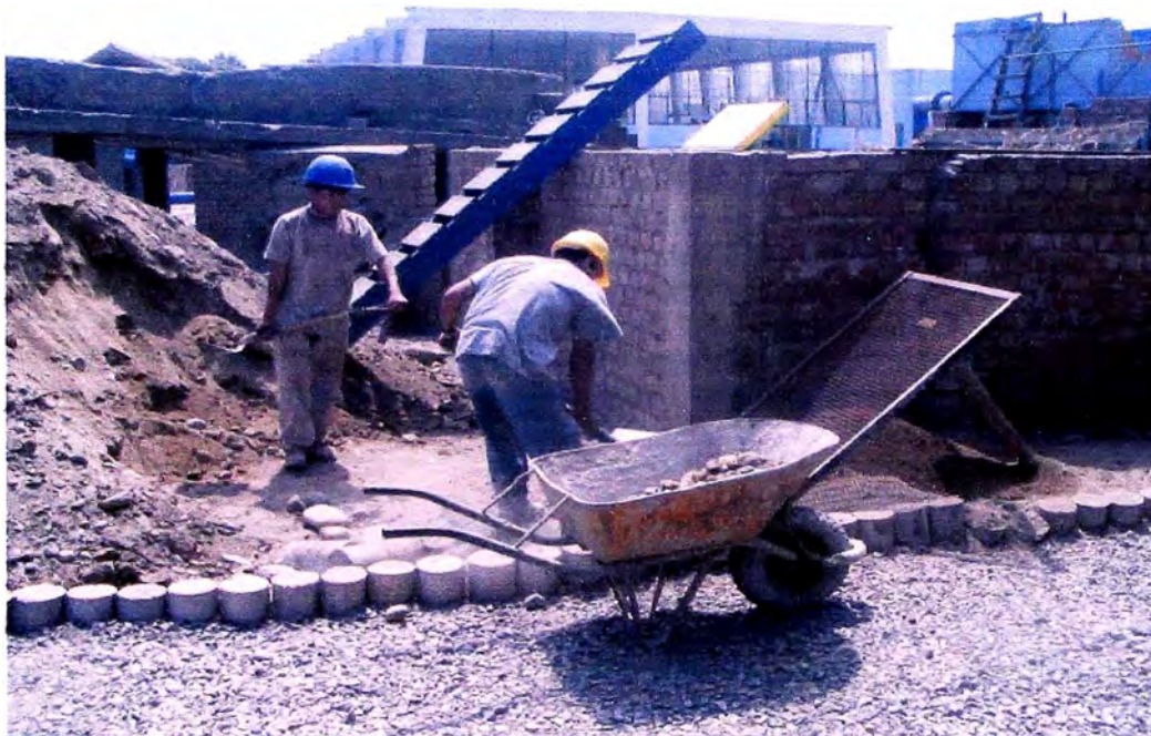
Foto 7. Zarandeo de material a fin de usarlo posteriormente como relleno
