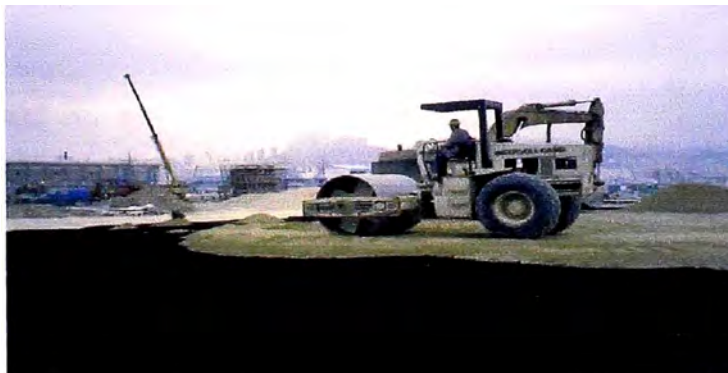
Figura 4.7 Compactación del relleno
