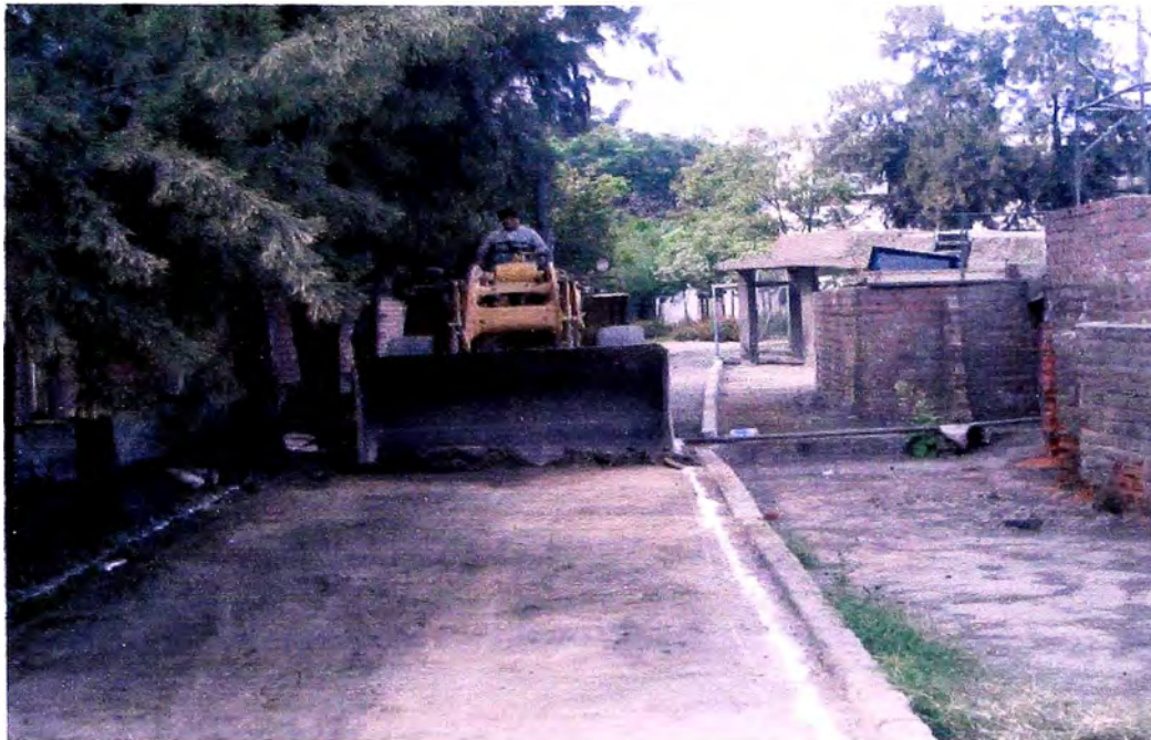
Foto 3. Inicio de corte de terreno con maquinaria pesada
