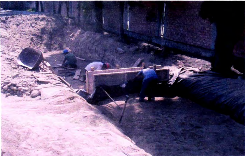
Foto 12. Construcción del muro de separación de zonas de trabajo
