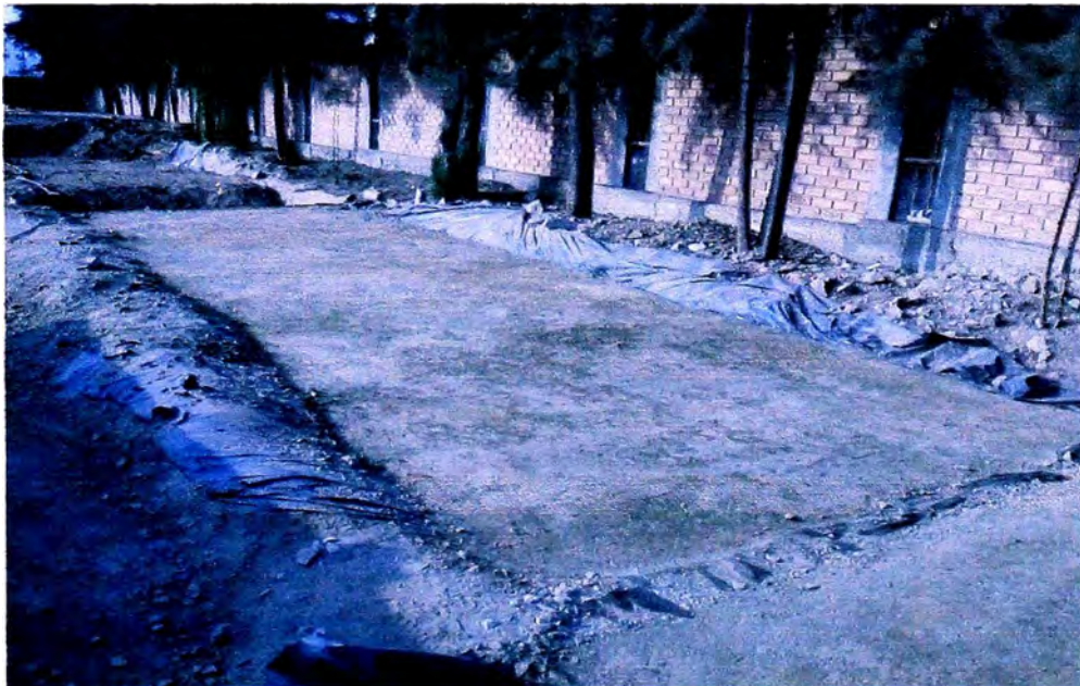
Foto 24. Otra vista de la obra terminada
