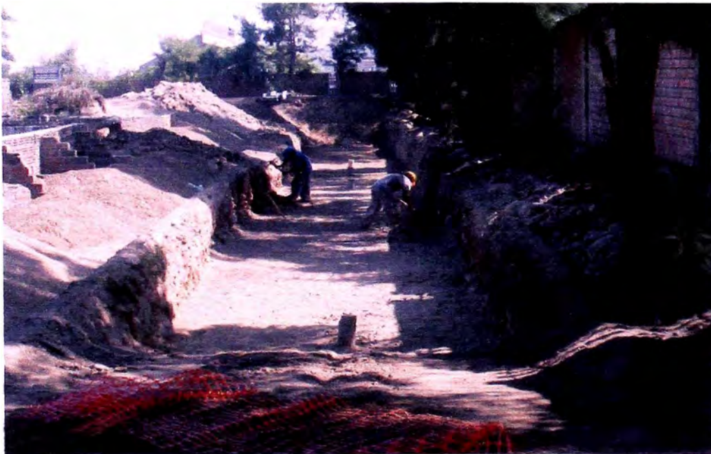
Foto 6. Trabajos de perfilado y refine de paredes de zanja
