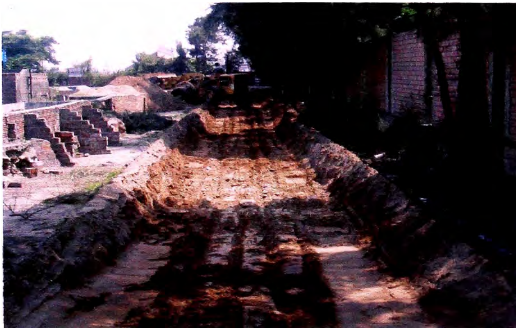
Foto 4. Primera pasada del cargador y el consecuente acarreo del material excavado
