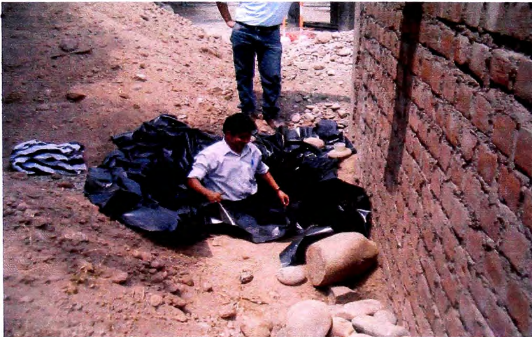
Foto 10. Impermeabilizado de la poza de prueba
