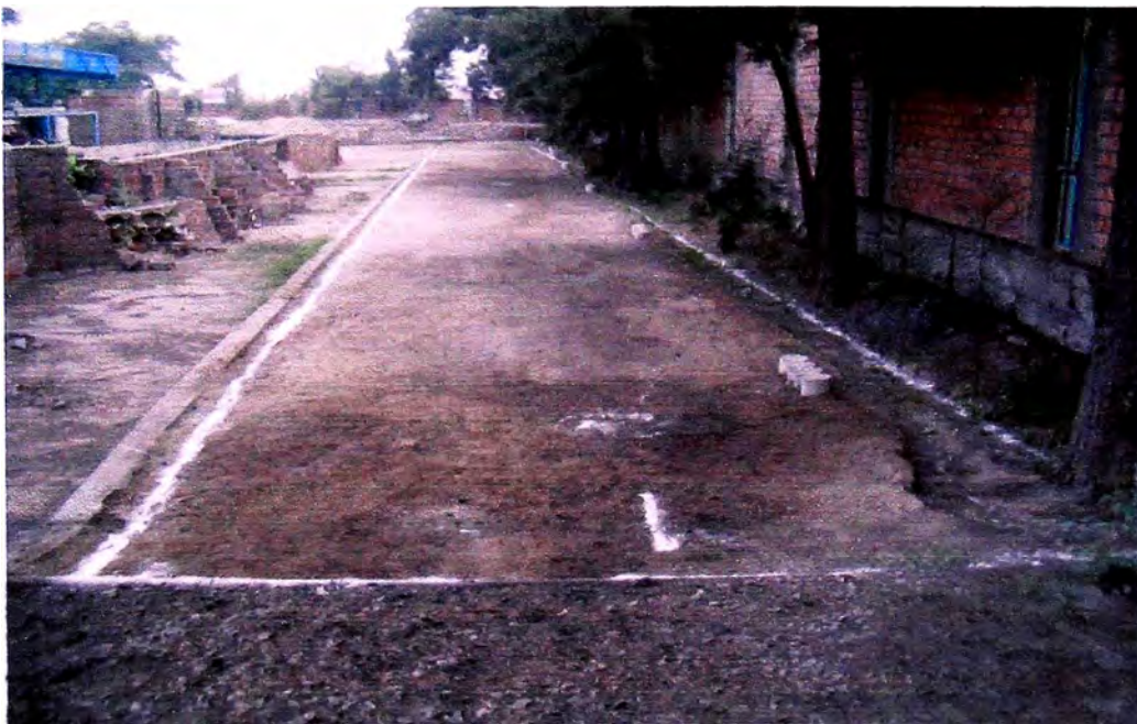
Foto 2. Zona de trabajo demarcada
