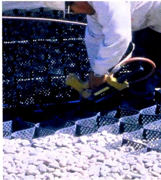
Figura 4.4 Engrapado neumático
