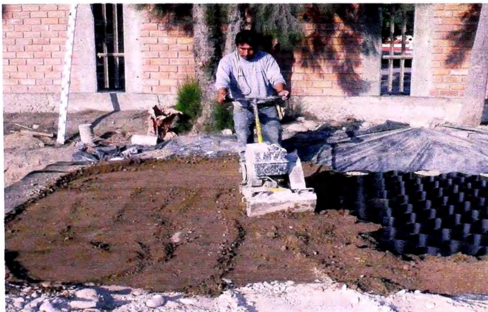
Foto 22. Compactación de la capa de afirmado con plancha vibratoria
