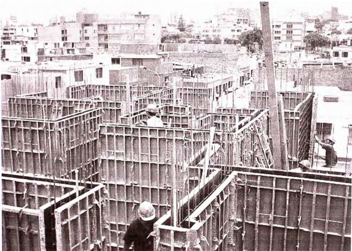
Foto.N°12: Encofrado metálico del SMDL
