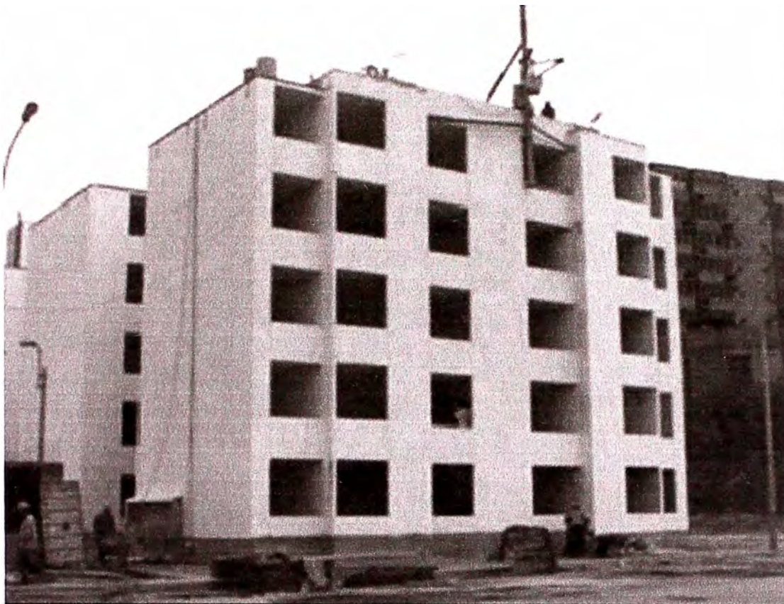
Foto.N°23: Acabado solaqueado de una edificación - SMDL
