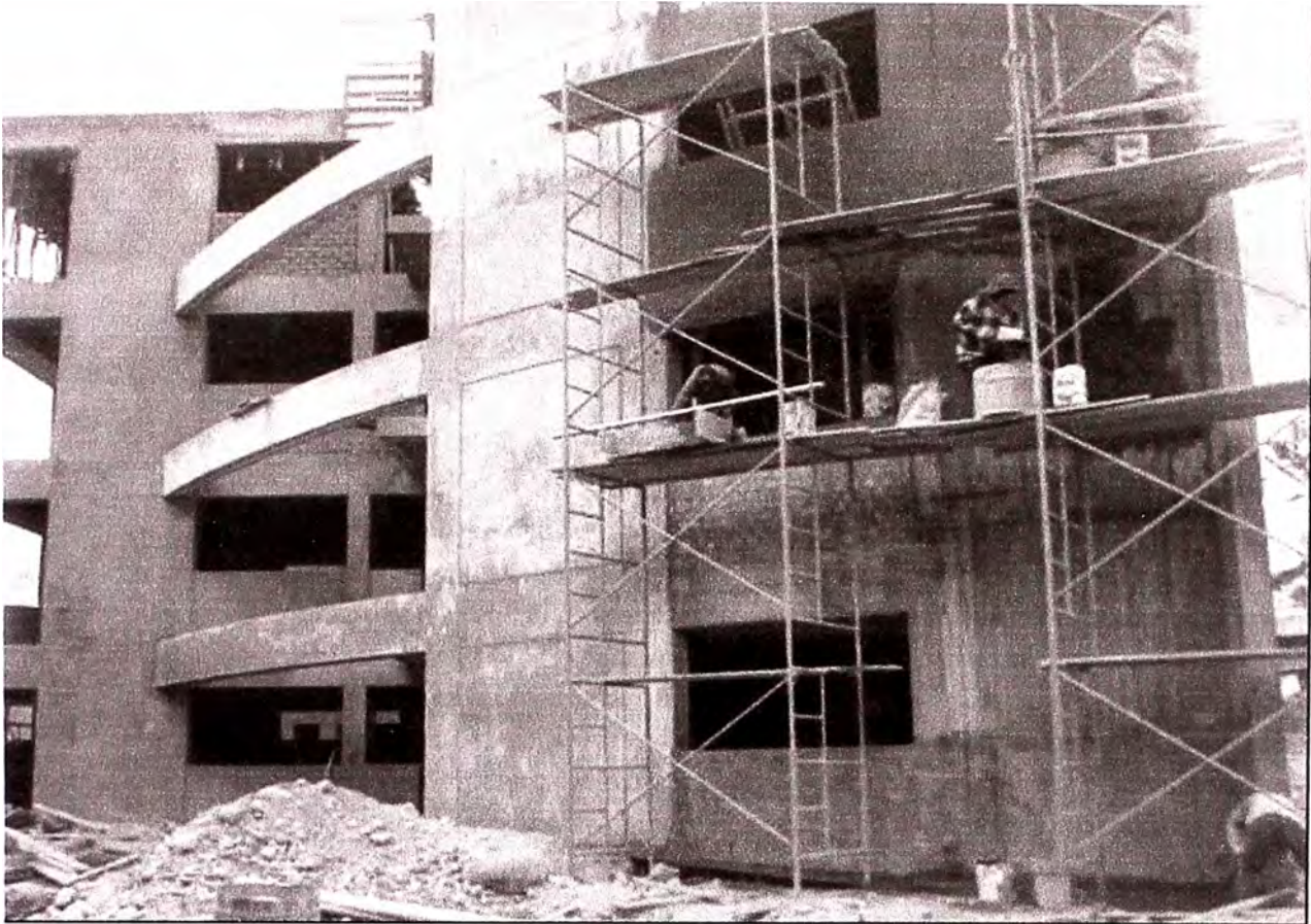
Foto.N°24: Acabado exterior con tarrajeo de un Pálcio Municipal - SD (Nótese que falta armar el cuerpo metálico de en medio)
