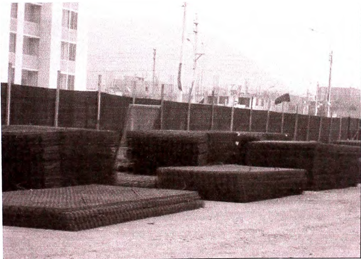
Foto.N°8: Almacén temporal de Mallas electrosoldadas
