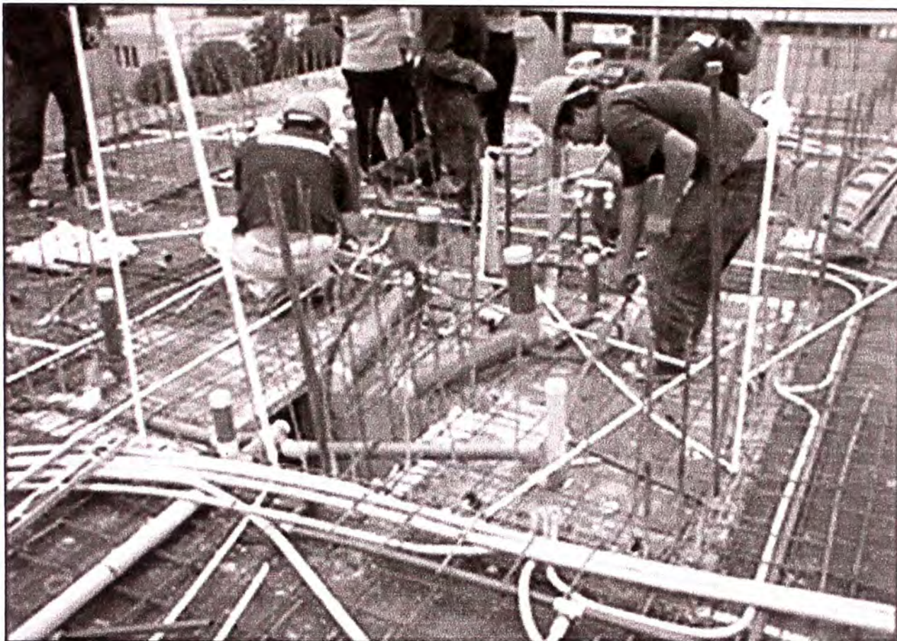
Foto.N°17: Losa de 20cm en techo de baño – SMDL
