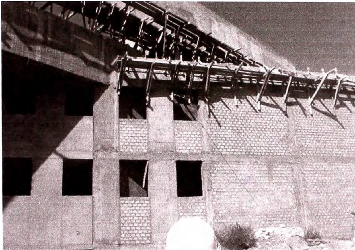
Foto.Nº21: Palacio Municipal con muros confinados y pórticos – SD (Nótese que la fachada tendrá que ser recubierta con mortero)
