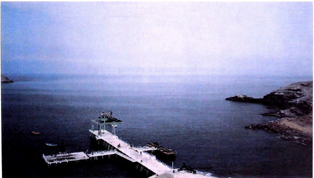
Foto I.1: Vista panorámica del Muelle el Poseidon
