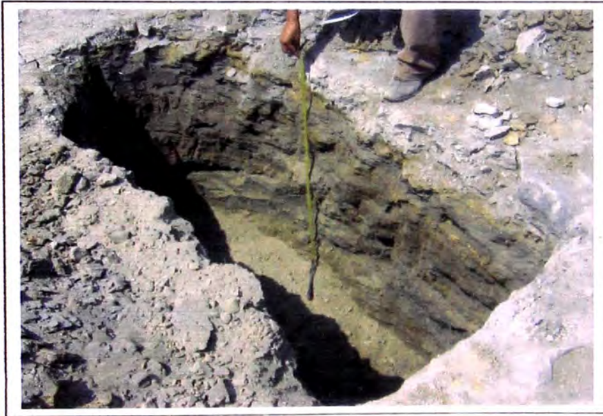
En la Foto N° 3 se observa una de las tres calicatas que se realizaron como parte del estudio geotécnico del proyecto.
