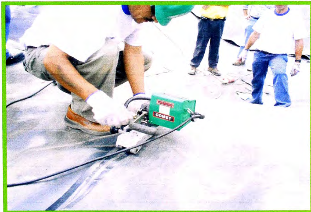
Foto N° 24: Soldadura por termofusión entre paneles de geomembrana para asegurar la impermeabilidad del reservorio
