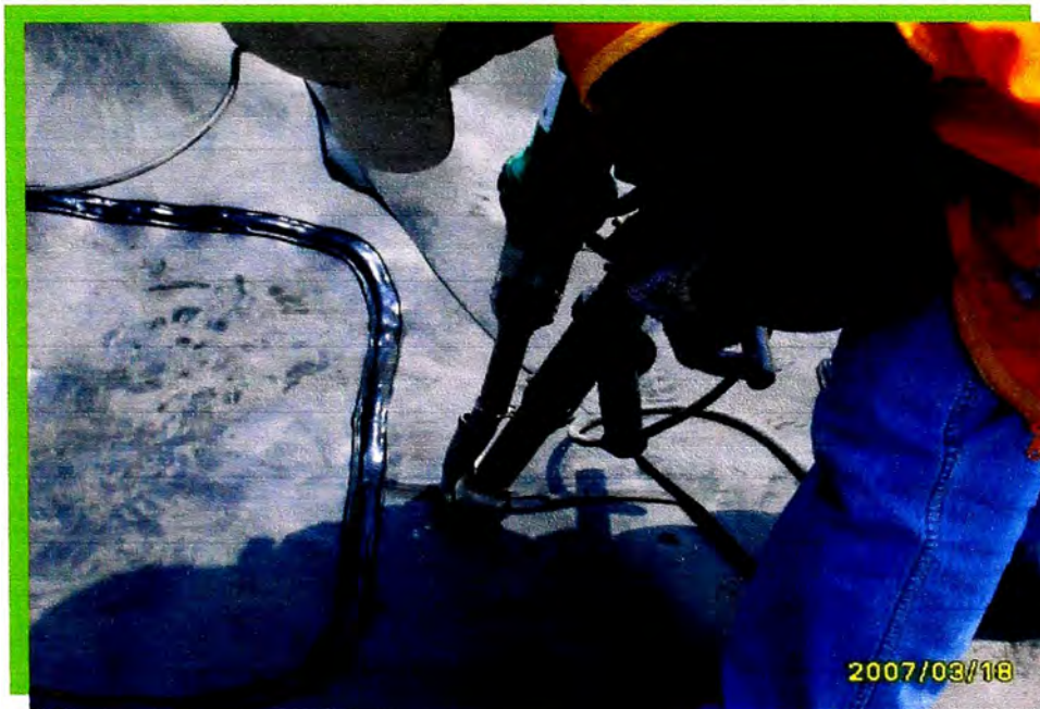
Foto N° 36: Soldadura por extrusión en el pie del talud.
