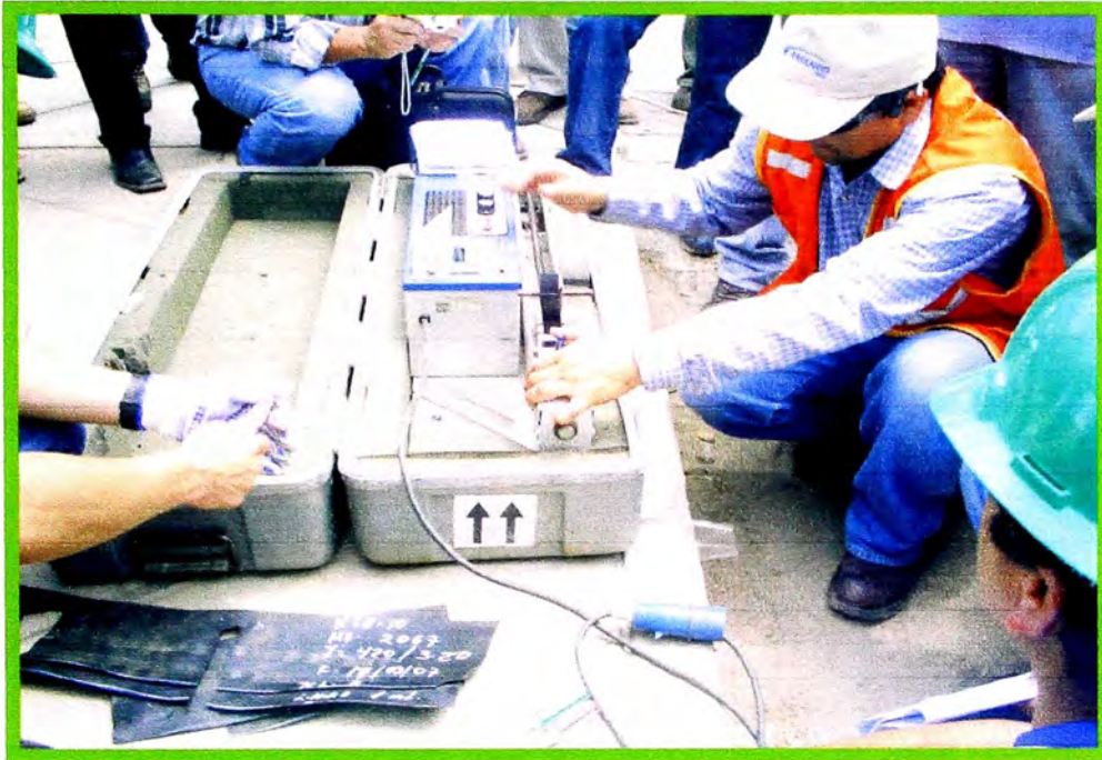
Foto N° 23: Toma de pruebas iniciales a cupones de geomembrana soldados
