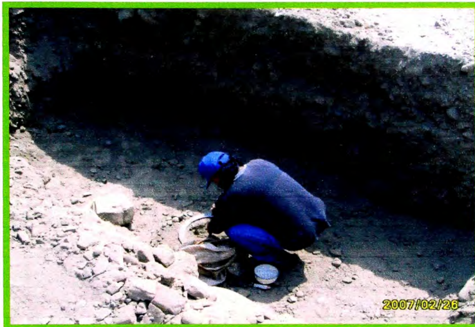
Foto N° 5: Toma de muestras para Ensayos de Suelos
