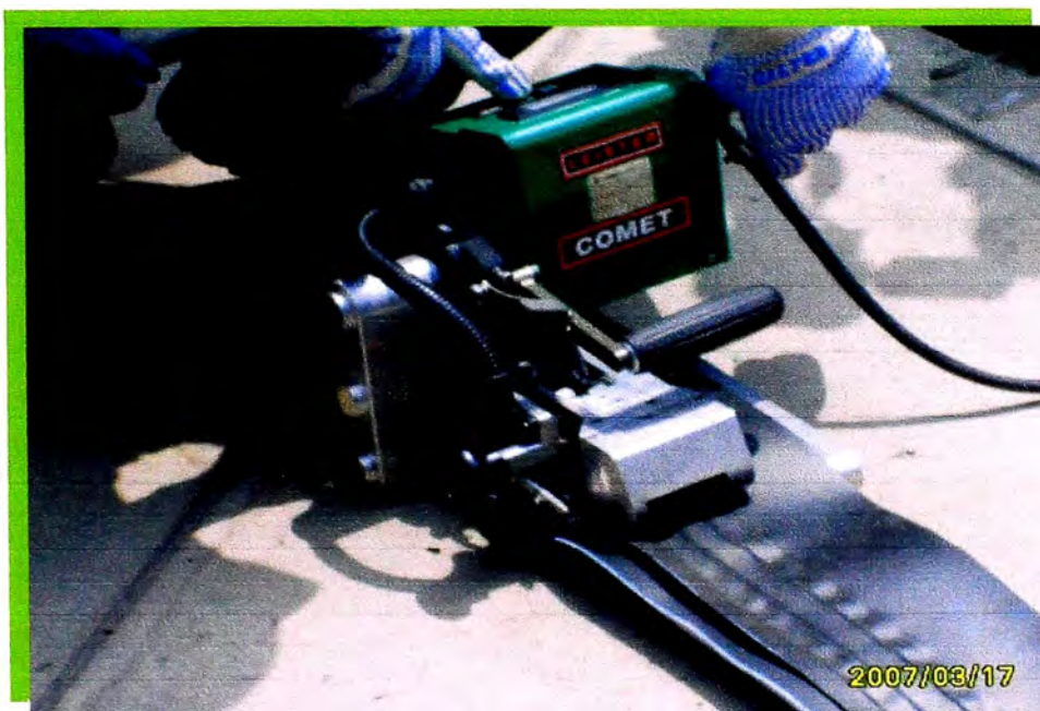
Foto N° 22: Prueba de la calibración de la cuña.
