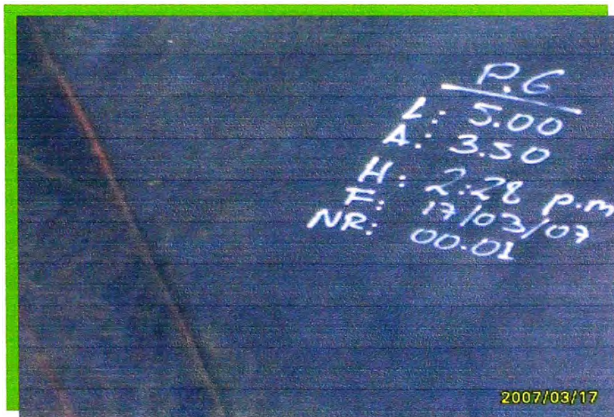
Foto N° 20: Datos de los paneles instalados
