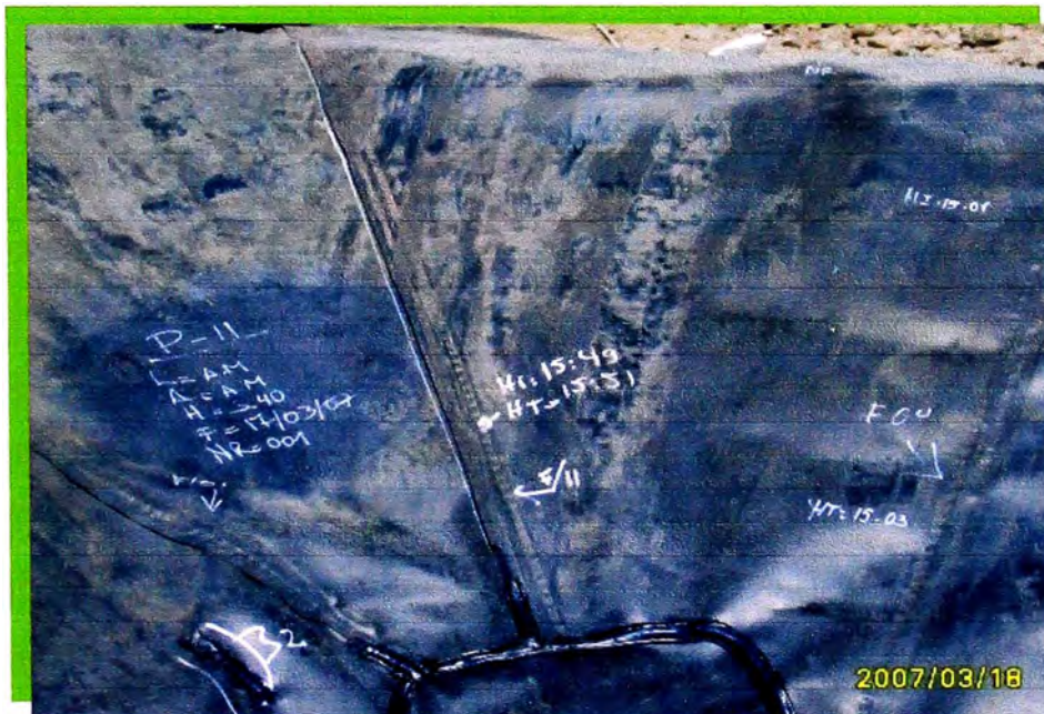
Foto N° 30: Vista de la identificación de paneles y los cordones de soldadura por termofusión.
