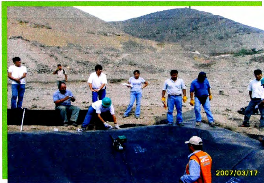
Foto N° 29: Soldado de un cordón por termofusión con la cuña caliente.
