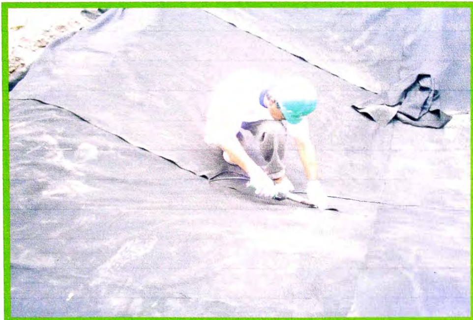
Foto N° 12: Sellado por calor de uniones entre paños de geotextil
