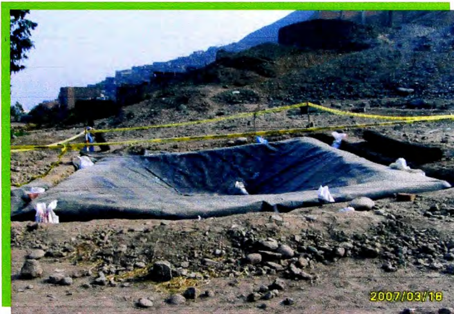
Foto N° 33: Poza impermeabilizada por temrofusión
