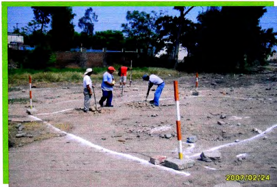
Foto N° 2: Trazo y replanteo de la zona donde se realizara la obra.
