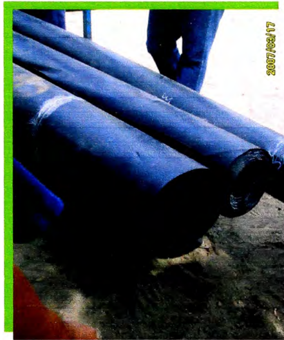
Foto N° 9: Rollos de geomembrana y geotextil a pie de obra.
