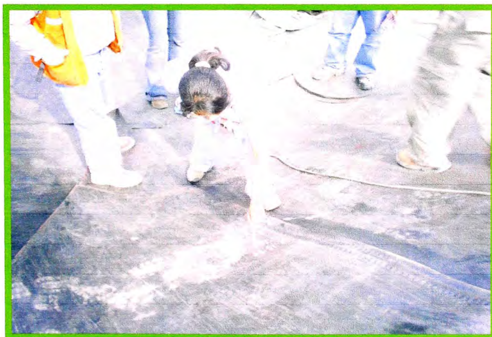
Foto N° 32: Control de Calidad durante la ejecución del proyecto, verificando la soldadura y marcando zonas de reparaciones
