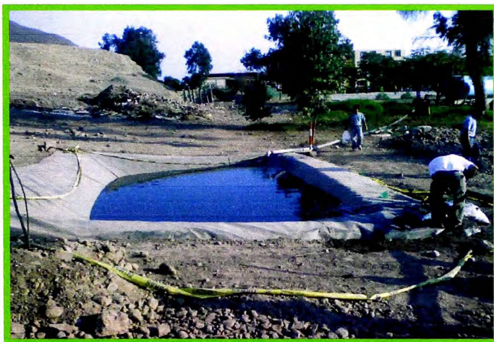
Foto N° 39: Llenado de Reservorio para prueba de impulsión hacia el Reservorio N°2
