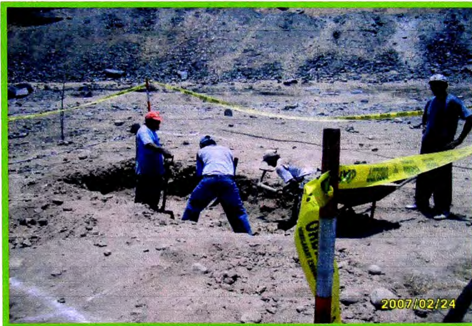
Foto N° 4: Excavación de Reservorio
