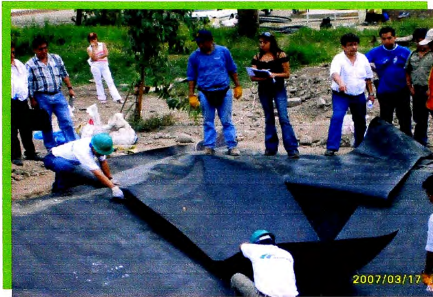
Foto N° 17: Colocación de paneles en los taludes de las esquinas.
