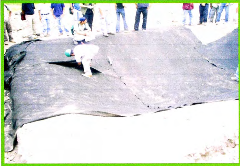
Foto N° 11: Verificando el traslape entre paños
