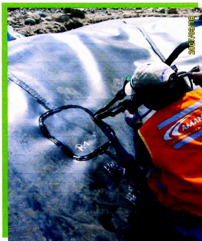
Foto N° 37: Soldadura por extrusión con la leister, para parches
