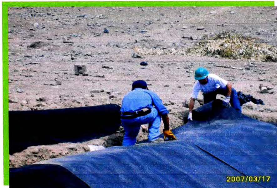
Foto N° 16: Ajuste de los paneles en la zanja de anclaje.
