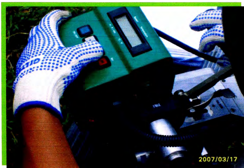
Foto N° 21: Calibración de la soldadora de cuña caliente.
