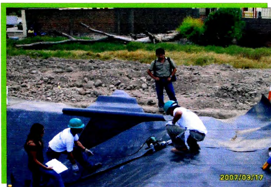
Foto N° 31: Soldadura en el talud de las esquinas de la poza.
