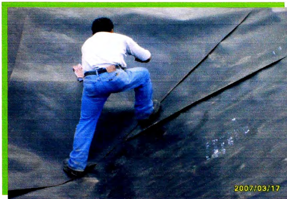
Foto N° 19: Identificación de Paneles
