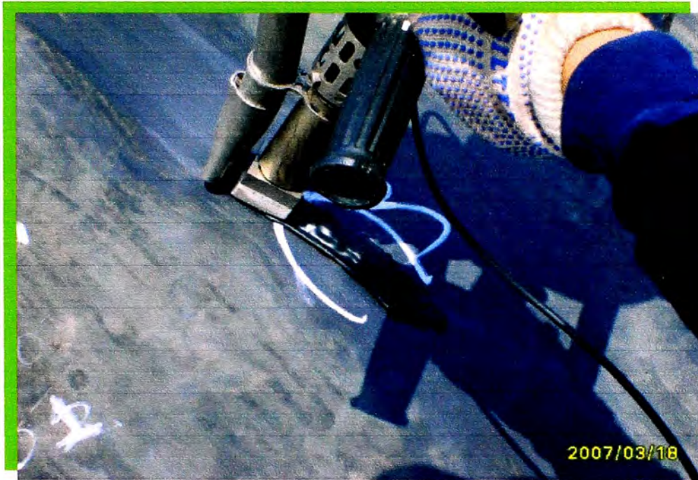
Foto N° 35: Soldadura para geomembrana por el Sistema de Extrusión
