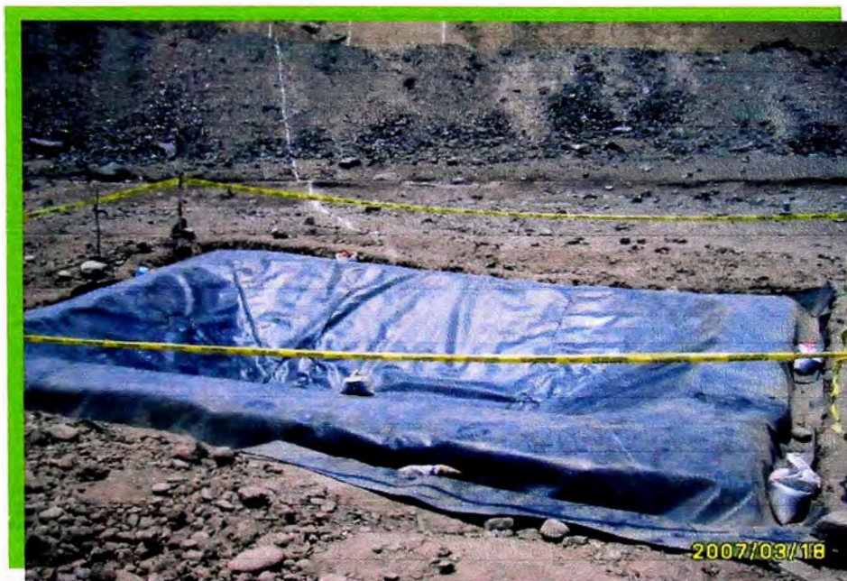
Foto N° 38: Poza totalmente impermeabilizada.
