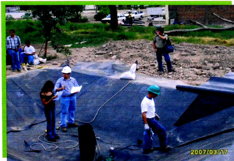
Foto N° 28: Llenado de formatos los paneles finales instalados
