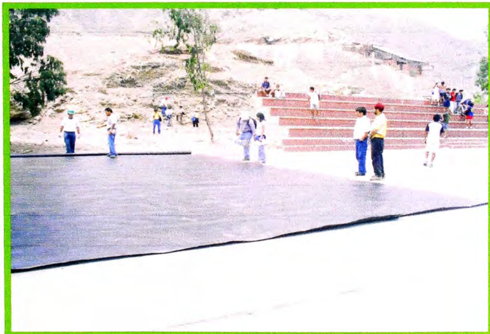
Foto N° 14: Corte de paneles de geomembrana en zona adyacente para facilitar su instalación
