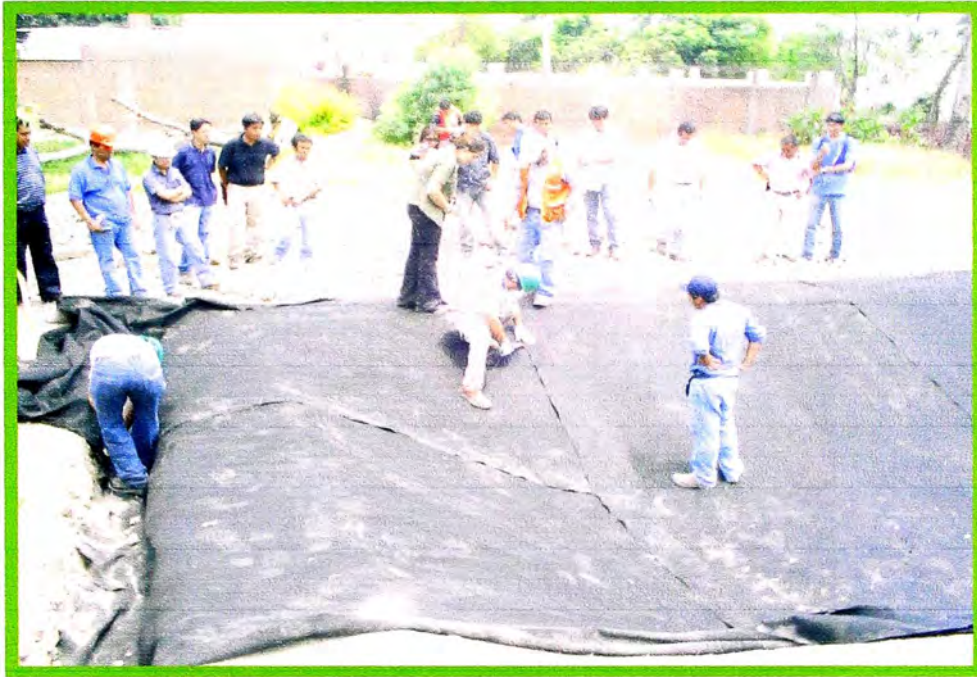
Foto N° 13: Vista general de tendido de geotextil en Reservorio de Agua
