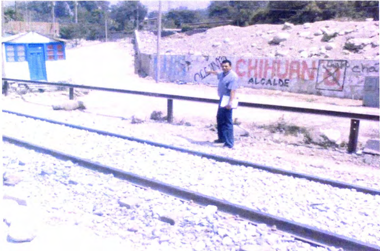
FOTO N°6 SEGUNDO TRAMO (PROGRESIVAS 00+270 – 00+380) – CRUCE DE LA LÍNEA FÉRREA
