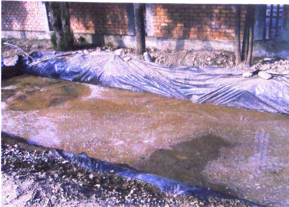
Figura 7: Proceso de saturación del material zarandeado, de acuerdo a los cálculos de gabinete y ensayos de suelos realizados.
