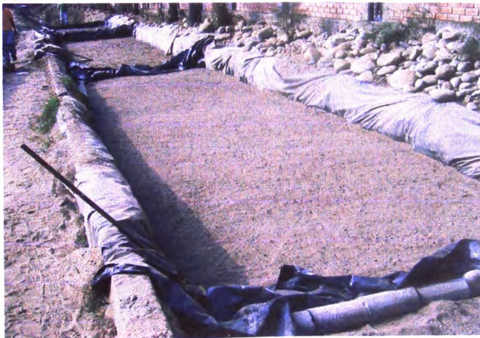
Figura 6: Material nivelado a degradar..
