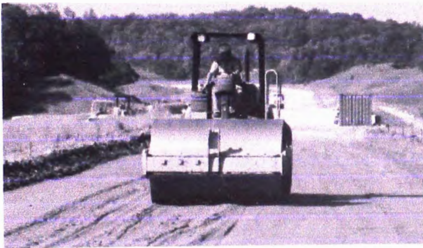
Figura 3.11: Compactación del relleno de áridos
