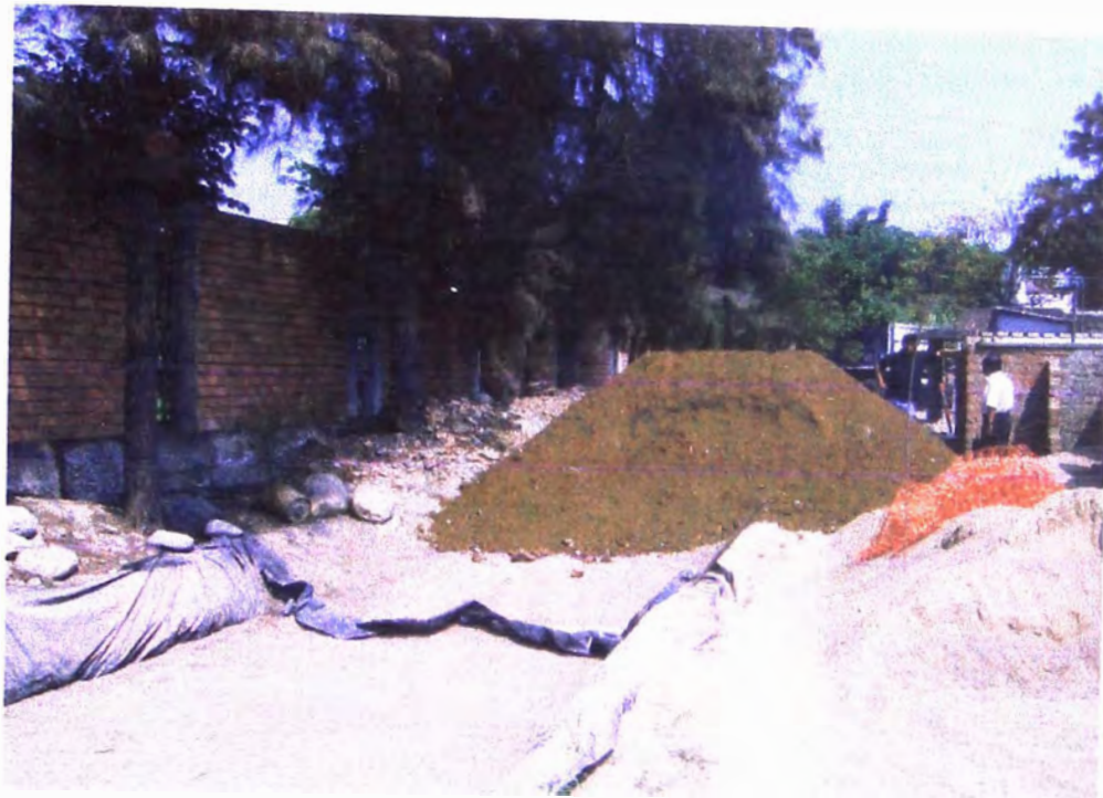
Figura 9: Material para la conformación de la plataforma (terraplén)
