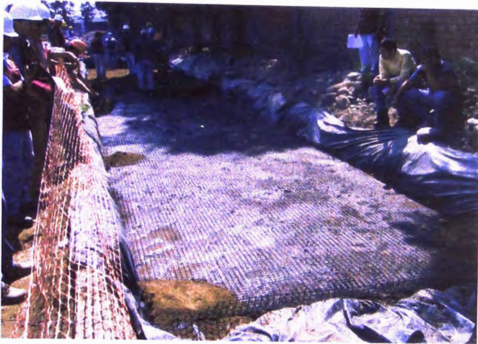
Figura 13: Aplicación de la geomalla Biaxial BX 1100 para mejoramiento de subrasante
