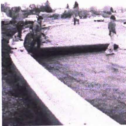
Figura 3.5a.- Colocación de la geomalla para acomodar las curvas
