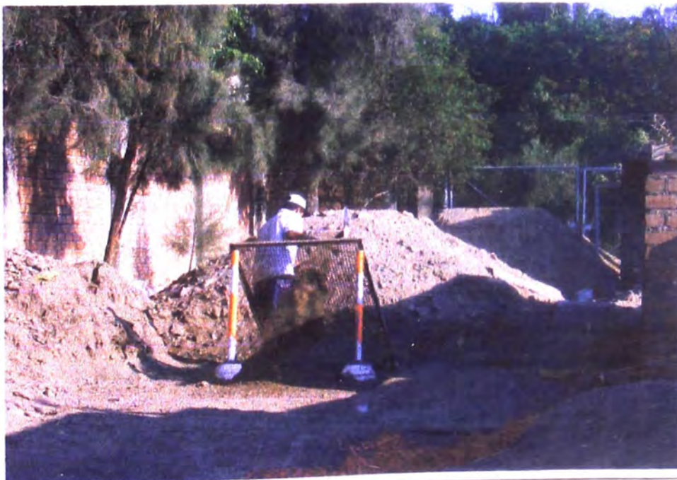
Figura 2: Personal zarandeando el material para ser usado como suelo de fundación.
