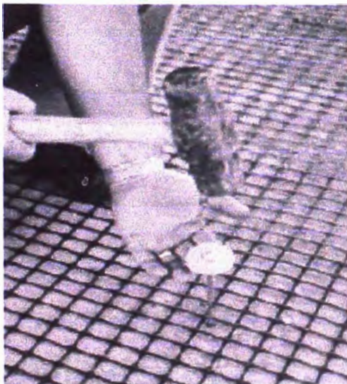
Figura 3.6a.- Anclaje de geomalla con arandelas y clavijas.
