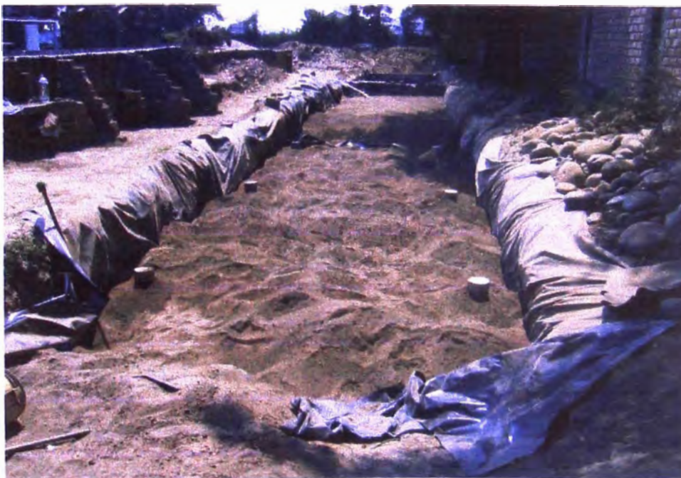
Figura 4: Plantillas ubicadas en la zona, para el nivelado del suelo a degradar, el nivel de referencia se ubica en el lado izquierdo.
