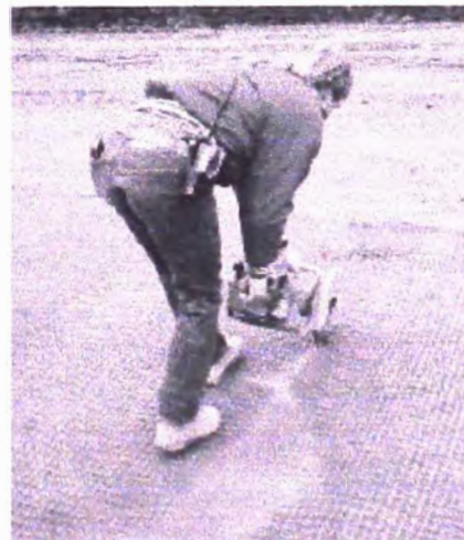
Figura 3.5b.- uso de una sierra mecánica para cortar la geomalla
