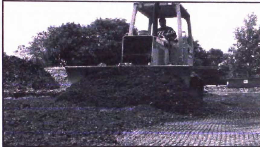
Figura 3.8: Distribución del relleno de áridos encima de las Geomallas .
