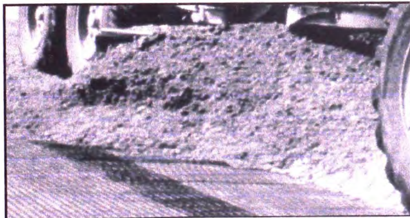
Figura 3.4: Traslapes superpuestos en la dirección del avance del relleno
