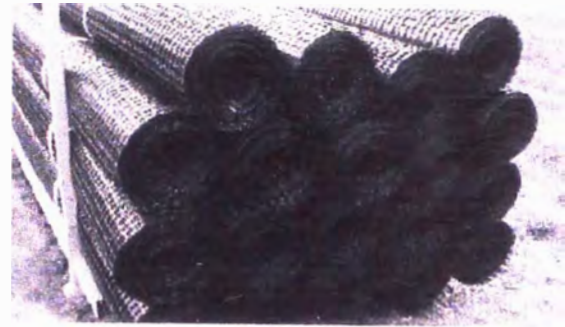
Figura 3.2. Almacenamiento (horizontal) de los rollos de las geomallas.
