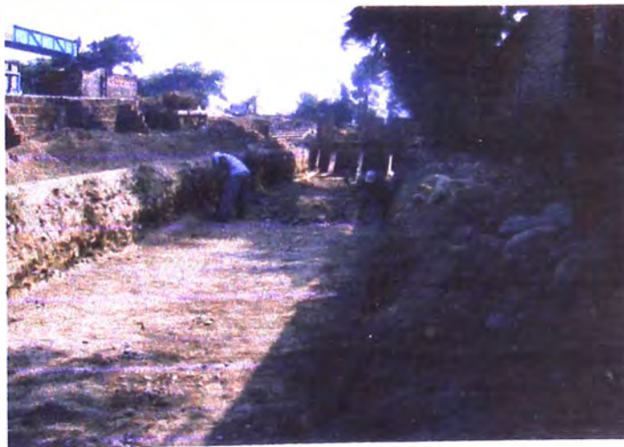
Figura 4.1: Zona de trabajo en donde se aplicara la geomalla Biaxial BX 1100. Se realizó excavación para colocar material con baja capacidad portante.
